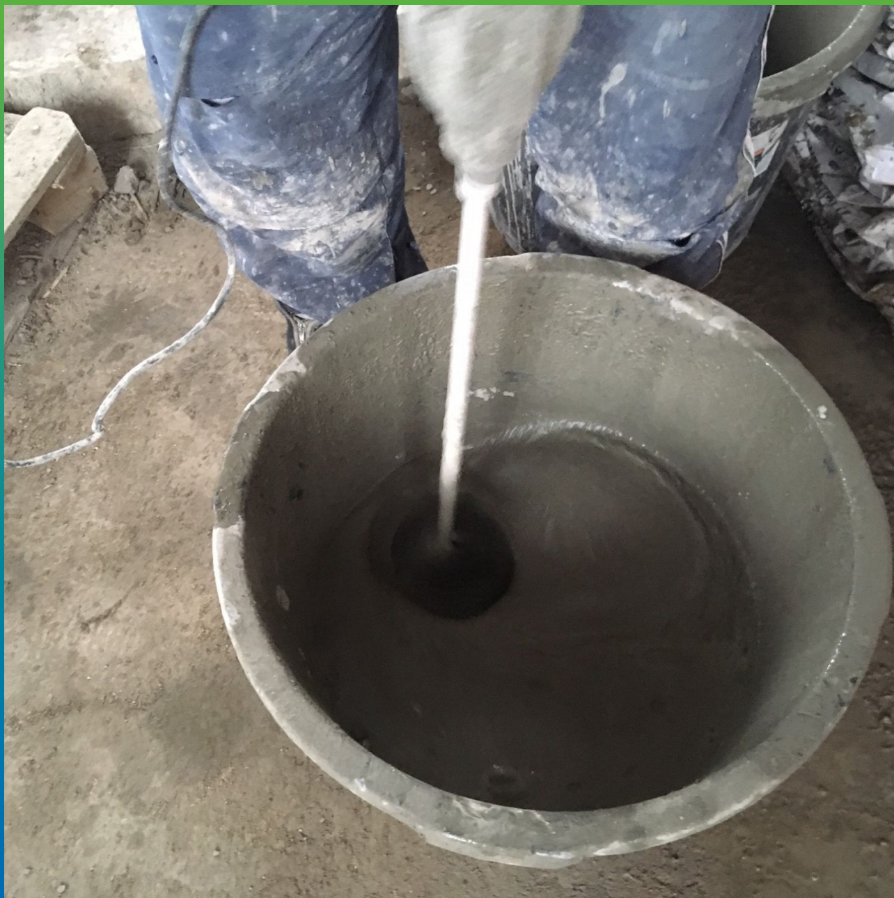
Подготовка растворной смеси Маноцем Гроут
