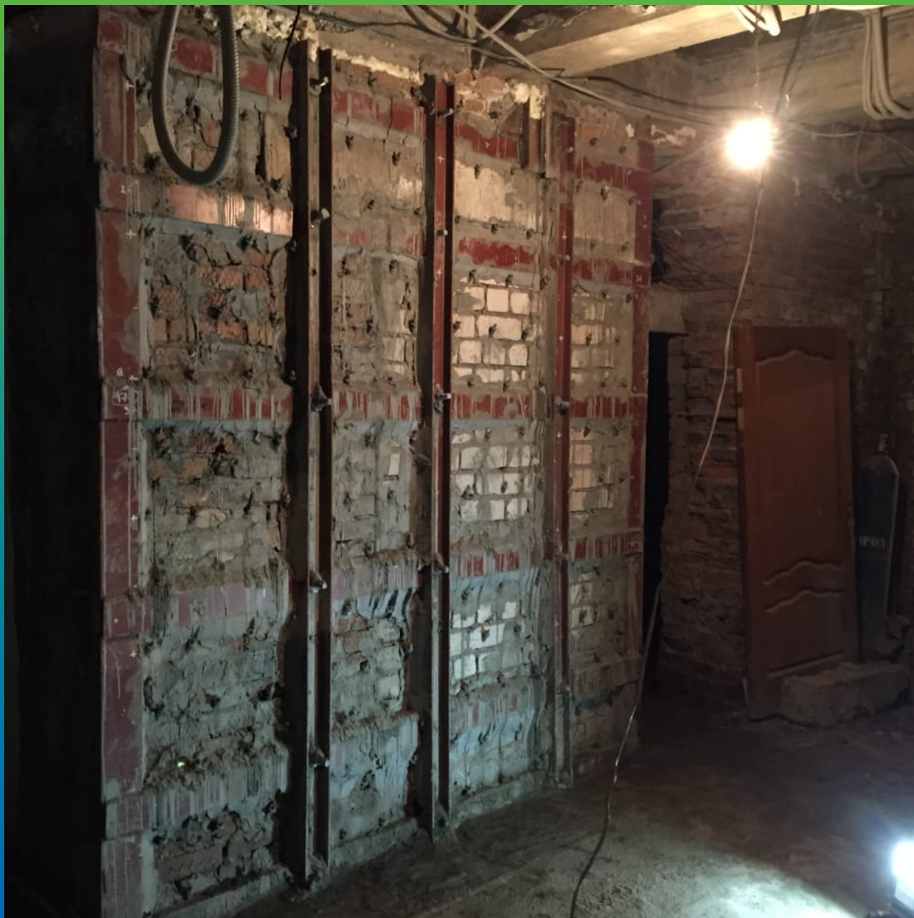
Общий вид после установки пакеров
