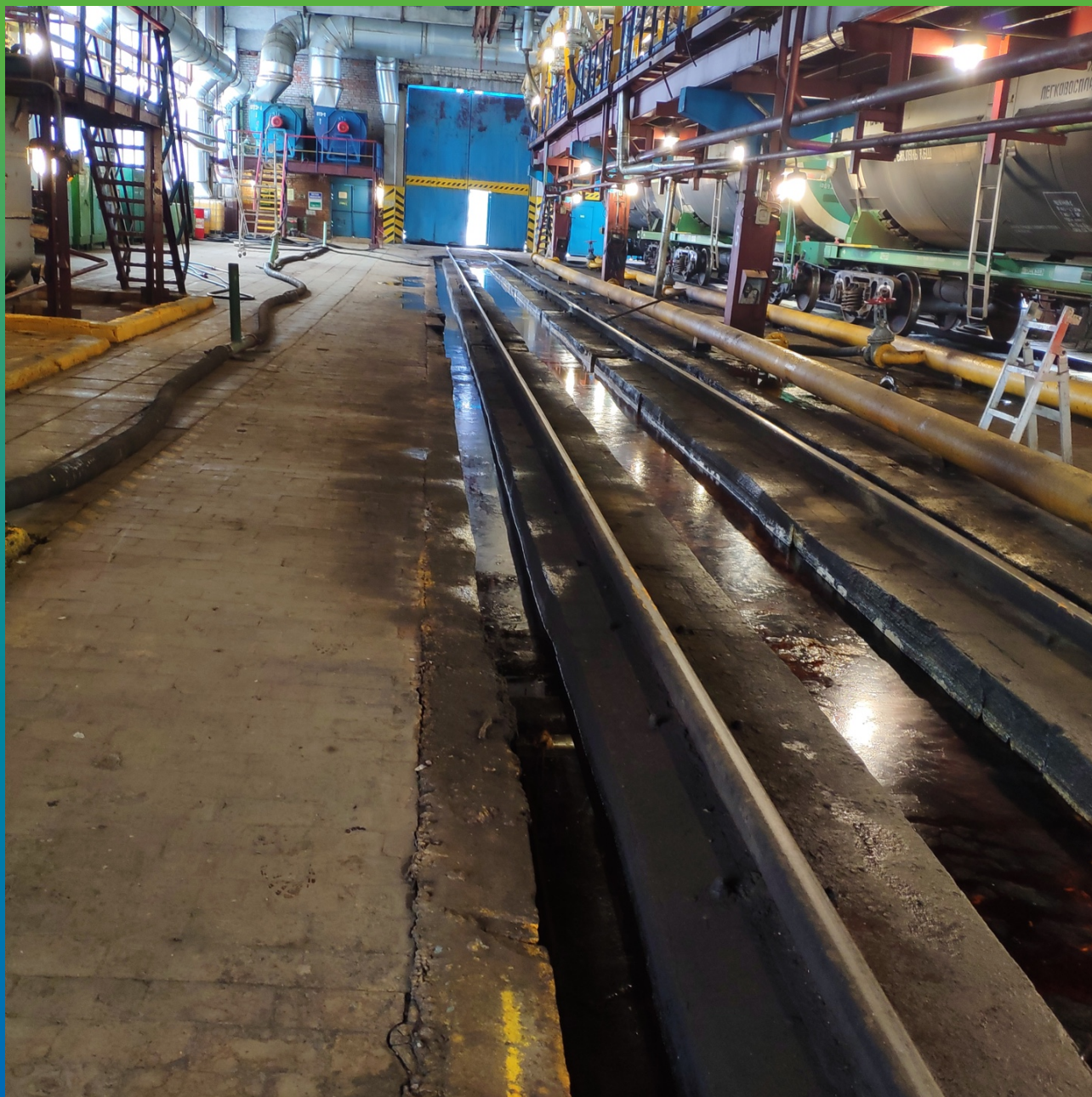
Сливные лотки цеха пропарки цистерн
