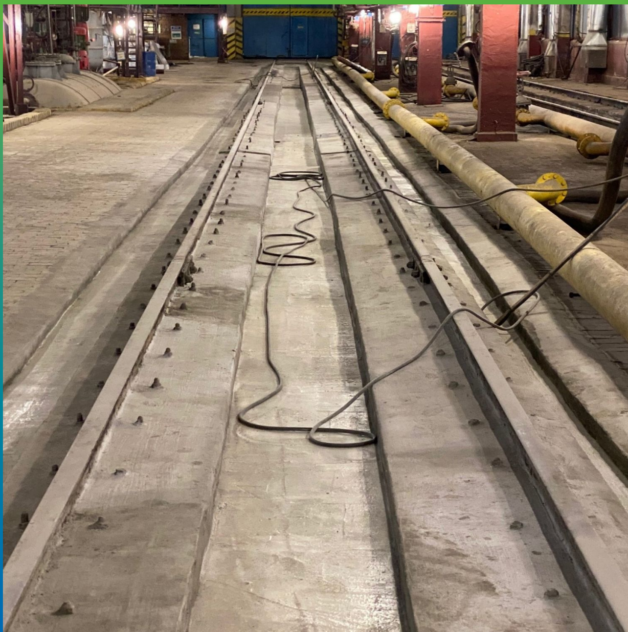
Отремонтированная поверхность лотков
