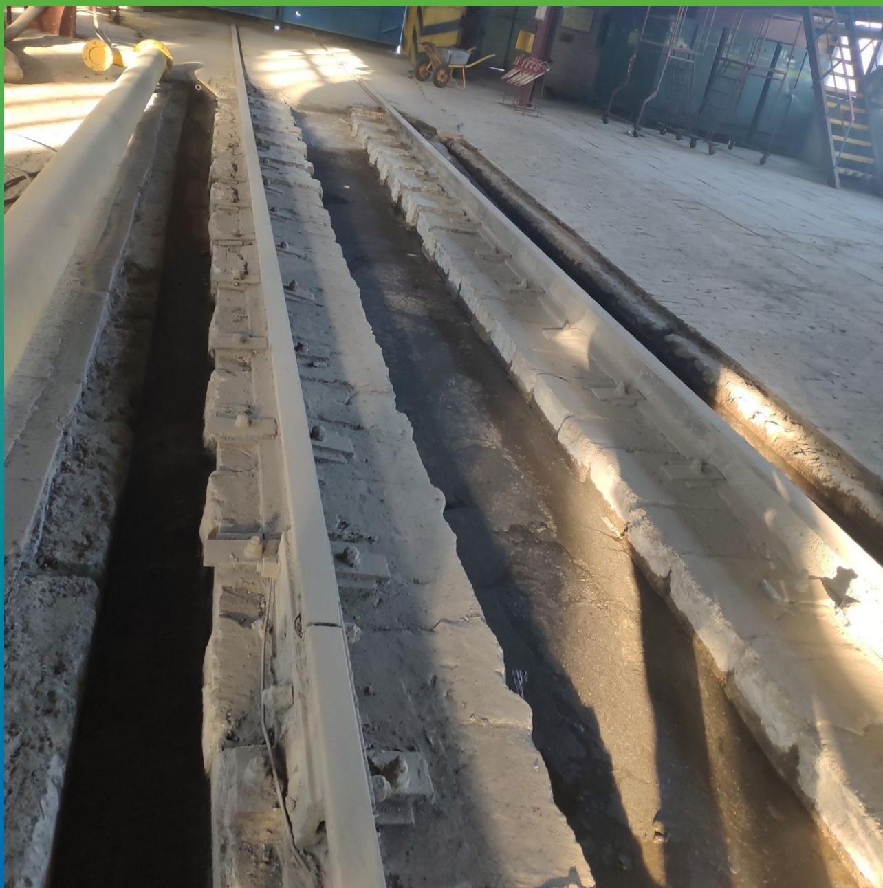
Подготовка основания к укладке ремонтного состава Стармекс РМЗ
