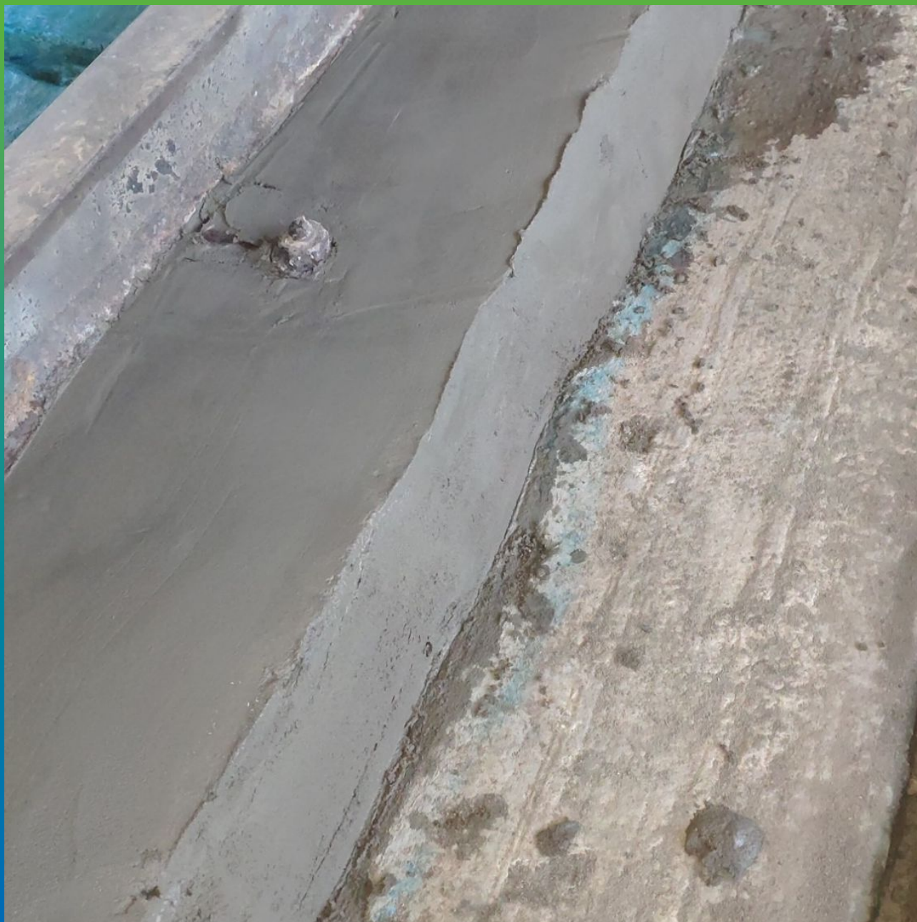
Укладка ремонтного состава Стармекс РМ3
