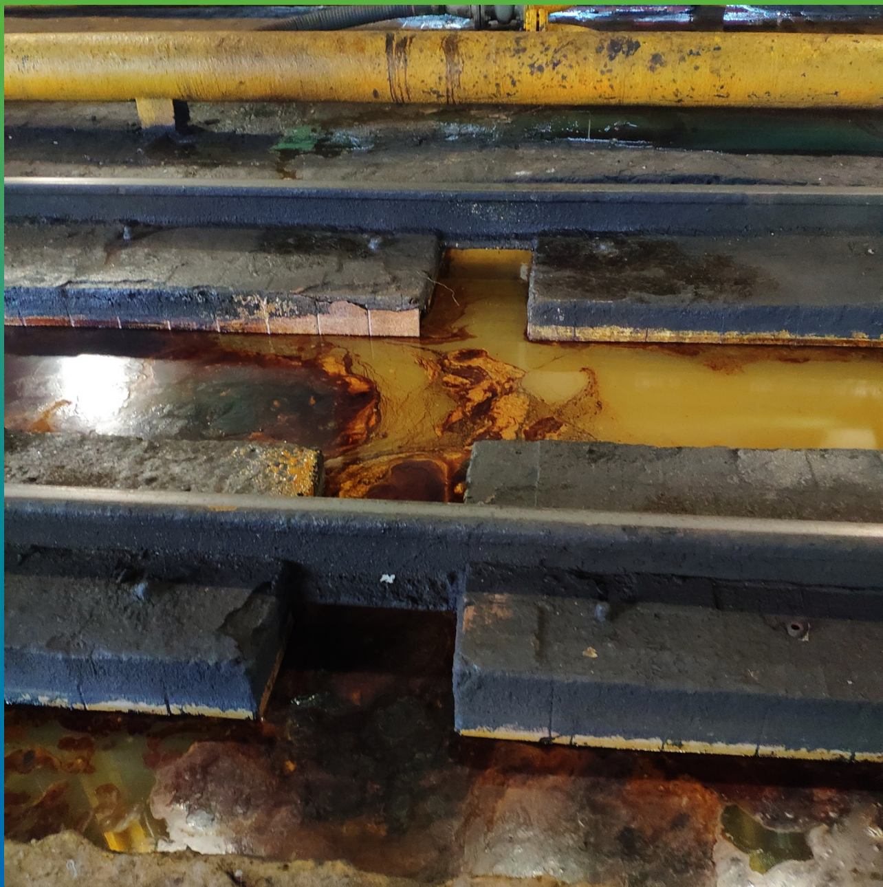
Сливные лотки цеха пропарки цистерн
