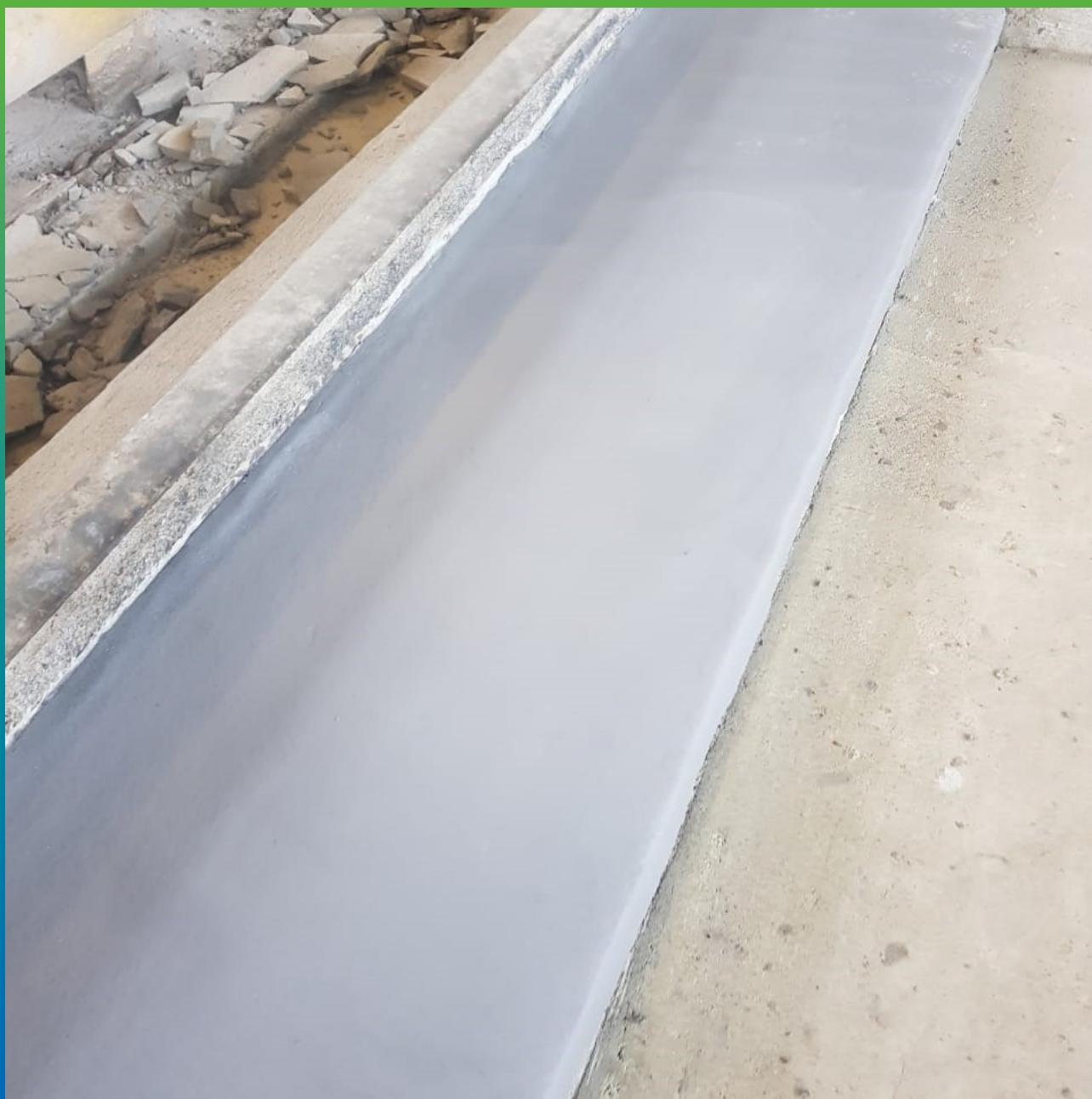
Нанесение химстойких защитных составов ДенсТоп ПМ 605 Тровел и ДенсТоп ПМ 605 ФК
