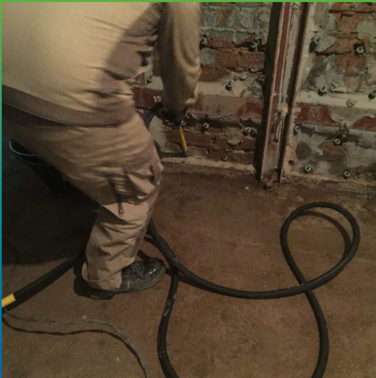
Инъектирование кирпичной кладки при помощи шнекового насоса
