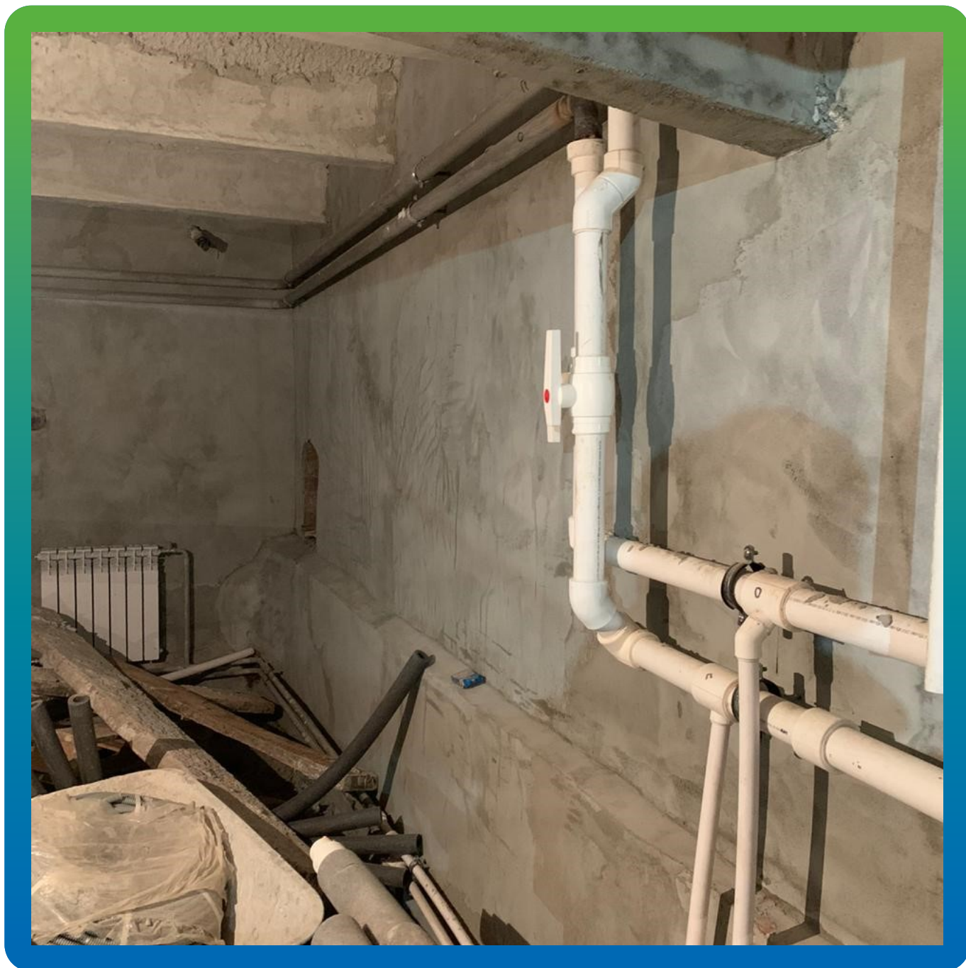
Финишный вид saniрующих составов
