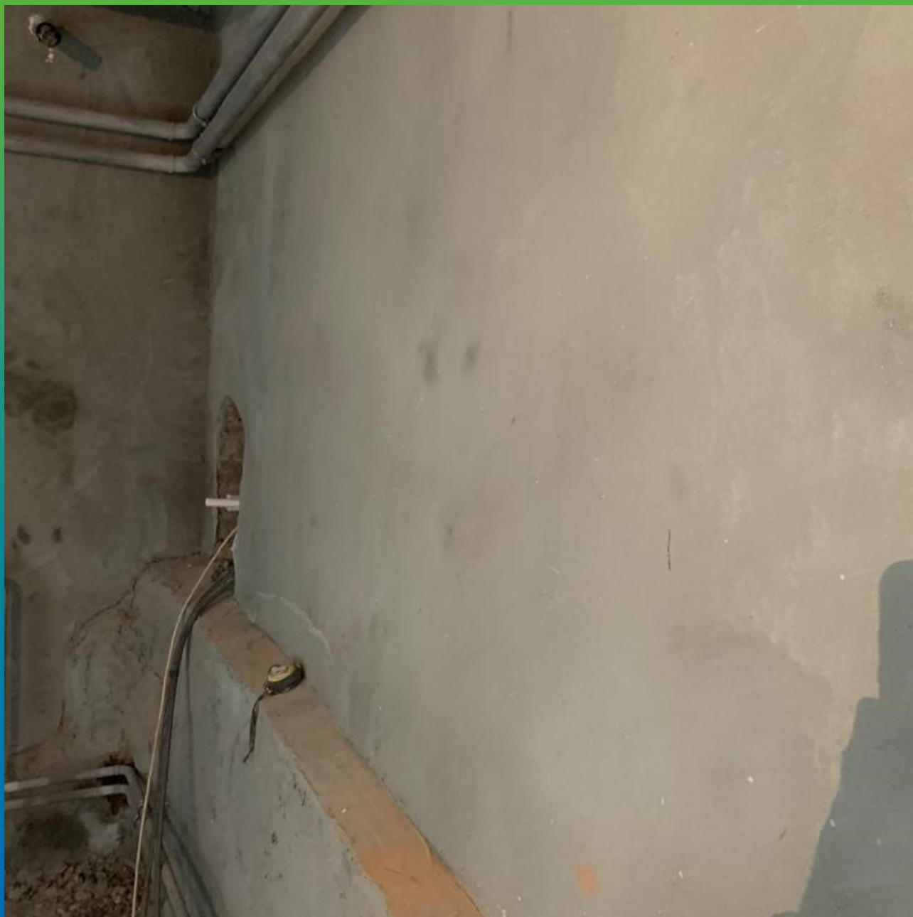
Финишный вид saniрующих составов
