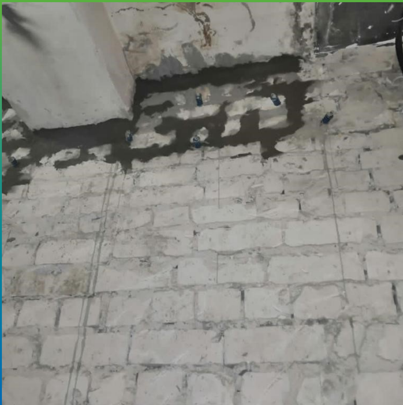
Зона усиления проема с зачеканенными Стармекс РМЗ швами и монтированными пакерами БМ 2839
