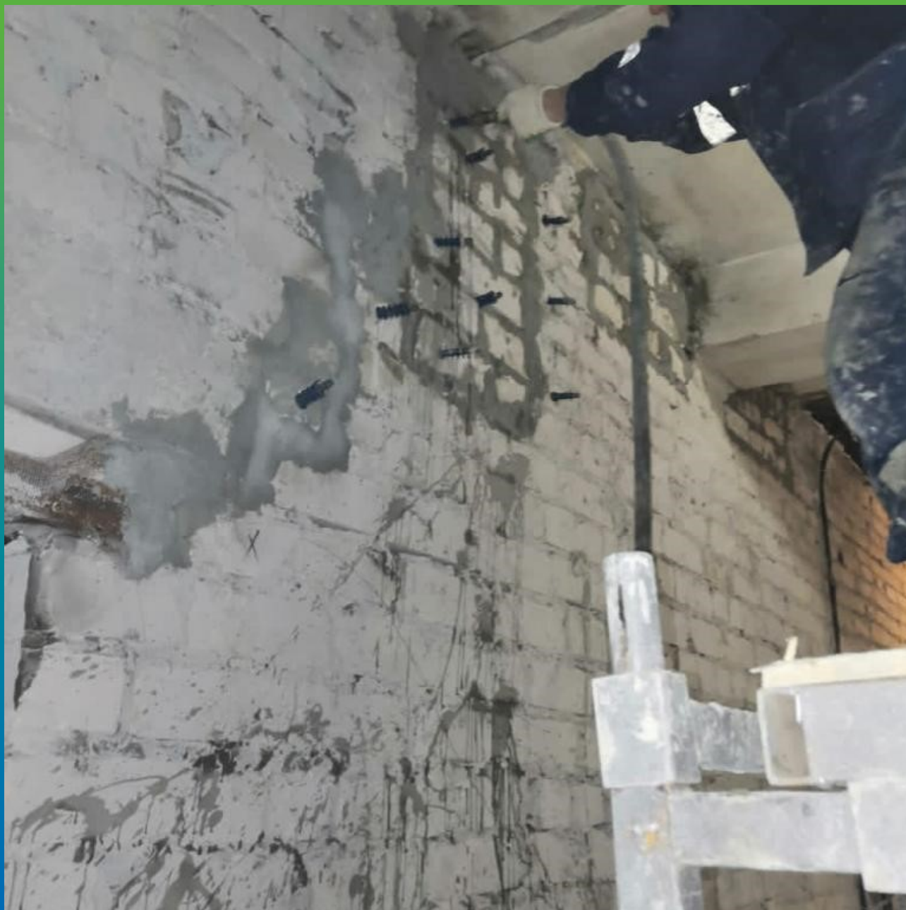
Инъектирование кирпичной кладки
