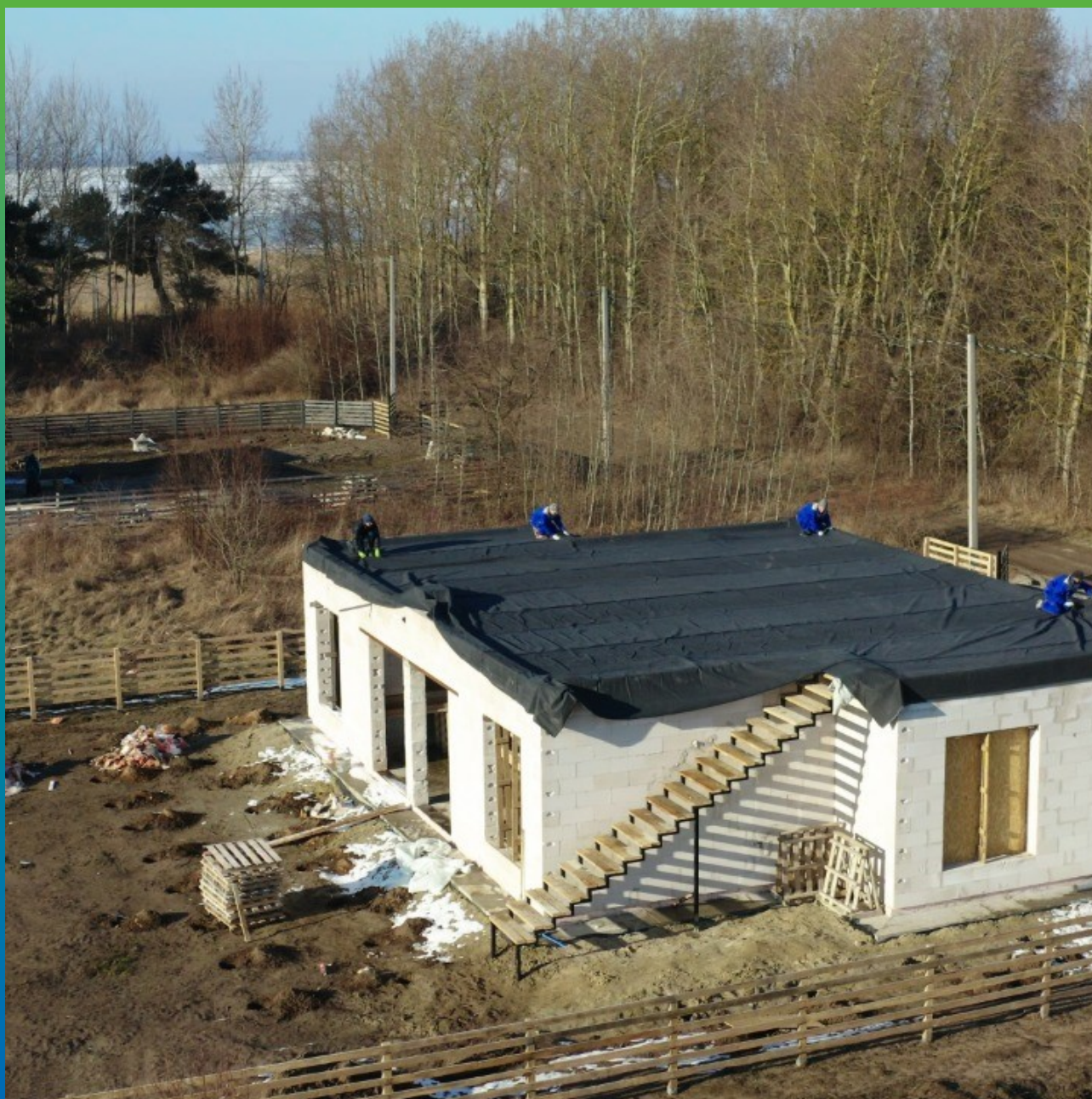
Расстил мембраны по кровле
