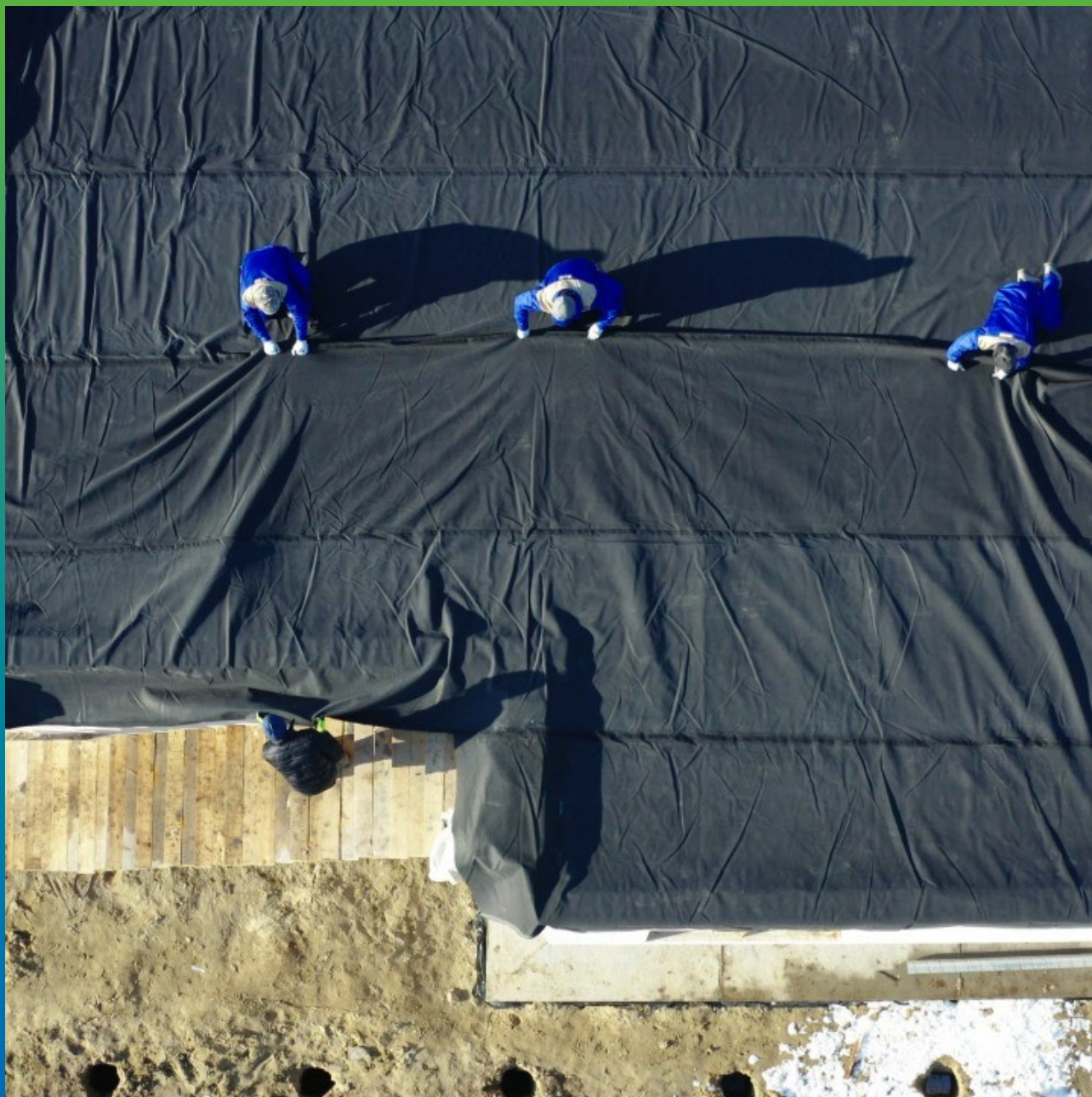
Монтаж Преласты СТ 1,2
