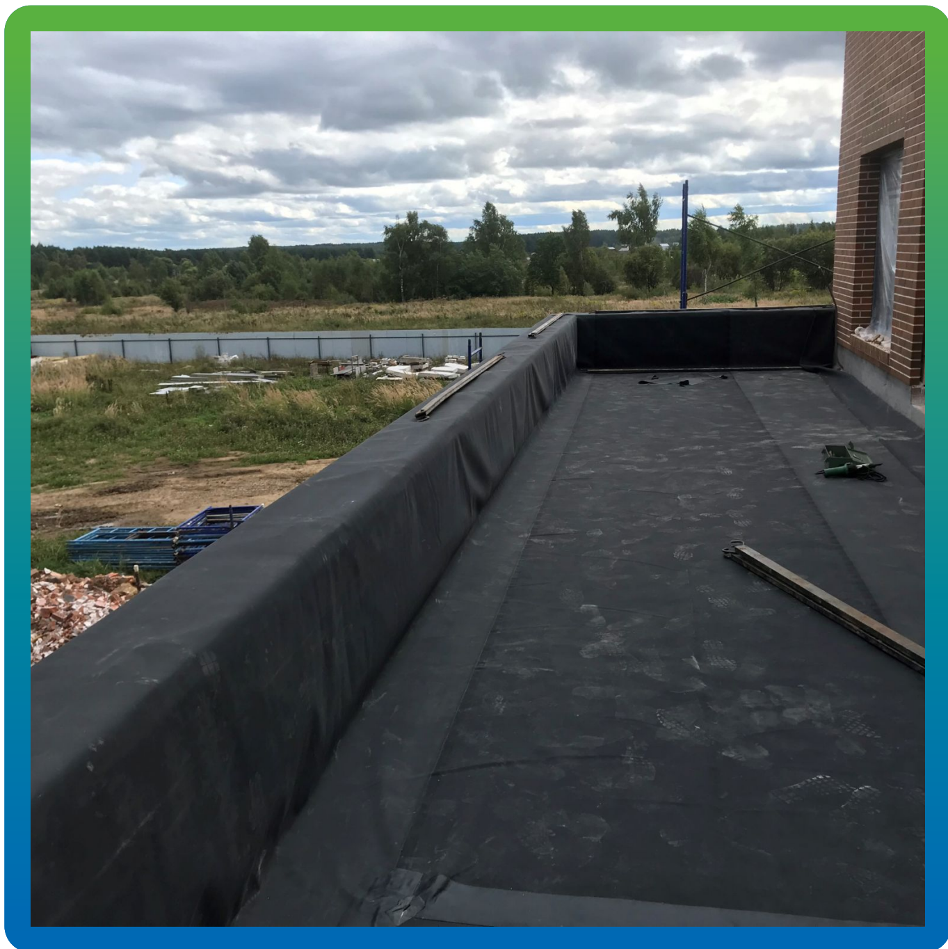
Итоговый вид гидроизолированного балкона
