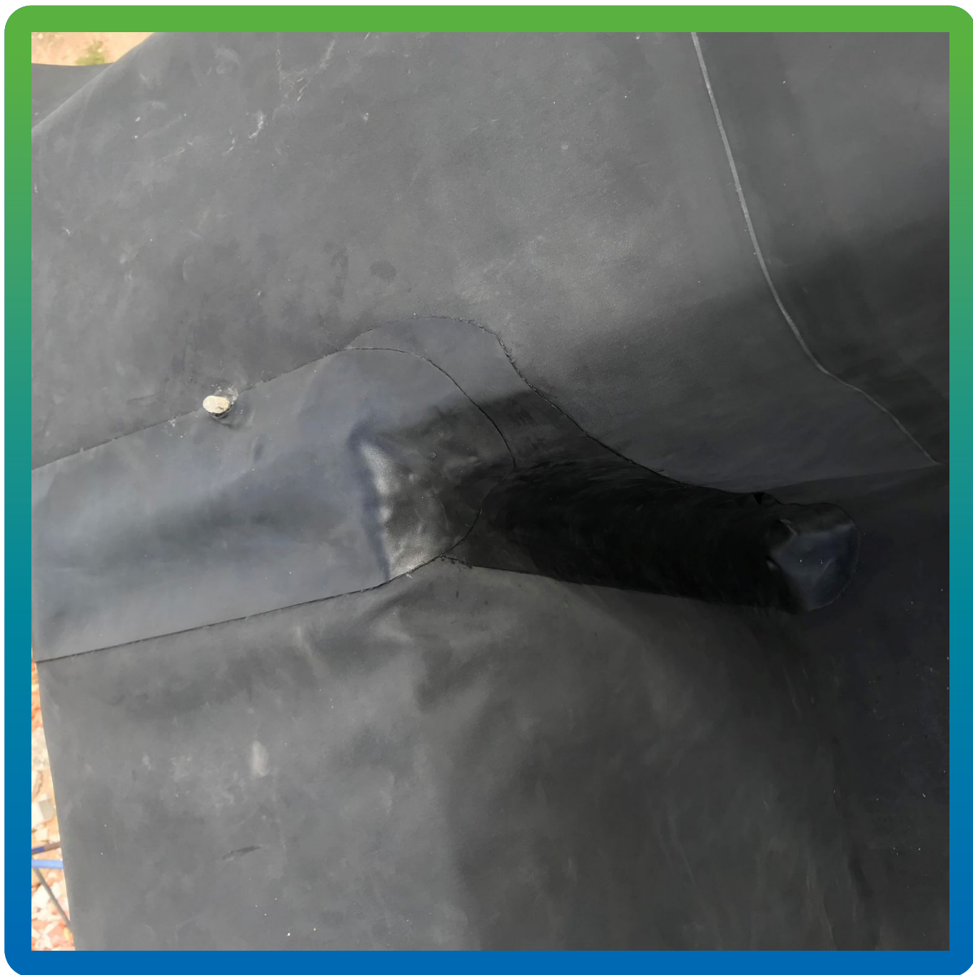
Итог по обварке углов материалом Термобонд 150x20
