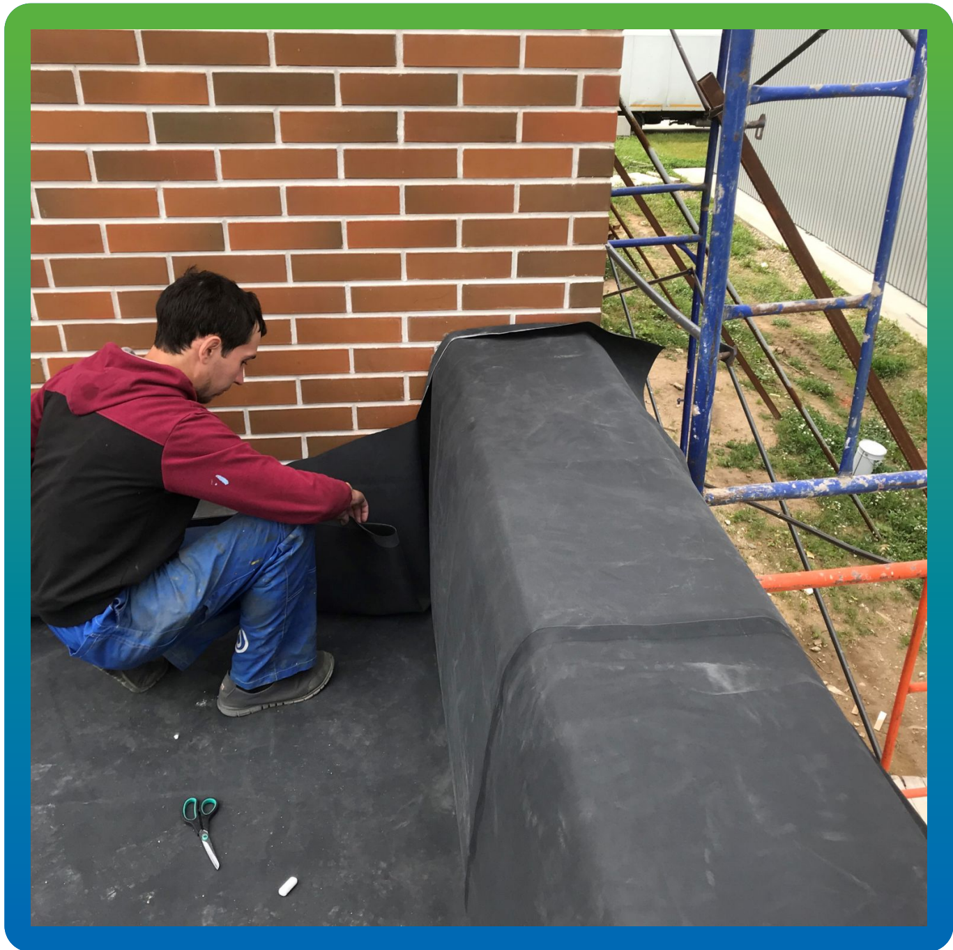
Обварка и раскрой угловых примыканий
