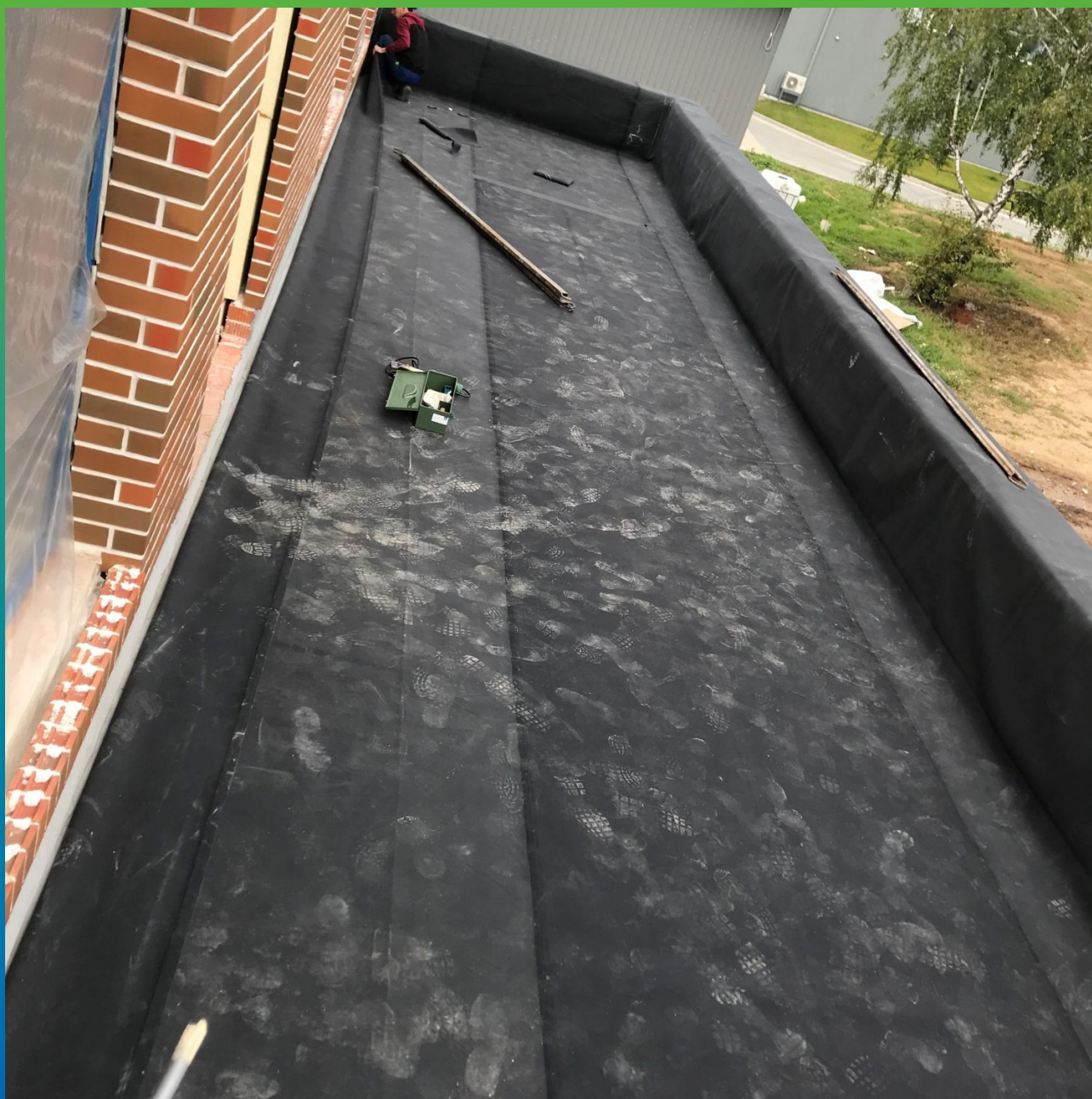
Вид уложенной и раскроенной мембраны на балконе
