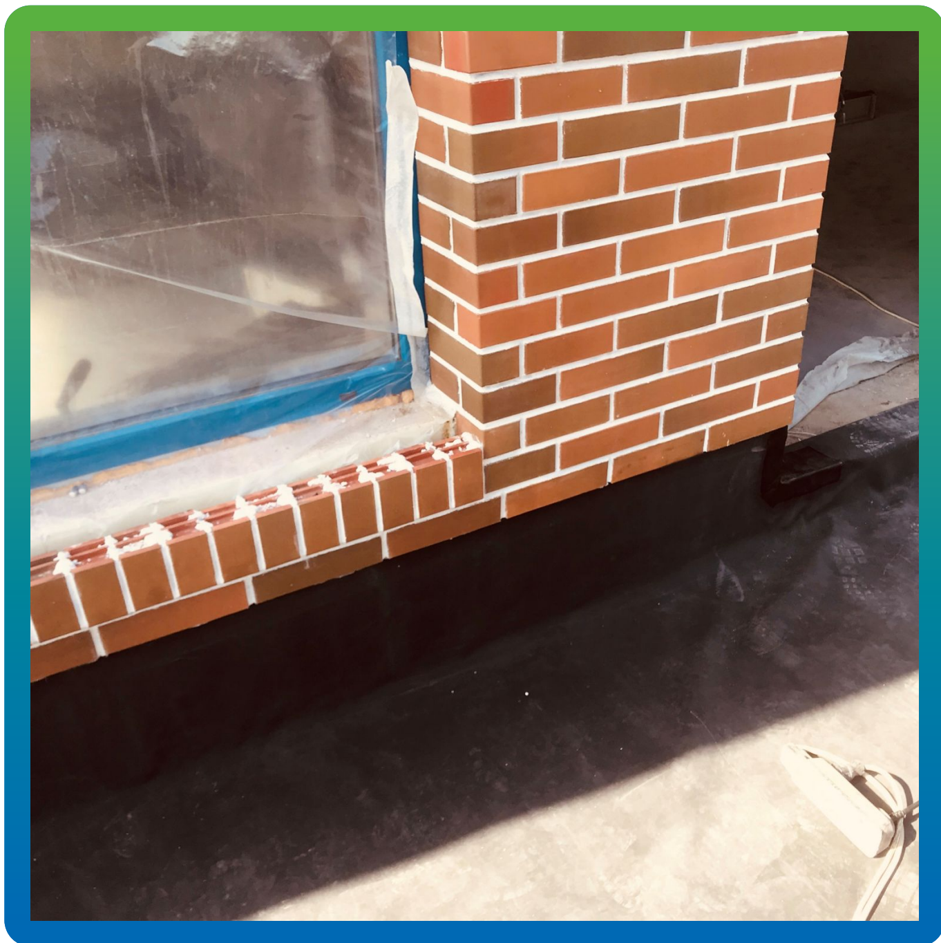
Примыкания к зданию АБК
