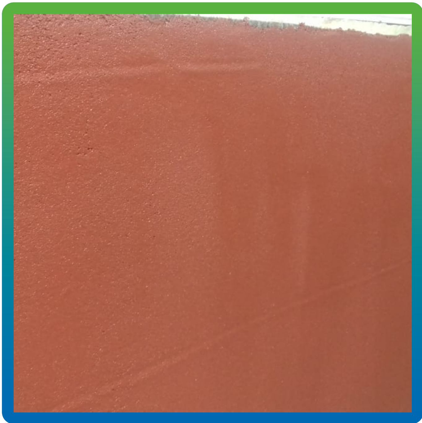
Вертикальный бортик, выполненный материалом ДенсТоп ПМ 605 ФК
