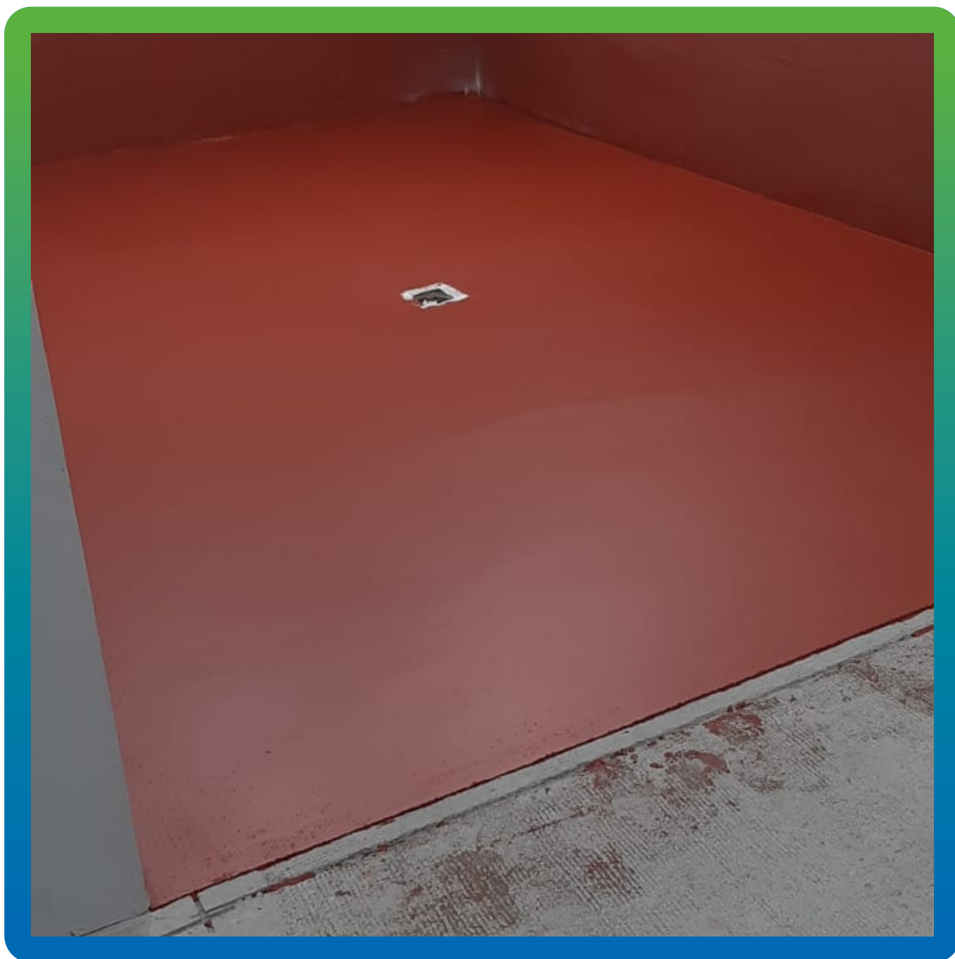
Готовая поверхность пола, выполненная ДенТоп ПМ 605 Трвел
