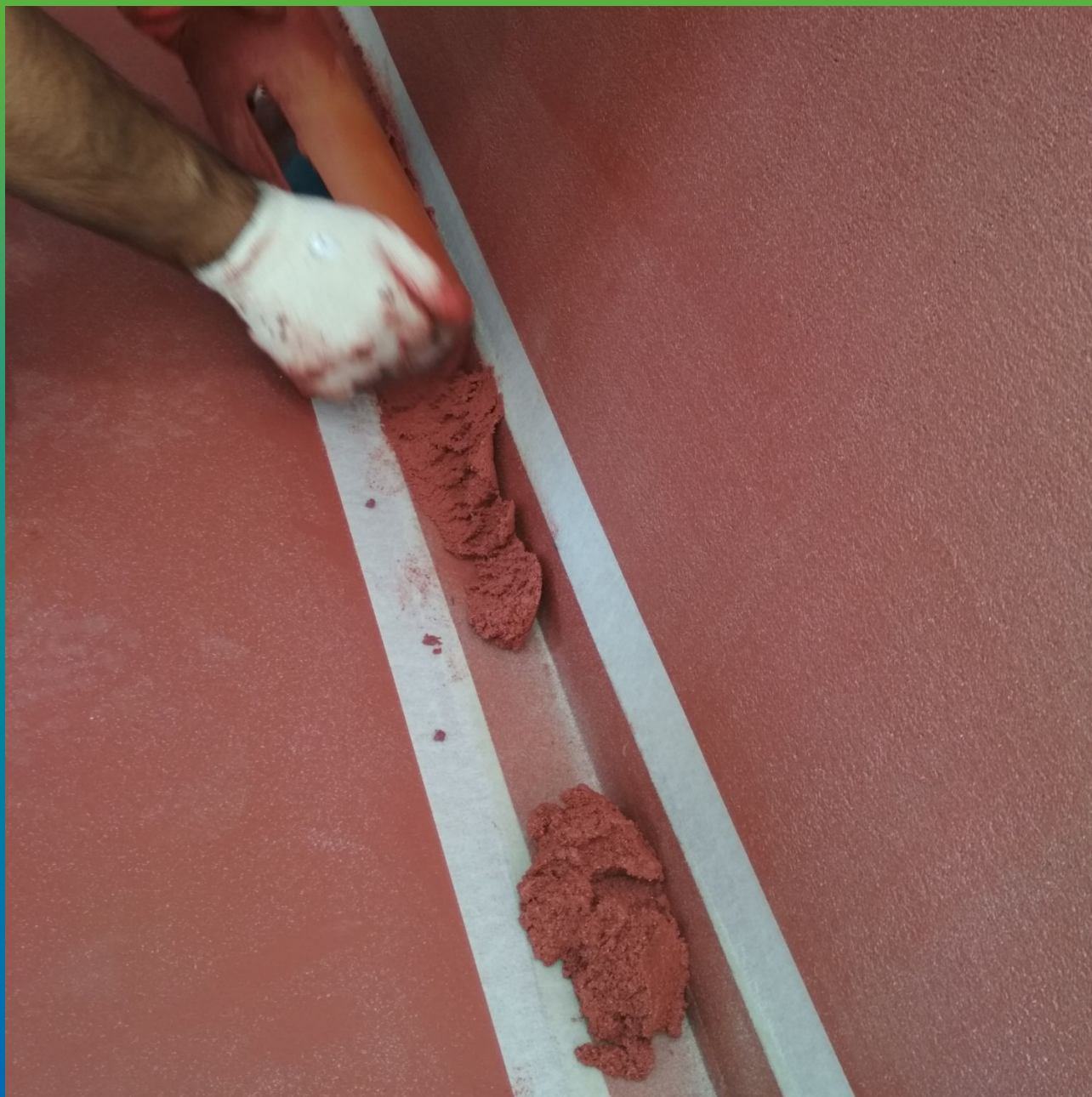
Выполнение плинтуса из материала ДенсТоп ПМ 605 ФК
