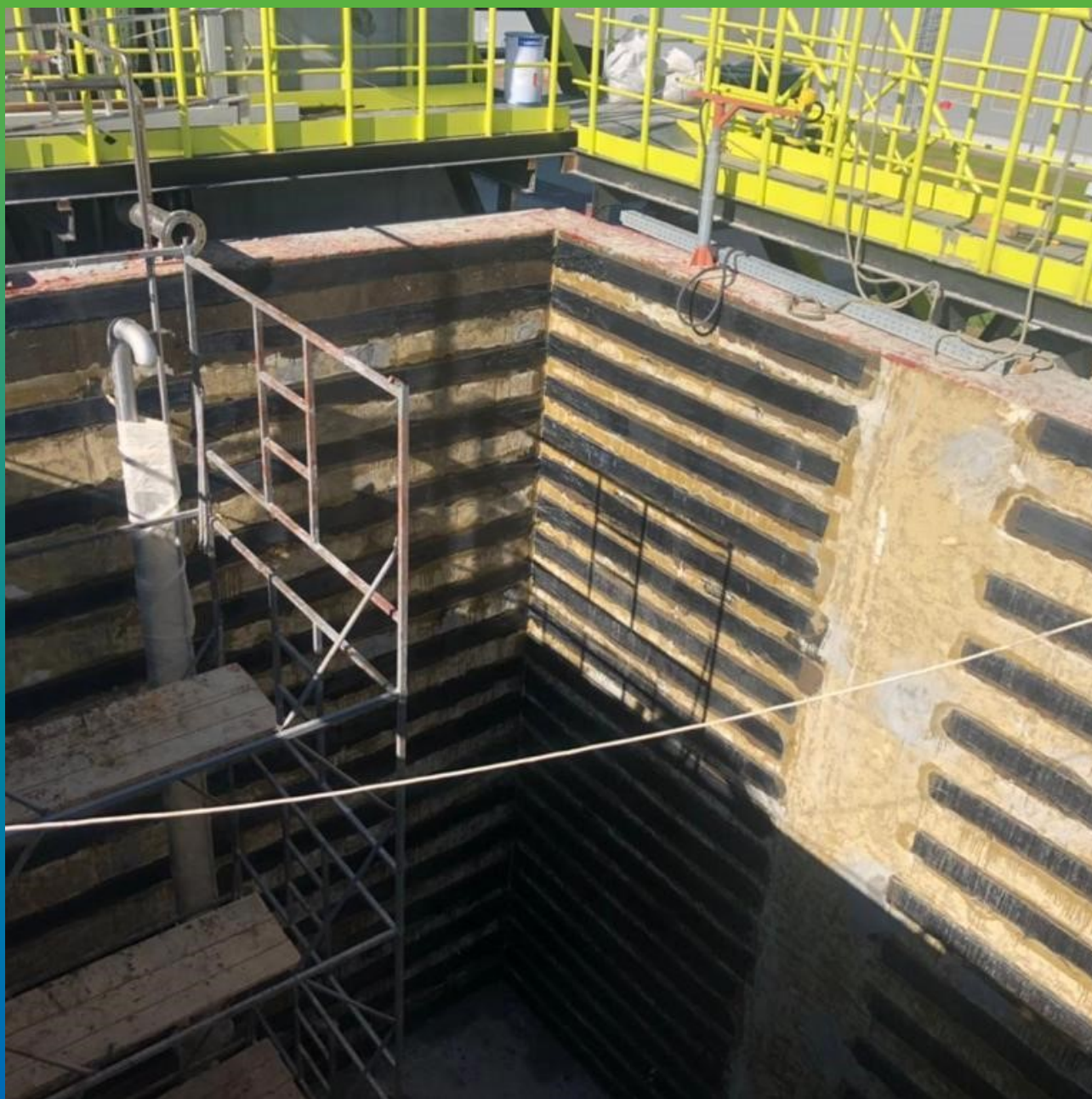
Армошел KB 500, монтированный на внутреннюю поверхность резервуара как дополнительное армирование
