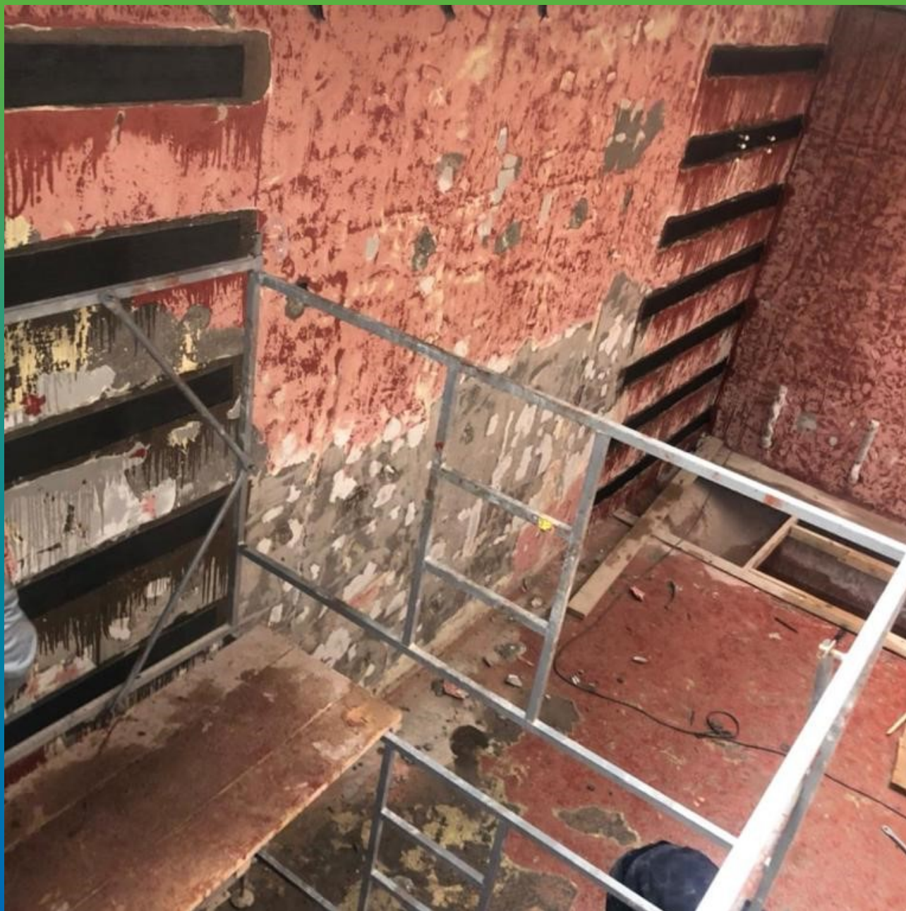
Армошел КВ 500, монтированный на внутреннюю поверхность резервуара как дополнительное армирование
