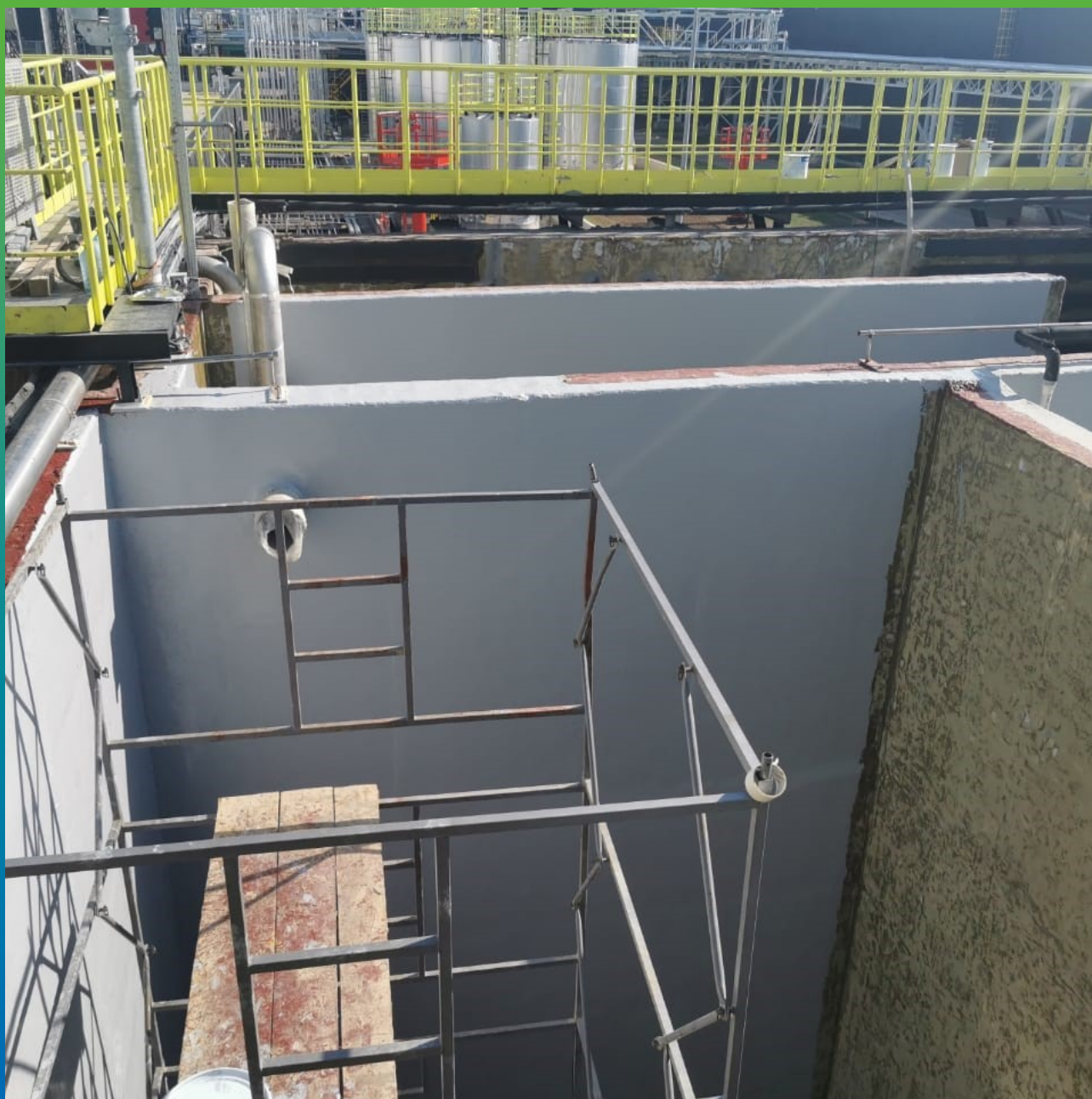
Нанесение ДенсТоп МС 351 по грунтовочному составу ДенсТоп ПУ 91
