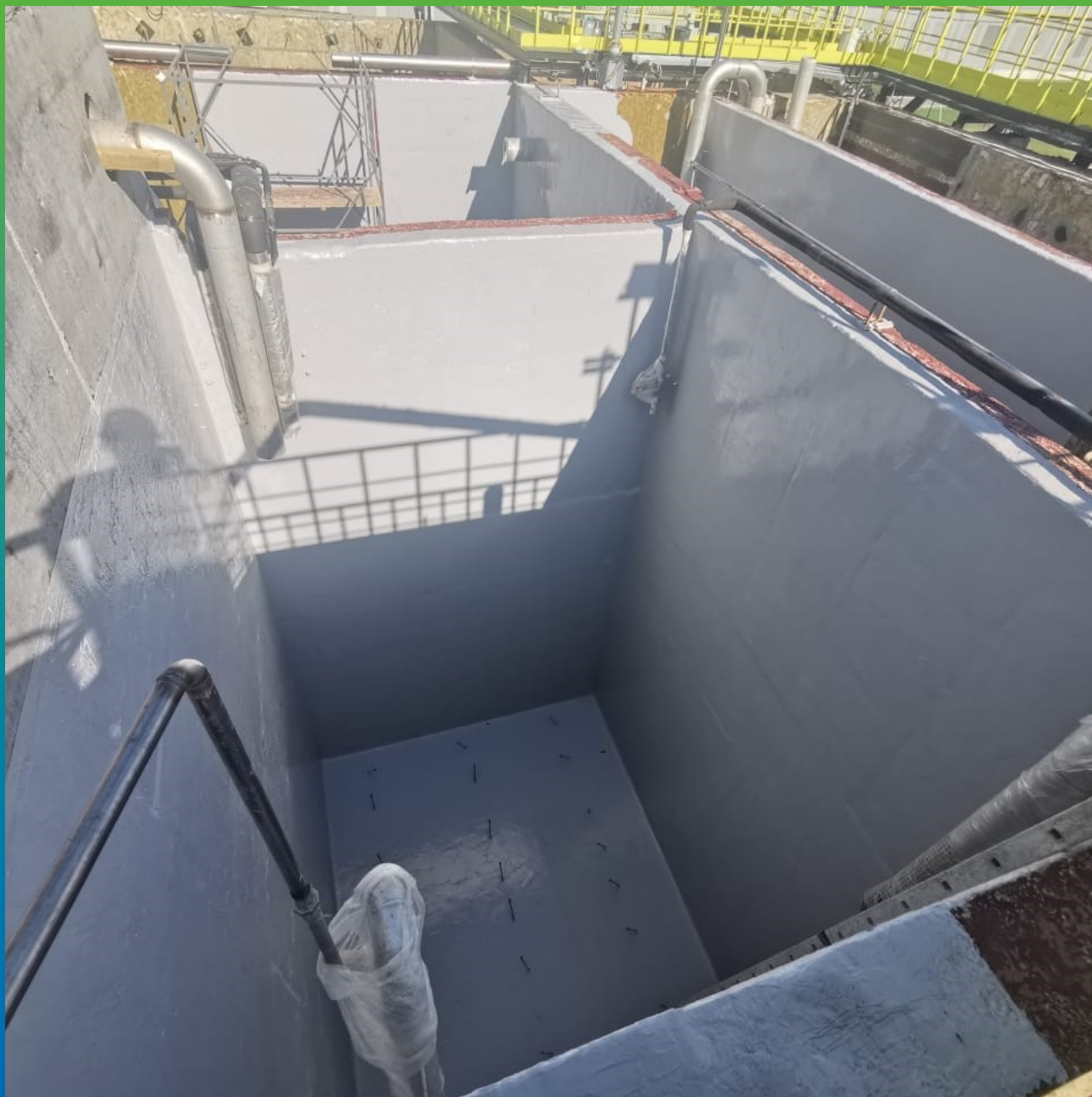
Резервуар, покрытый ДенсТоп МС 351
