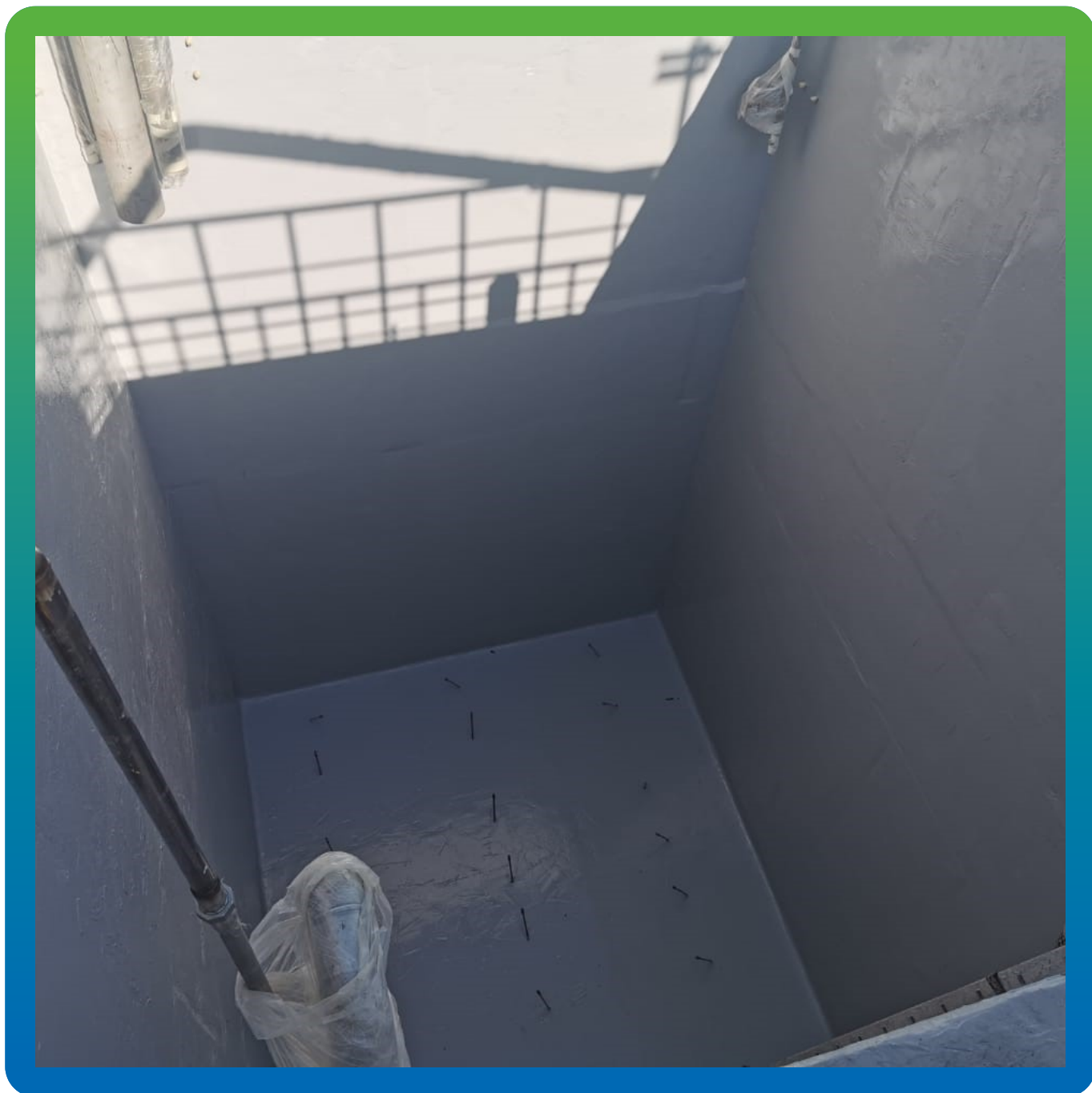
Резервуар, покрытый ДенТоп МС 351
