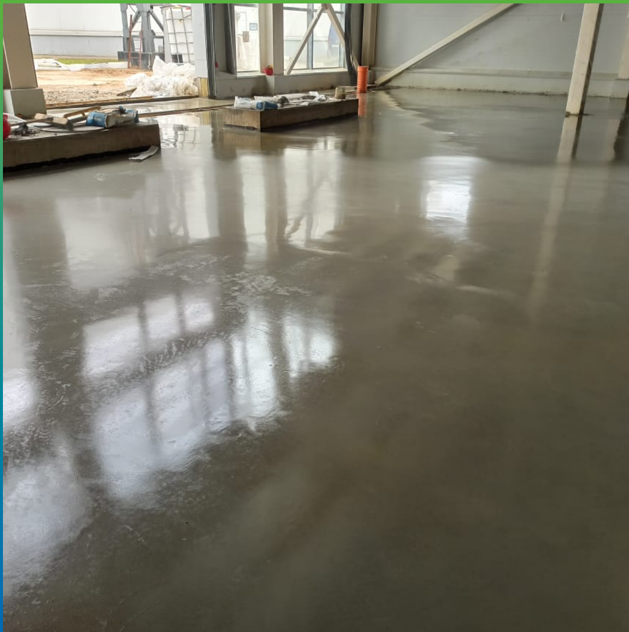
Общий вид после затирки Стармекс Топ Кр
