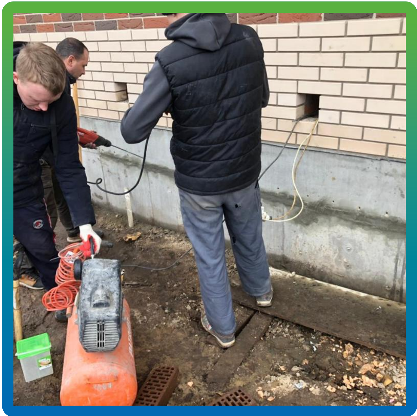
Зачеканка штробы. Сверление шпуров для последующего монтажа пакеров
