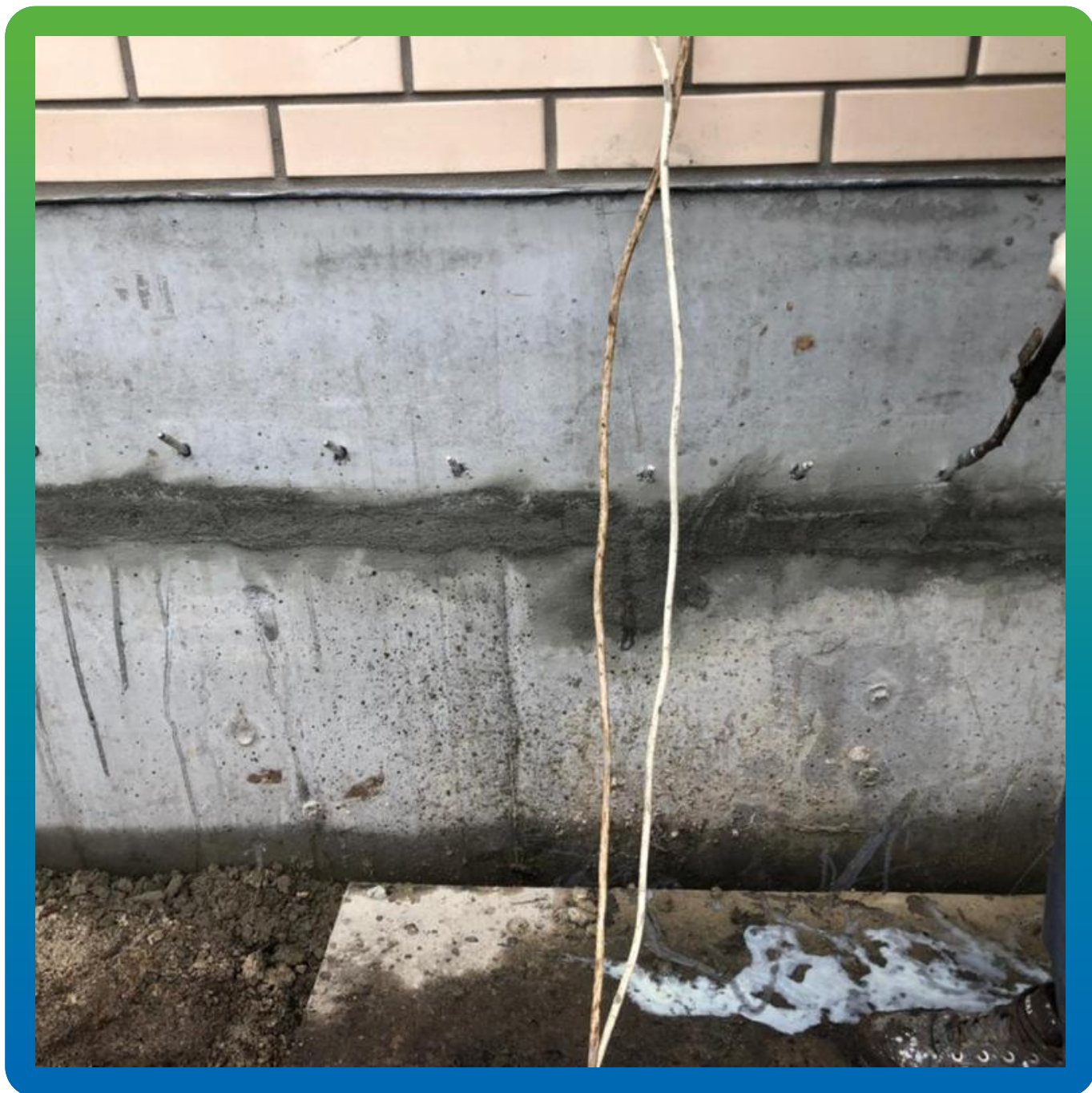
Инъектирование эпоксидного состава Манопокс 352
