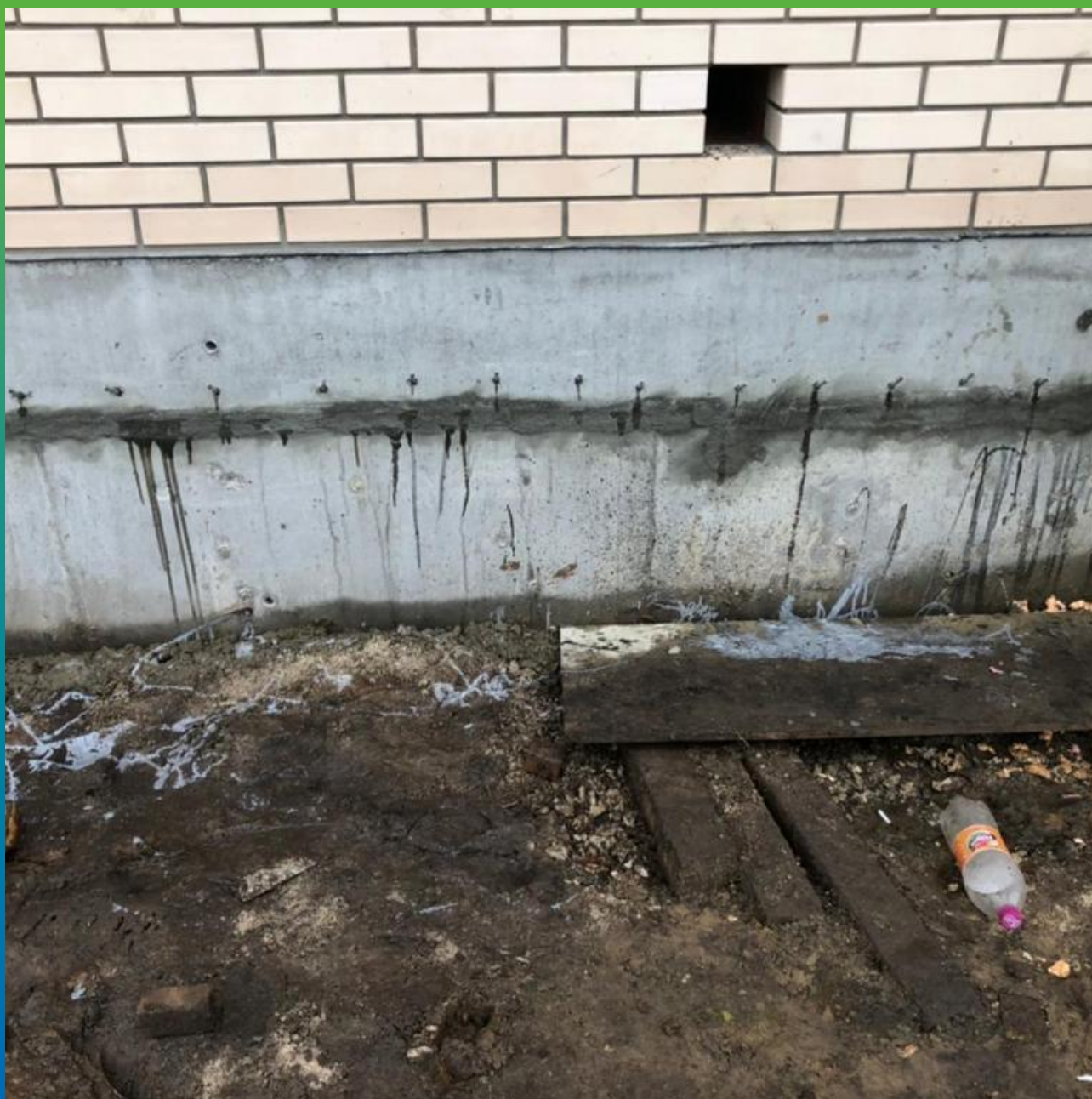
Инъектирование эпоксидного состава Манопокс 352
