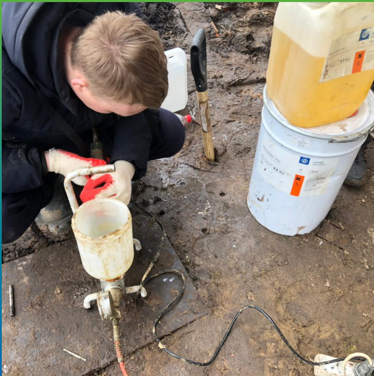
Инъектирование эпоксидного состава Манопокс 352
