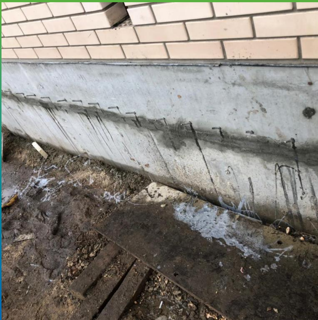
Инъектирование эпоксидного состава Манопокс 352
