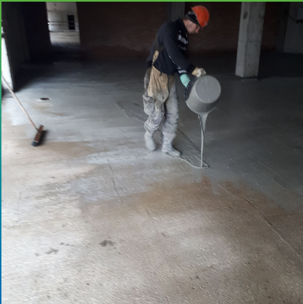
Подготовленный материал Стармекс Сил выливают на плиту
