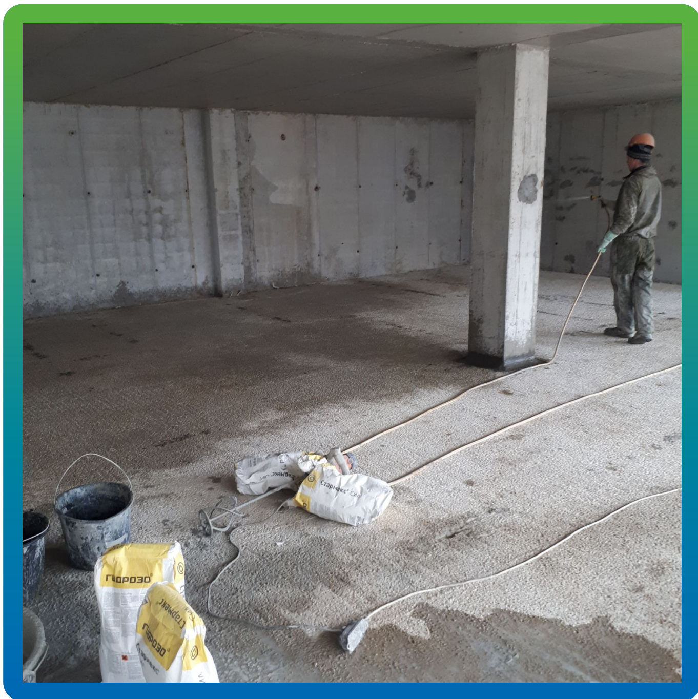
Увлажнение основания перед нанесением гидроизоляции
