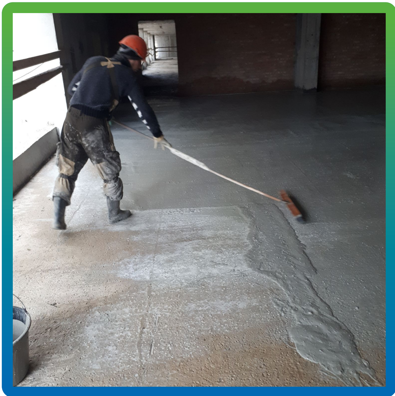
Распределение Стармекс Сил по плите специальной щеткой Стармекс Брум
