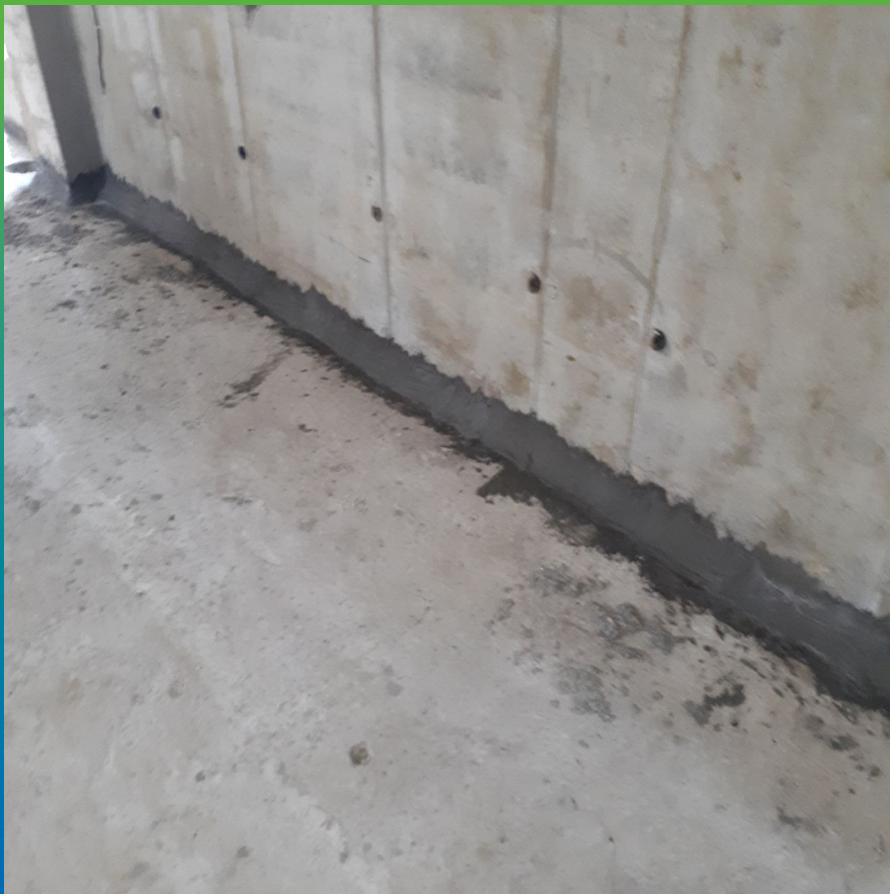
Галтель по примыканию плита-стена из Стармекс РМЗ
