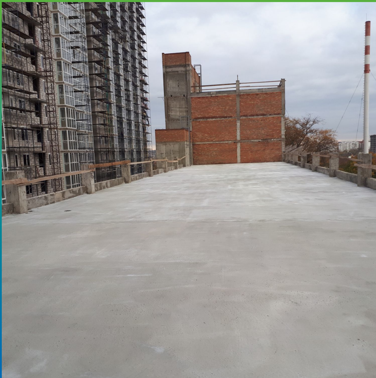
Верхний уровень паркинга, также покрытый Стармекс Сил
