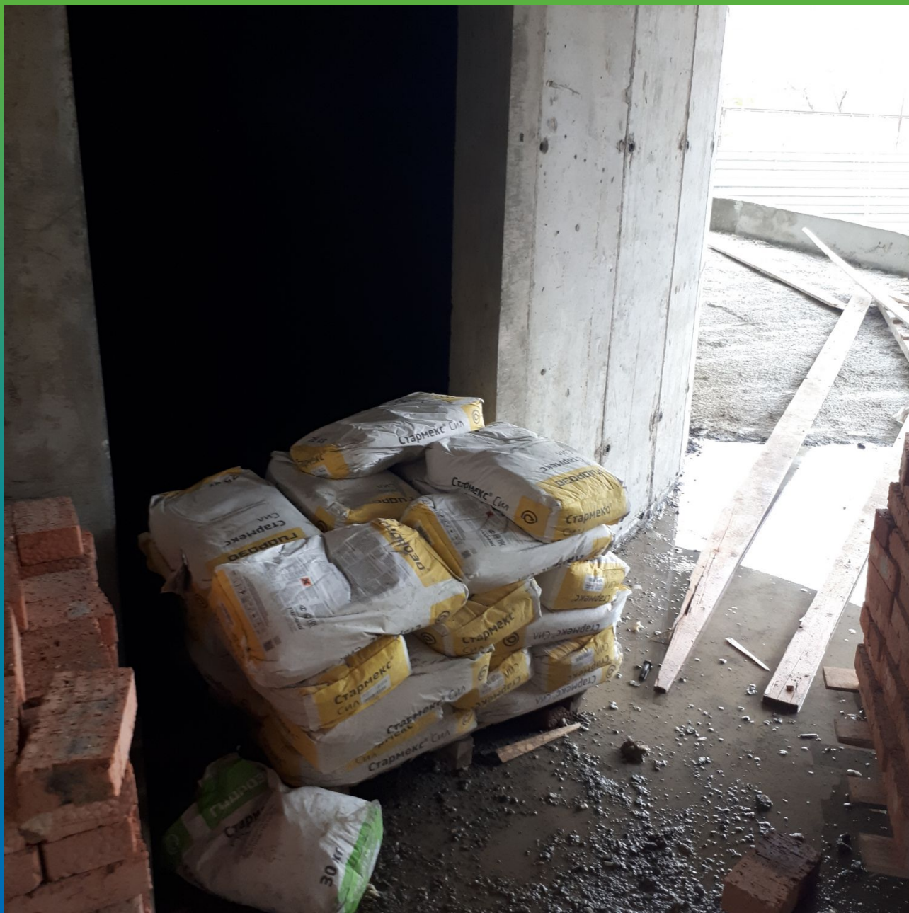
Материал Гидрозо на объекте
