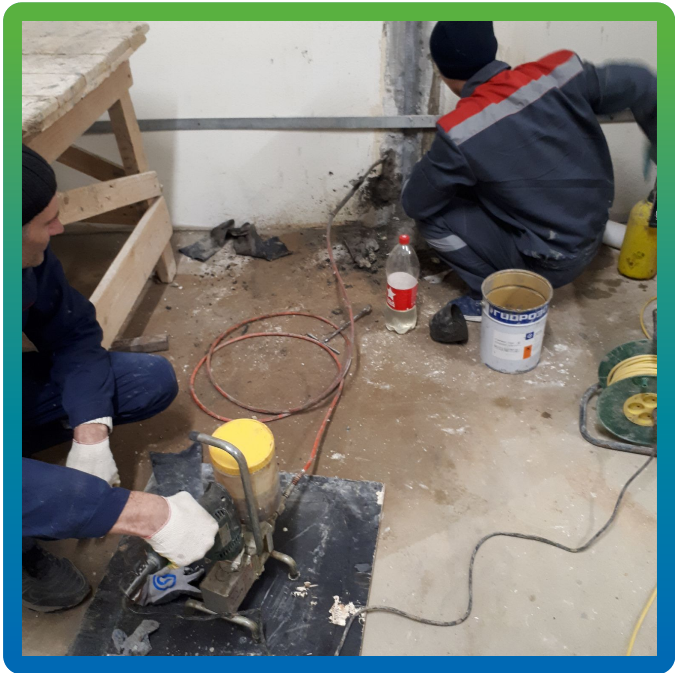
Инъектирование деформационного шва снизу вверх
