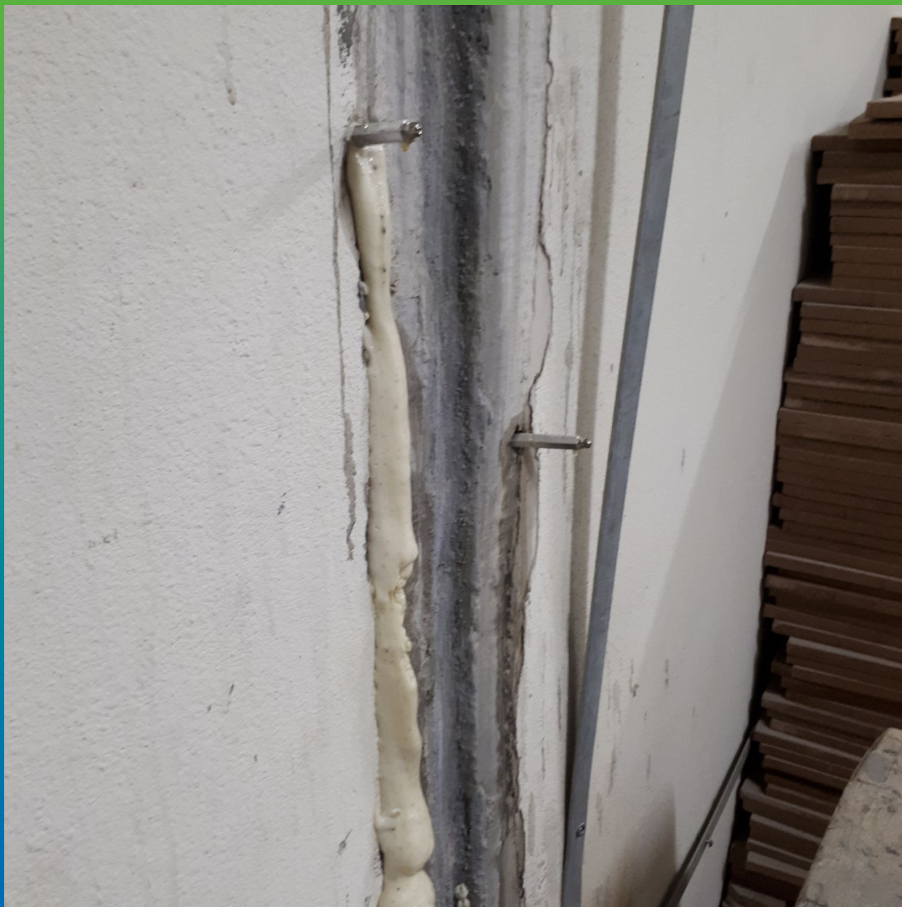
Инъектирование завершено. Выход пены
