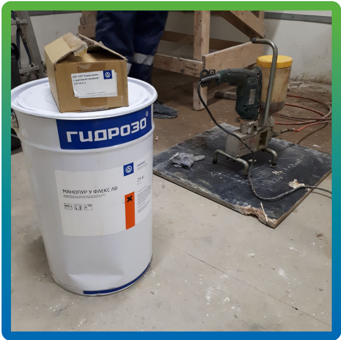
Материал Гидрозо на объекте
