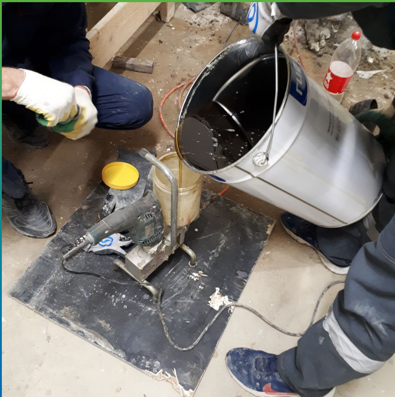
Подготовка высокоэластичной смолы Манопур У Флекс ЛВ
