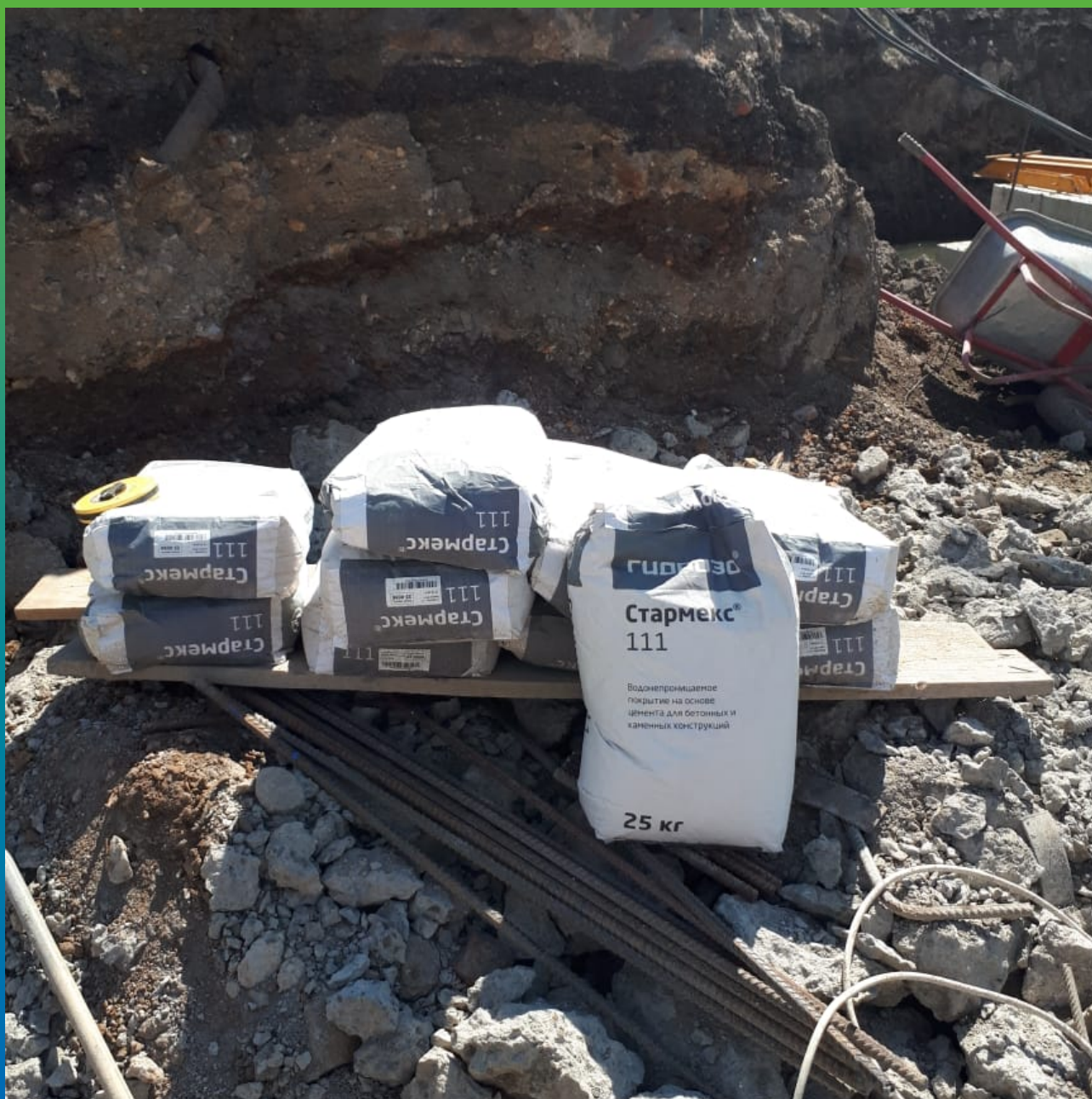
Материалы Гидрозо на объекте
