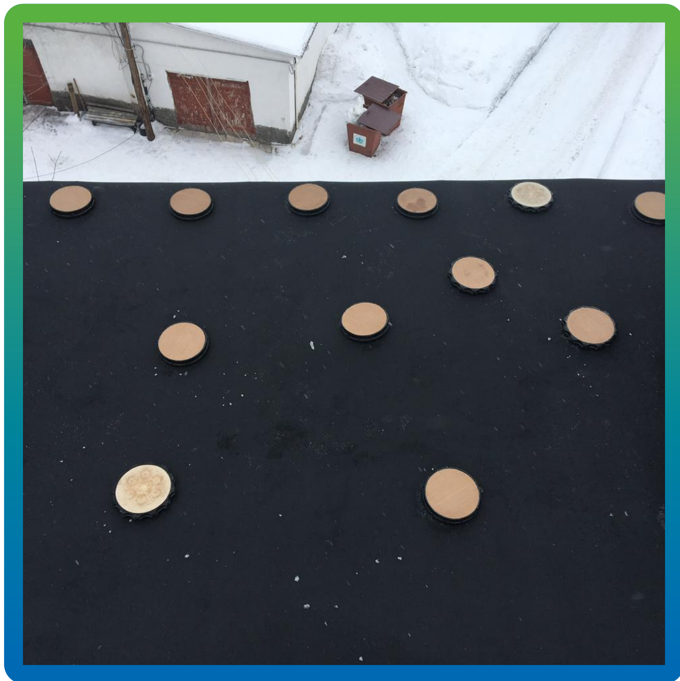
Остужение шайб специальными магнитами Центрикс
