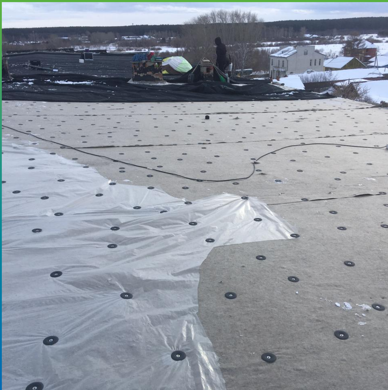
Общий вид смонтированных шайб Центрикс
