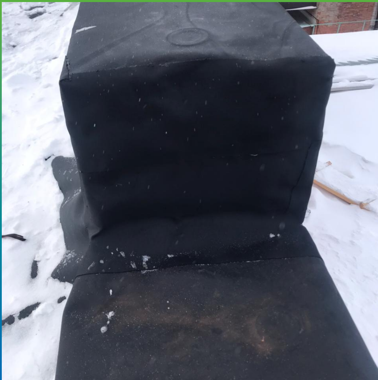
Вид закрепленной мембраны по парапету
