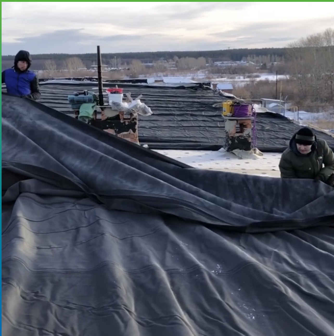
Стыковка и подгонка двух карты ЭПДМ-мембраны
