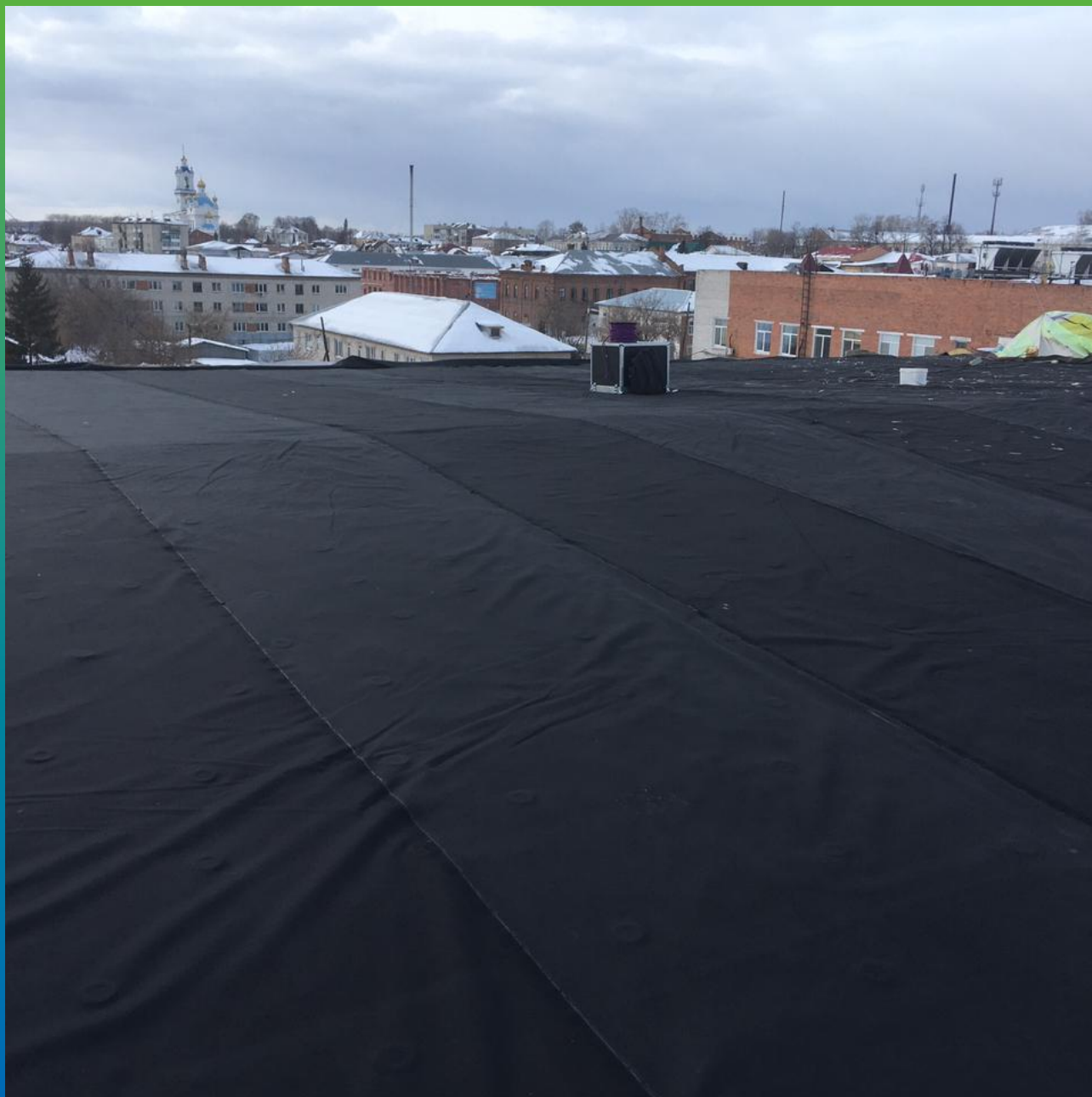
Общий вид закрепленной ЭПДМ-мембраны
