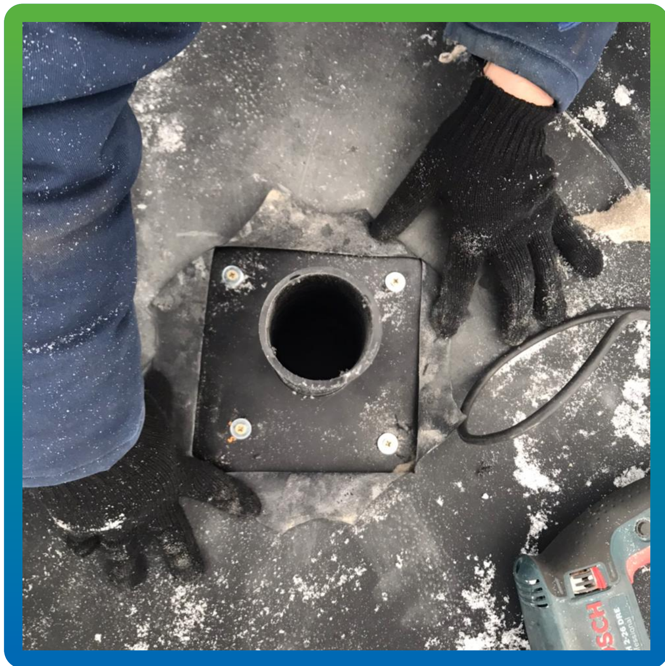
Монтаж аэраторов
