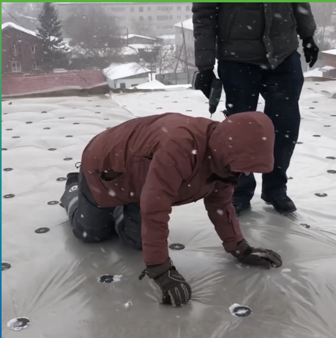
Проверка крепления Шайб Центрикс
