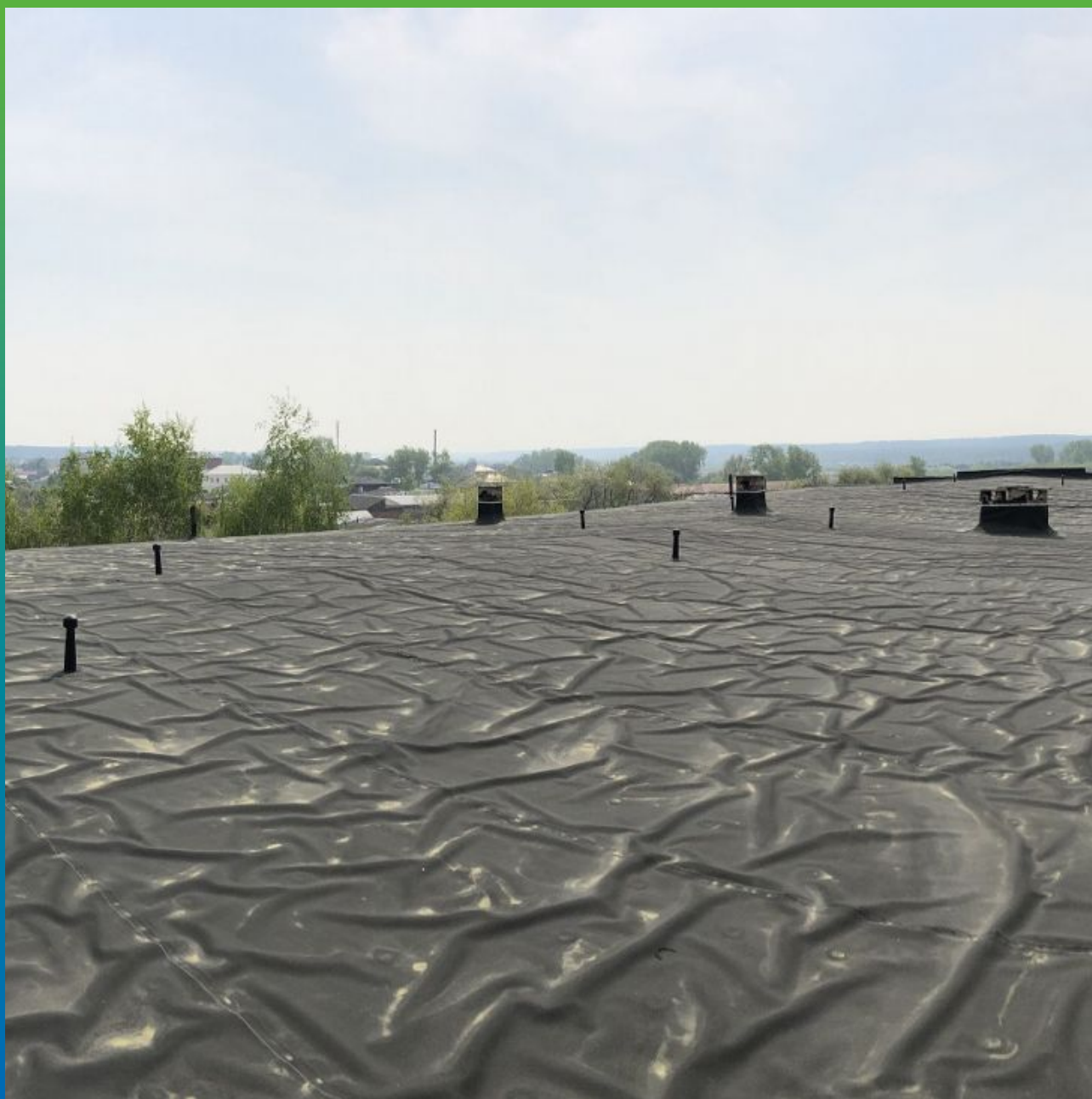
Общий вид объекта в эксплуатации
