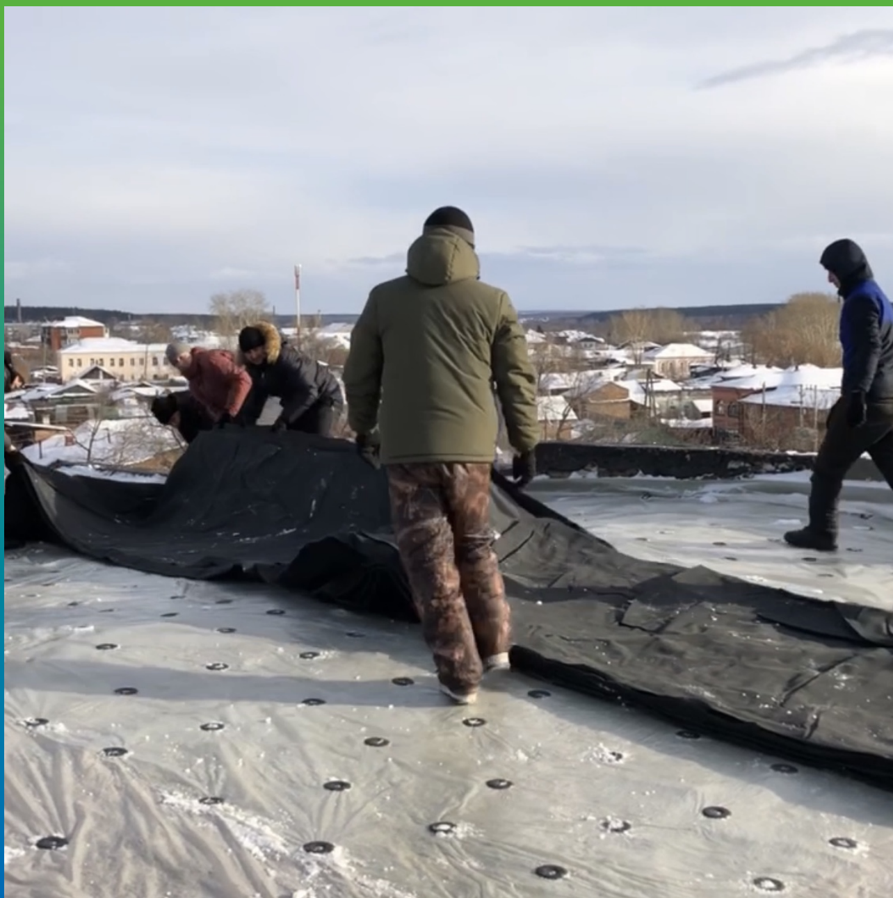
Процесс разворачивания ЭПДМ-мембраны
