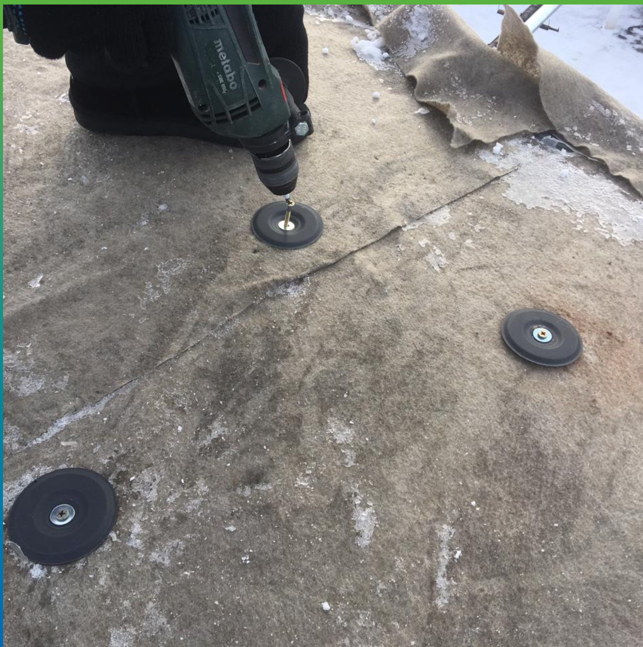
Монтаж шайб Центрикс
