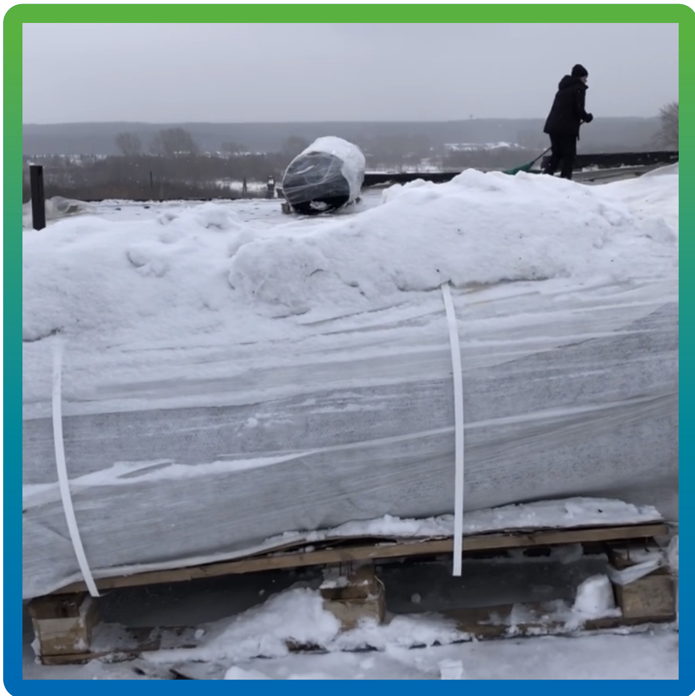
Материал ЭПДМ-мембрана Прелести СТ 1,2 мм на объекте
