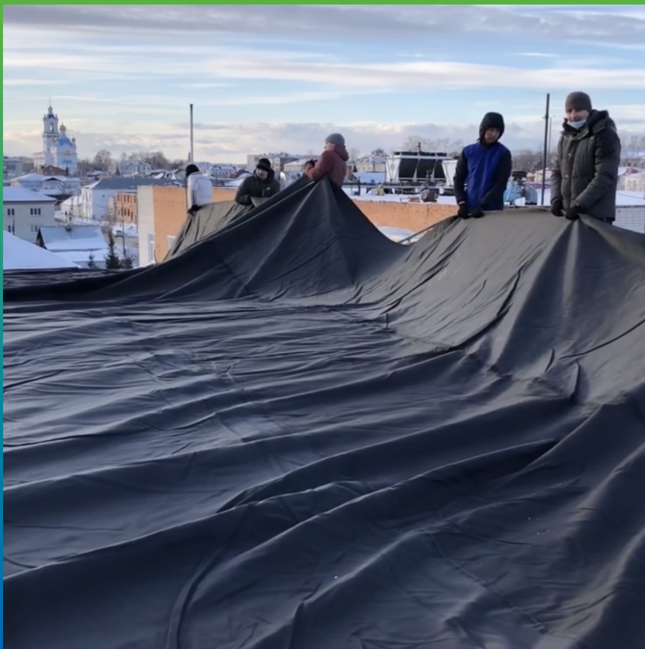
Процесс разворачивания ЭПДМ-мембраны
