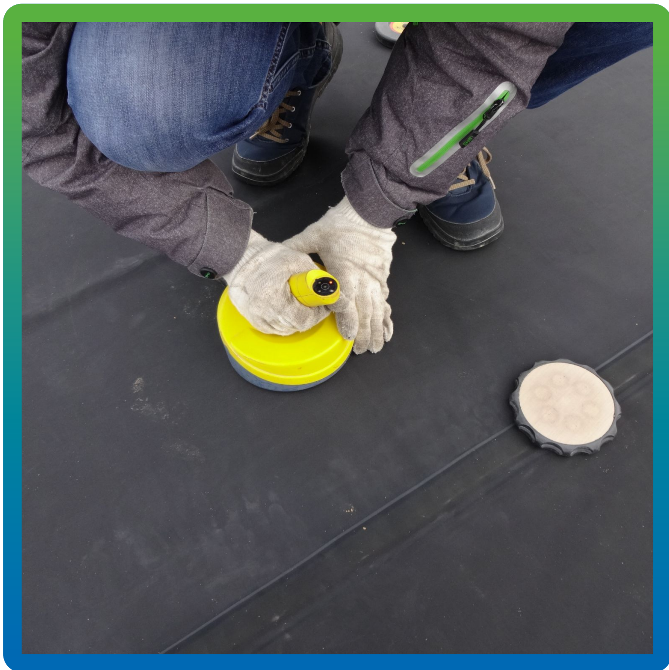
Закрепление полотна индукционным аппаратом Центрикс без прокола
