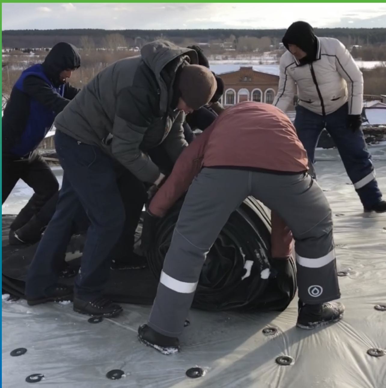
Процесс разворачивания ЭПДМ-мембраны
