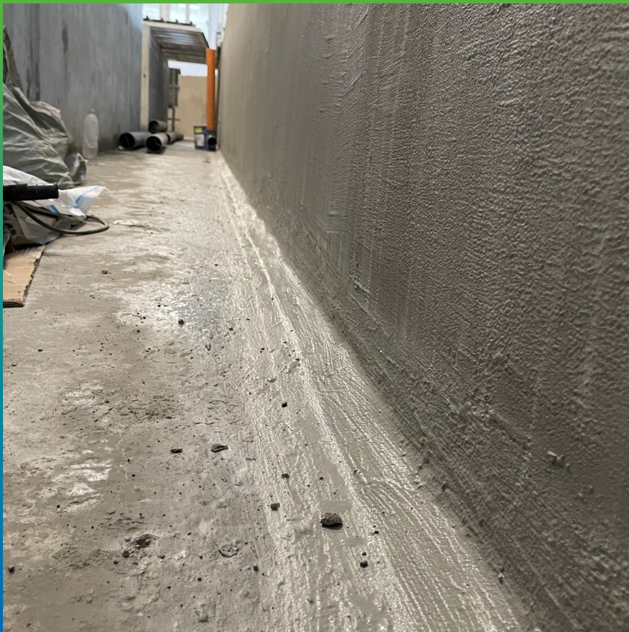
Шов, заполненный составом Стармекс РМЗ
