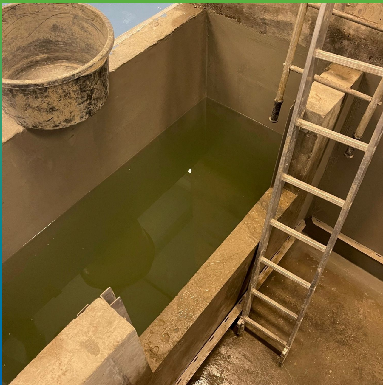
Проведение гидроиспытаний
