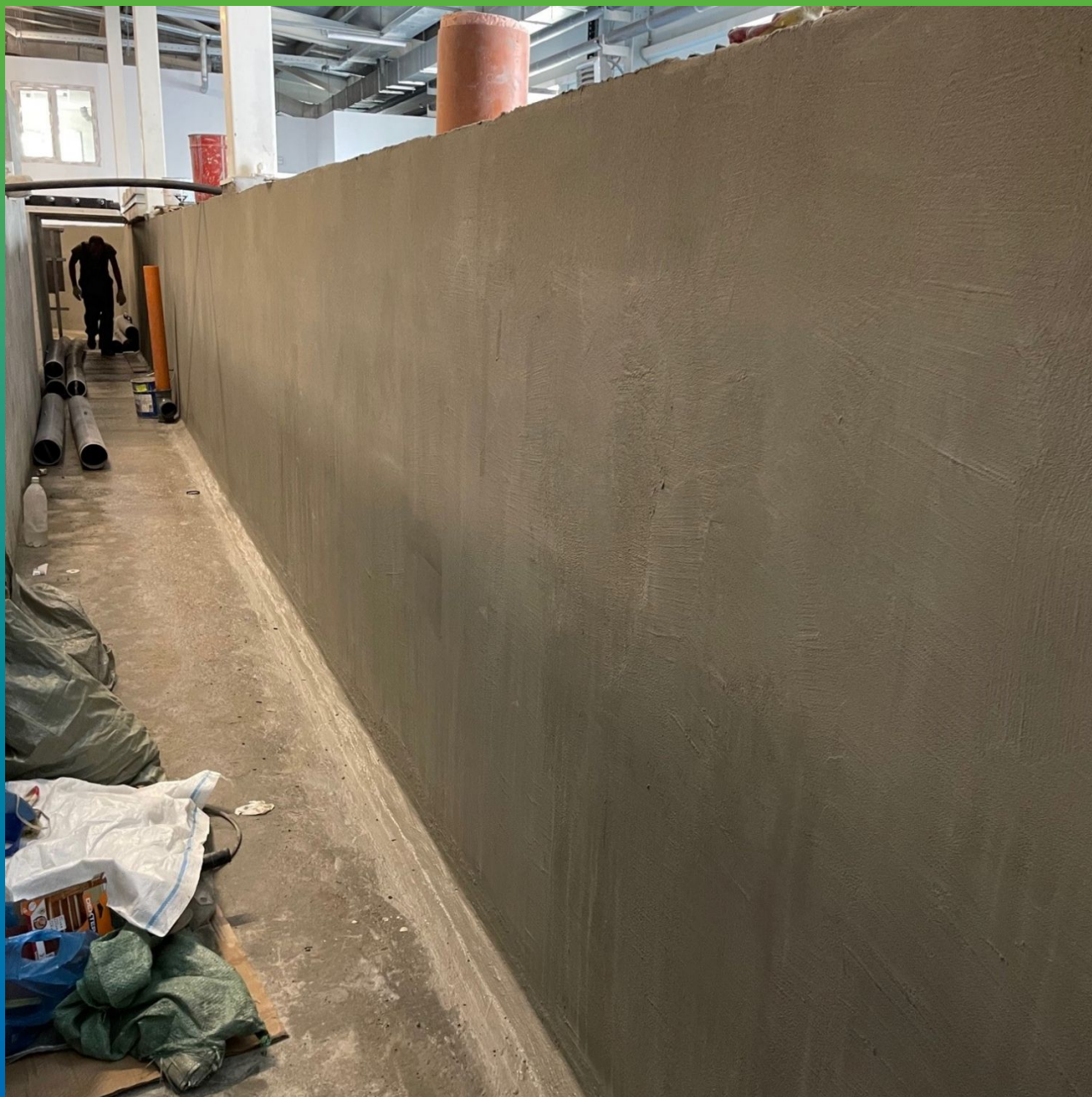
Стена водоема, обработанная Стармекс Сил флекс
