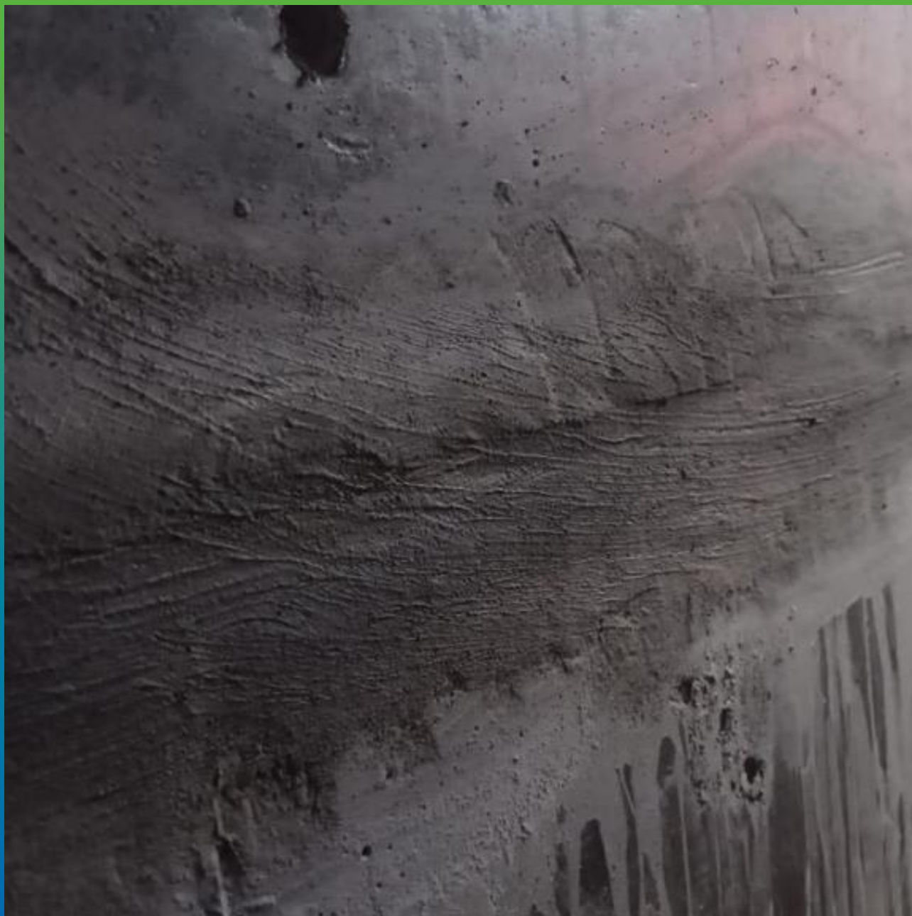
Зачеканенная штроба Составом Стармекс РМЗ
