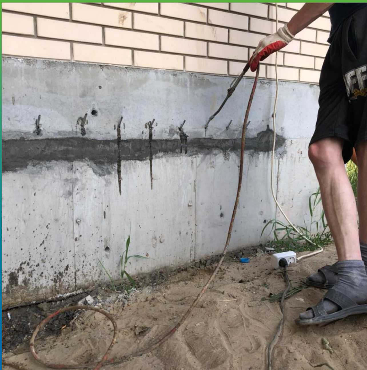
Заполнение пустот методом инъектирования эпоксидным составом Манопокс 352
