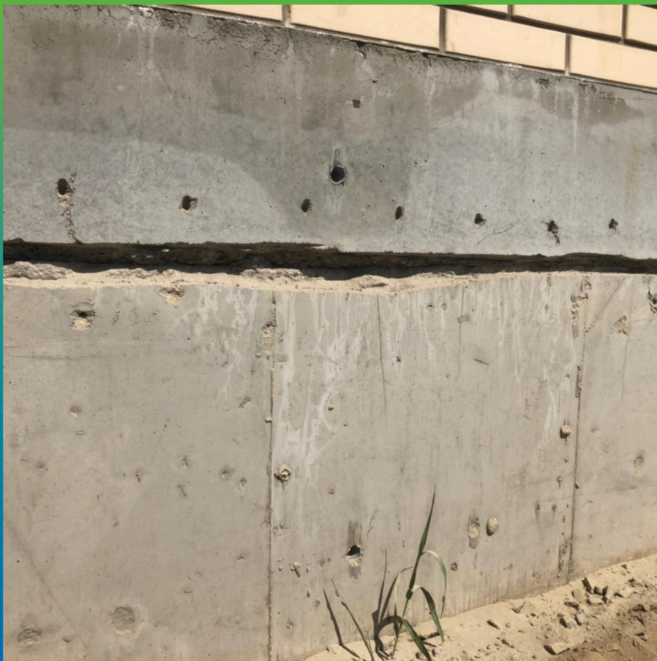
Подготовка штробы для зачеканки ремонтным составом Стармекс РМЗ
