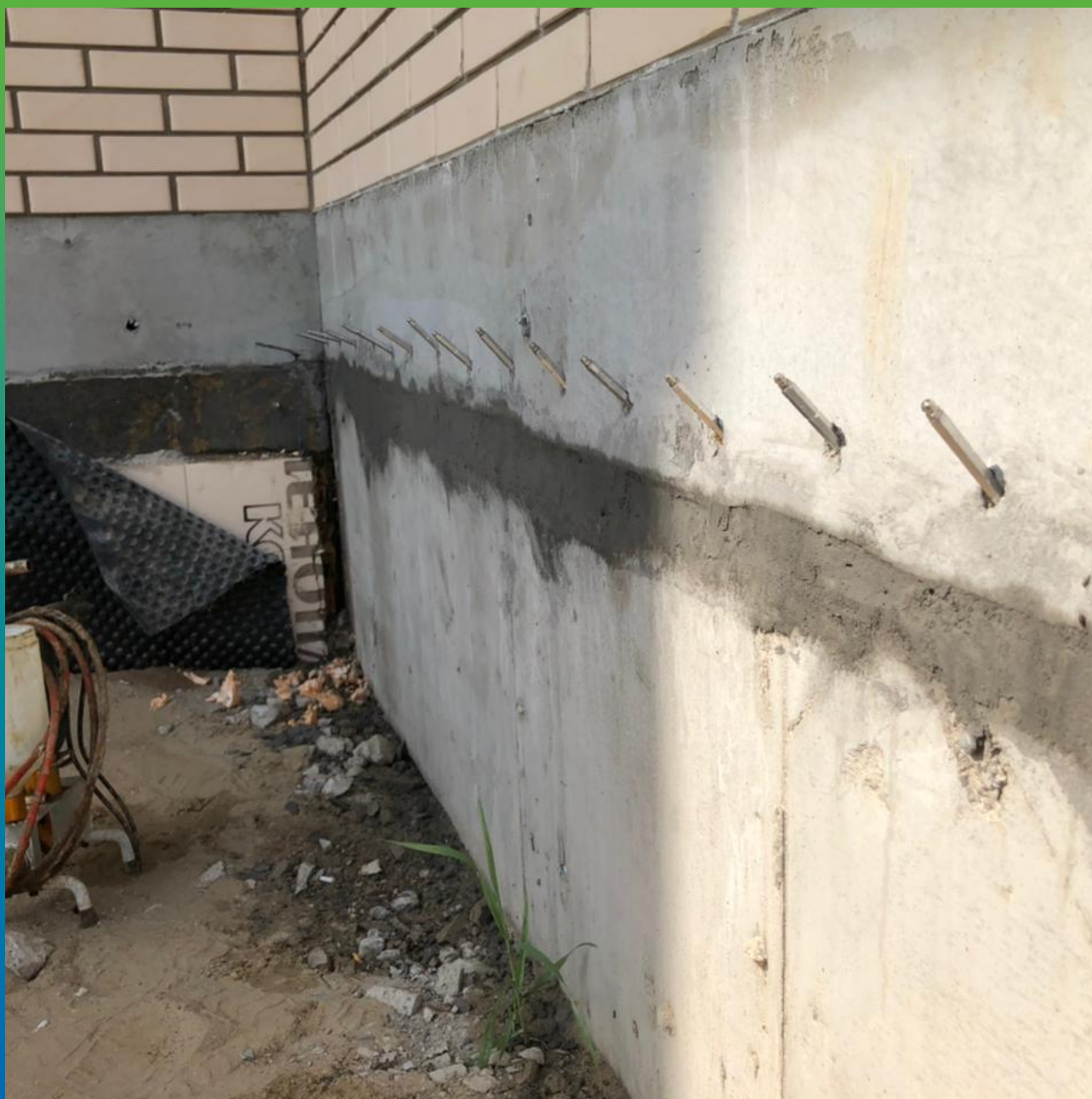
Установка пакеров для прокладки Манопокс 352
