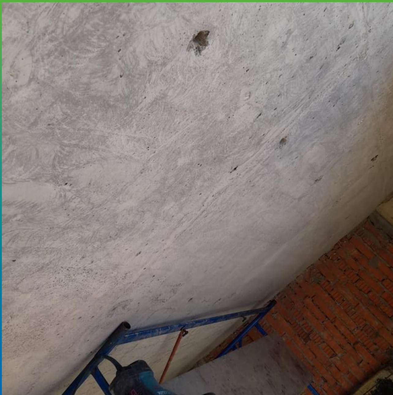
Подготовка основания под нанесение Стармекс Эласт
