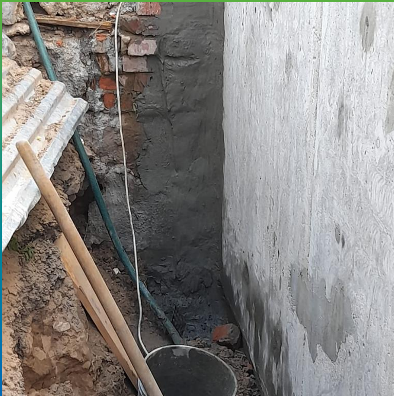
Подготовка основания под нанесение Стармекс Эласт
