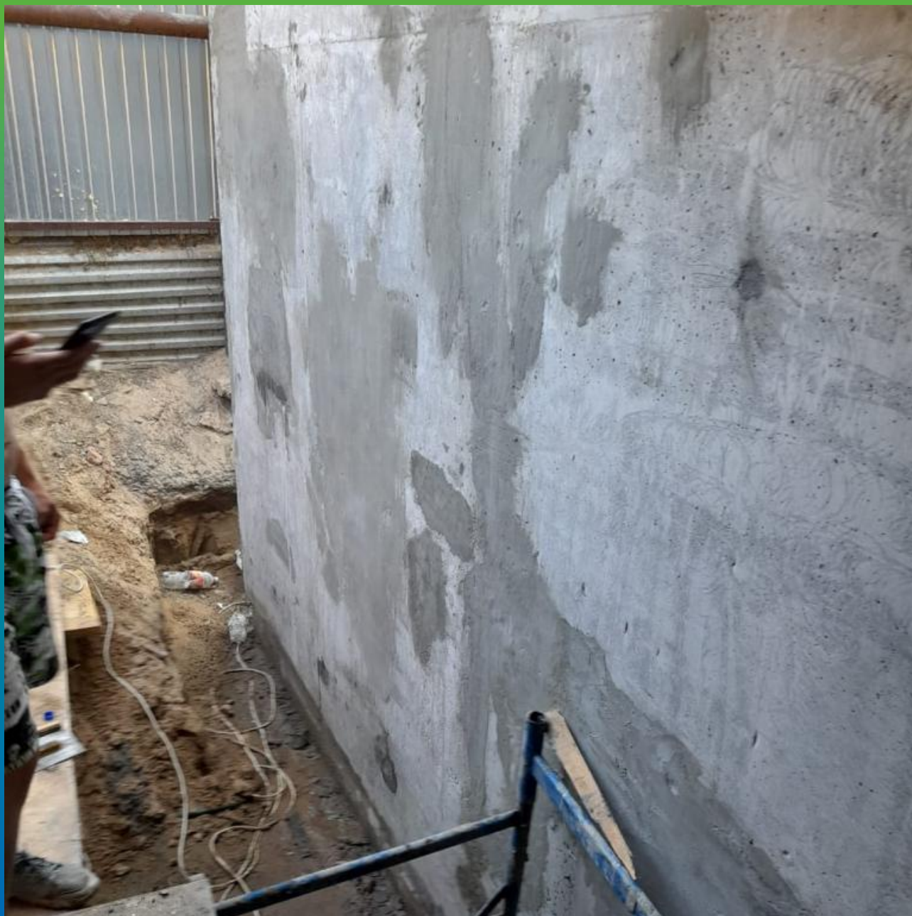
Подготовка основания под нанесение Стармекс Эласт
