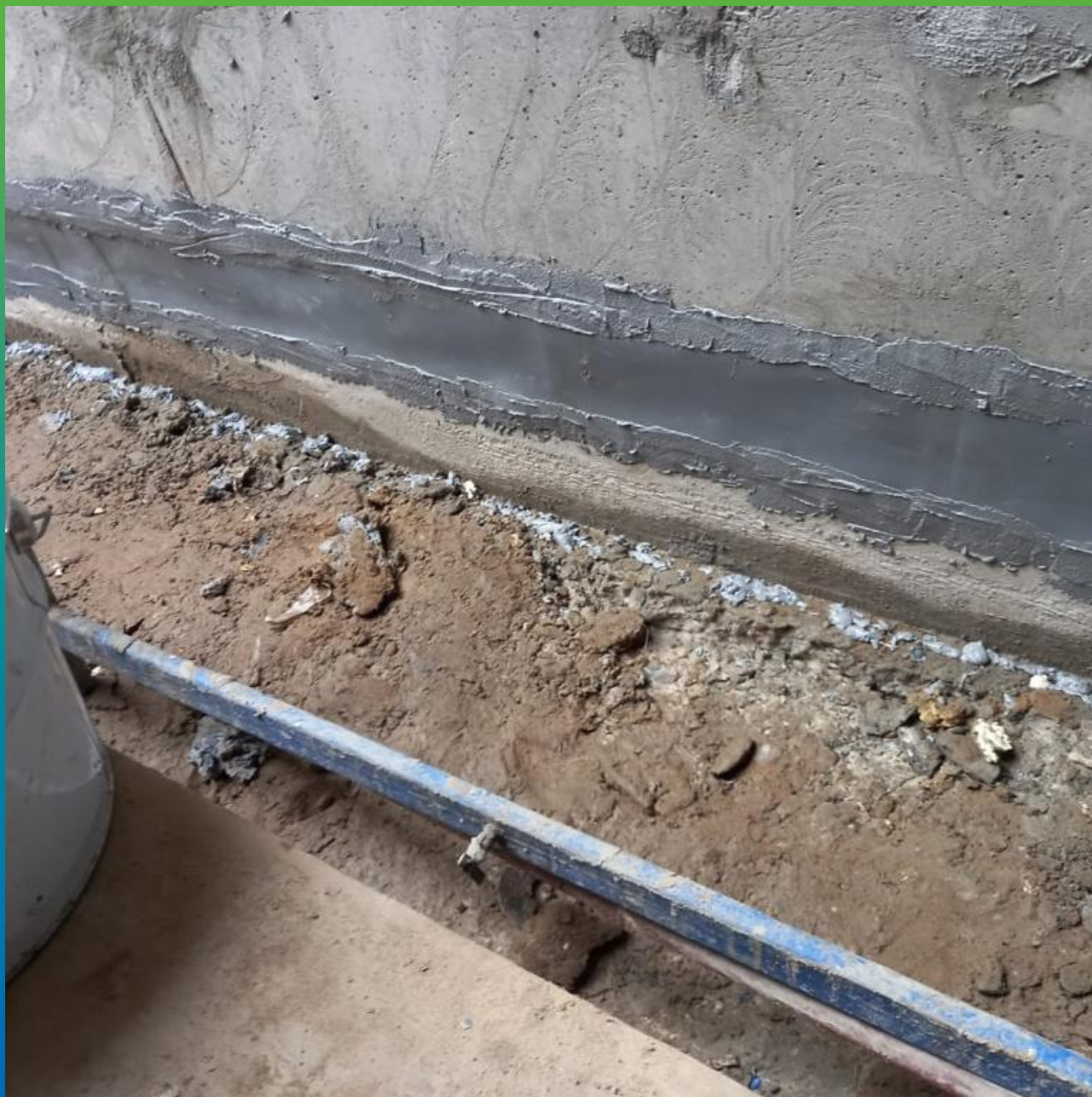
Проклеивание холодного шва лентой Манодил Про на клей Манопокс 331
