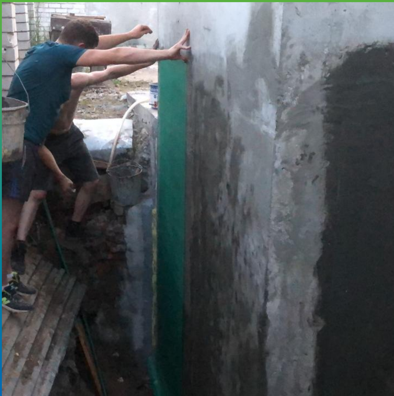
Нанесение второго слоя гидроизоляции по сетке.
