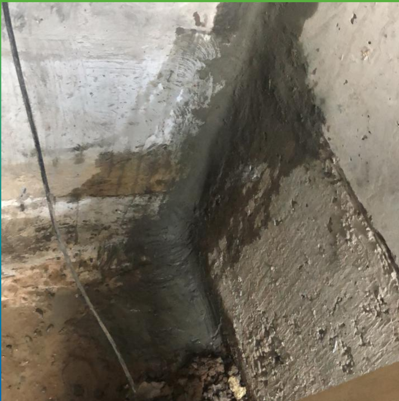
Устройство галтели из ремонтного состава Стармекс РМЗ
