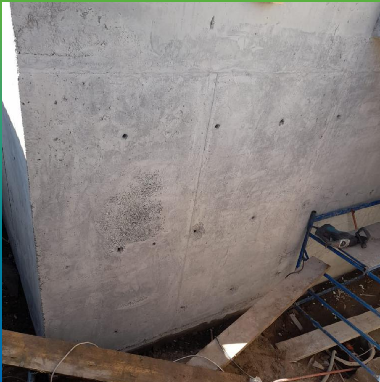
Подготовка основания под нанесение Стармекс Эласт
