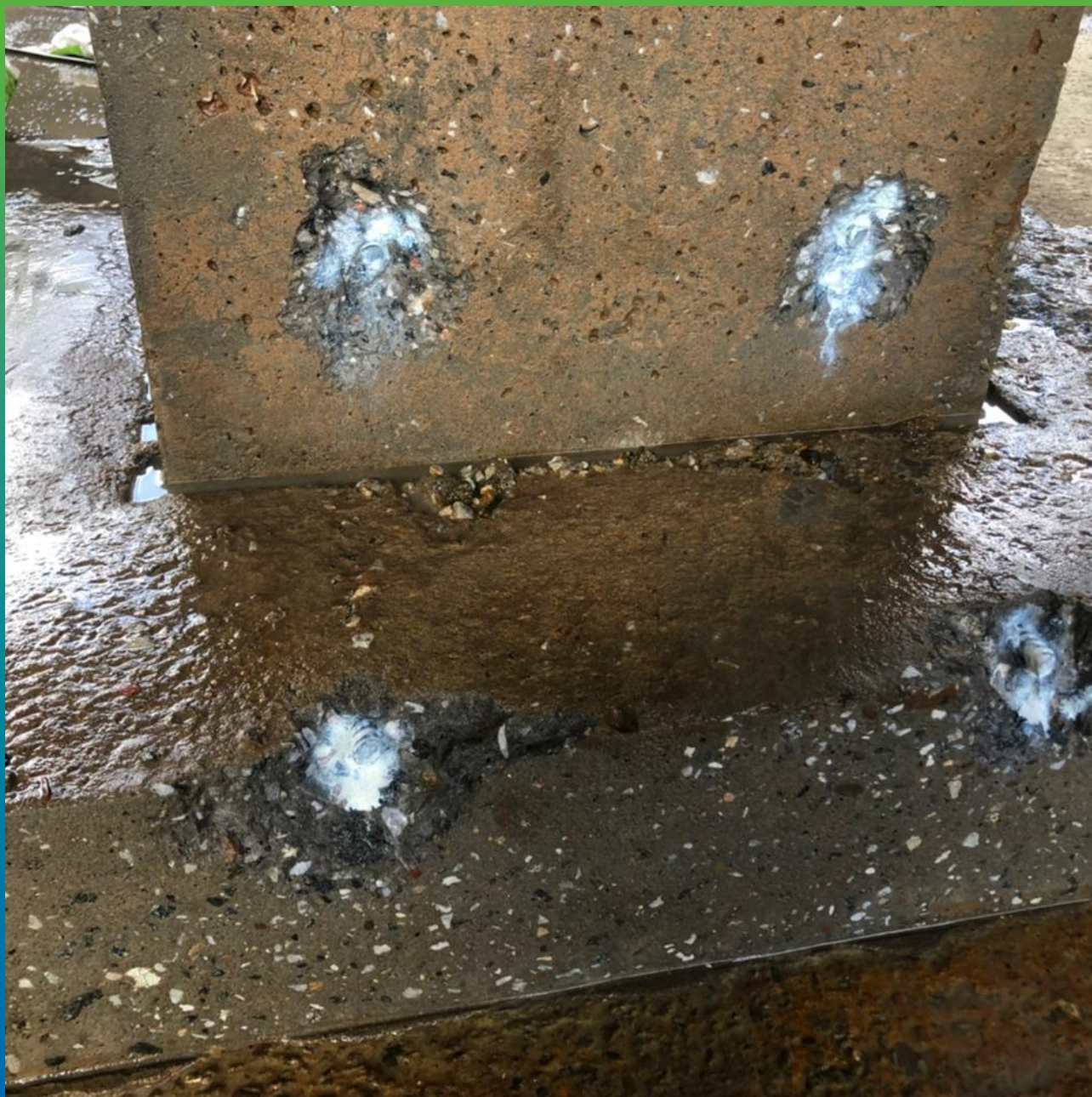
Нанесение защитного состава Маногард 133 Фер на арматуру
