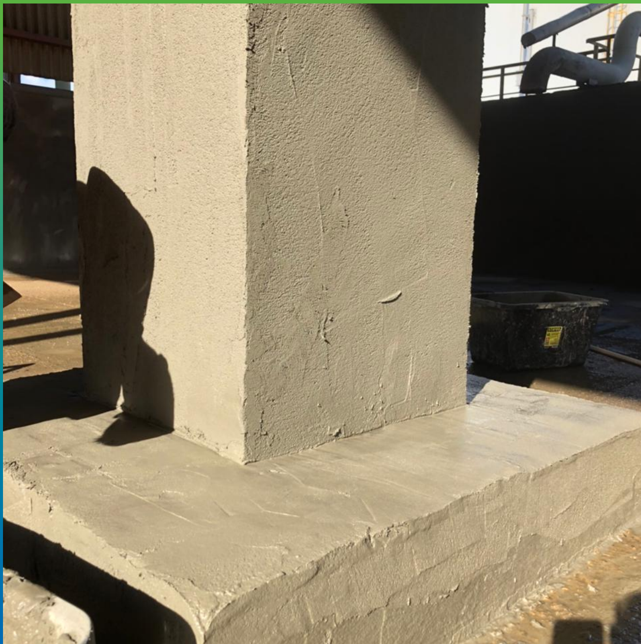
Отремонтированные железобетонные элементы
