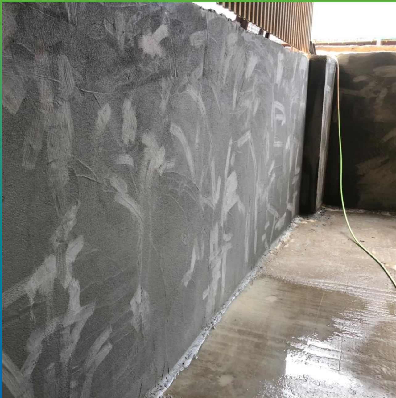
Нанесение ремонтного состава Стармекс РМ3
