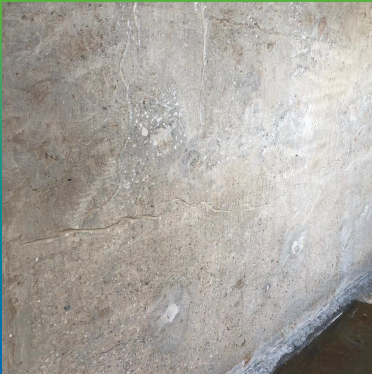
Подготовка основания к ремонту
