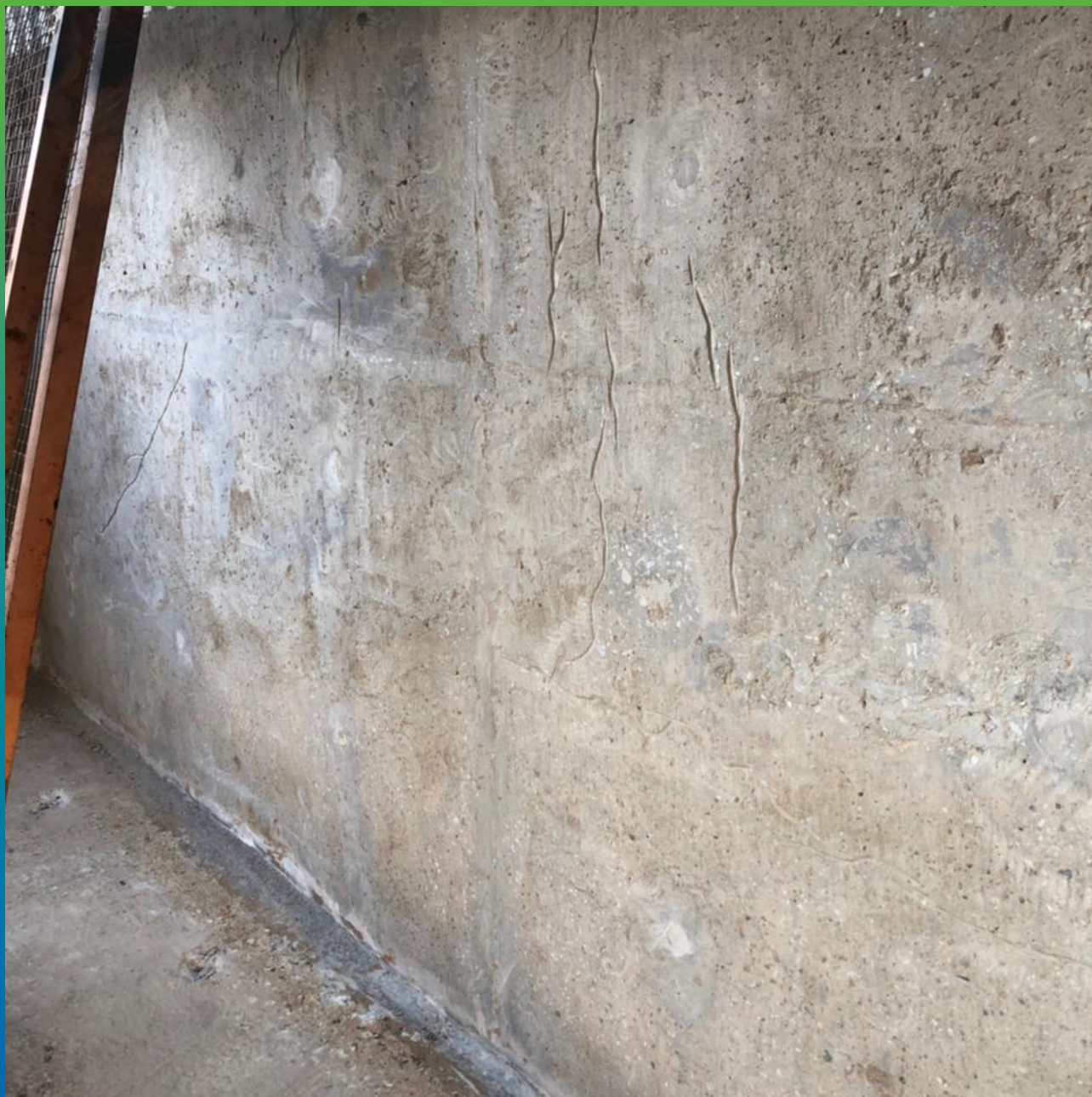
Подготовка основания к ремонту
