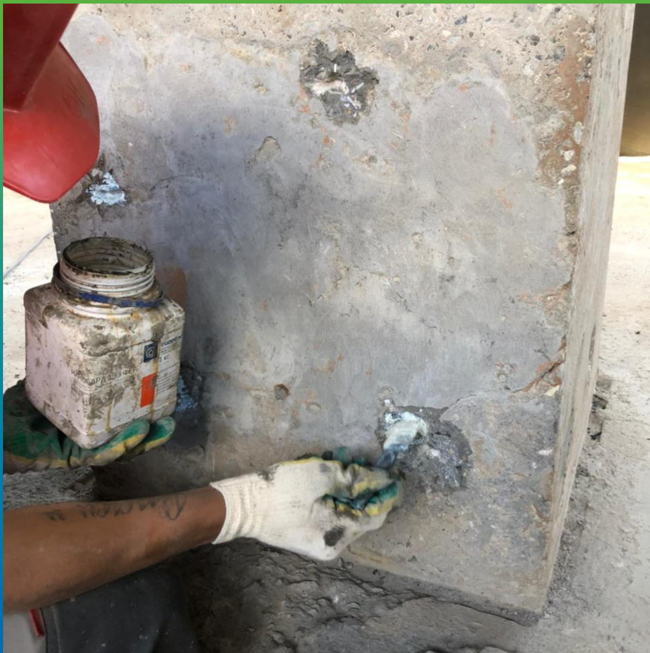
Нанесение защитного состава Маногард 133 Фер на арматуру
