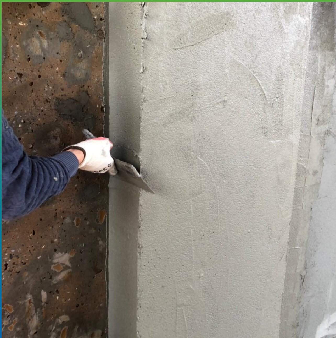
Нанесение ремонтного состава Стармекс РМЗ
