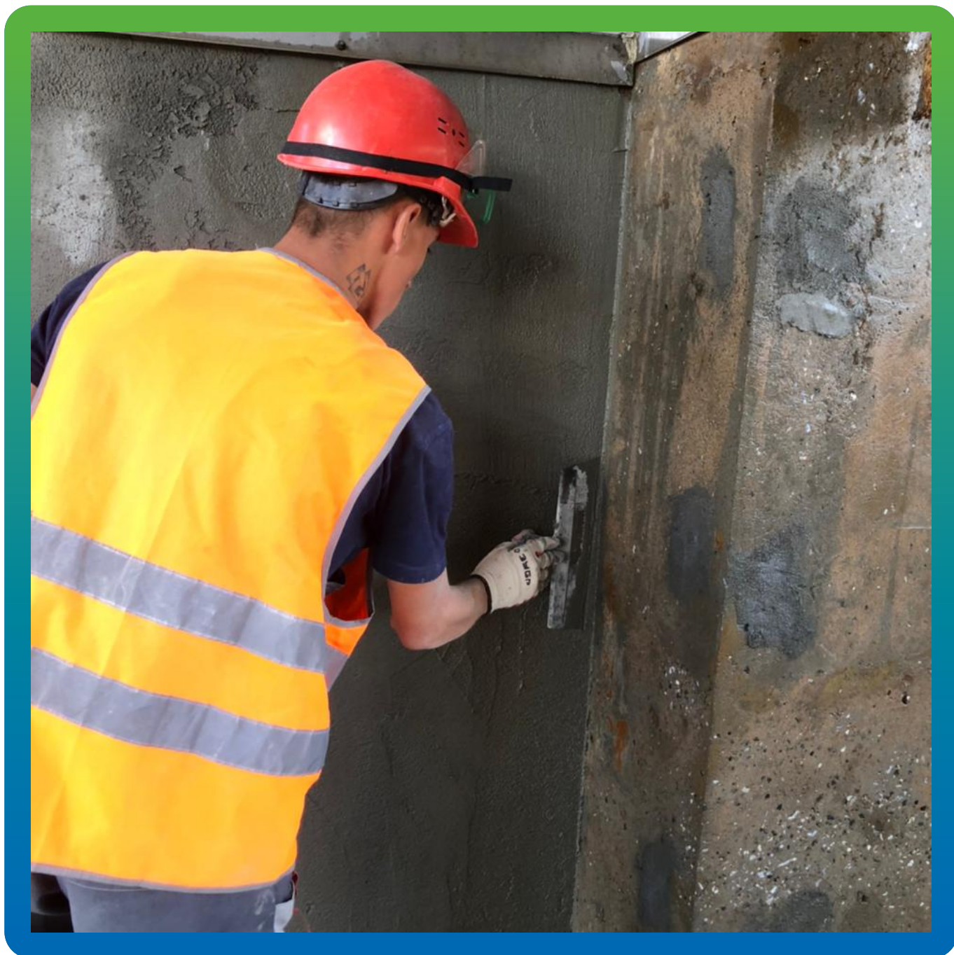
Нанесение ремонтного состава Стармекс РМЗ
