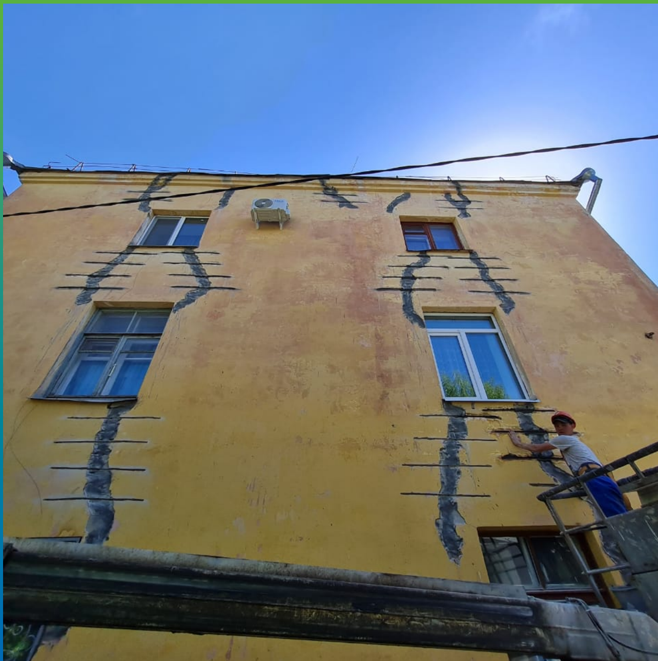
Восстановление фасада здания после ремонтных работ
