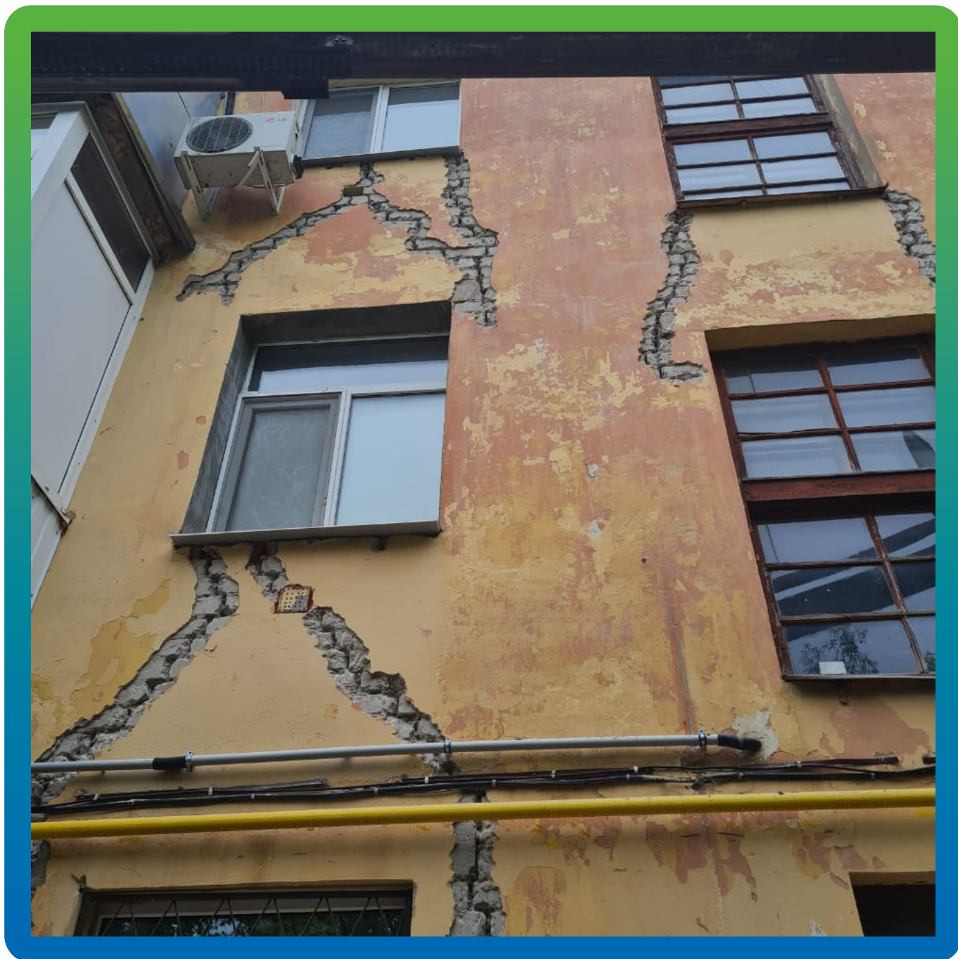
Установка пакеров для усиления кирпичной кладки
