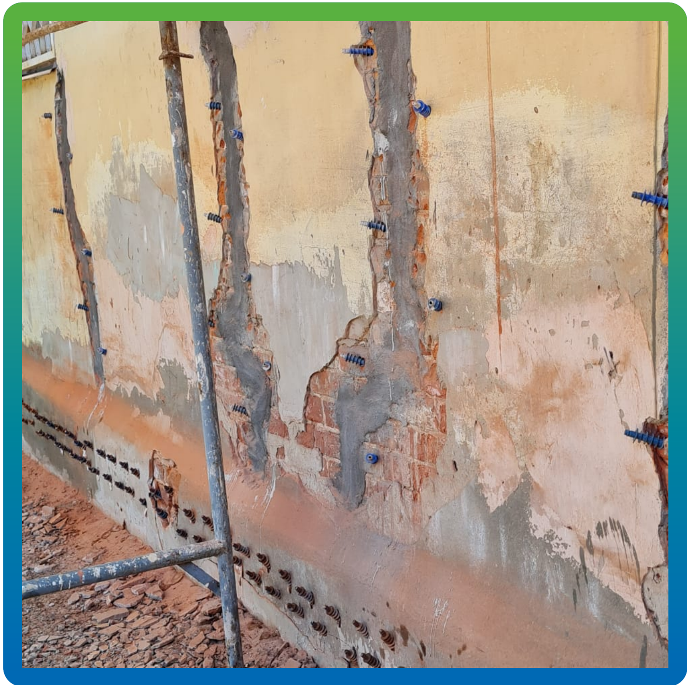
Установка пакеров для усиления кирпичной кладки
