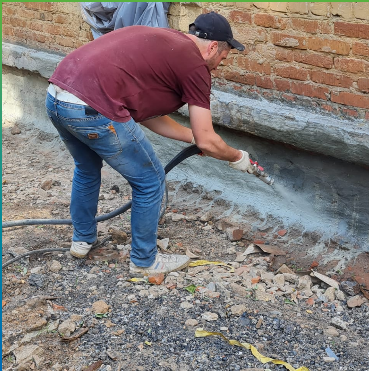
Нанесение гидроизоляционного состава Стармекс Сил
