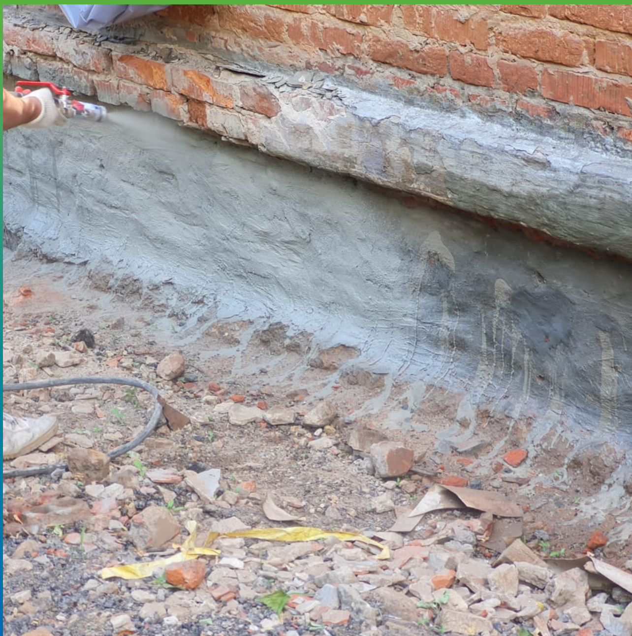
Нанесение гидроизоляционного состава Стармекс Сил
