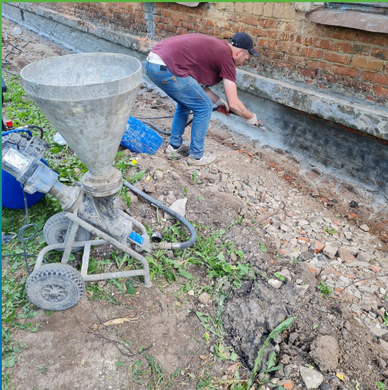
Нанесение гидроизоляционного состава Стармекс Сил
