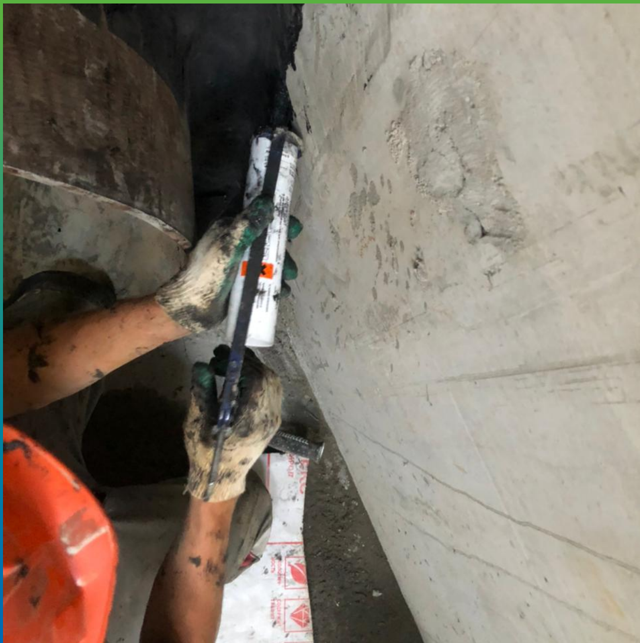
Герметизация краев мембраны герметиком Манодил Бонд Ф
