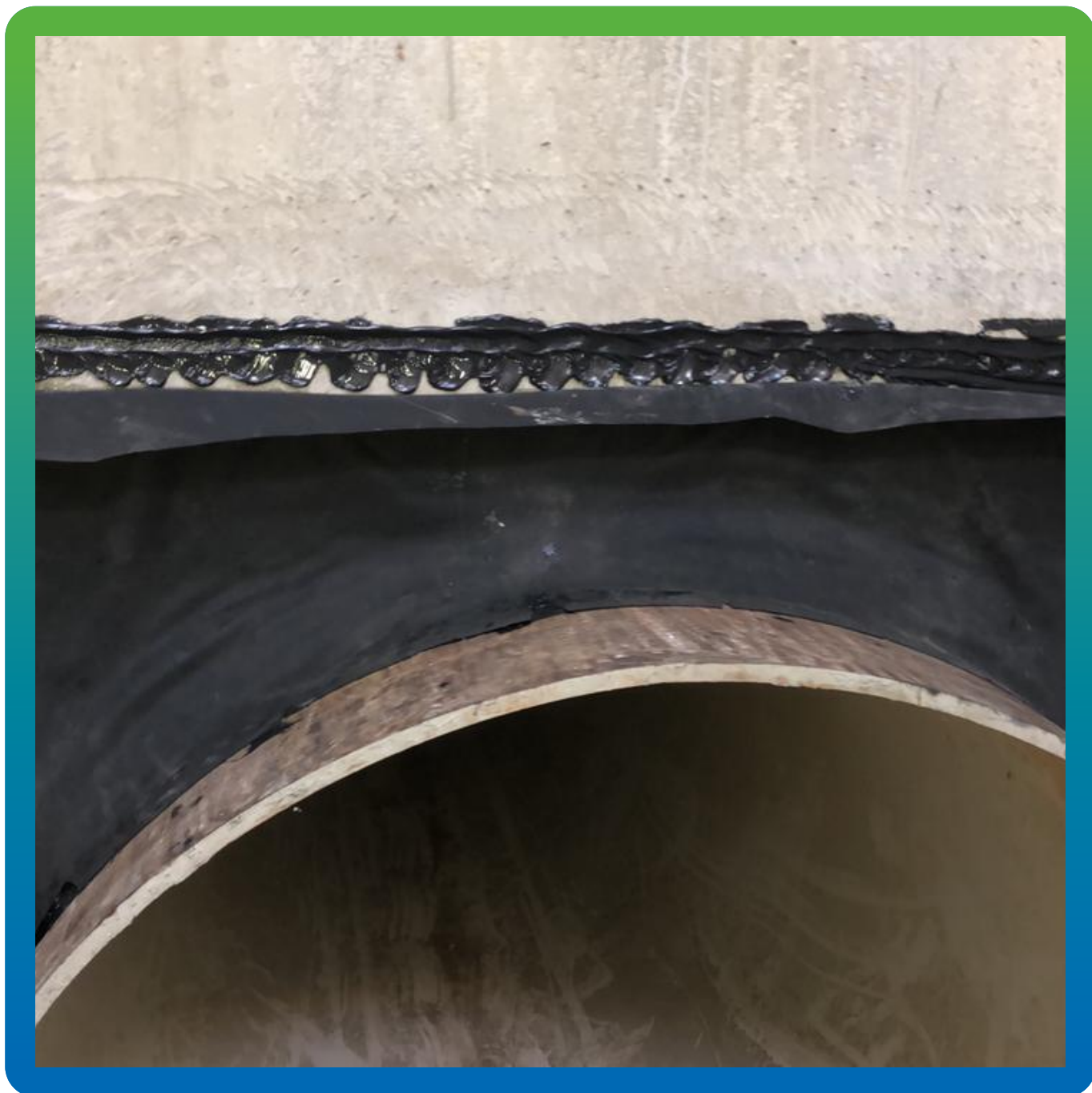
Герметизация краев мембраны герметиком Манодил Бонд Ф
