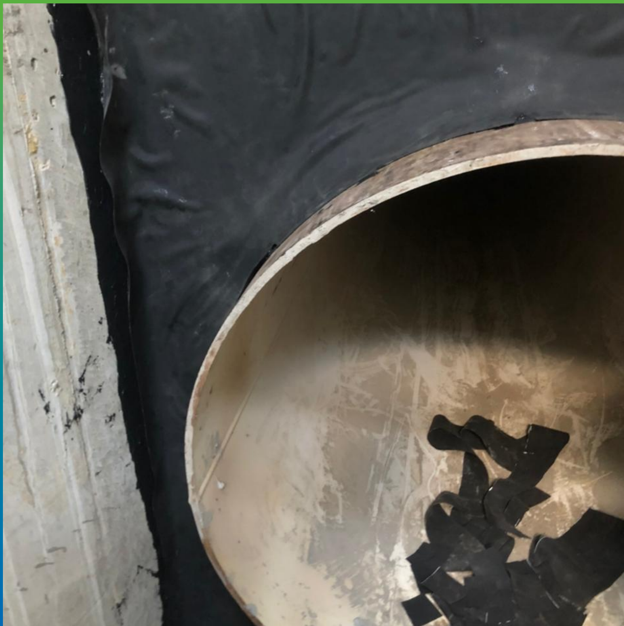
Герметизация краев мембраны герметиком Манодил Бонд Ф
