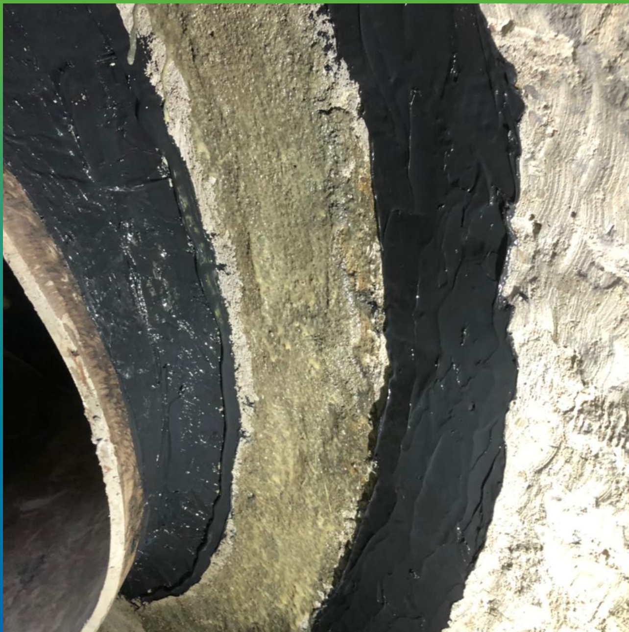
Нанесение герметика Манодил Бонд Ф
