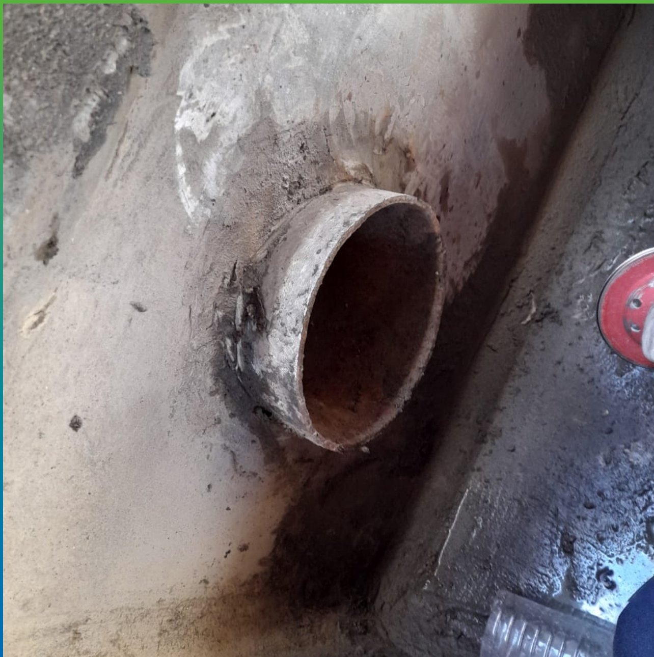
Ввода коммуникаций, подлежащие гидроизоляции
