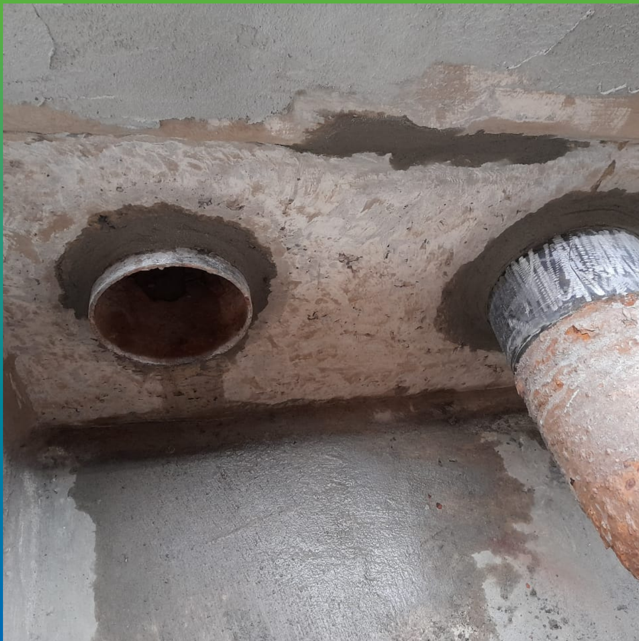
Ввода коммуникаций, подлежащие гидроизоляции
