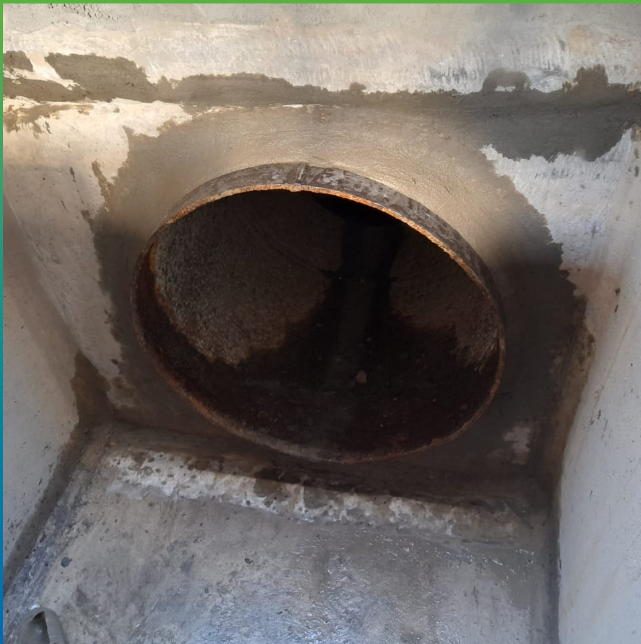
Ремонт стыка бетон/металл составом Стармекс РМЗ
