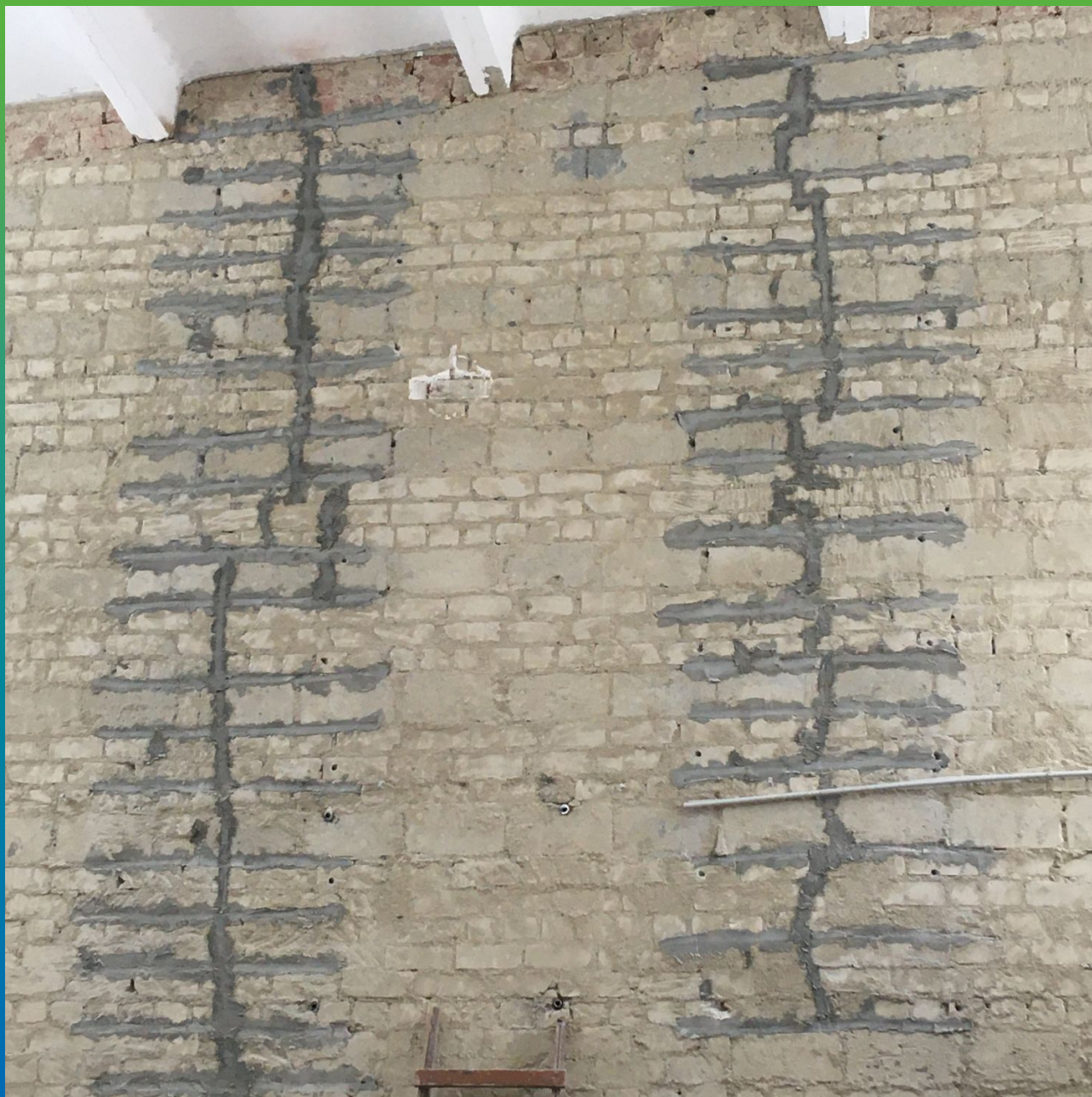
Зачеканенные стены с отверстиями для установки пакеров
