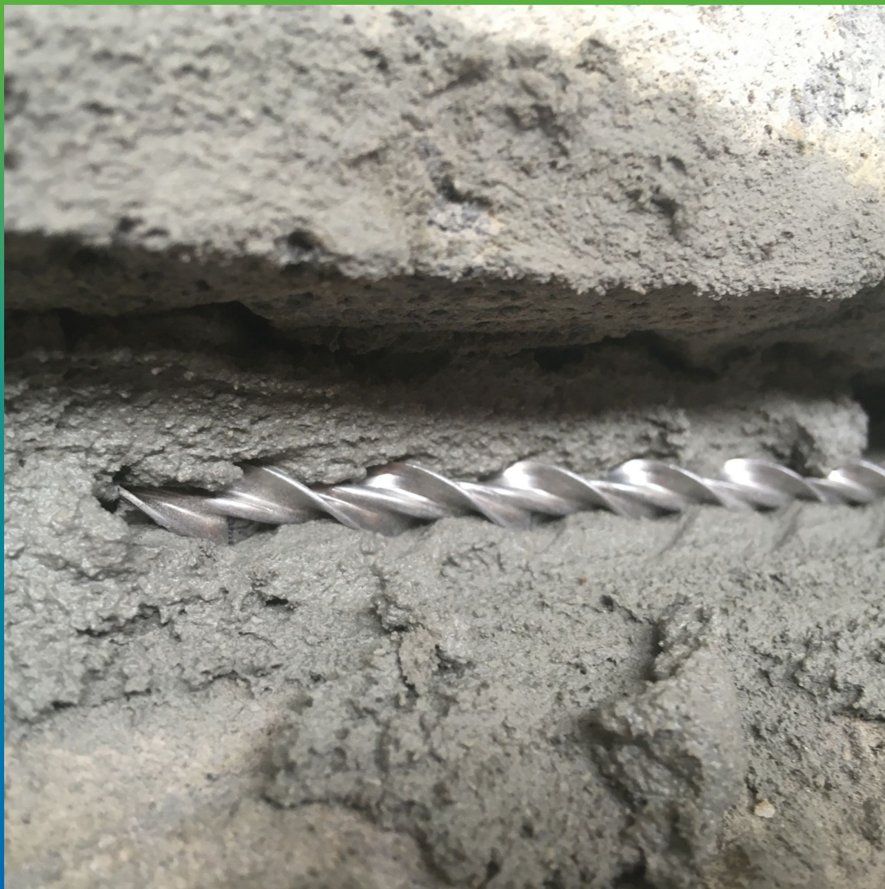
Установка анкерных стержней в шов с помощью Стармекс Арсул
