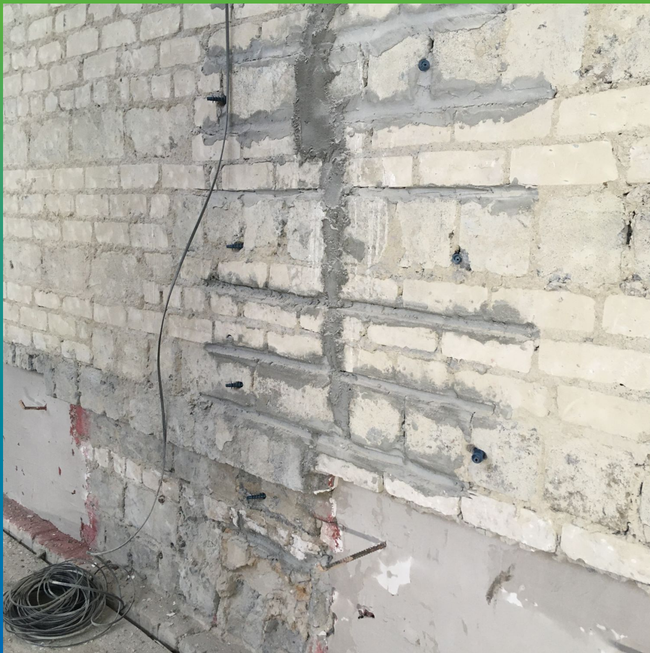
Трещина с установленными спиральными анкерами БМ 2861 готовая к инъектированию
