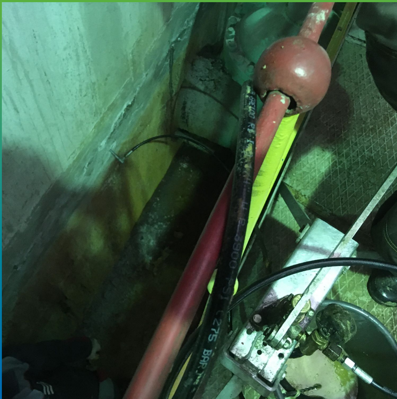
Процесс инъецирования Манопурс С в шов с активной протечкой
