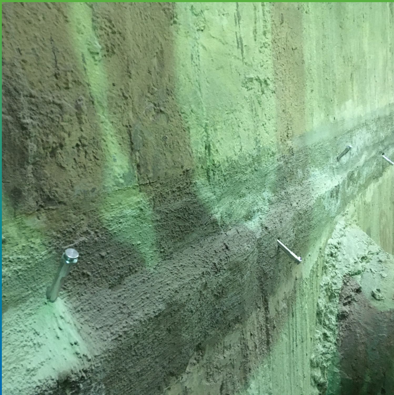
Пакера установленный в шахматном порядке с двух сторон от шва между блоками ФБС
