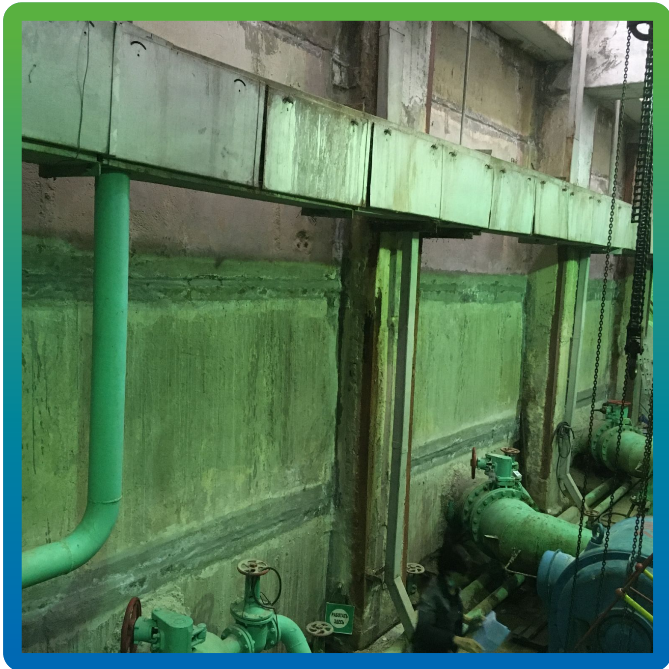
Общий вид после работ
