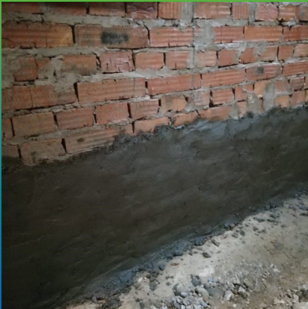
Стармекс РМЗ, нанесенный на кирпичную стену
