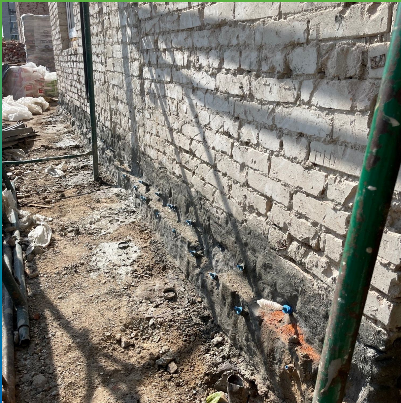
Стена, прокаченная составами Маноцем Фил и Маноксан 150
