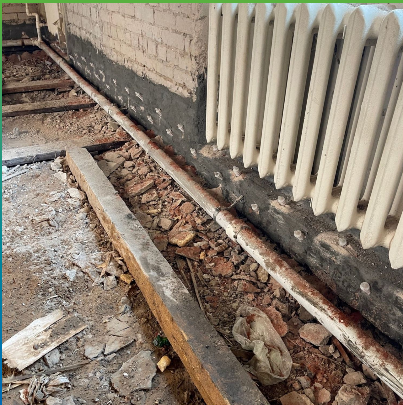
Пакеры, монтированные в стену
