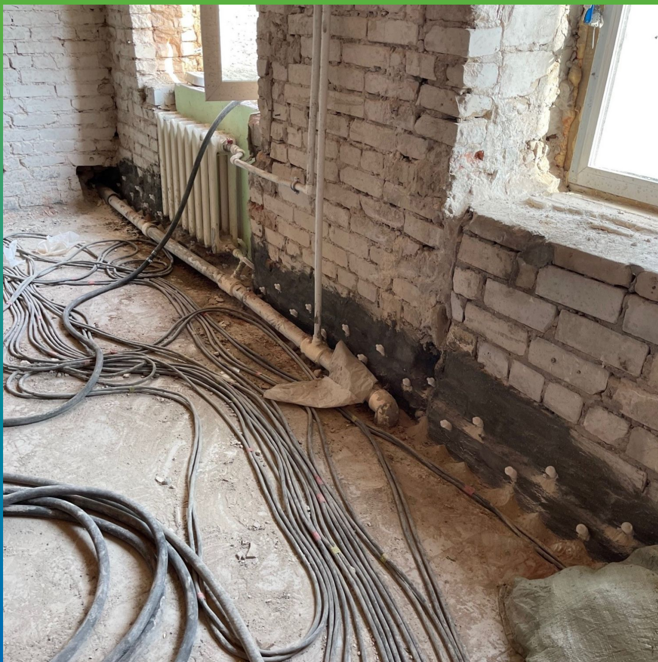
Пакеры, монтированные в стену
