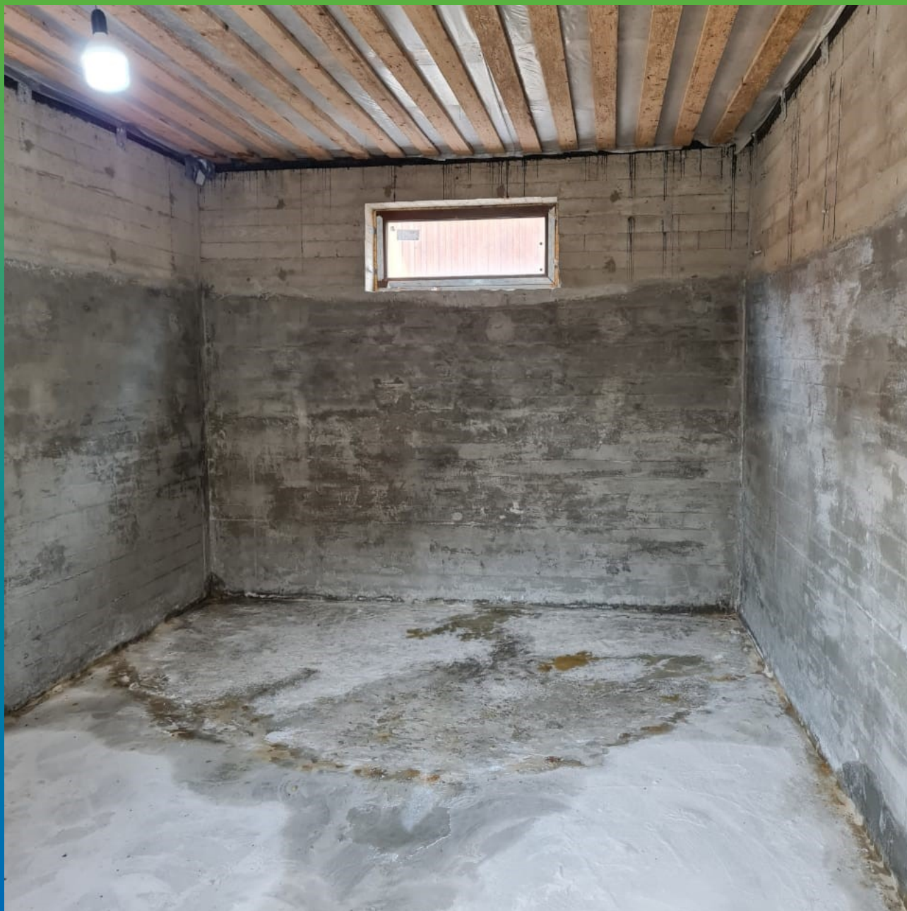
Основание комнат Тех подполья до укладки ЭПДМ
