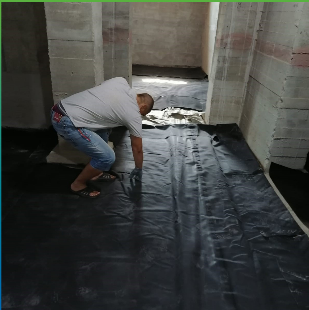
Укладка ЭПДМ Тех подполья
