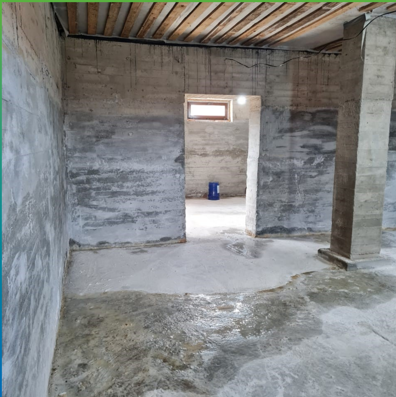
Основание комнат Тех подполья до укладки ЭПДМ
