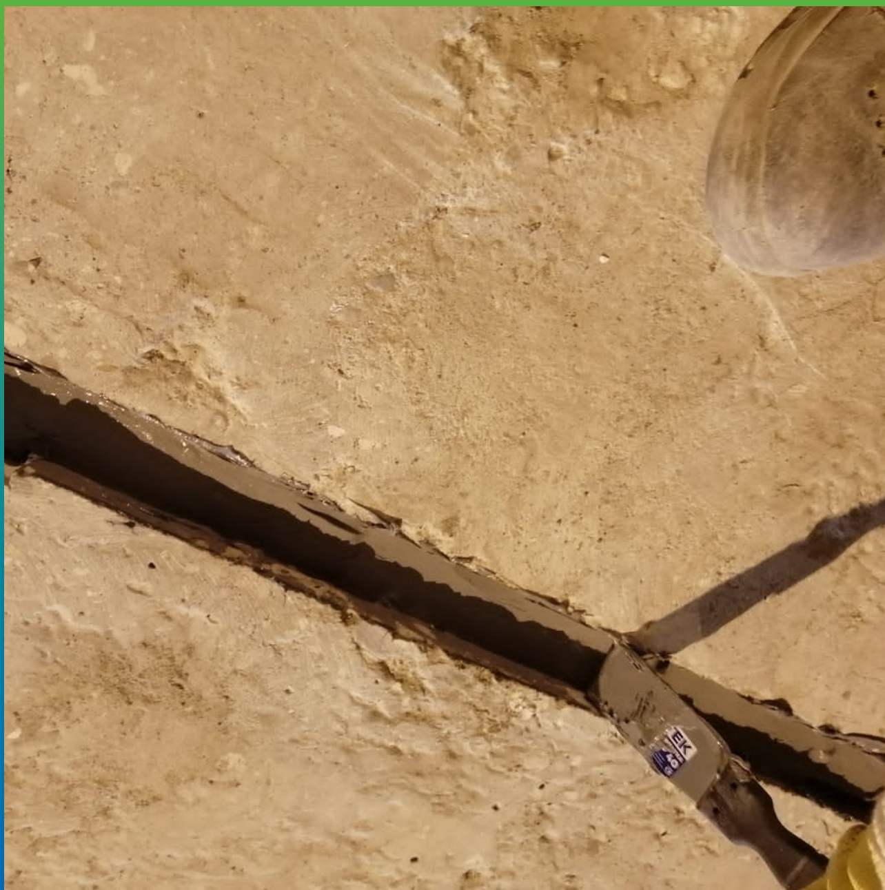
Укладка герметика в деформационный шов
