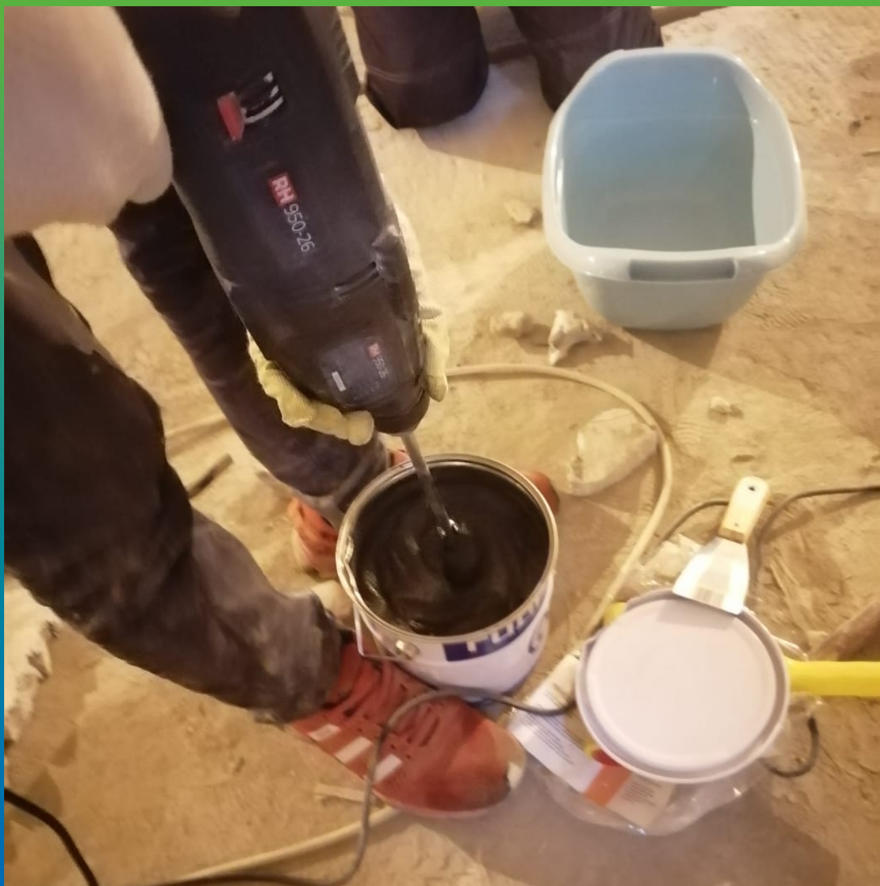
Приготовление герметика Манодил ПС 190
