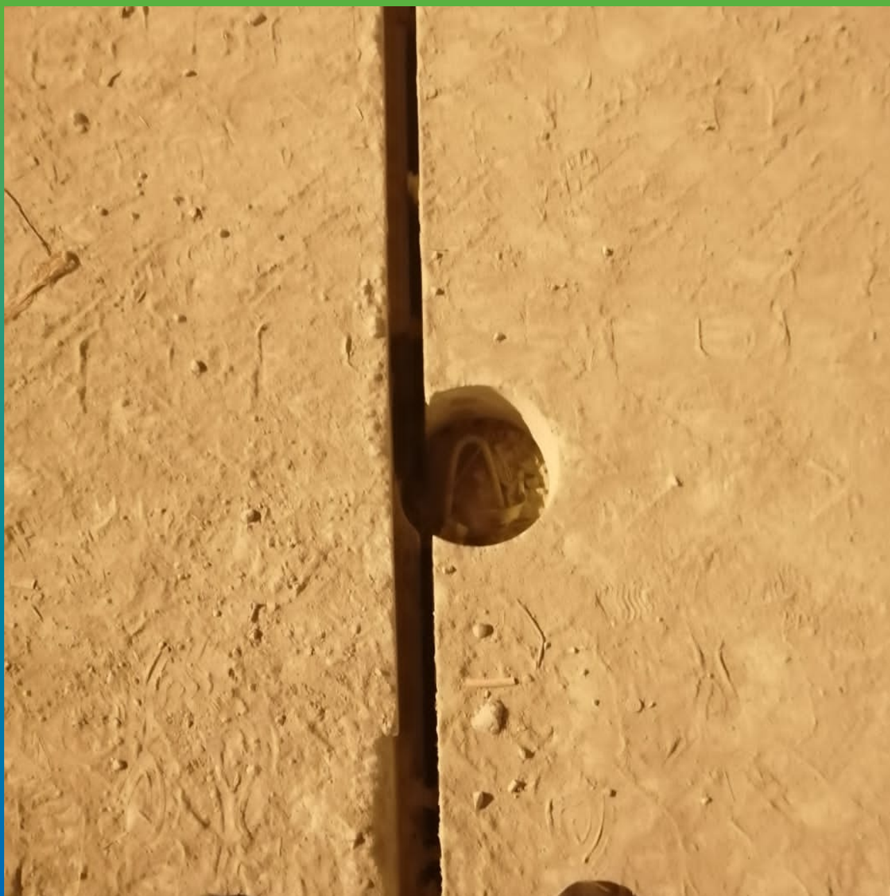
Основание под нанесение гидроизоляционных материалов.
