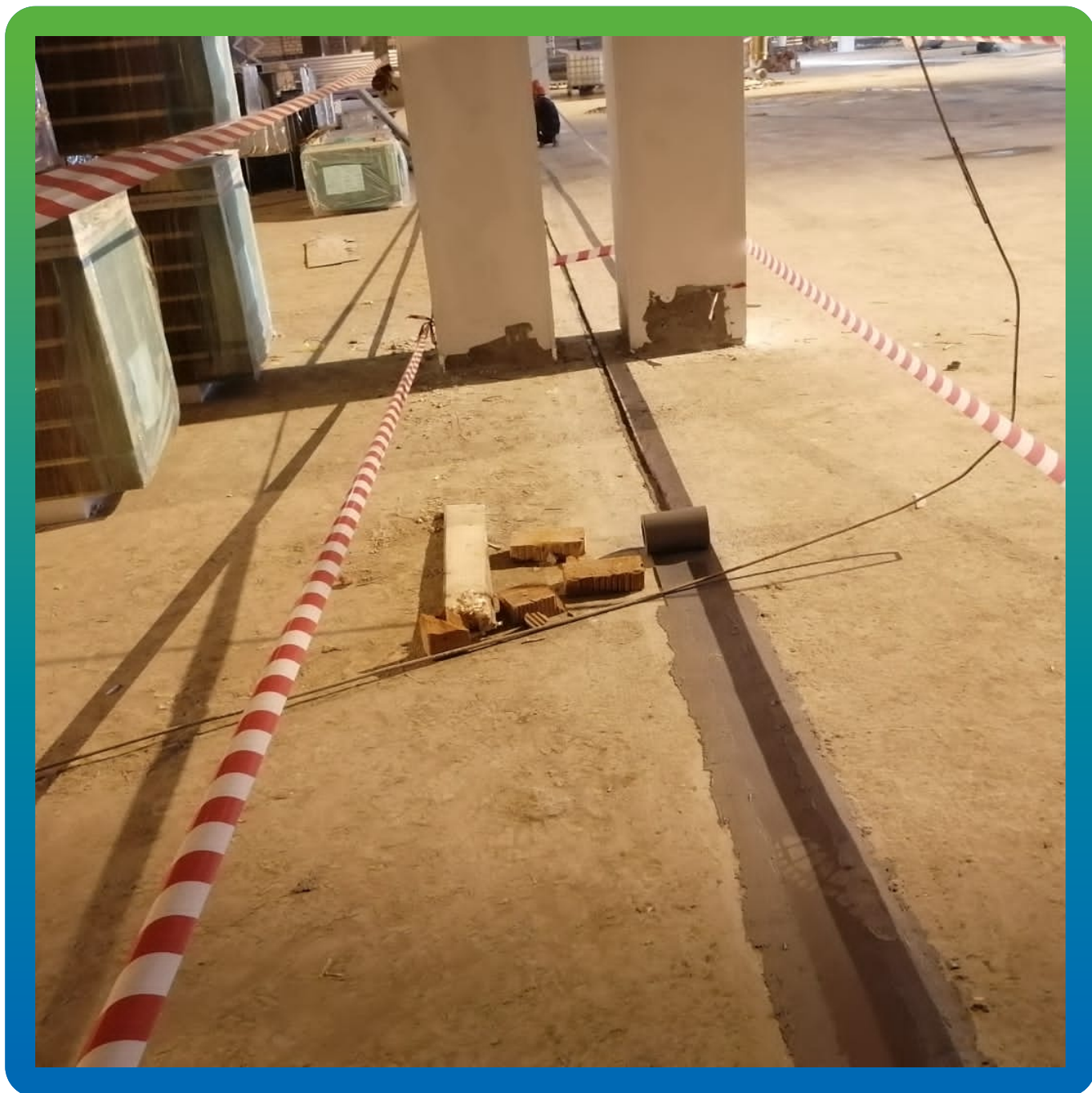
Монтаж системы Манопокс 331 + Манодил Про
