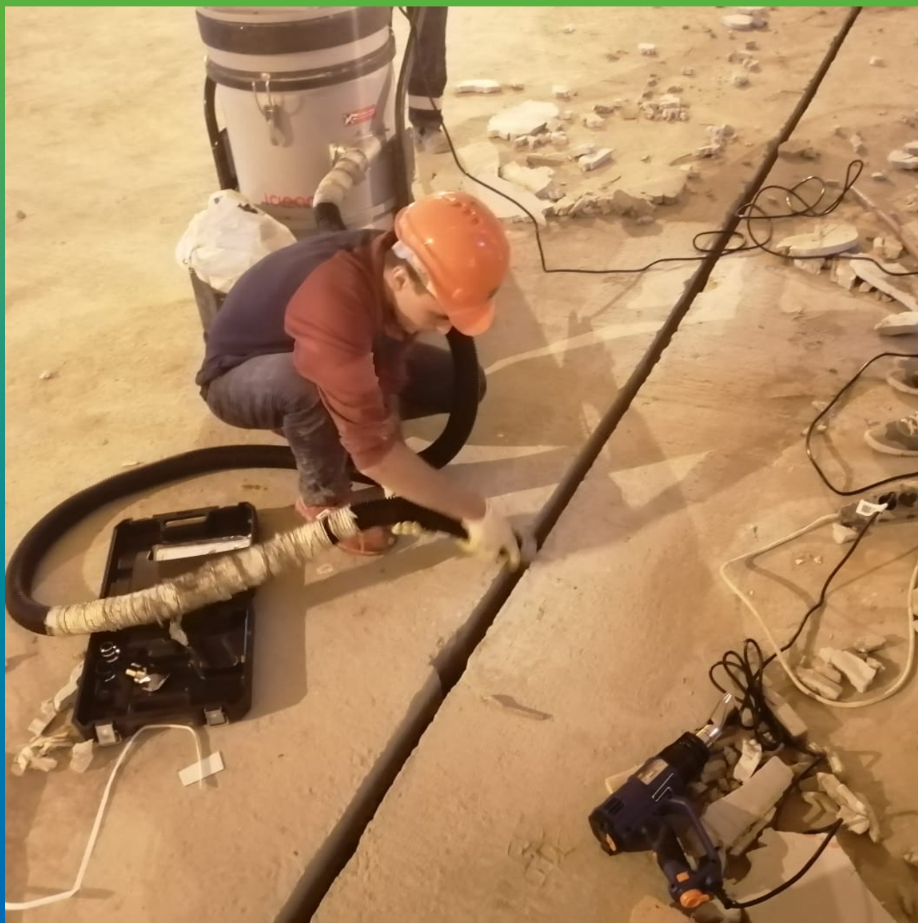
Обеспыливание основания
