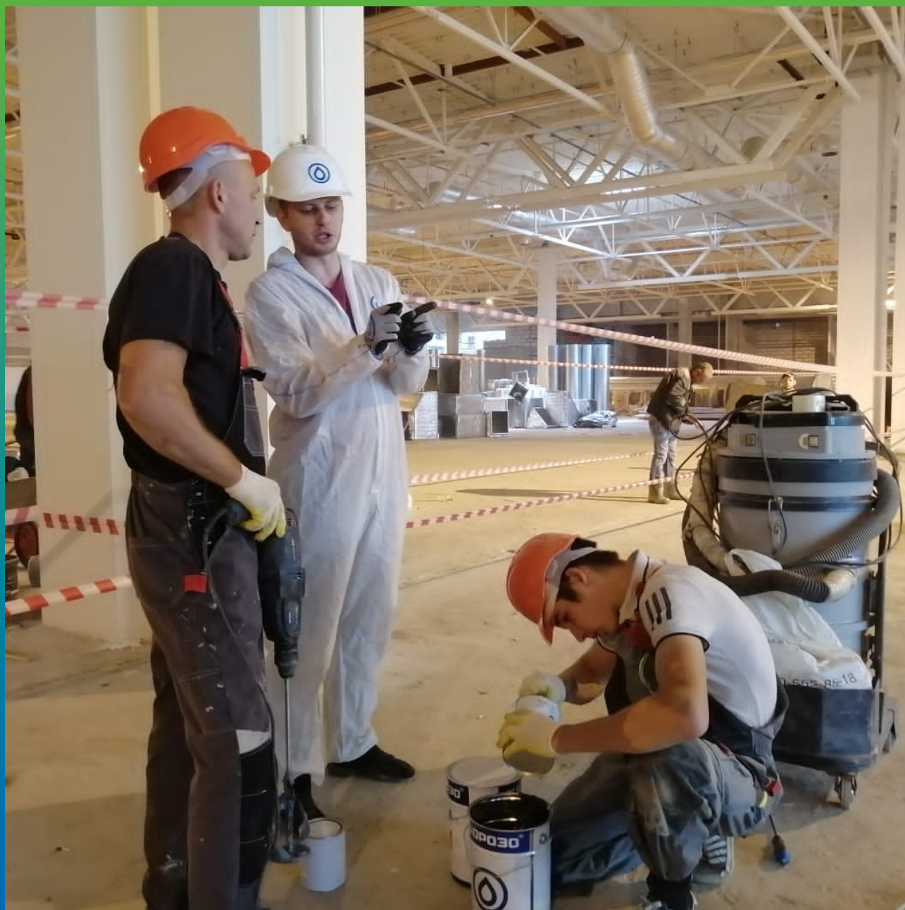
Техническое сопровождение работ на объекте
