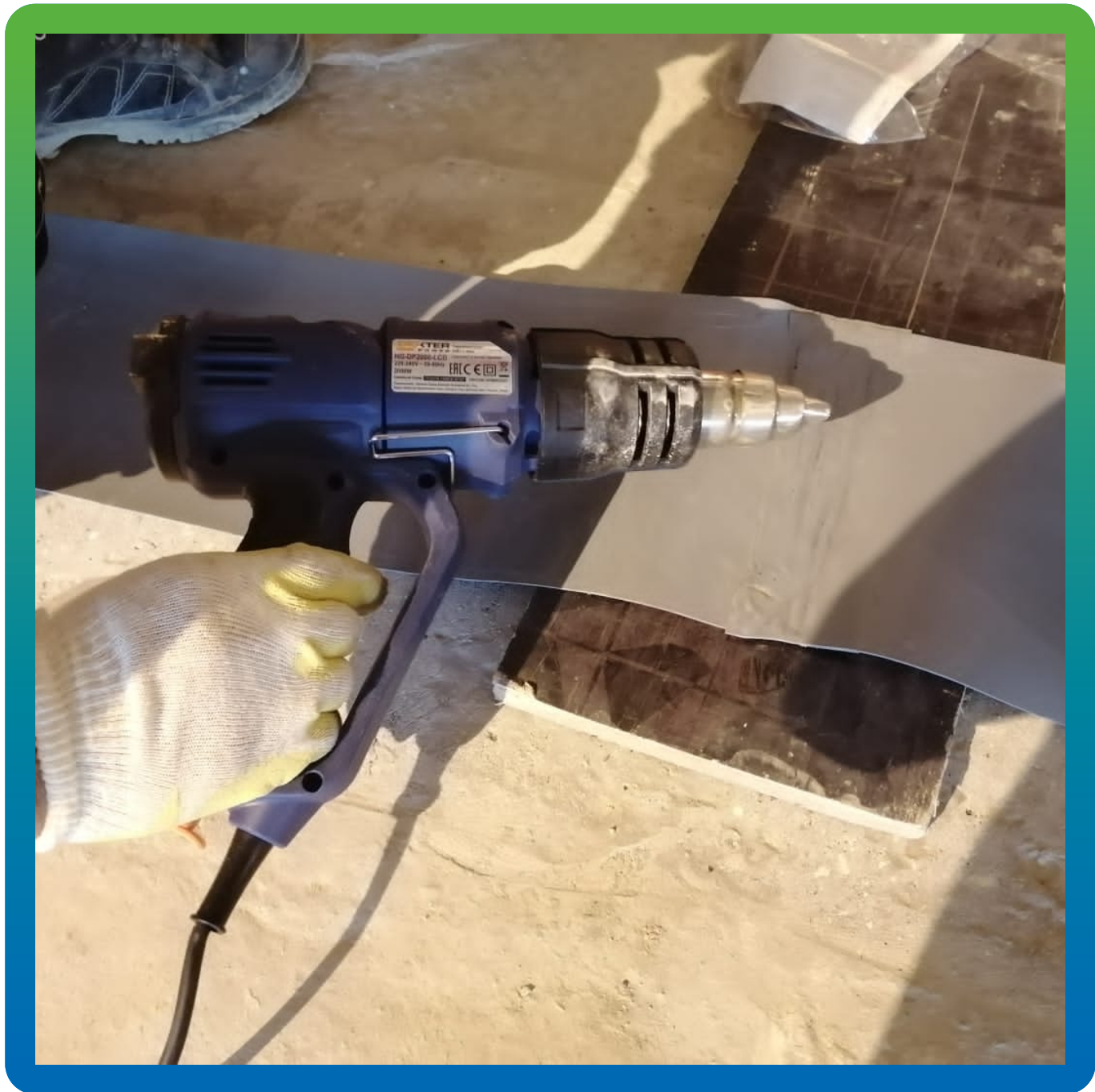
Стыковка краев ленты Манодил Про между собой
