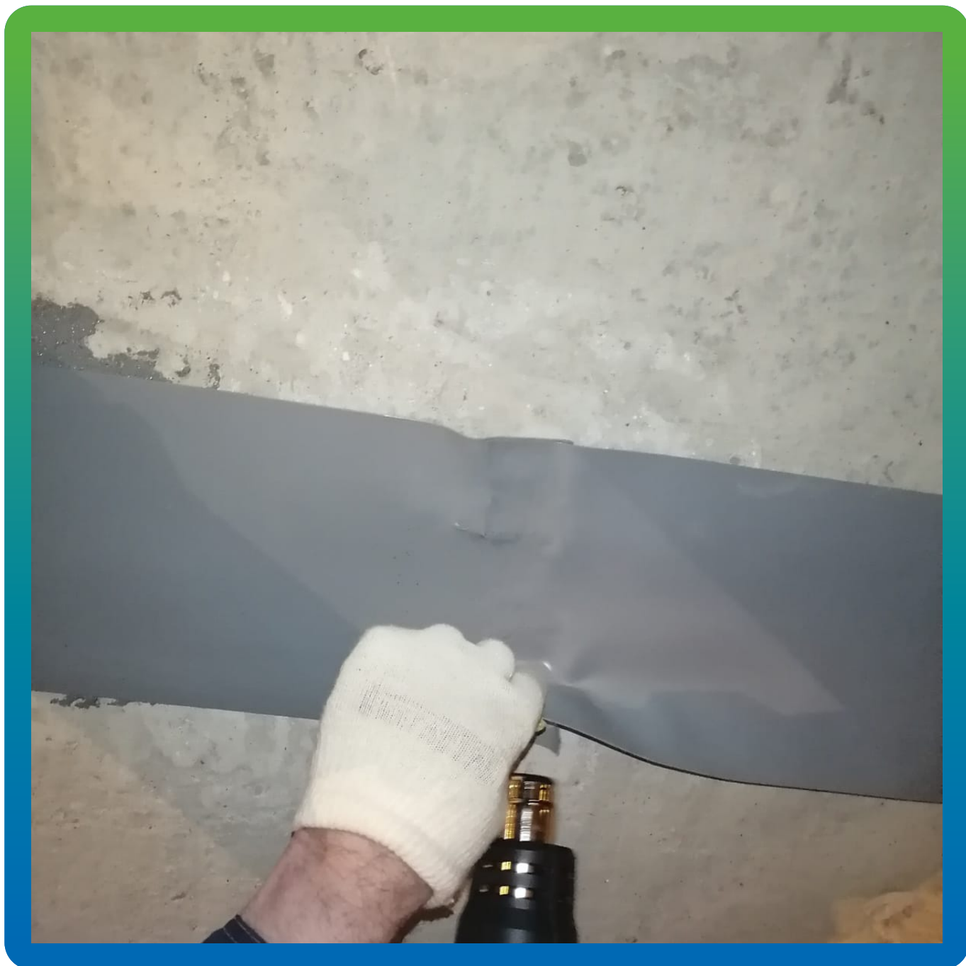
Стыковка краев ленты Манодил Про между собой
