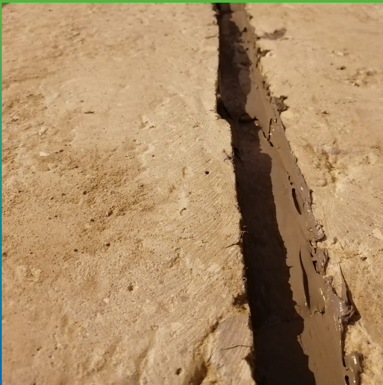
Укладка герметика в деформационный шов
