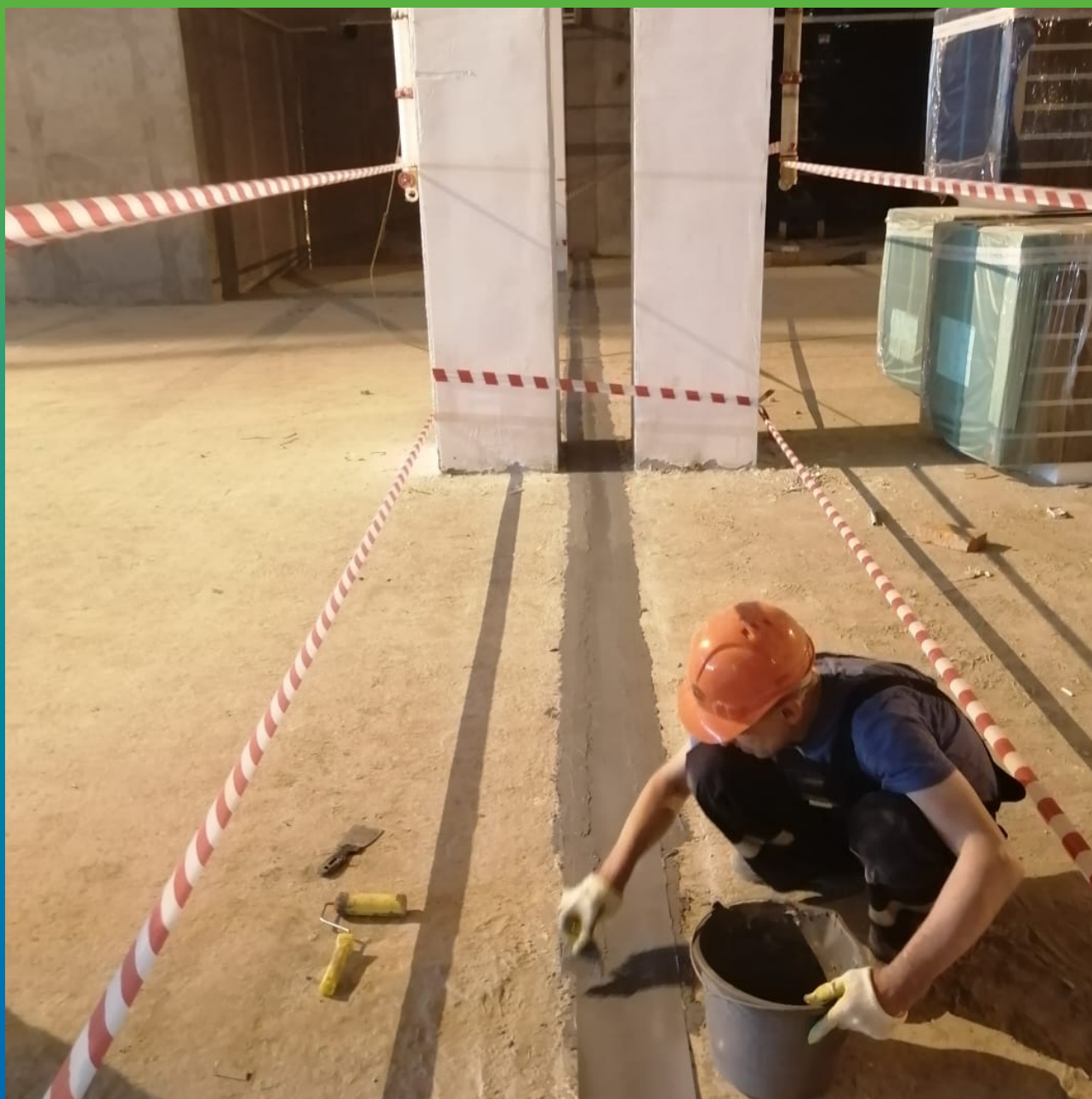
Монтаж системы Манопокс 331 + Манодил Про
