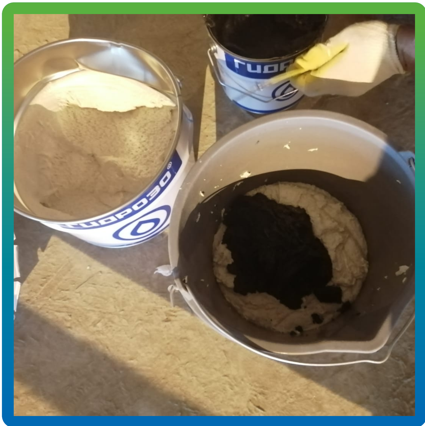
Приготовление эпоксидного клея Манопокс 331 для устройства системы Манодил Про
