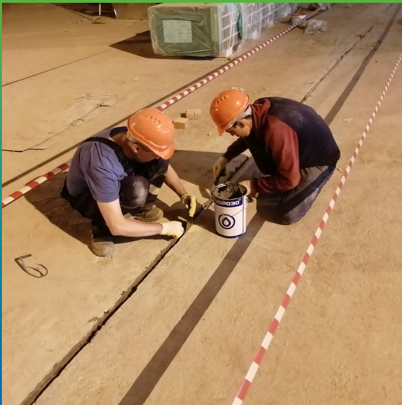
Укладка герметика в деформационный шов
