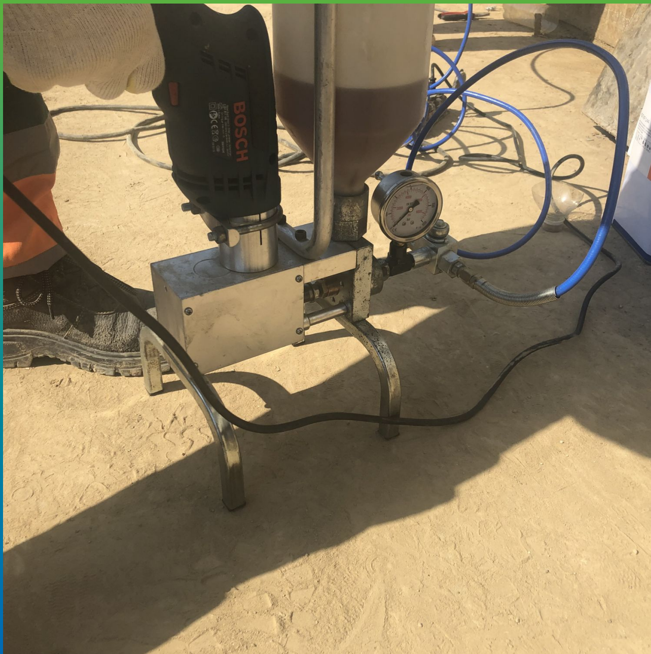
Процесс нагнетания состава Манопур 144 при помощи инъекционного насоса
