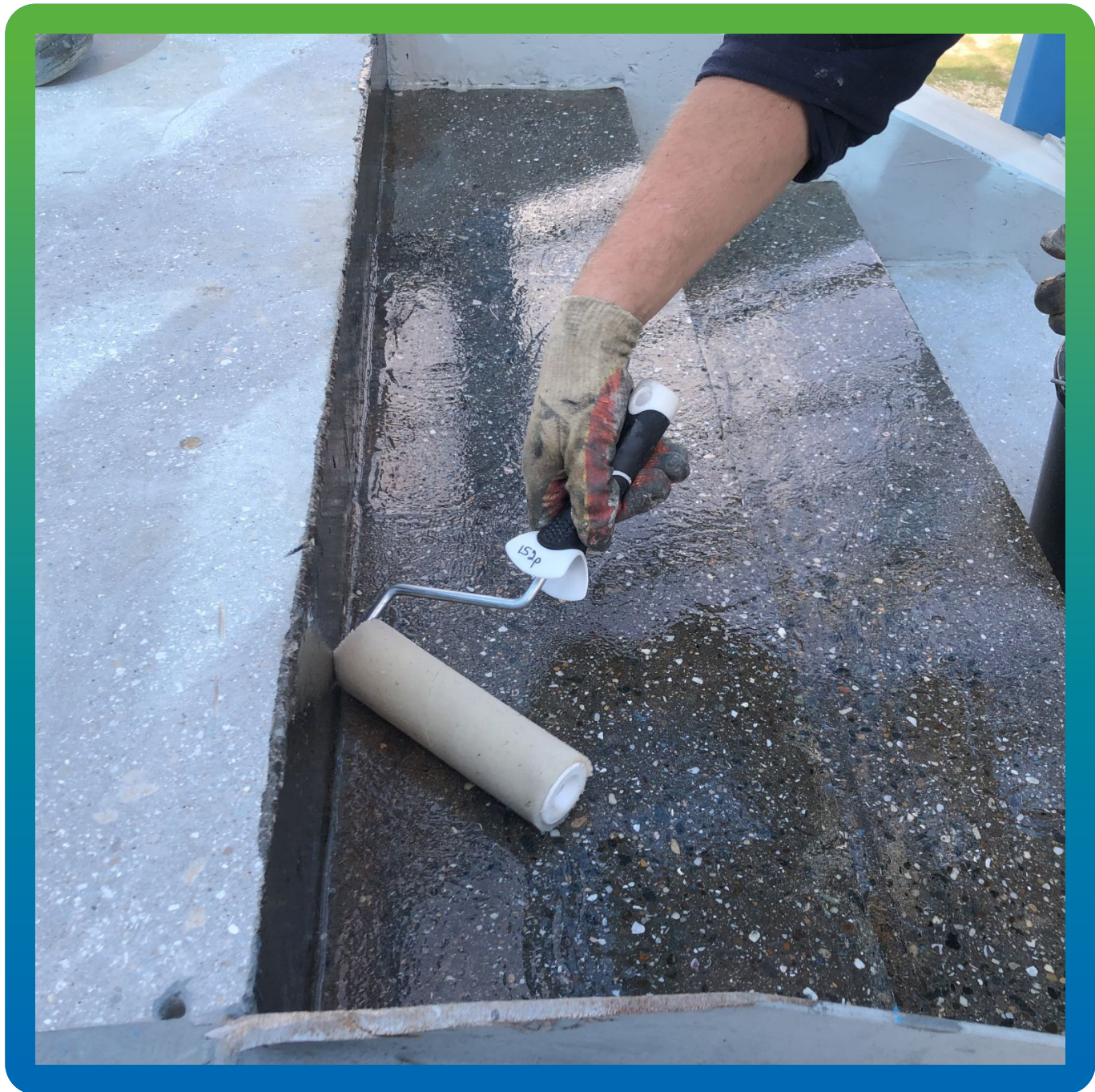
Грунтование лестничного марша при помощи ДенТоп ЭП 100
