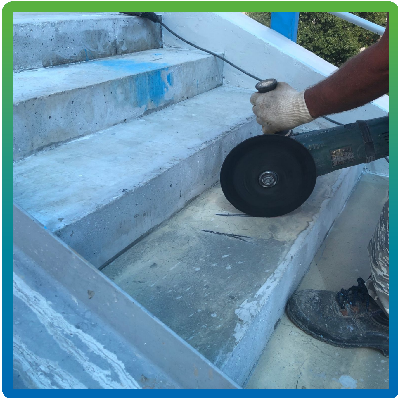
Расшивка трещин, для последующего ремонта
