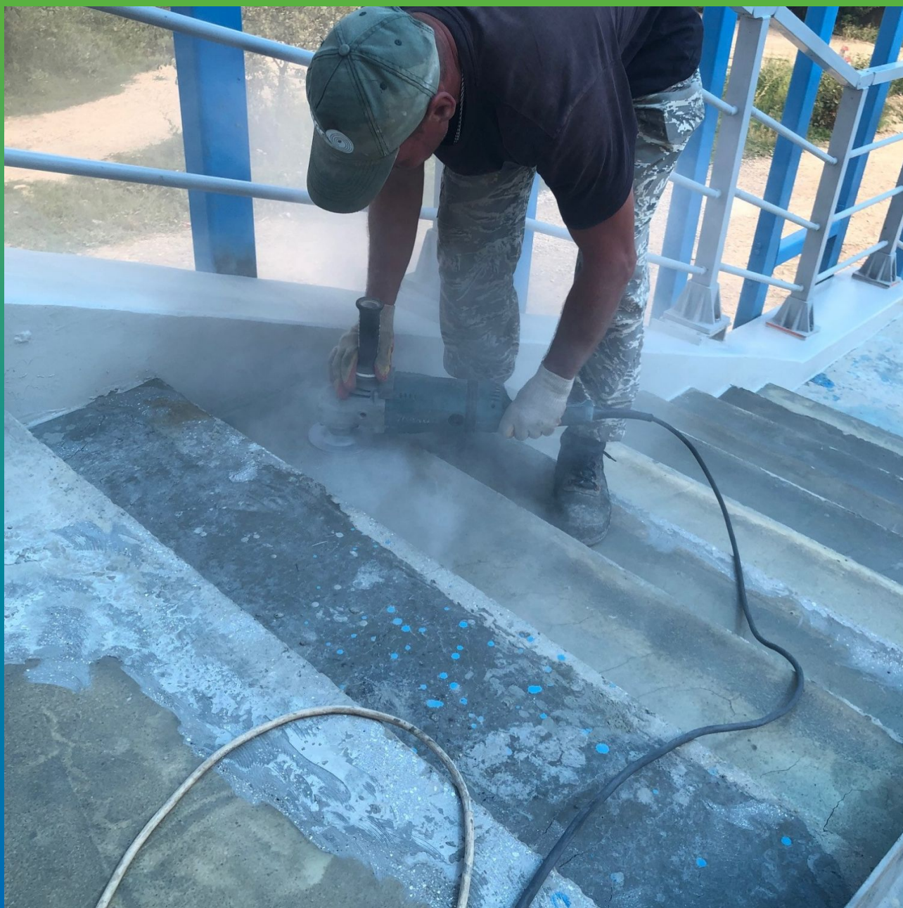
Шлифование бетонных поверхностей
