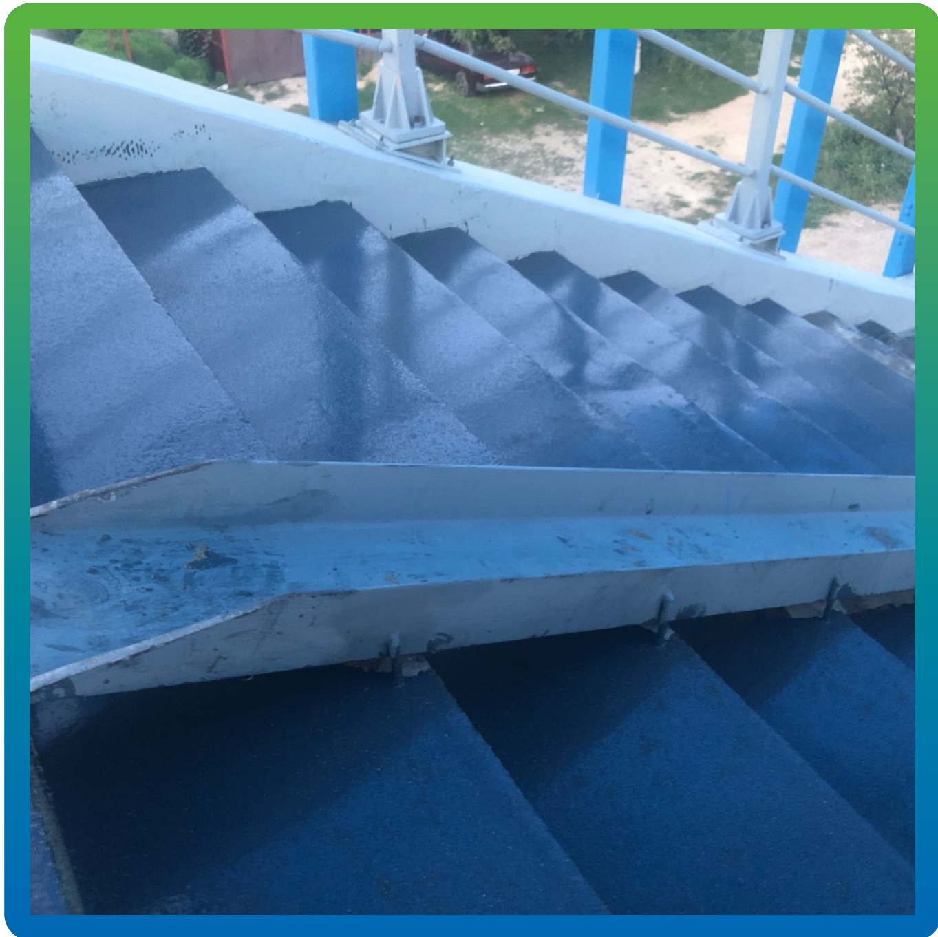
Нанесенный материал ДенТоп ЭП 710 Мастик на лестничном марше
