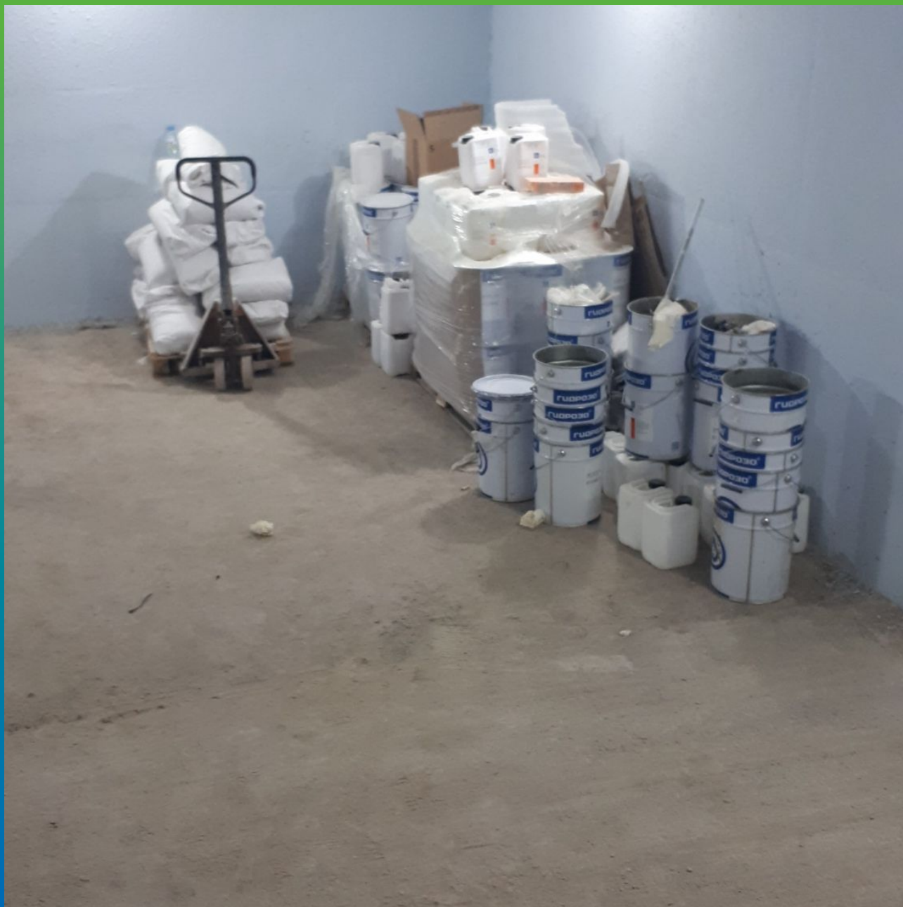
Материалы Гидрозо на объекте
