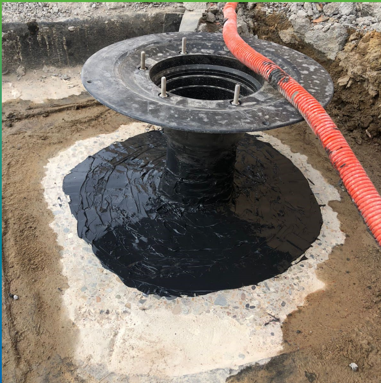
Обмазка площади около воронки составом Манодил Бонд Ф
