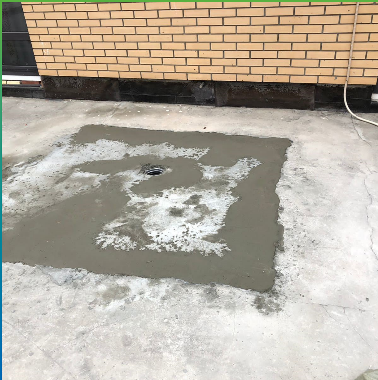
Заливка демонтированного пирога кровли составом Стармекс ФМ7
