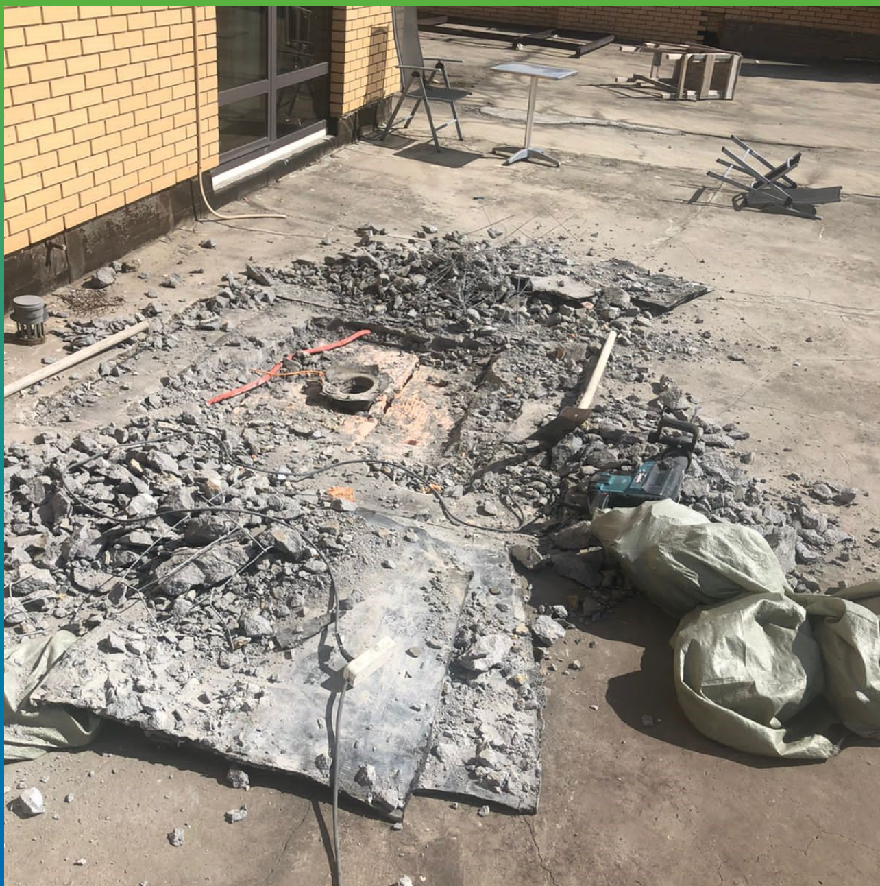
Демонтаж кровельного пирога
