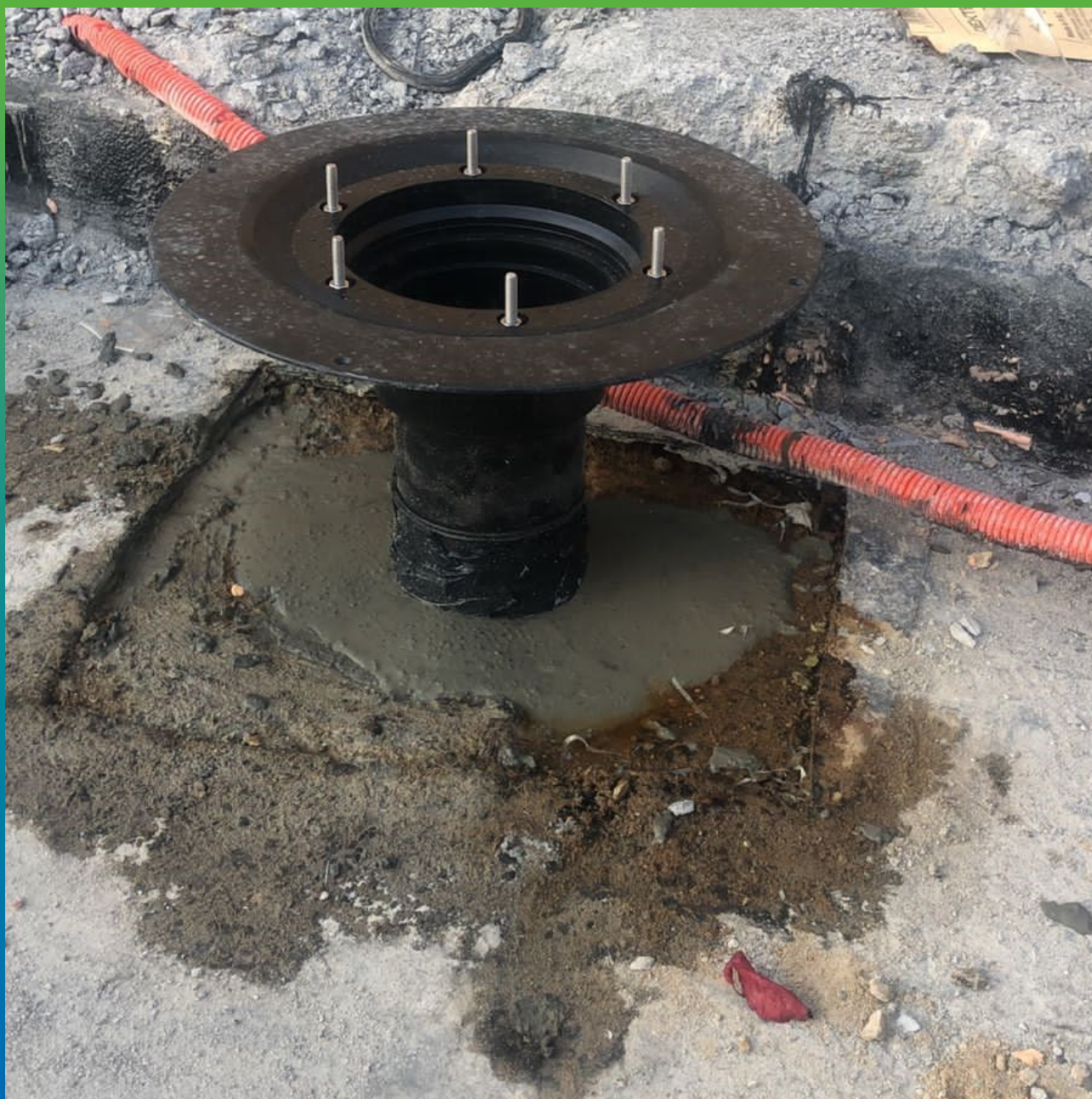
Подливка полости составом Стармекс ФМ7
