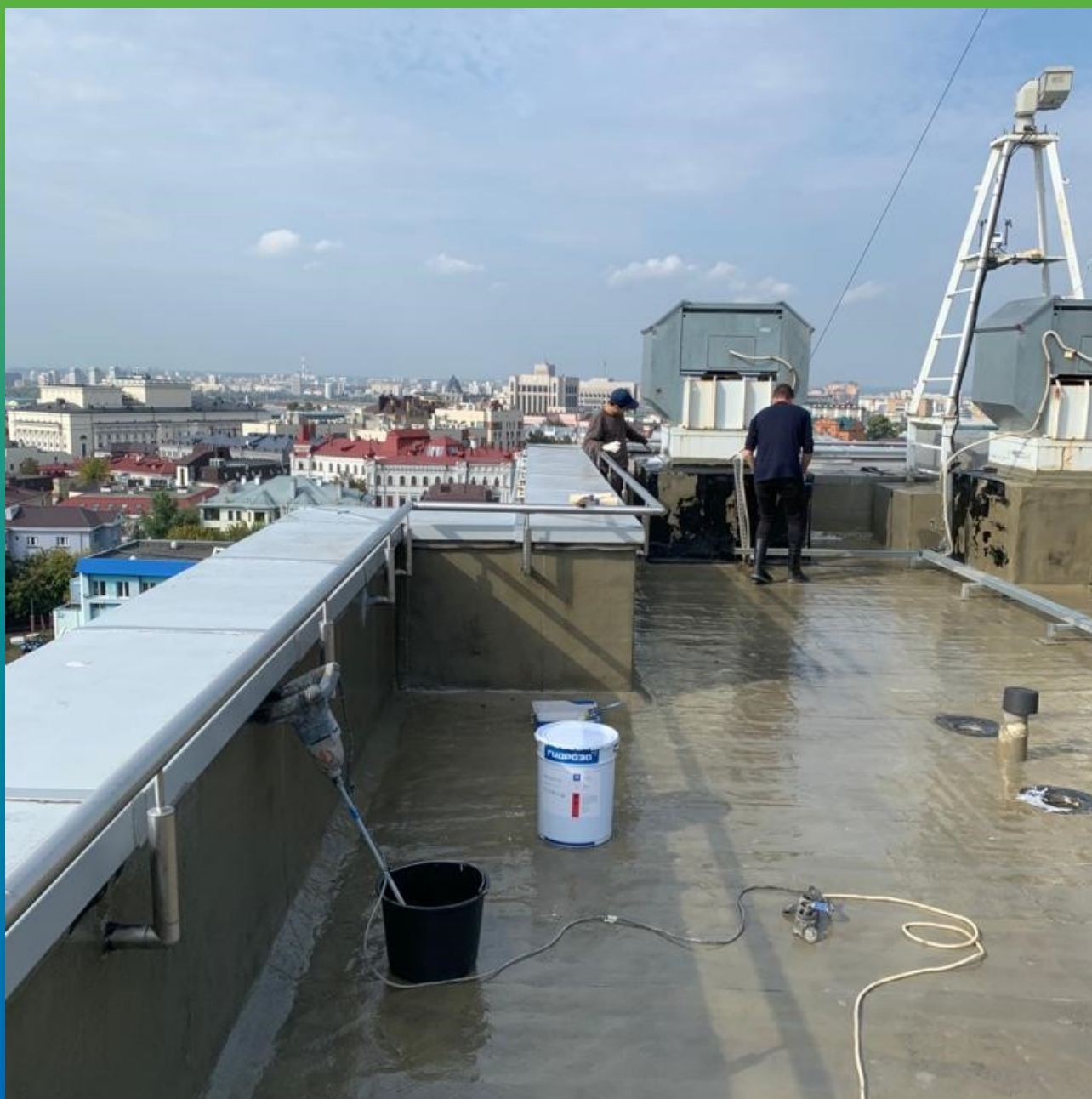
Загрунтованная поверхность
