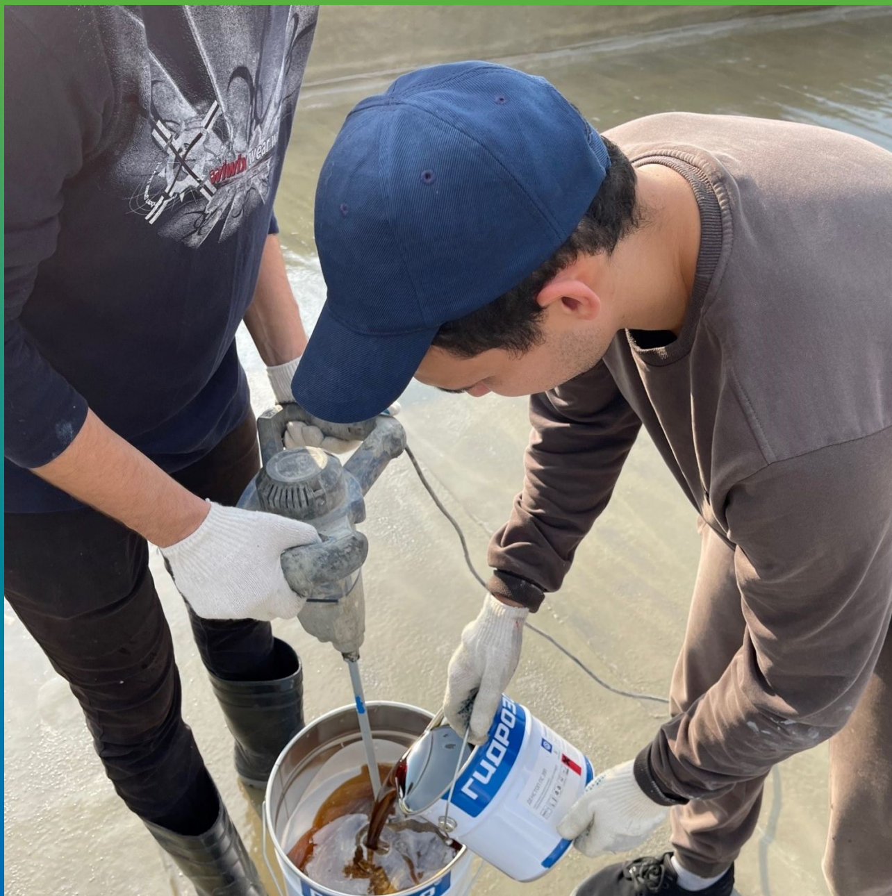
Подготовка материала для нанесения
