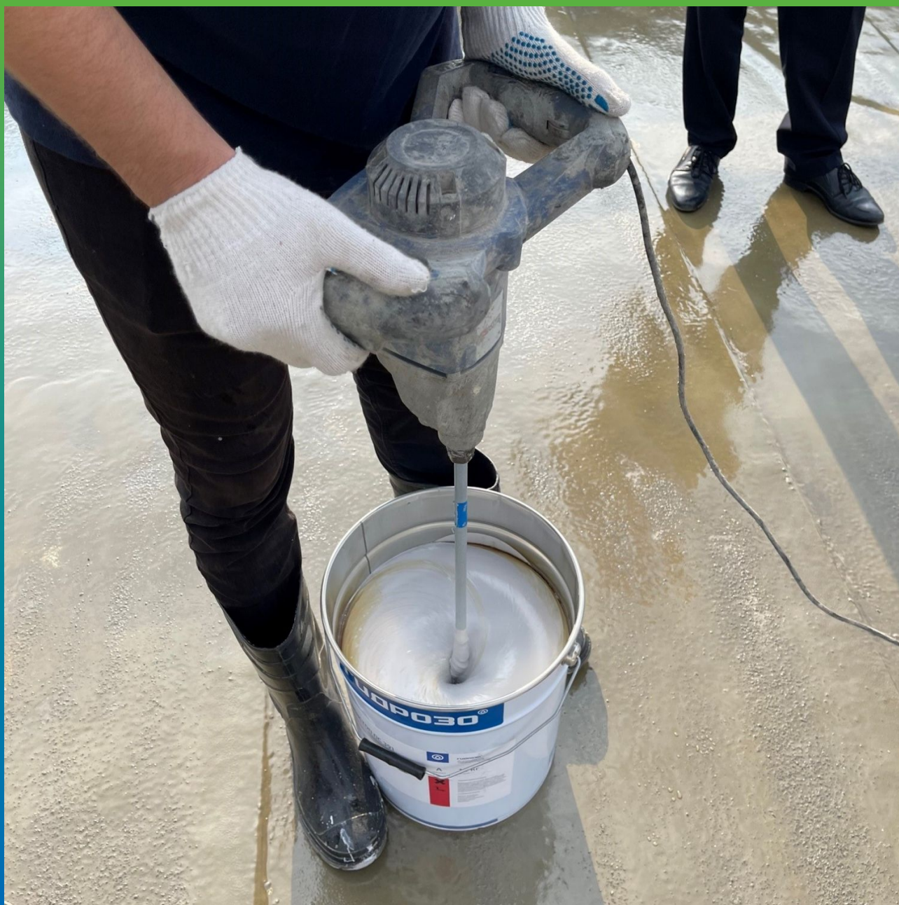
Подготовка материала для нанесения
