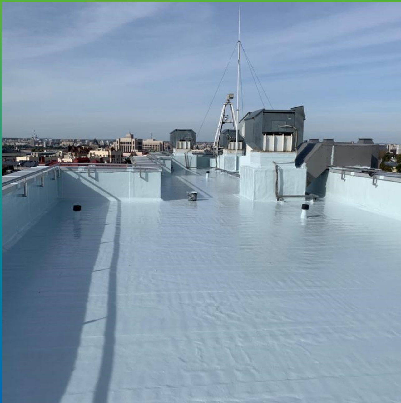
Финишный вид кровли
