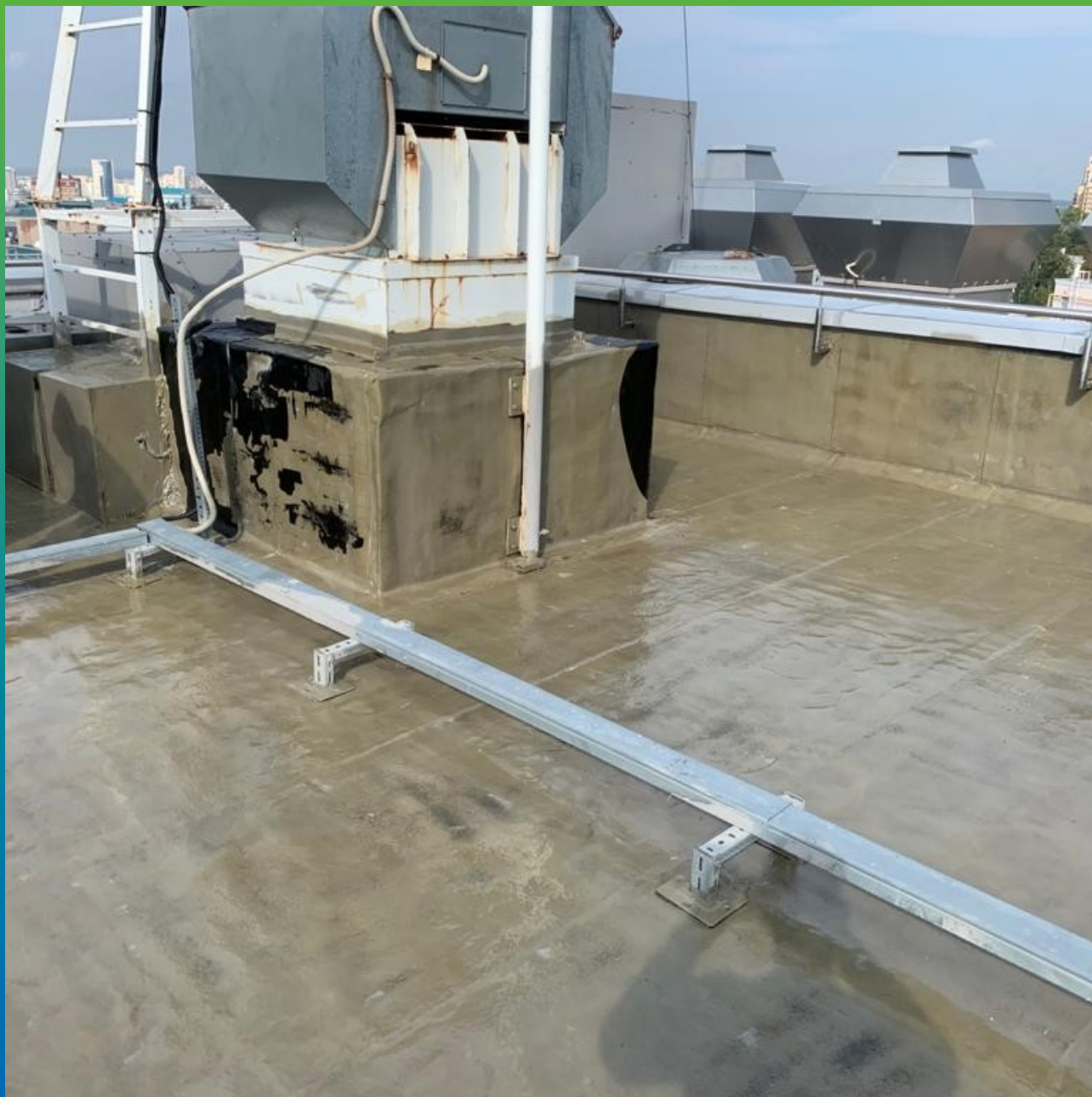
Загрунтованная поверхность
