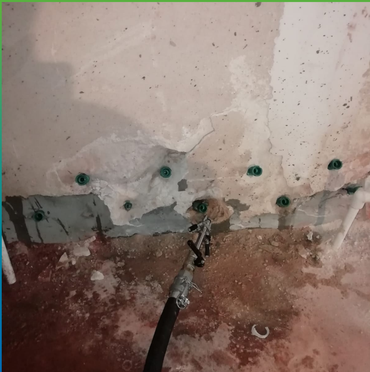
Устройство отсечной гидроизоляции при помощи Маноксан 155
