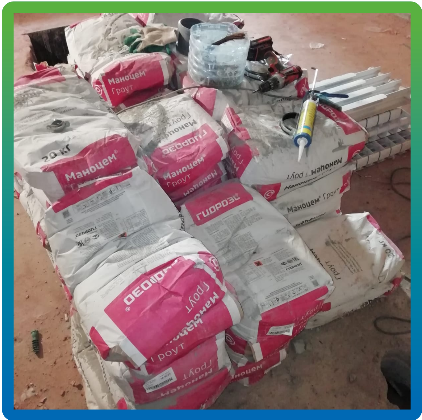
Материал Маноцем Грунт на объекте.
