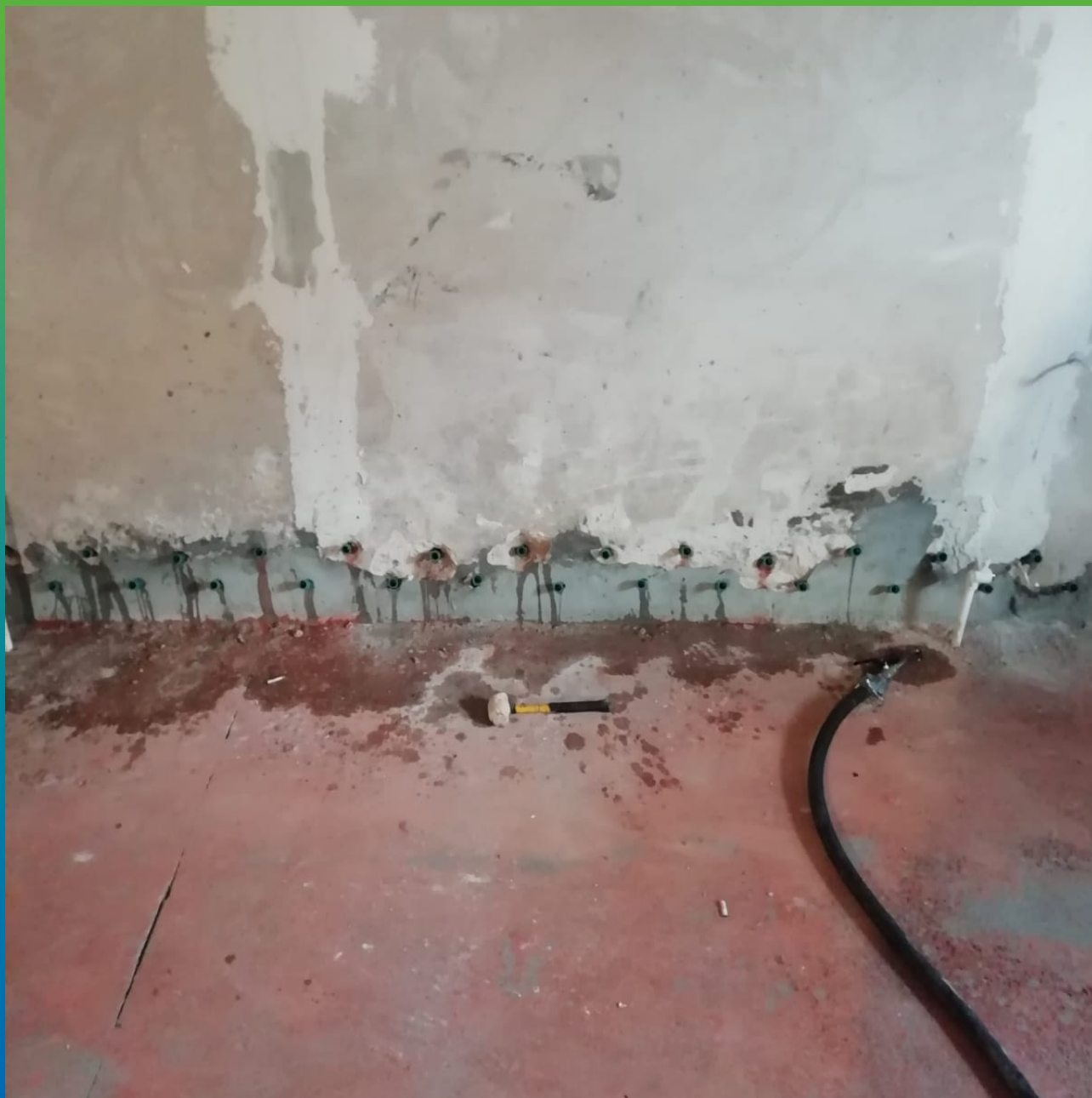
Проинъектированный участок
