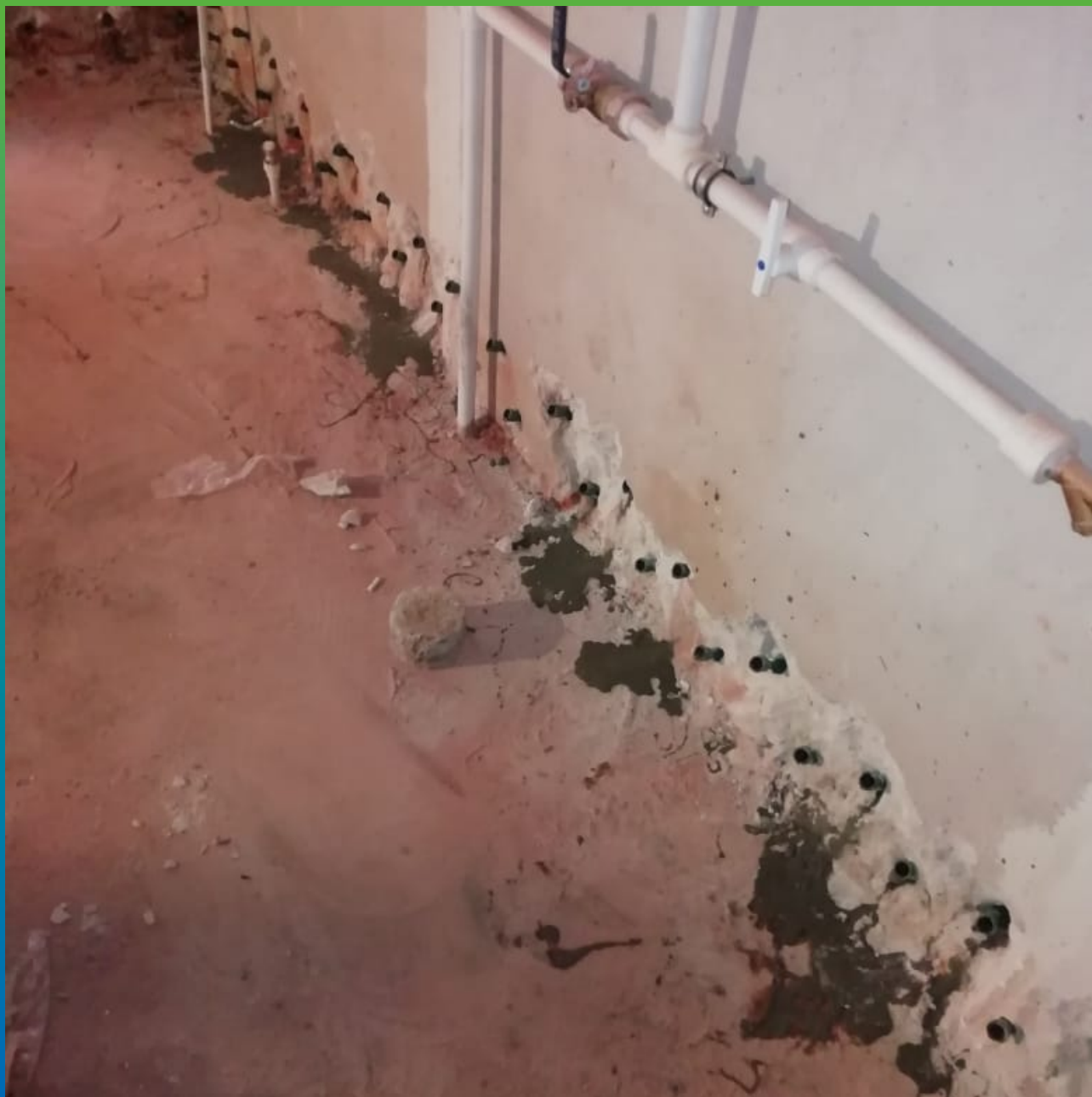
Инъектирование в фундамент Маноцем Гроут
