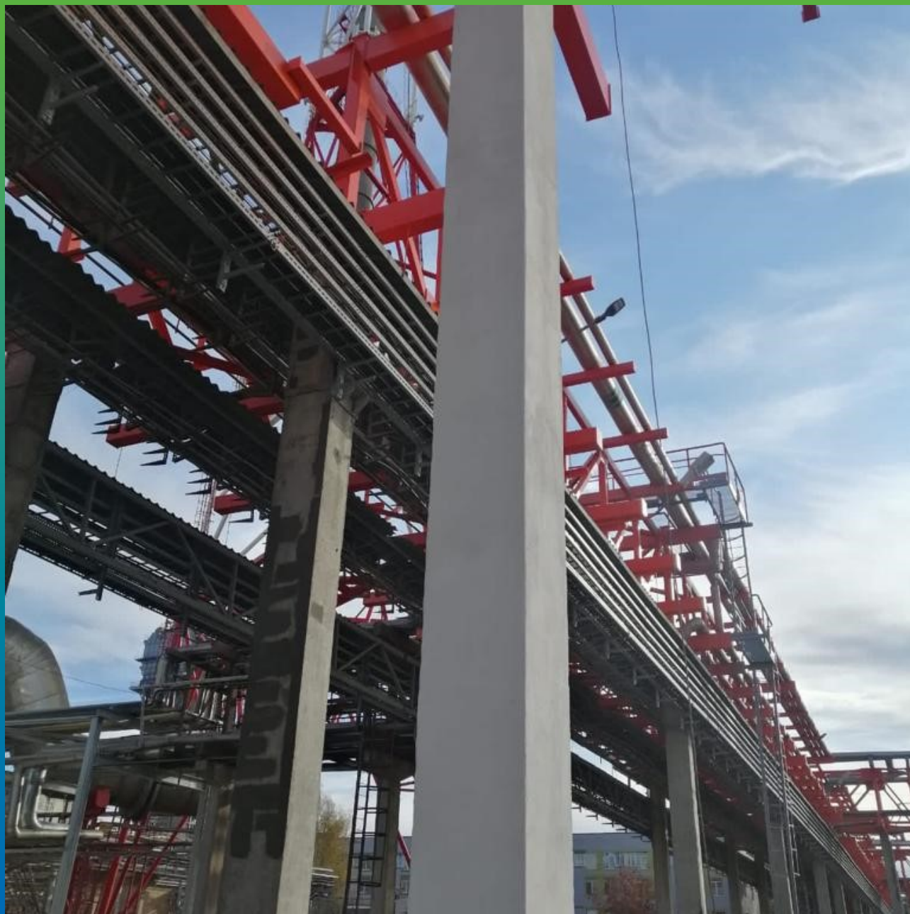
Внешний вид колонн после завершения работ.
