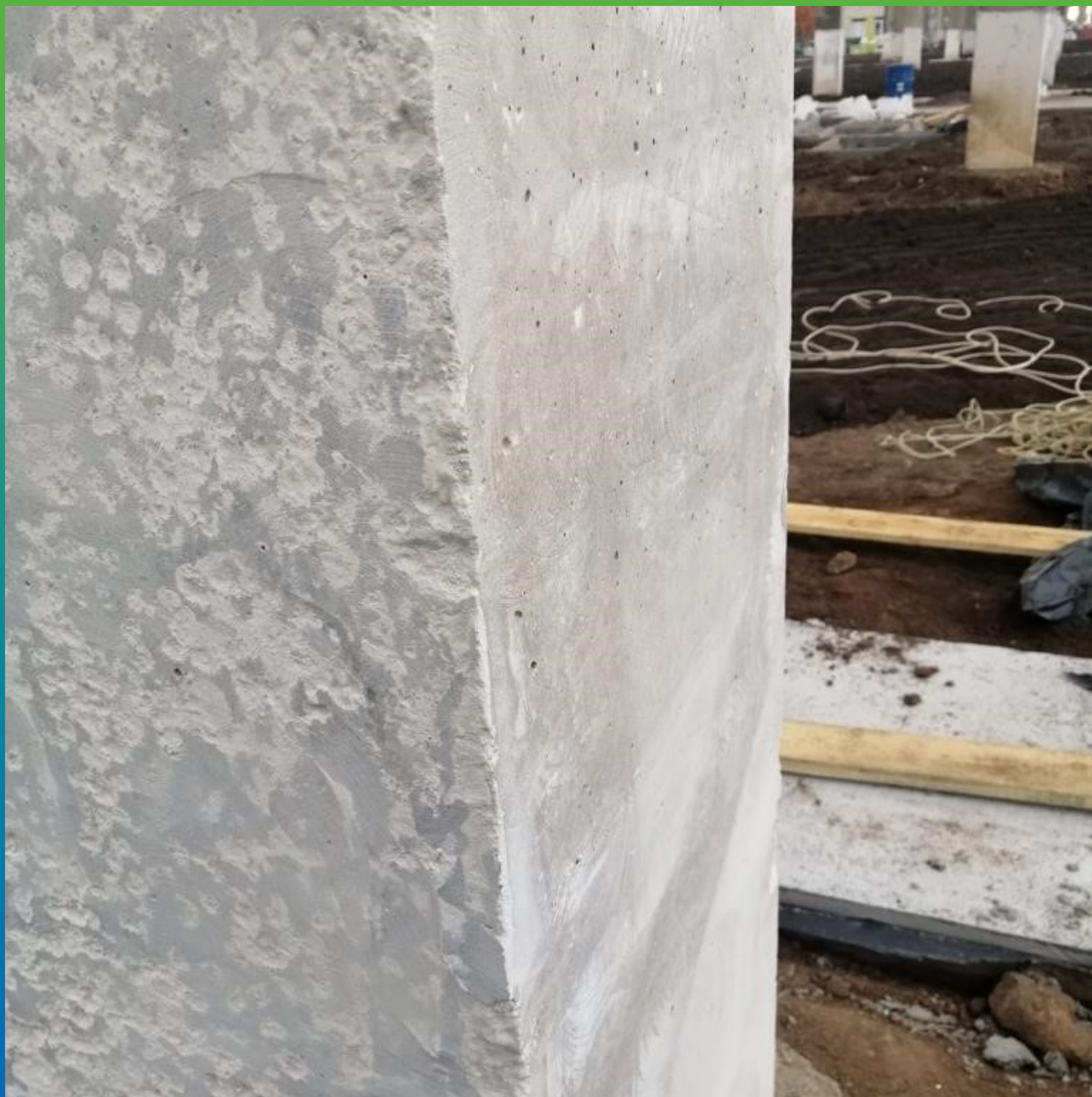
Подготовка основания под нанесение рем. состава Стармекс РМЗ
