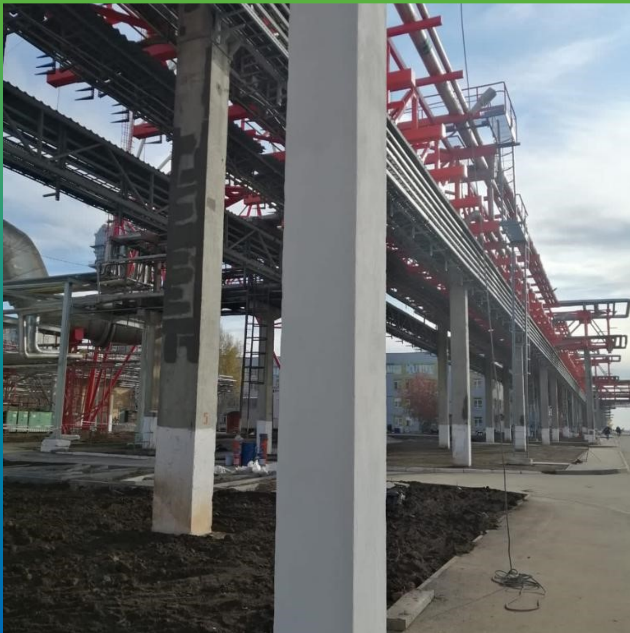
Внешний вид колонн после завершения работ.
