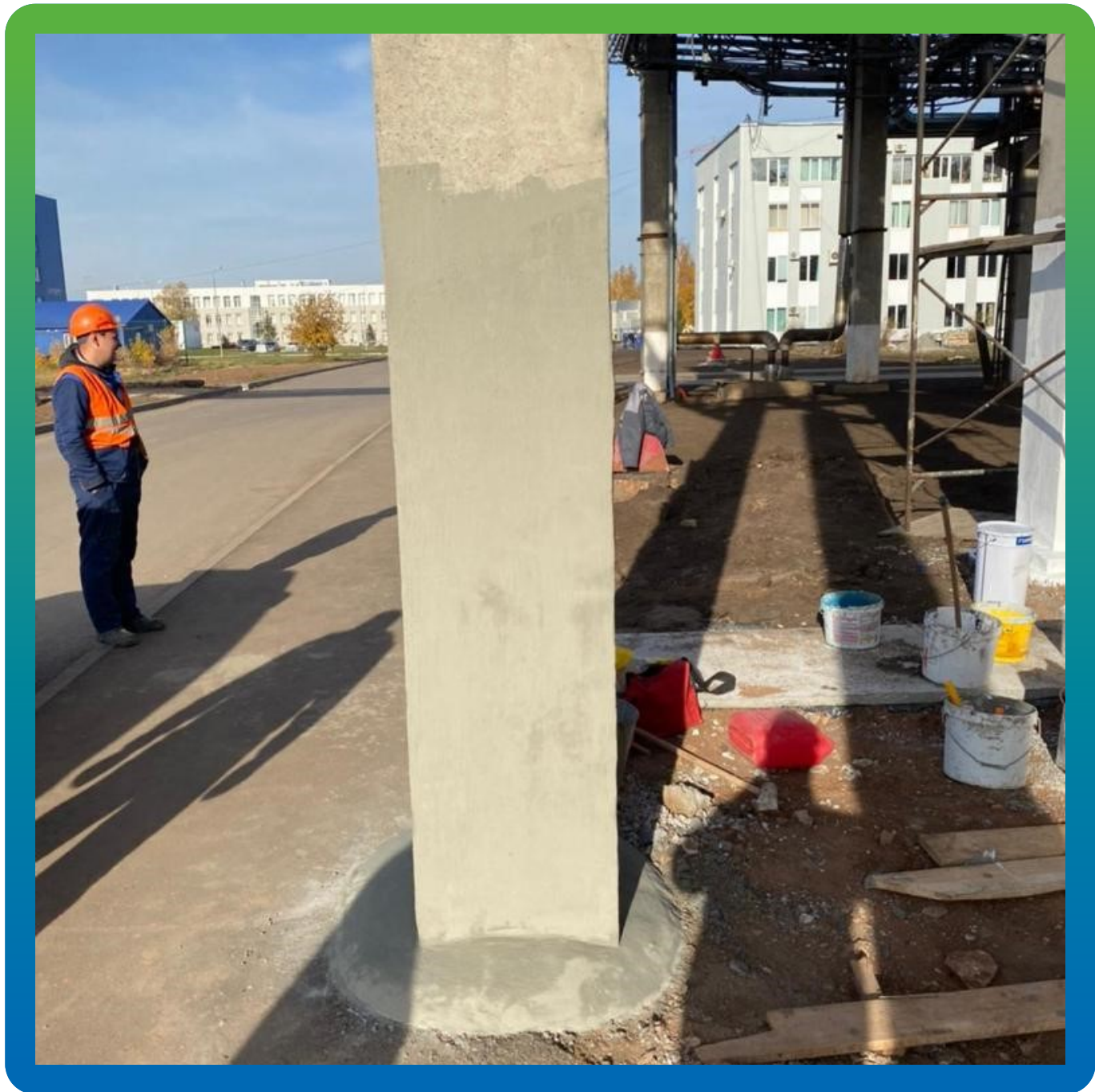
Нанесение Стармекс Сил
