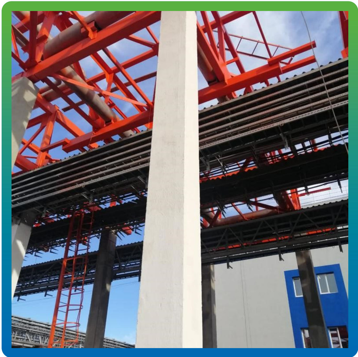
Внешний вид после завершения работ
