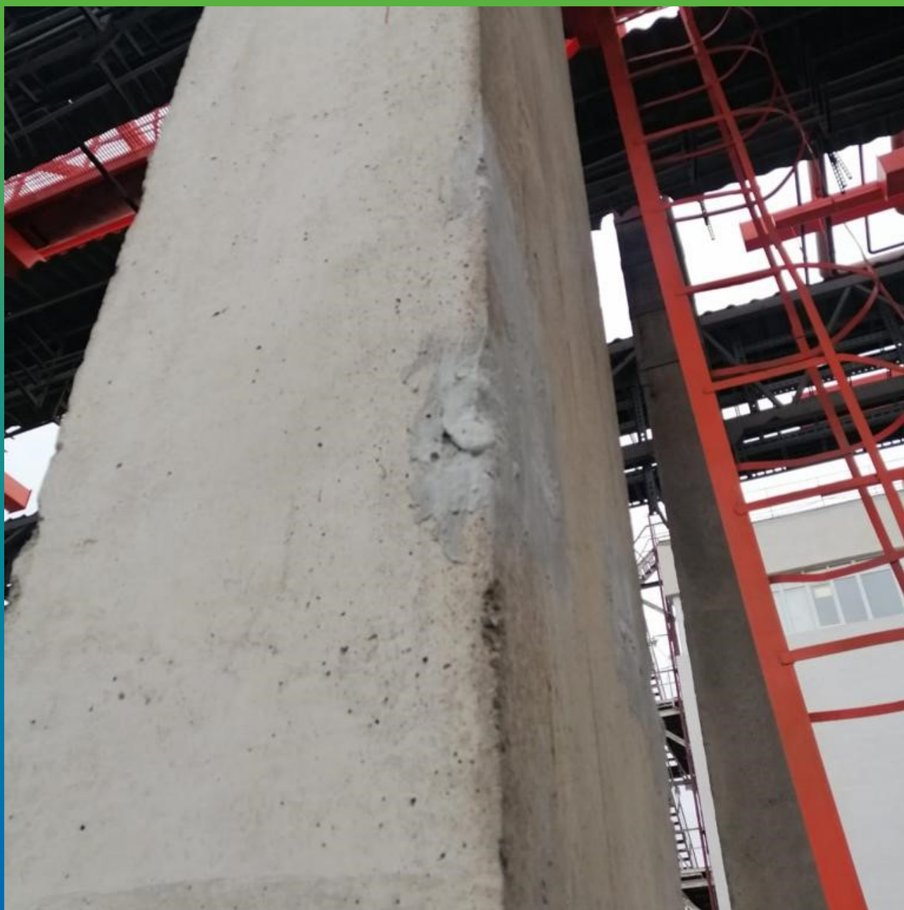
Колонна под нанесение защитного состава
