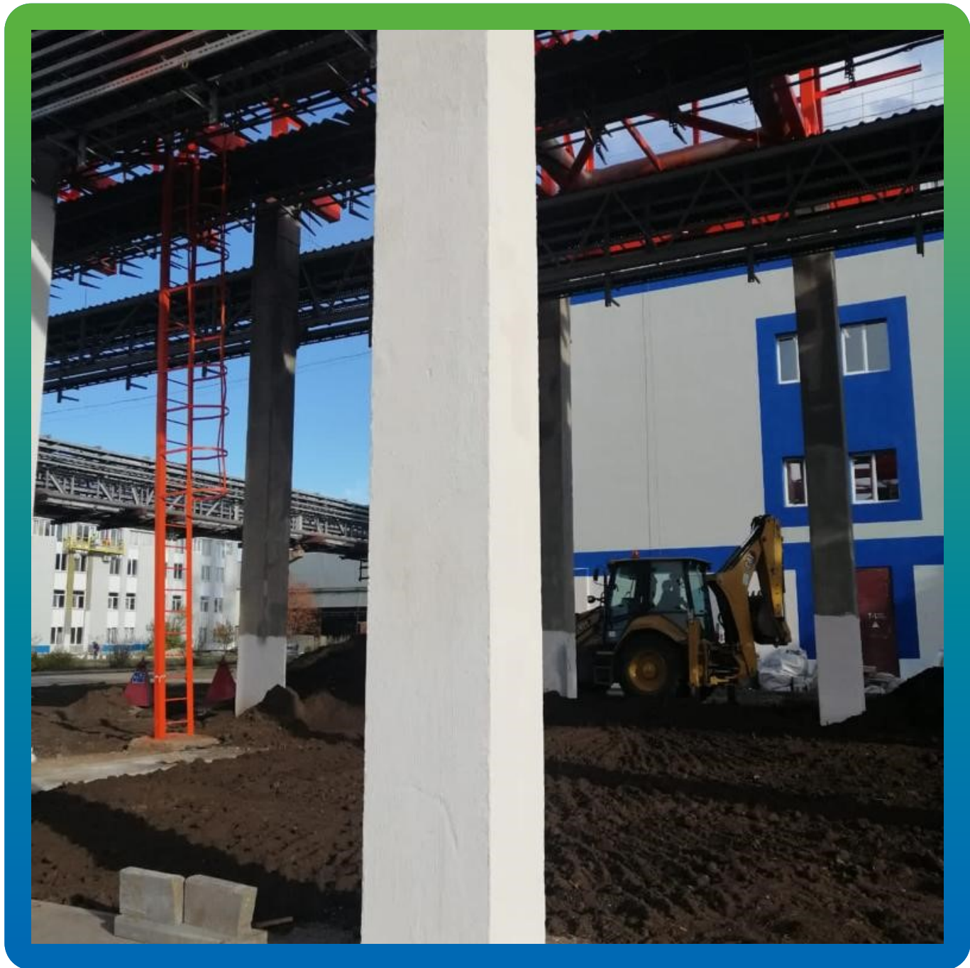
Внешний вид после завершения работ
