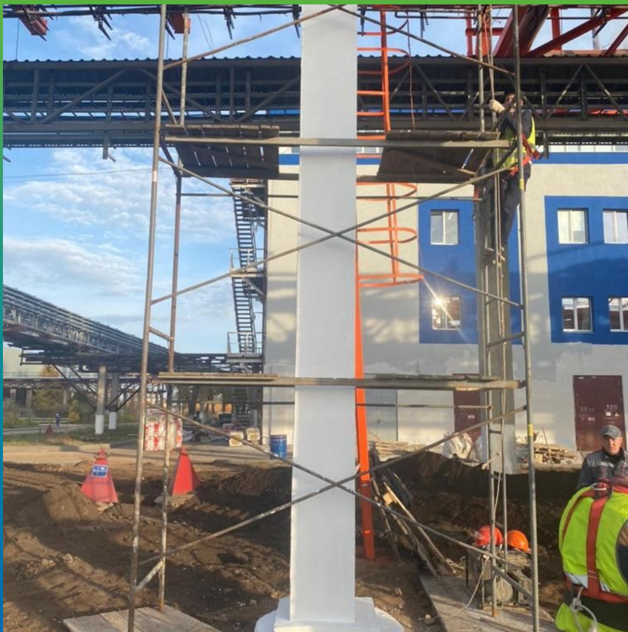
Нанесение декоративного защитного покрытия ДенТоп АК 220
