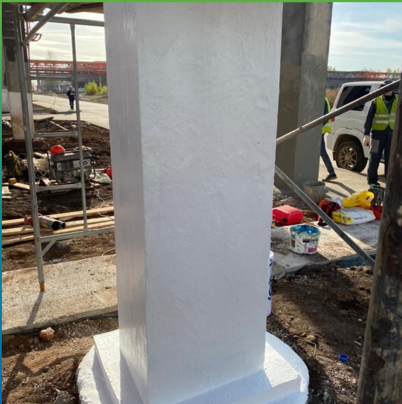
Нанесение декоративного защитного покрытия ДенСтол АК 220
