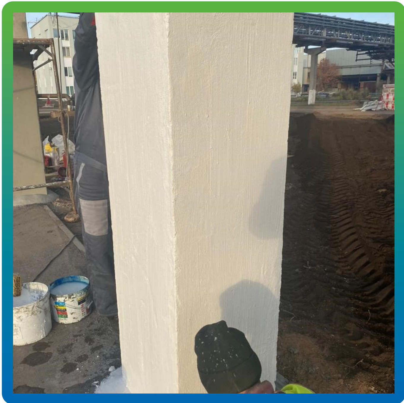
Нанесение декоративного защитного покрытия ДенТоп АК 220
