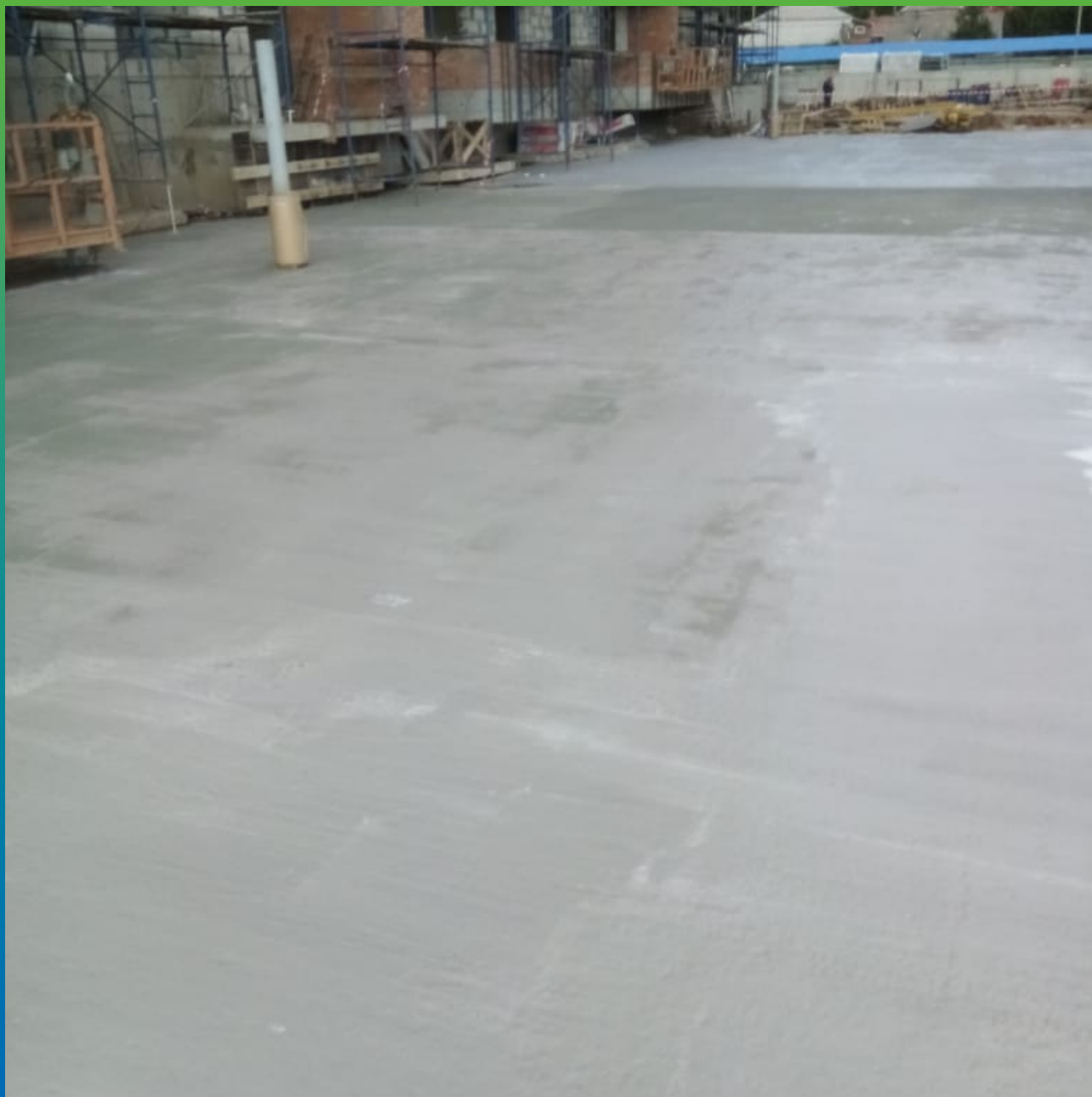
Плита после нанесенной гидроизоляции
