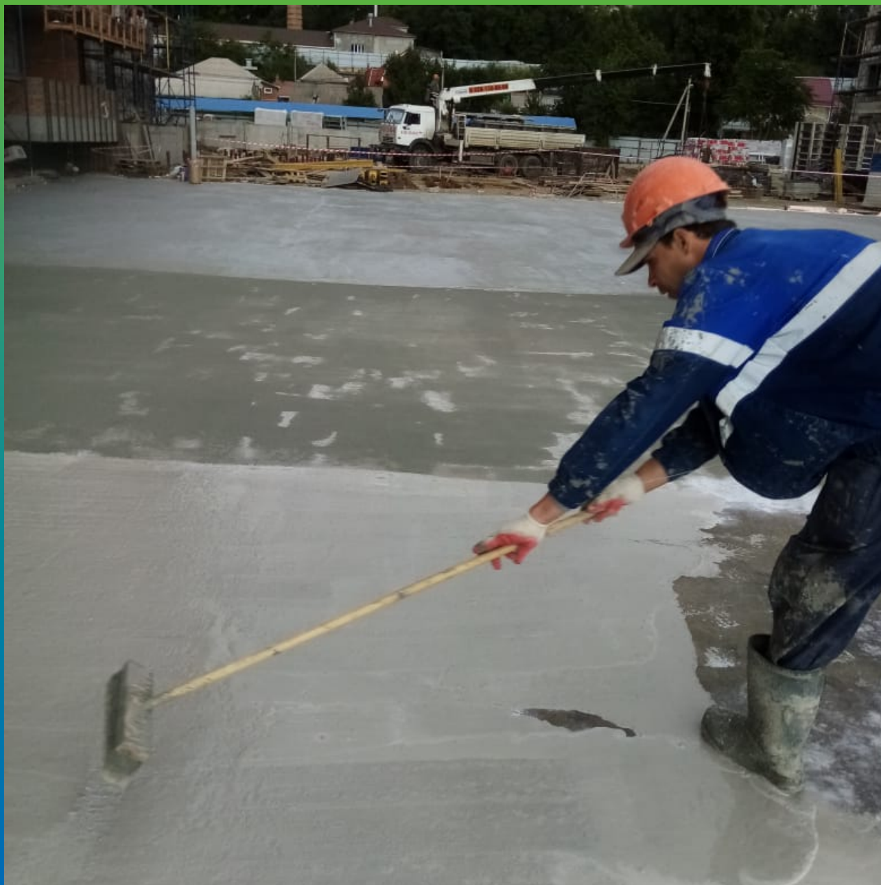
Нанесение Стармекс Сил Флекс в несколько слоев по плите
