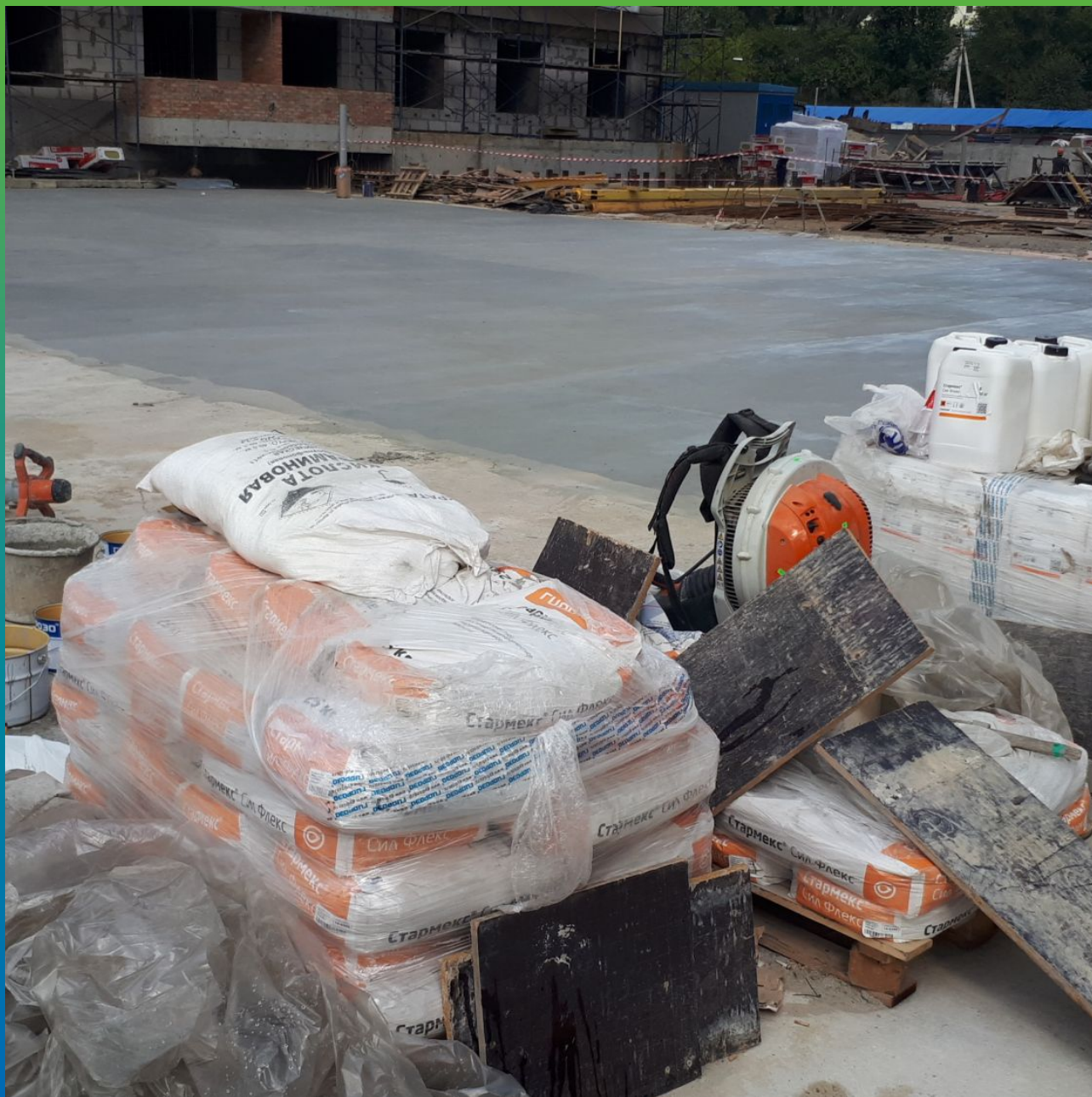
Материалы Гидрозо на объекте
