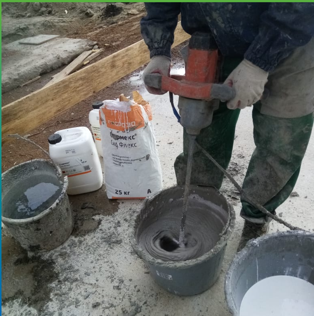
Замешивание эластичной гидроизоляции Стармекс Сил Флекс
