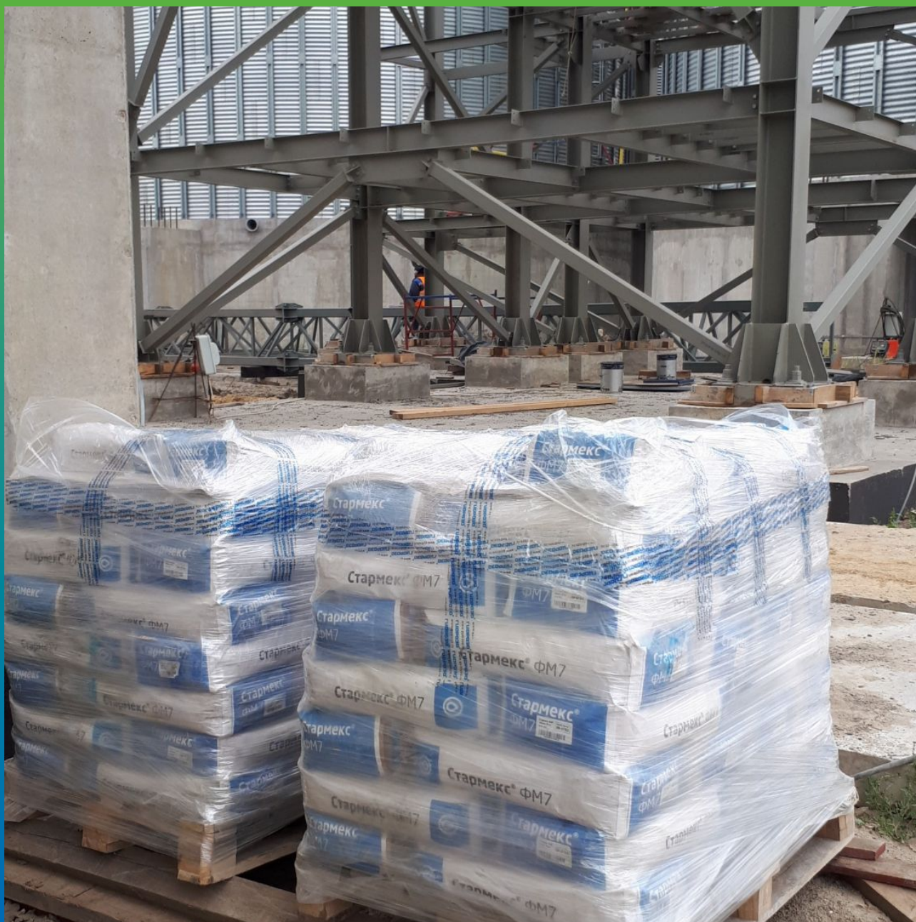
Стармекс ФМ7 на объекте
