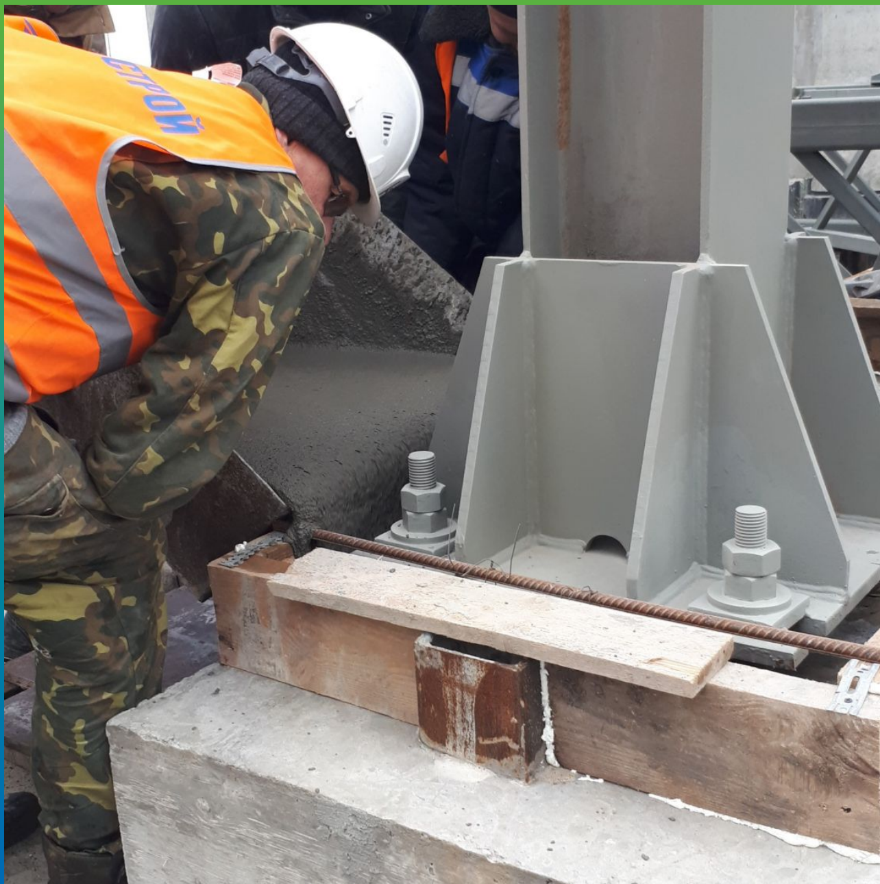
Подливка под базу колонны высокопрочного состава Стармекс ФМ7
