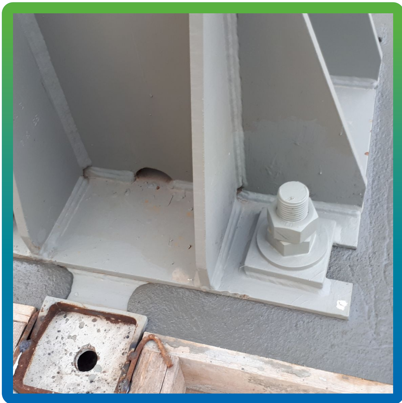
Выполнена подливка базы колонны
