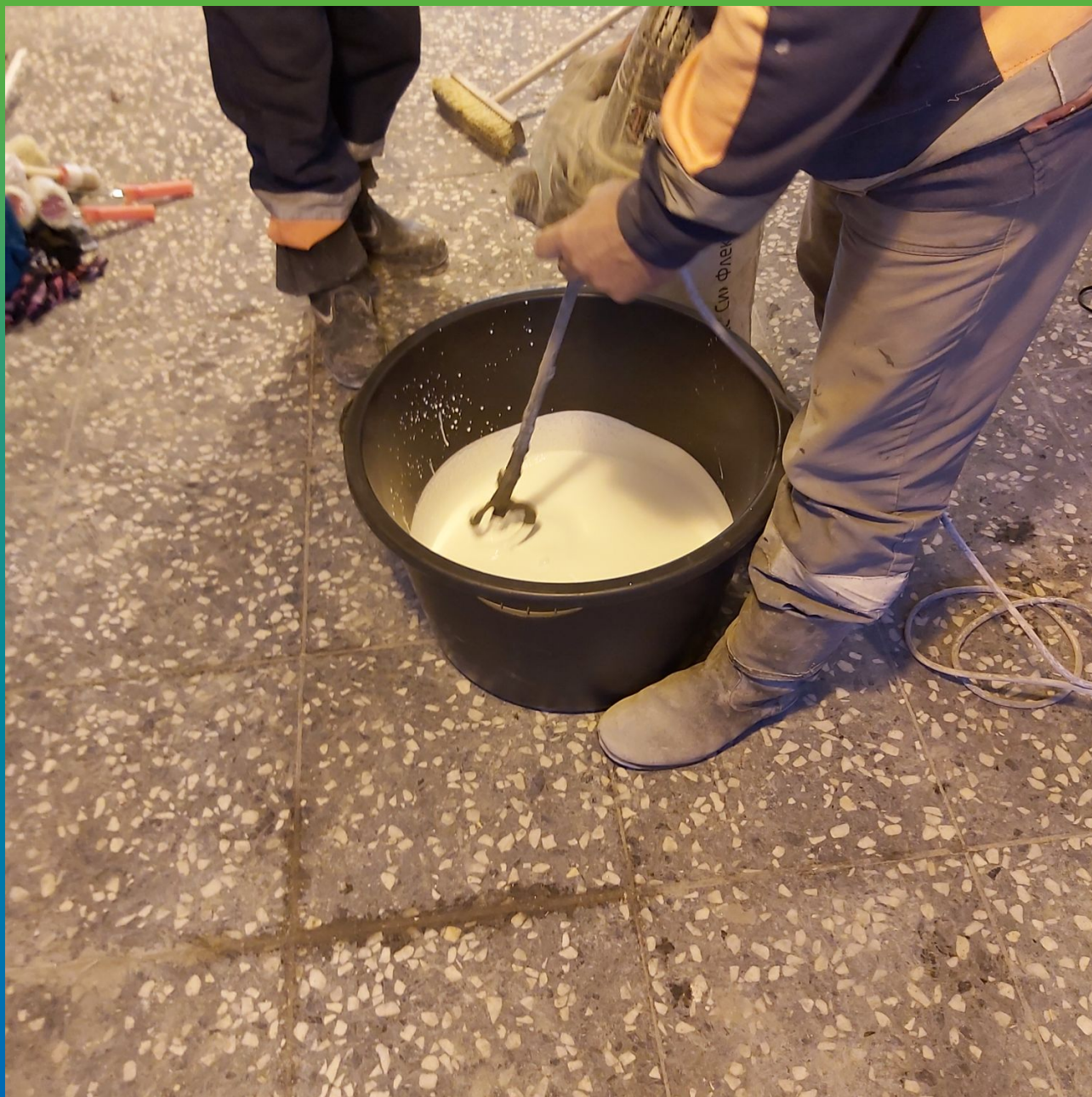
Перемешивание жидкого компонента материала Стармекс Сил Флекс.
