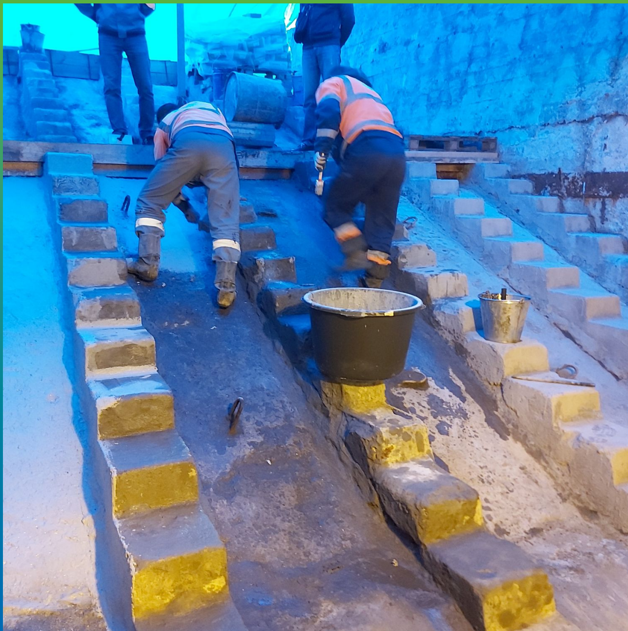
Нанесение гидроизоляции
