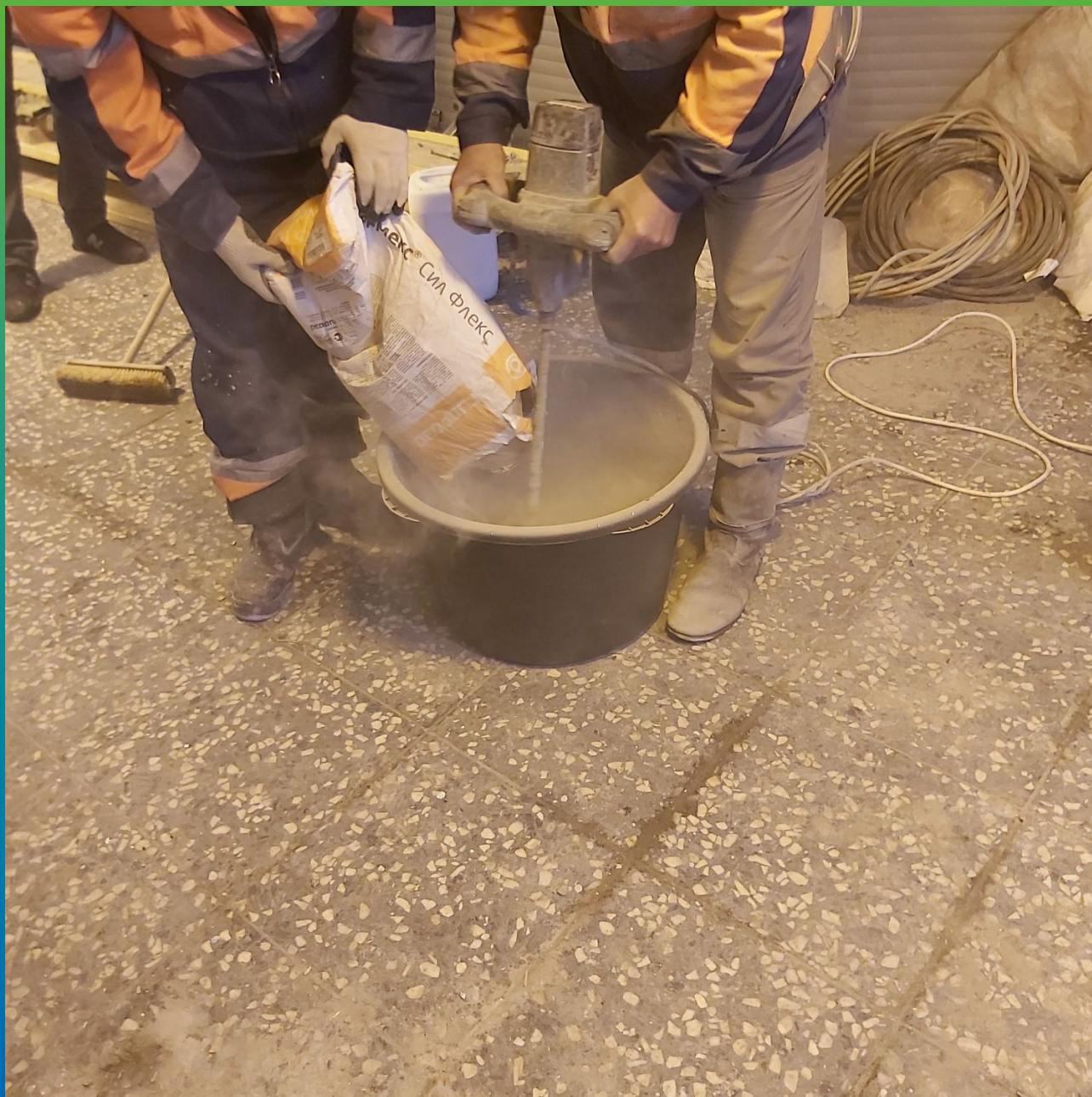
Добавление сухого компонента материала Стармекс Сил Флекс.
