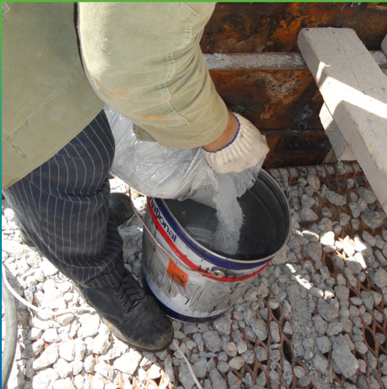
Затворение Максдинамит Цементa водой
