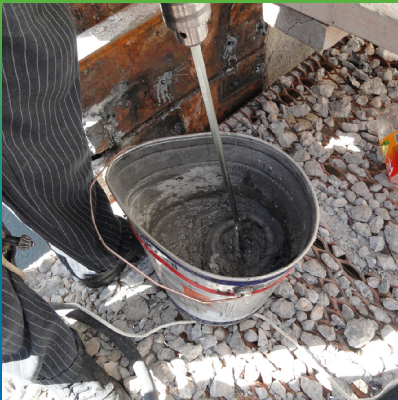
Смешивание Максдинамит Цемента низкоскоростной дрелью
