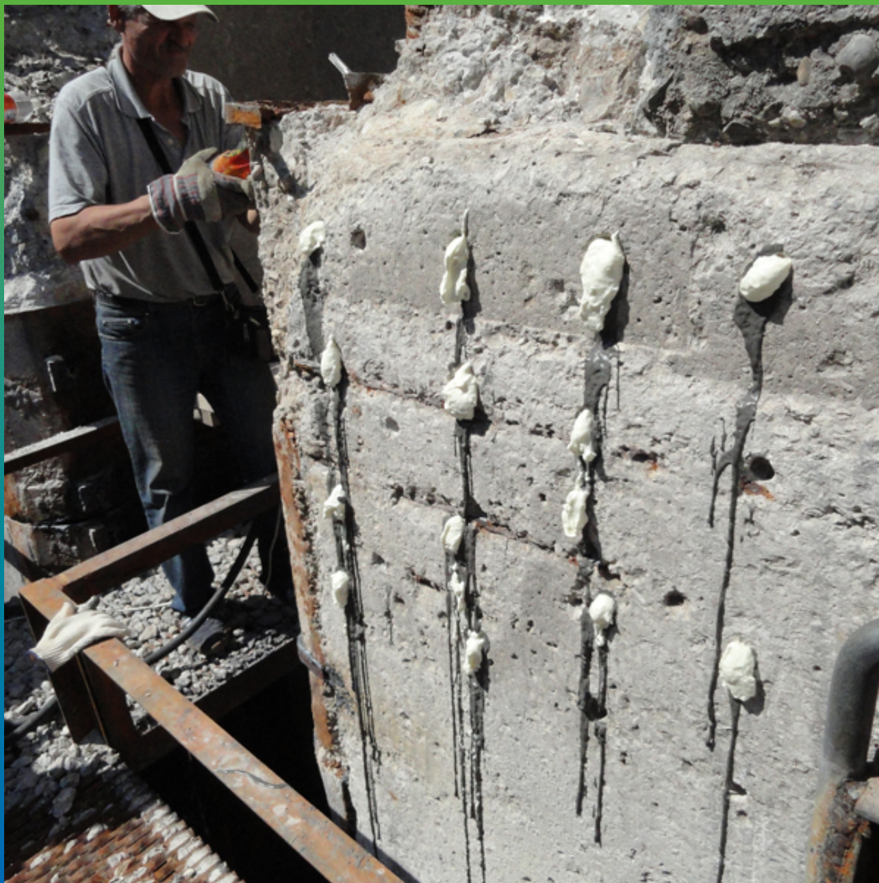
Закупорка шпуров монтажной пеной (частный случай)
