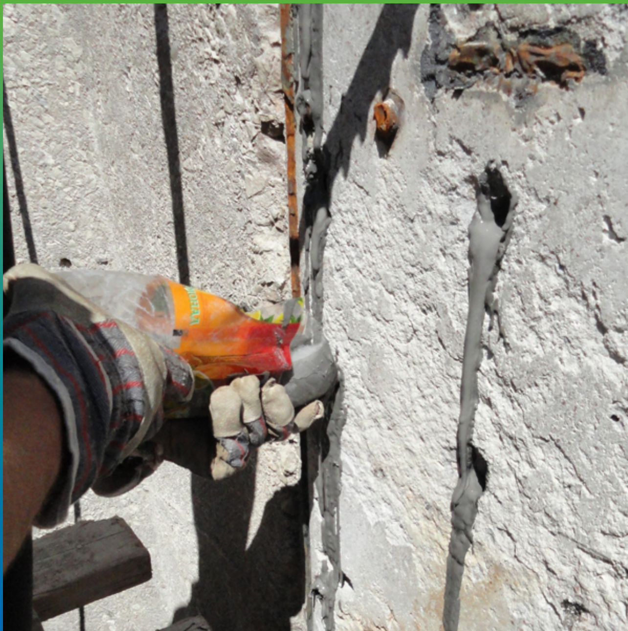
Заполнение шпуров составом Максдинамит Цемент
