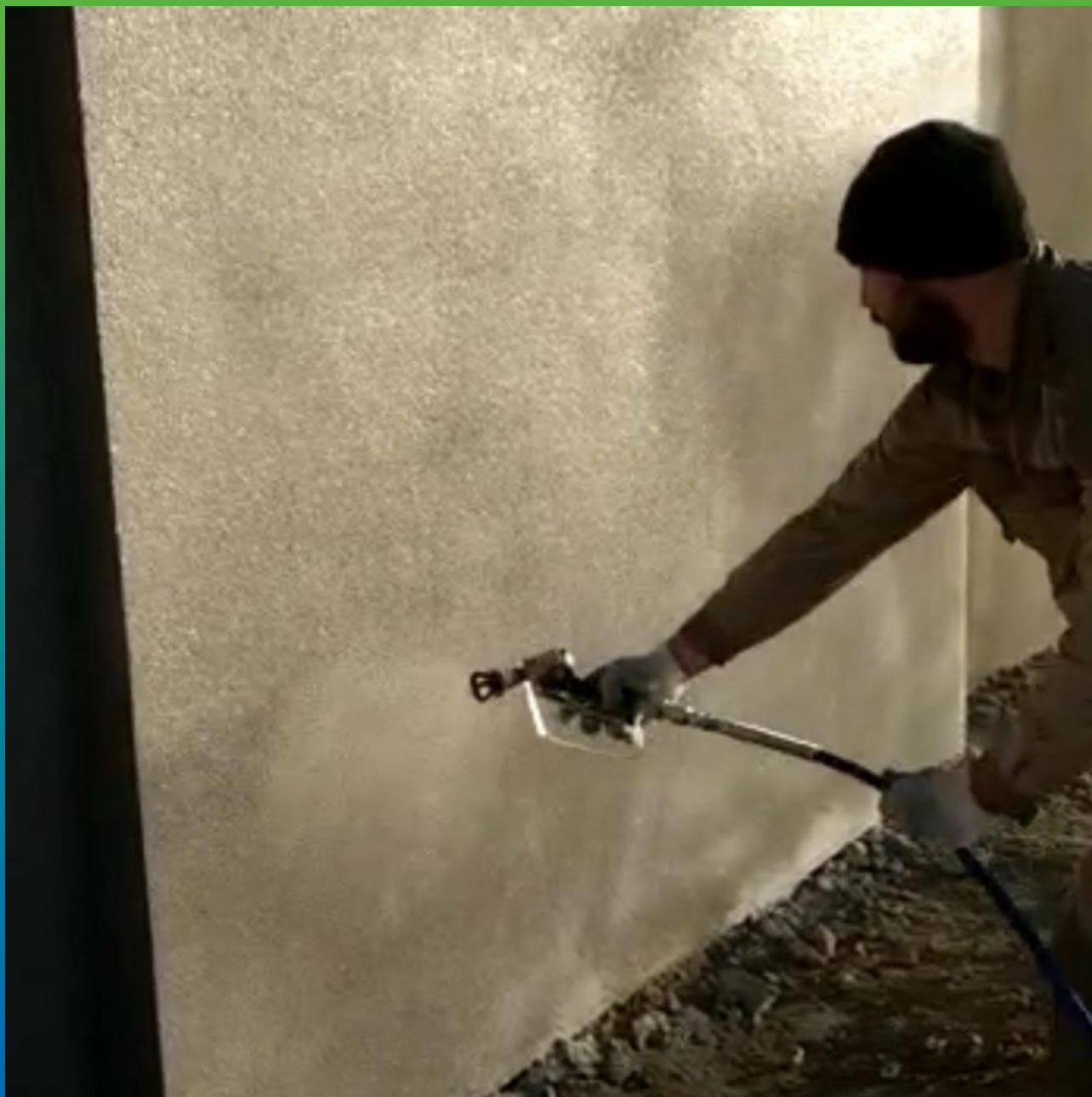
Окрашивание поверхностей водонепроницаемым покрытием ДенТоп ПУ 245 Пул
