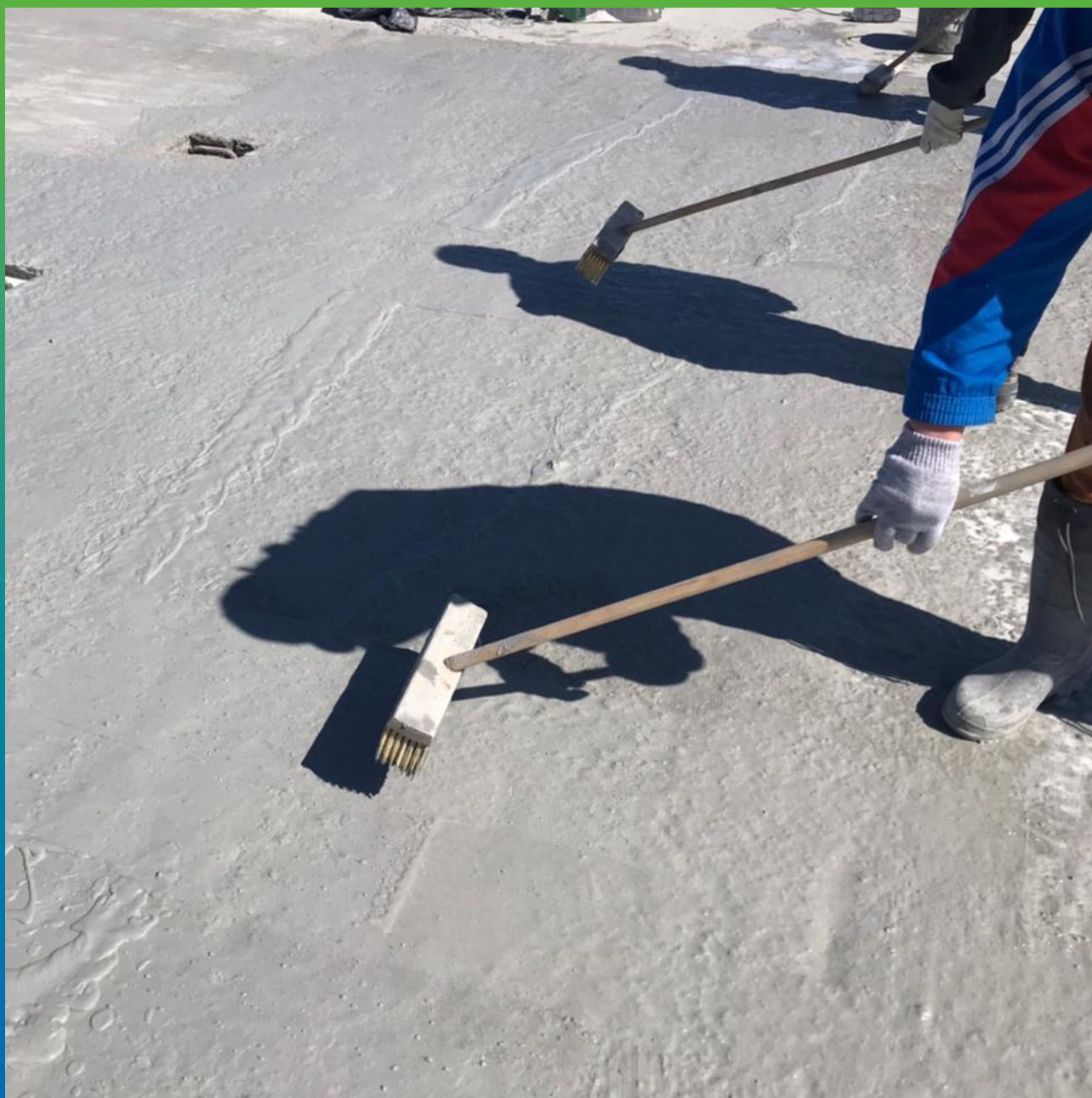
Нанесение состава Стармекс Сил по всей площади плиты
