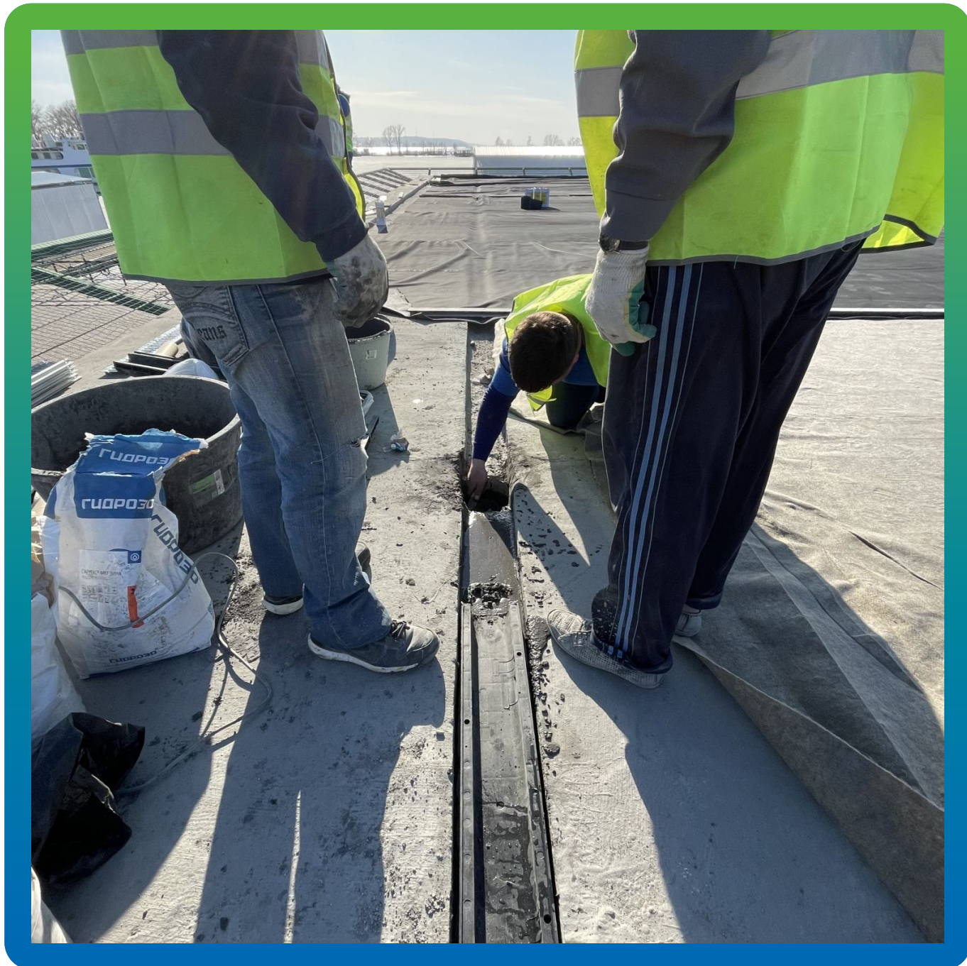
Притапливание пластмассового лотка в анкерочный состав Стармекс ФМ7
