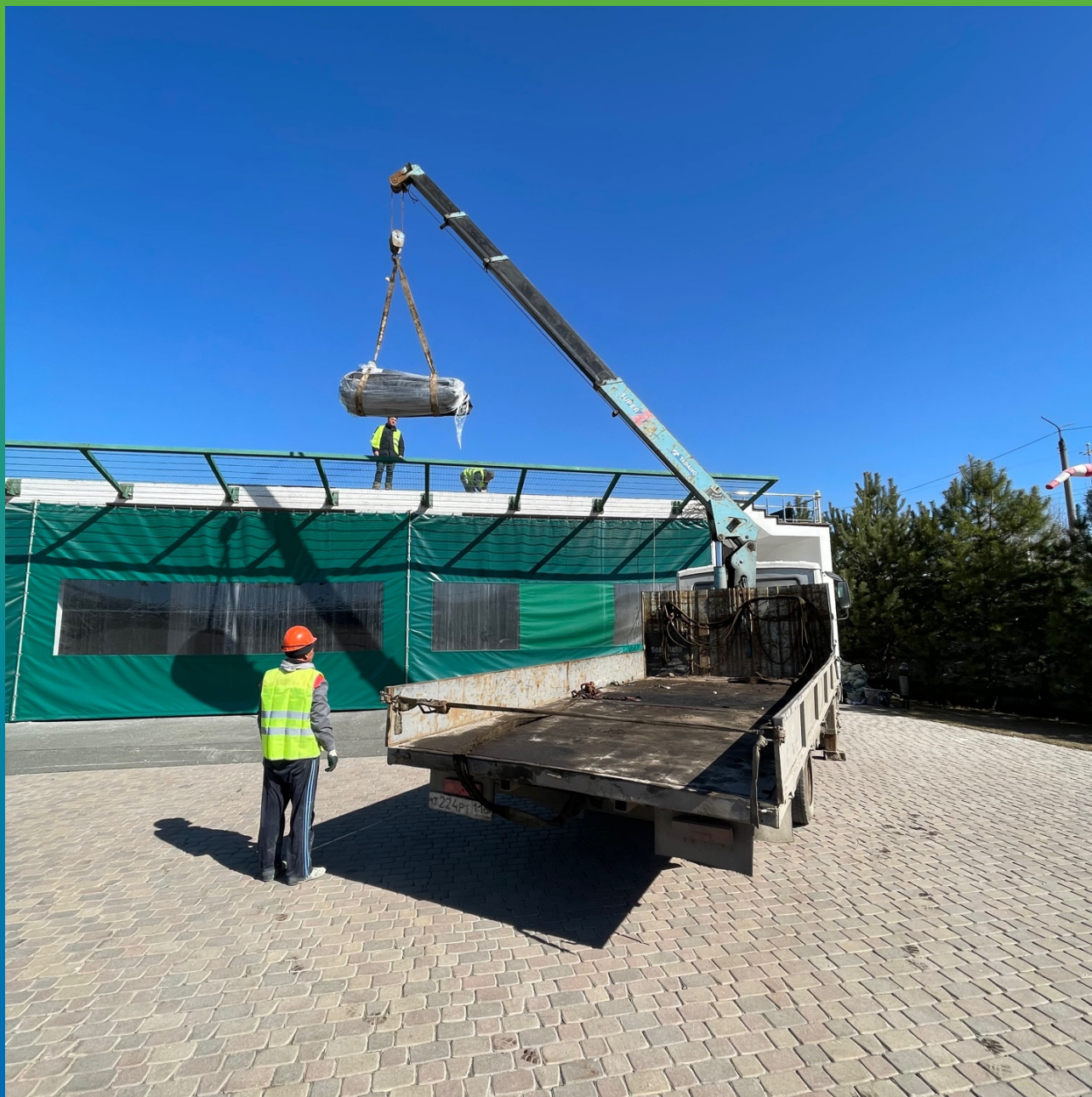
Подача мембраны Преласты СТ на вертолетную площадку
