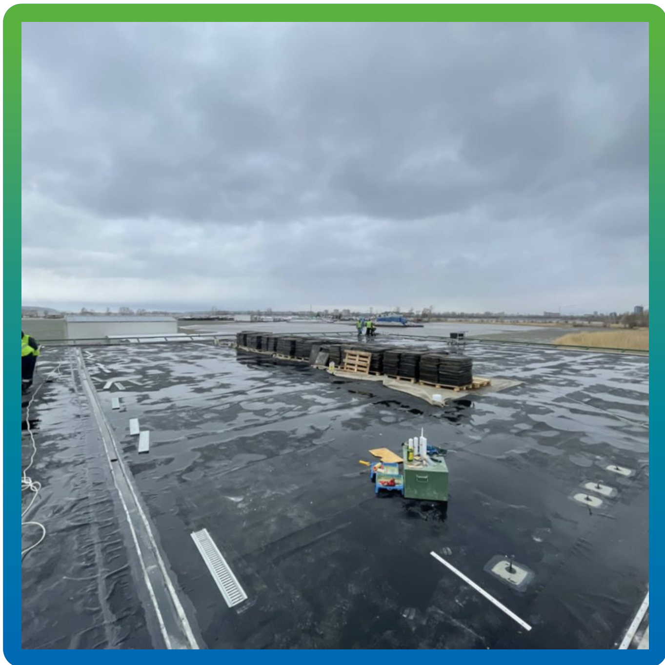
Площадка перед укладкой матов
