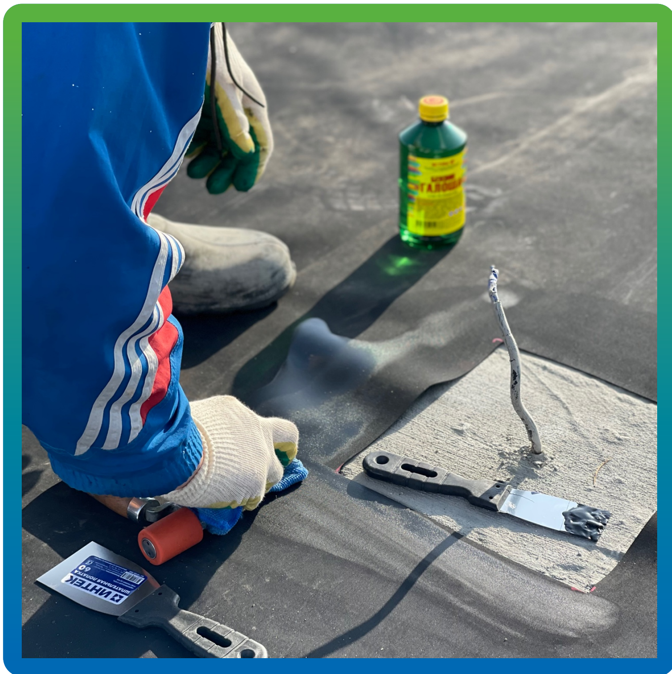
Обезжиривание поверхности перед герметизацией
