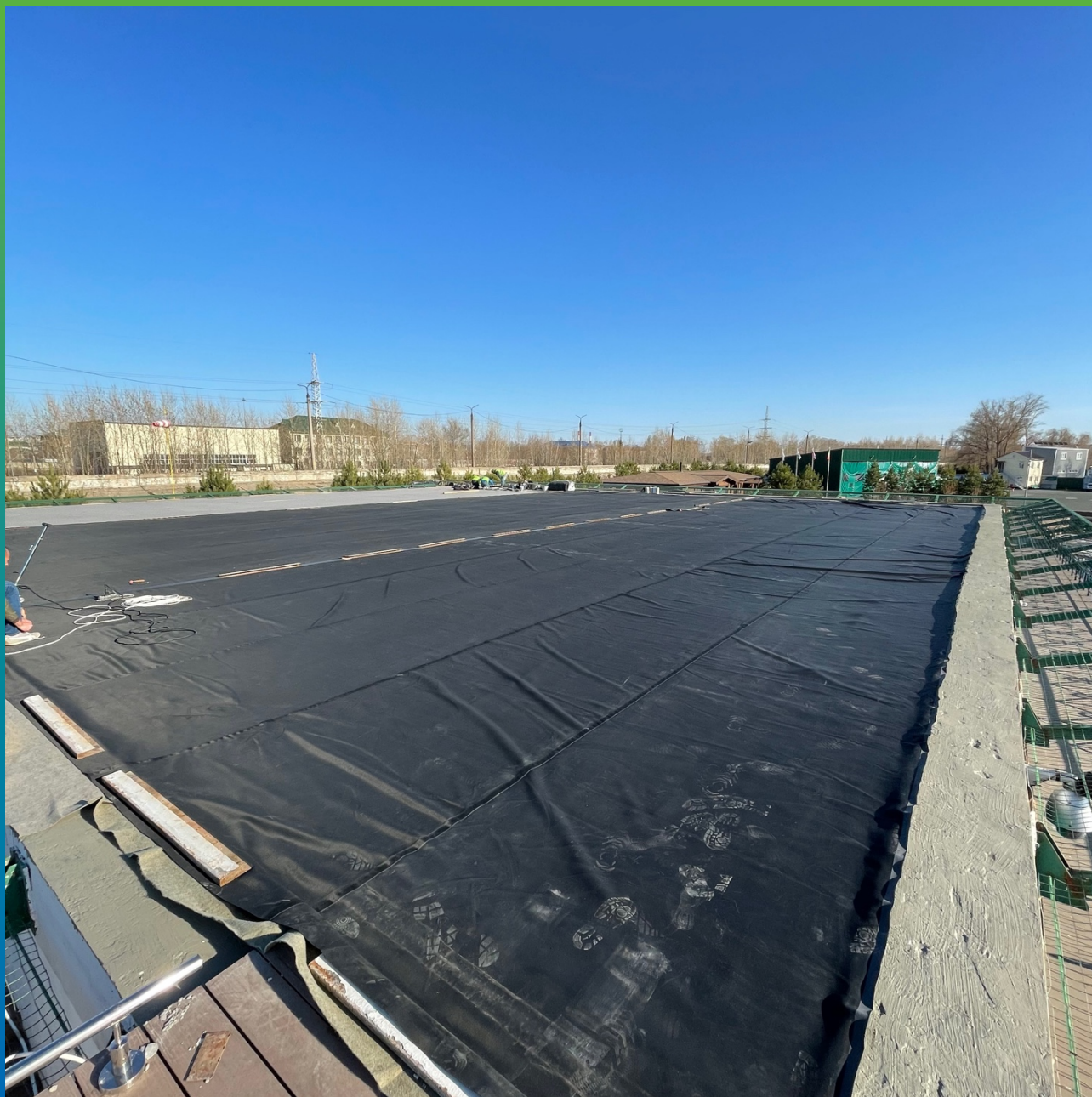
Полотна Прелести СТ, разложенные по всей площади
