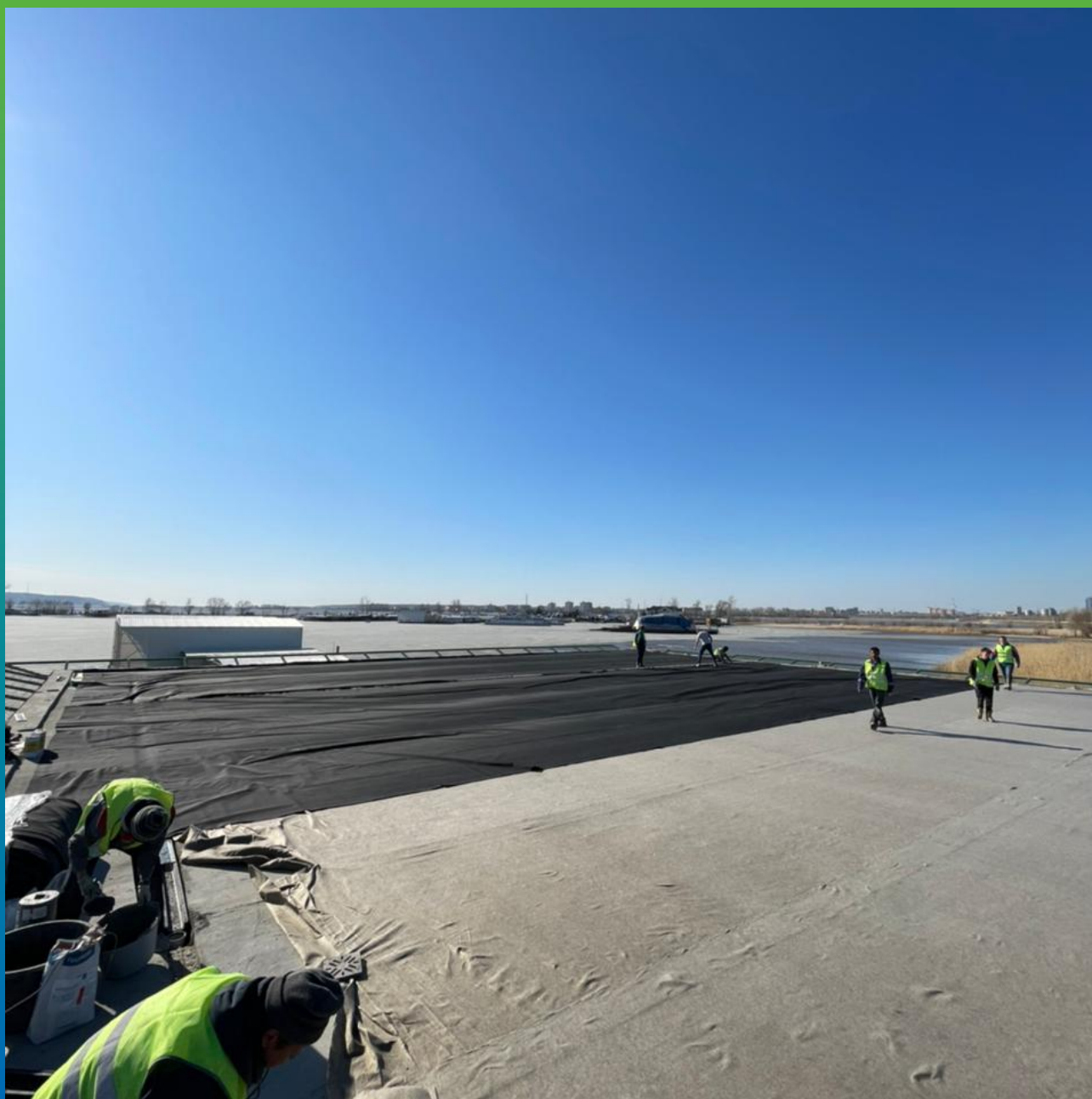
Укладка двух заранее изготовленных полотен мембраны Преласта СТ
