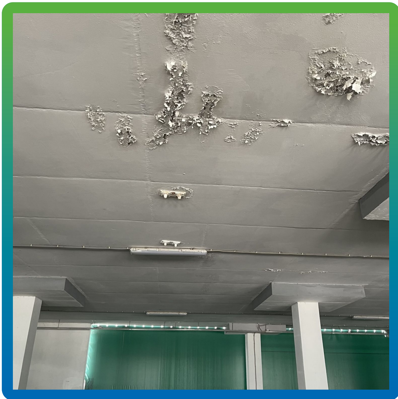
Проникновение воды в нижнюю часть вертолетной площадки
