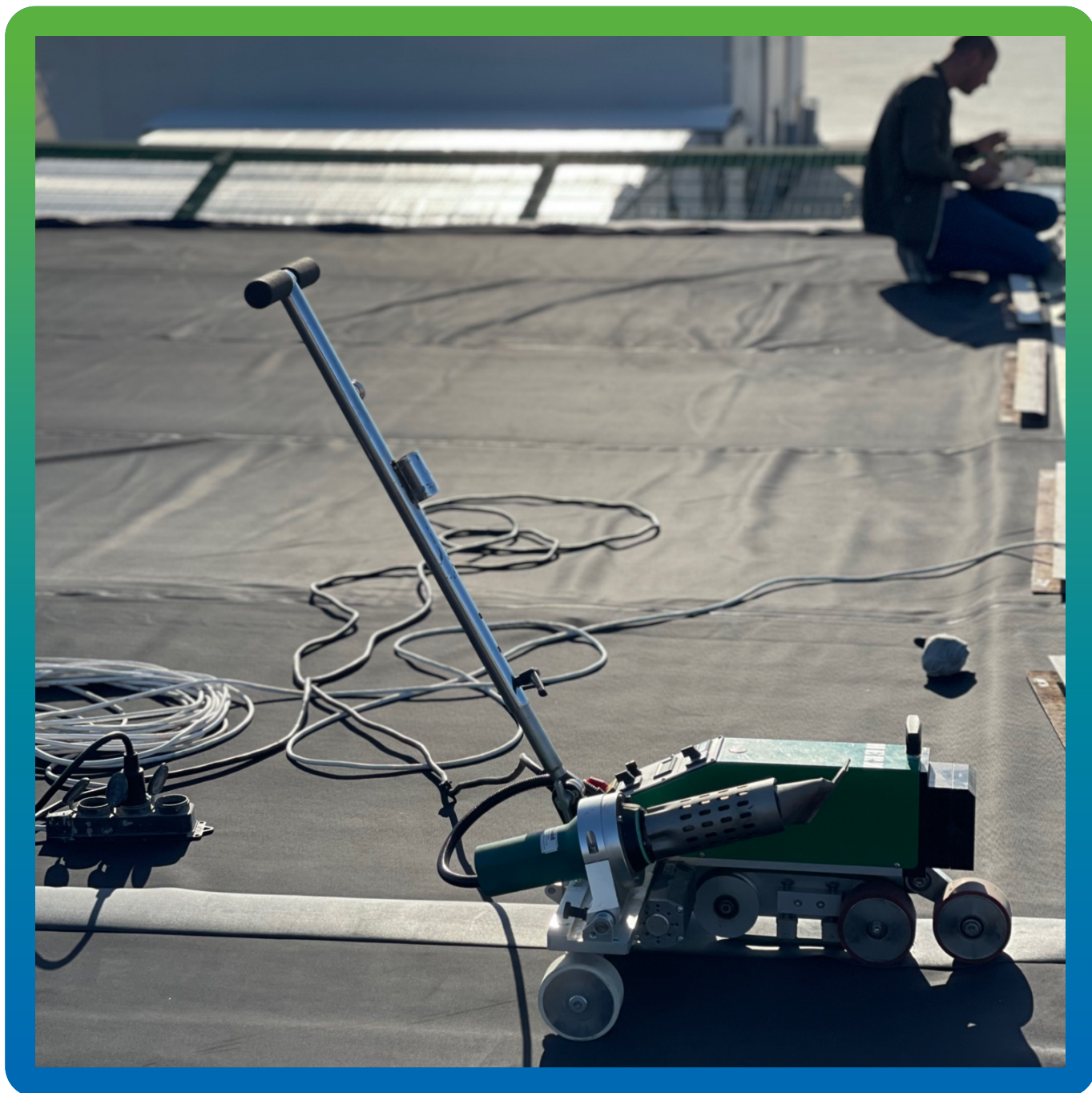
Аппарат для сварки полотен Leister Varimat
