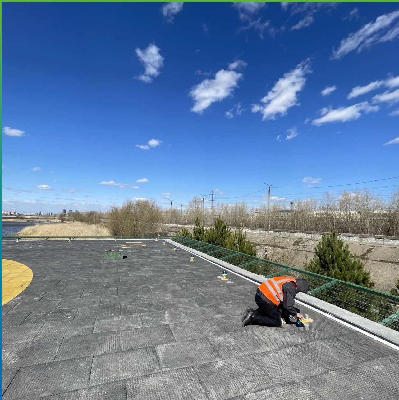
Установка сигнальных фонарей
