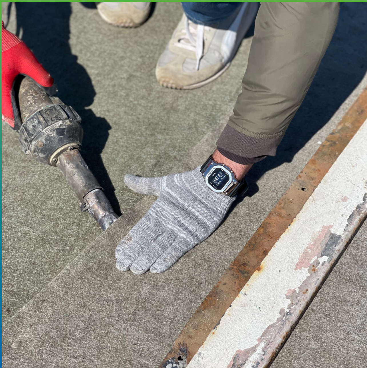
Сварка полотен геотекстиля между собой
