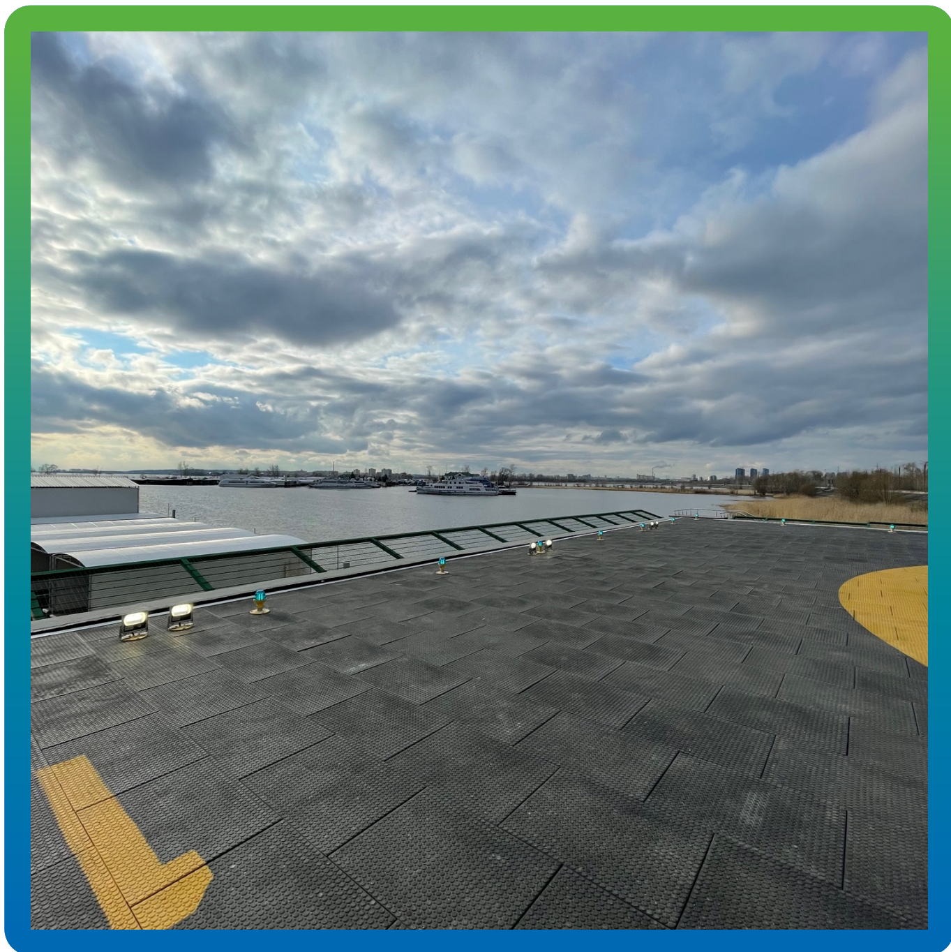
Финальный вид вертолетной площадки
