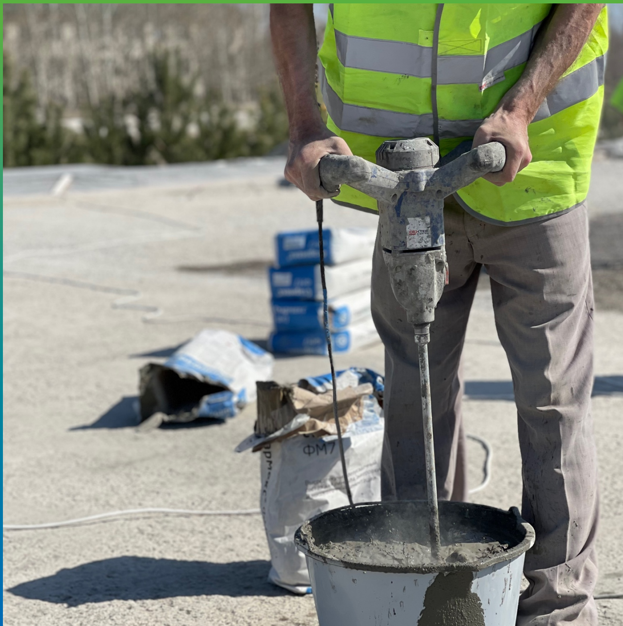
Замешивание состава Стармекс ФМ7
