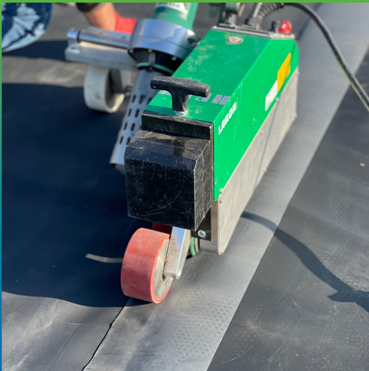
Сварка полотен с помощью Термобонд
