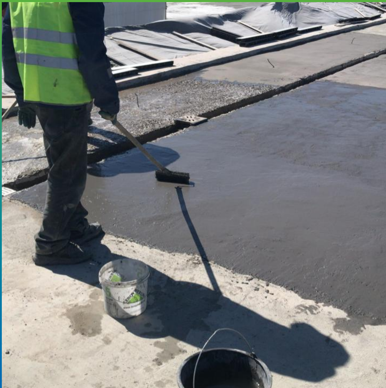
Выравнивание Стармекс ФМ7 игольчатым валиком
