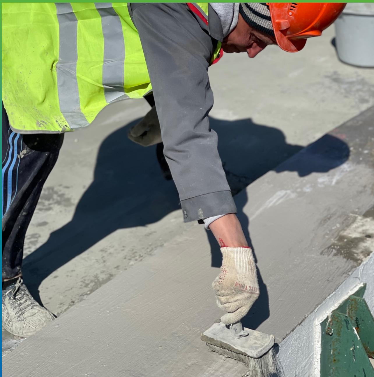
Нанесение состава Стармекс Сил Флекс по бортам вертолетной площадки
