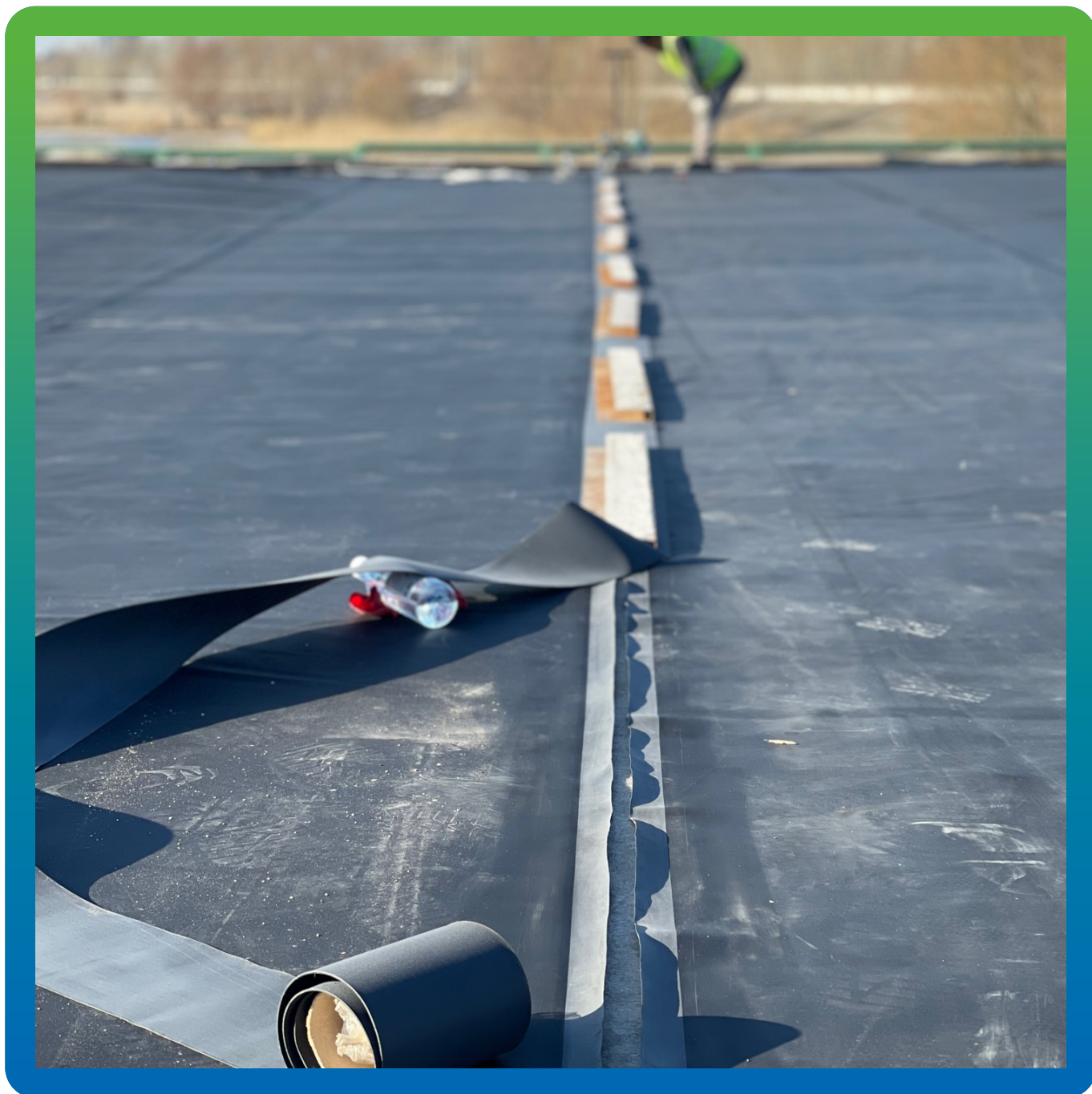
Центровка полотен и подготовка к сварке на Термобонд
