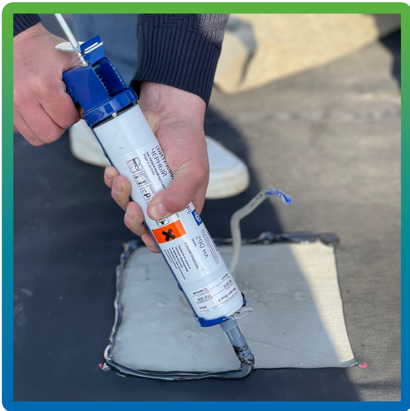
Герметизация отверстий с помощью герметика Манодил Бонд Ф
