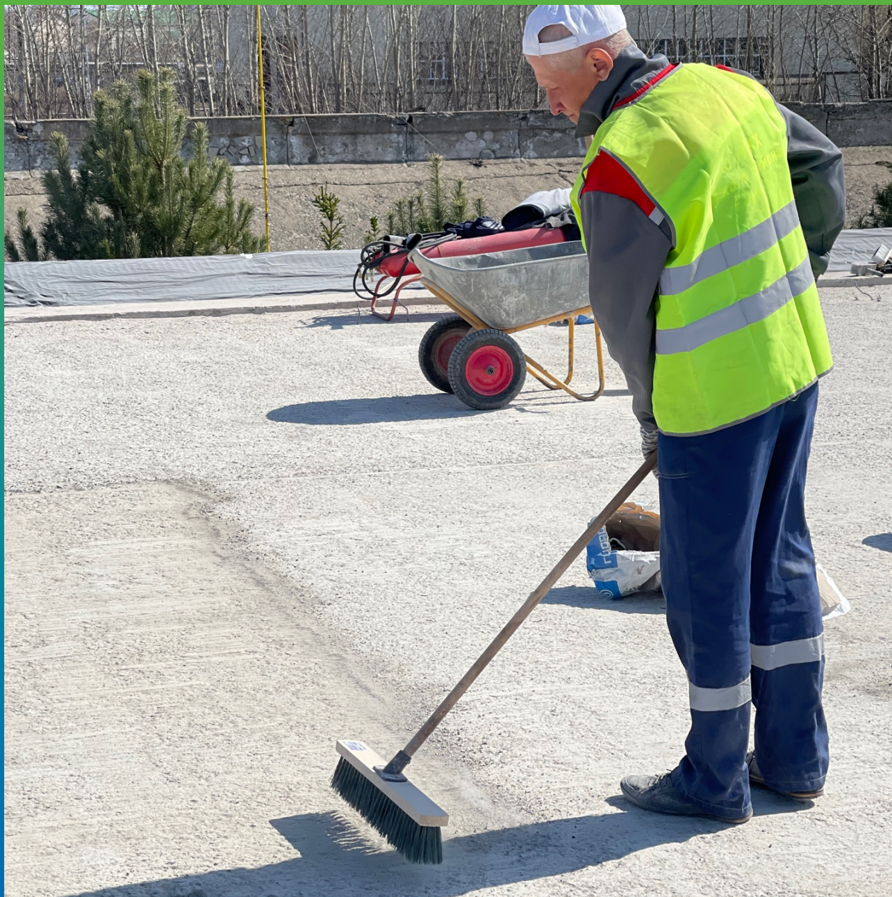
Очистка поверхности после фрезерования
