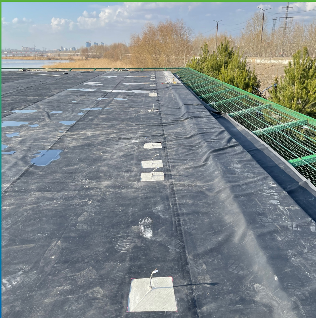
Места установки сигнальных фонарей
