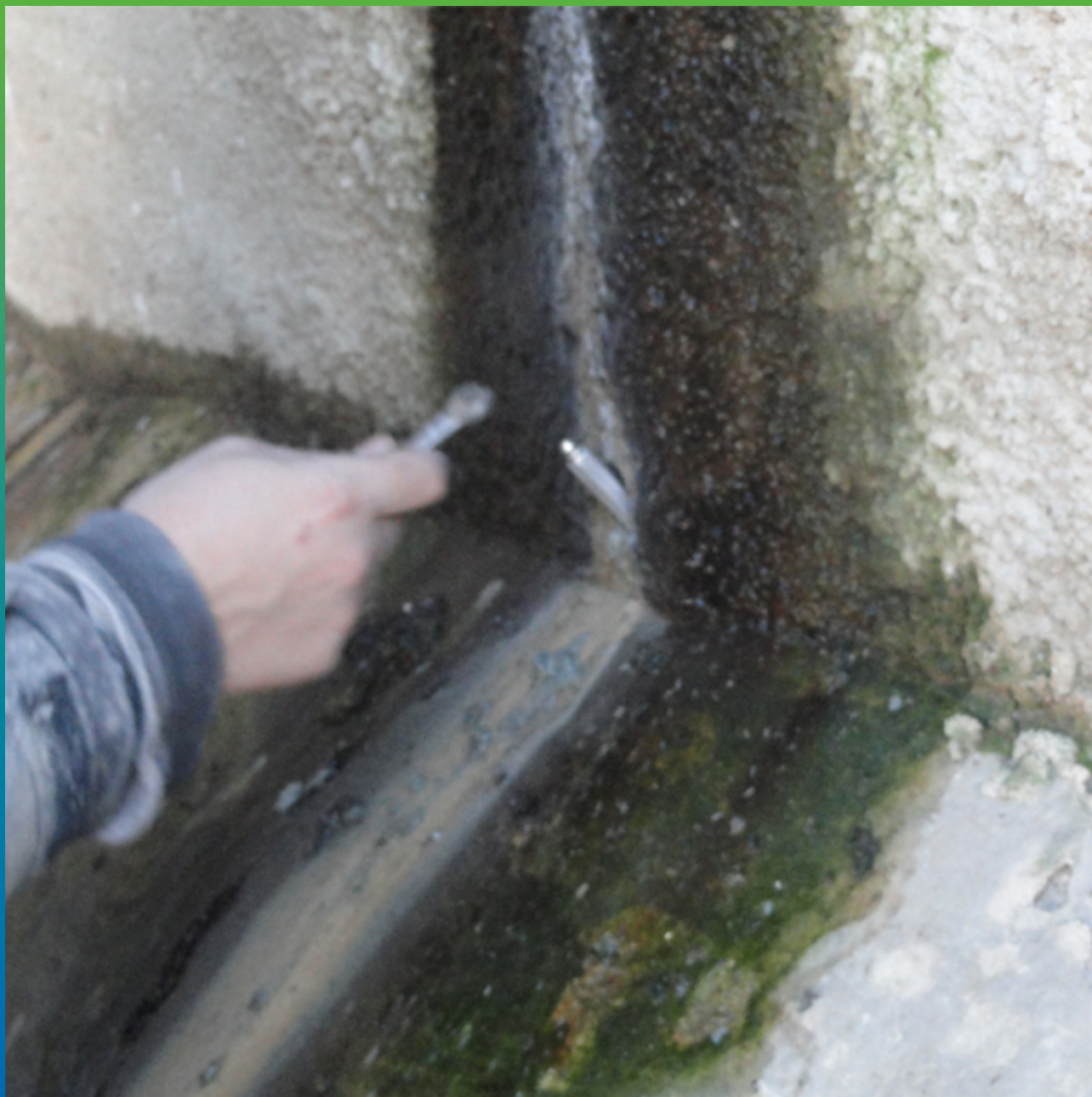
Закрепление инъекционных пакеров
