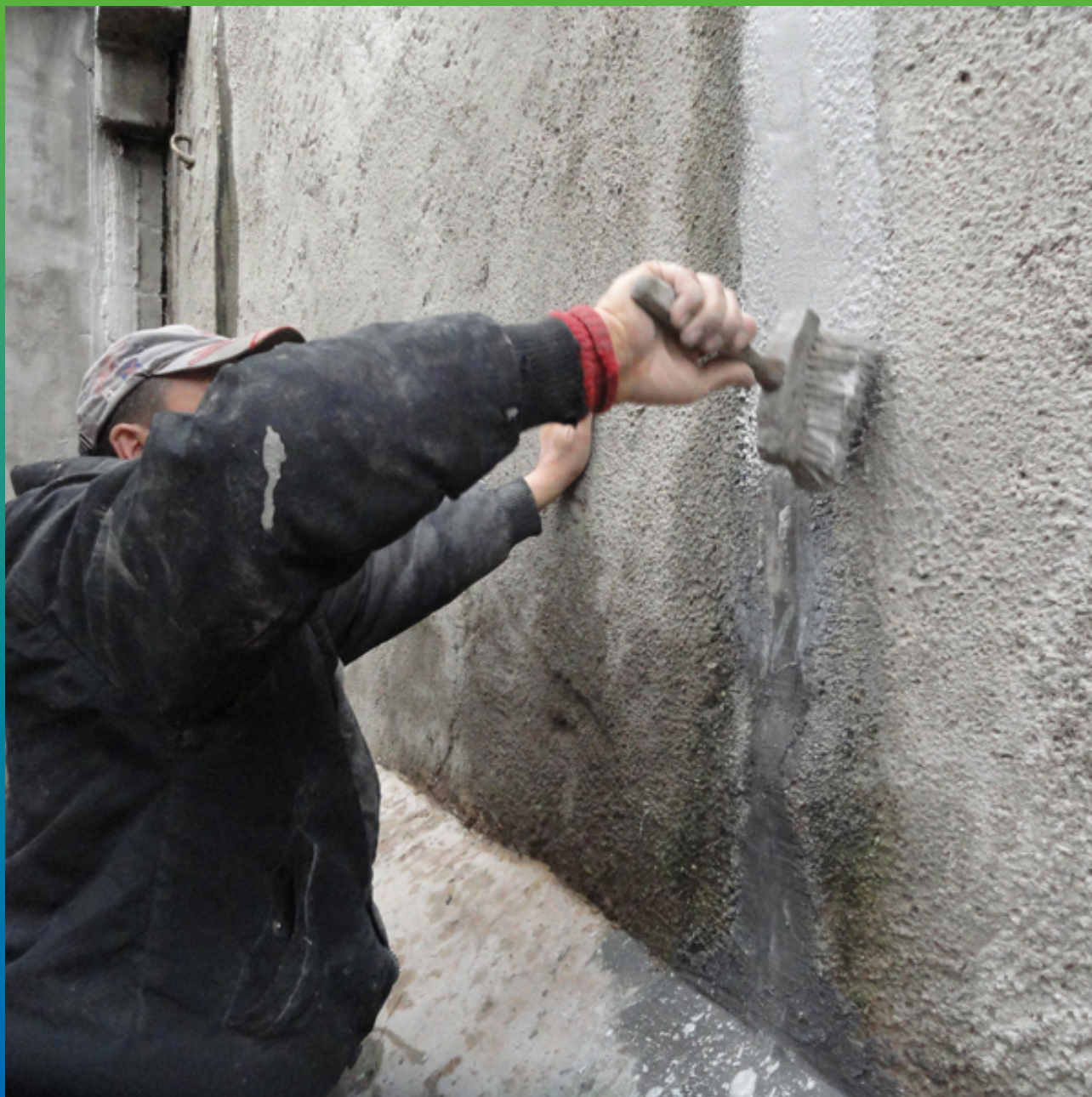
Нанесение эластичной гидроизоляции Максил Флекс
