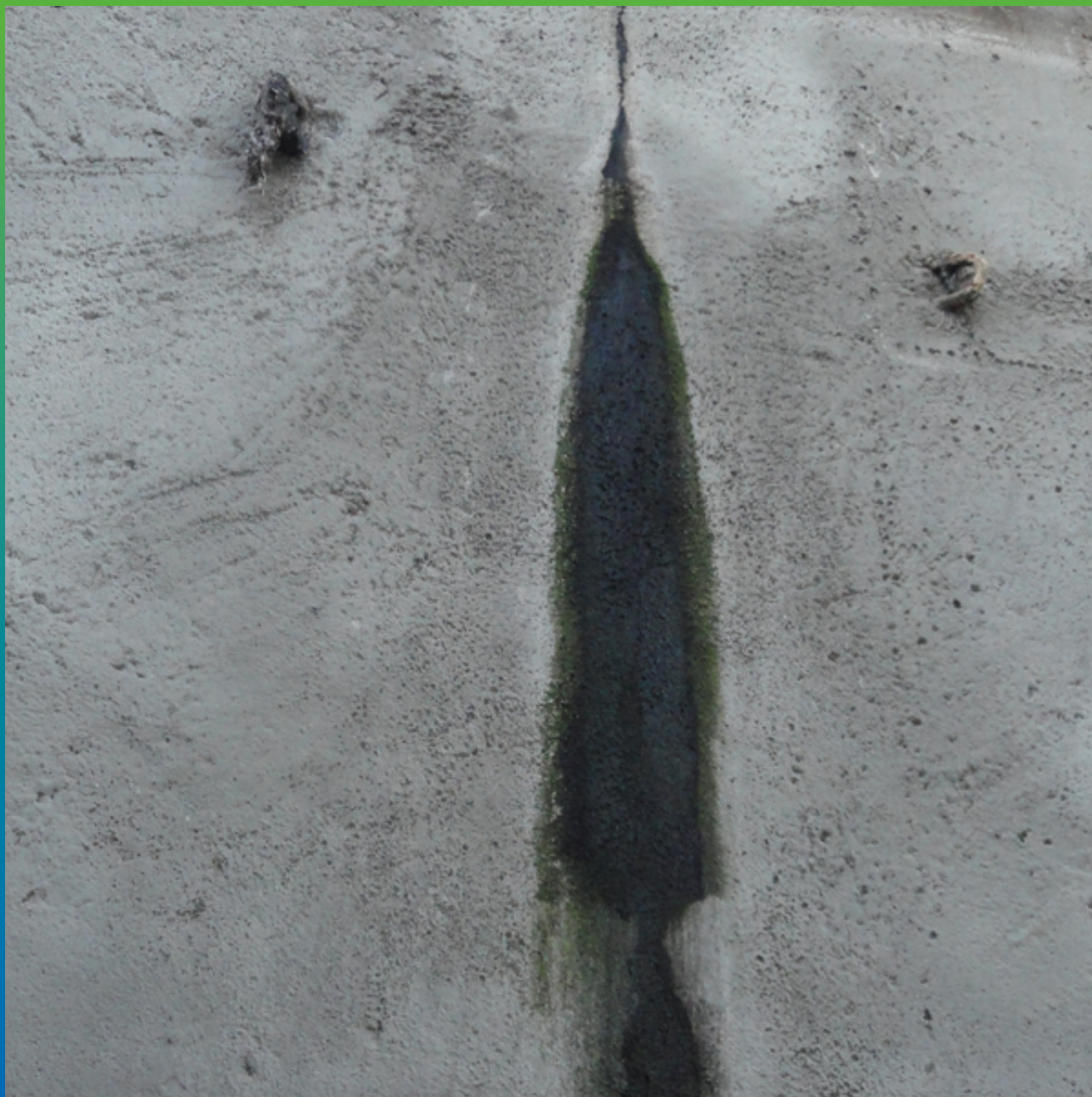
Фильтрующий шов до начала работ
