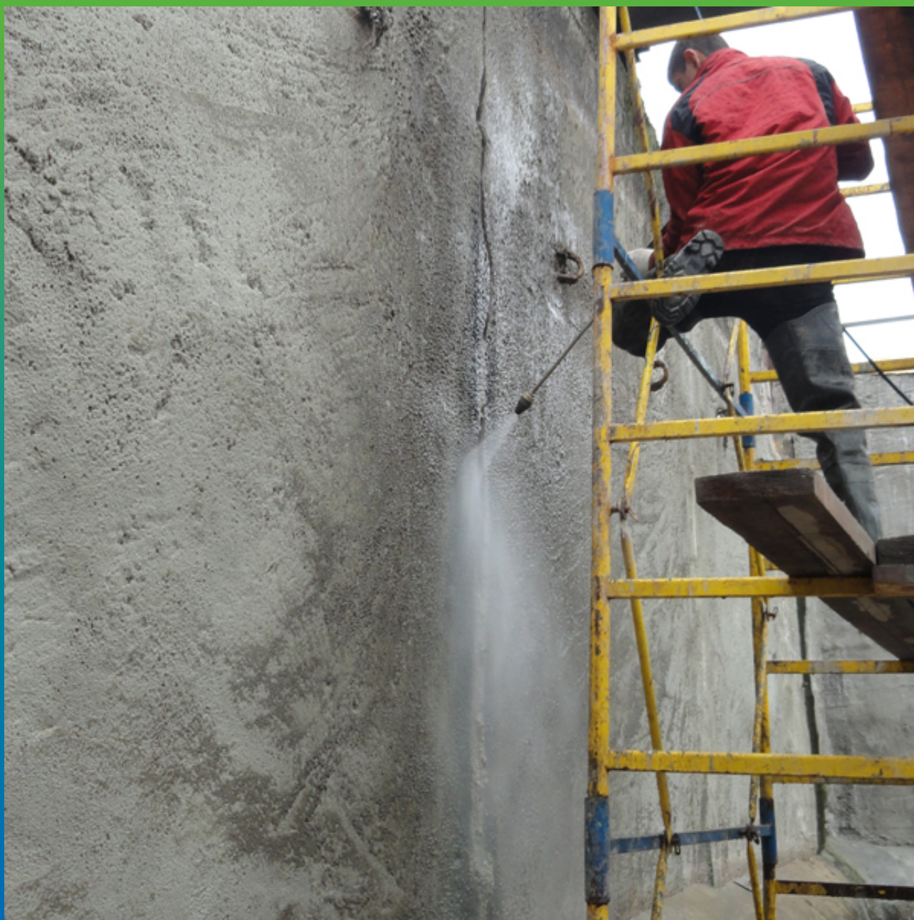
Очистка шва водой аппаратом высокого давления
