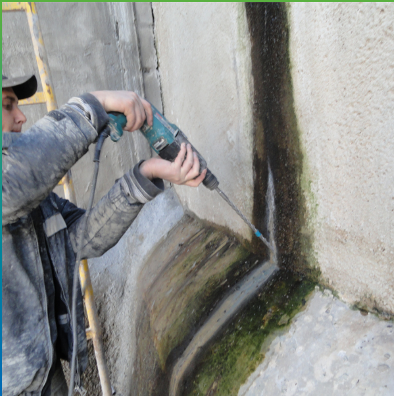
Подготовка инъекционных шпуров
