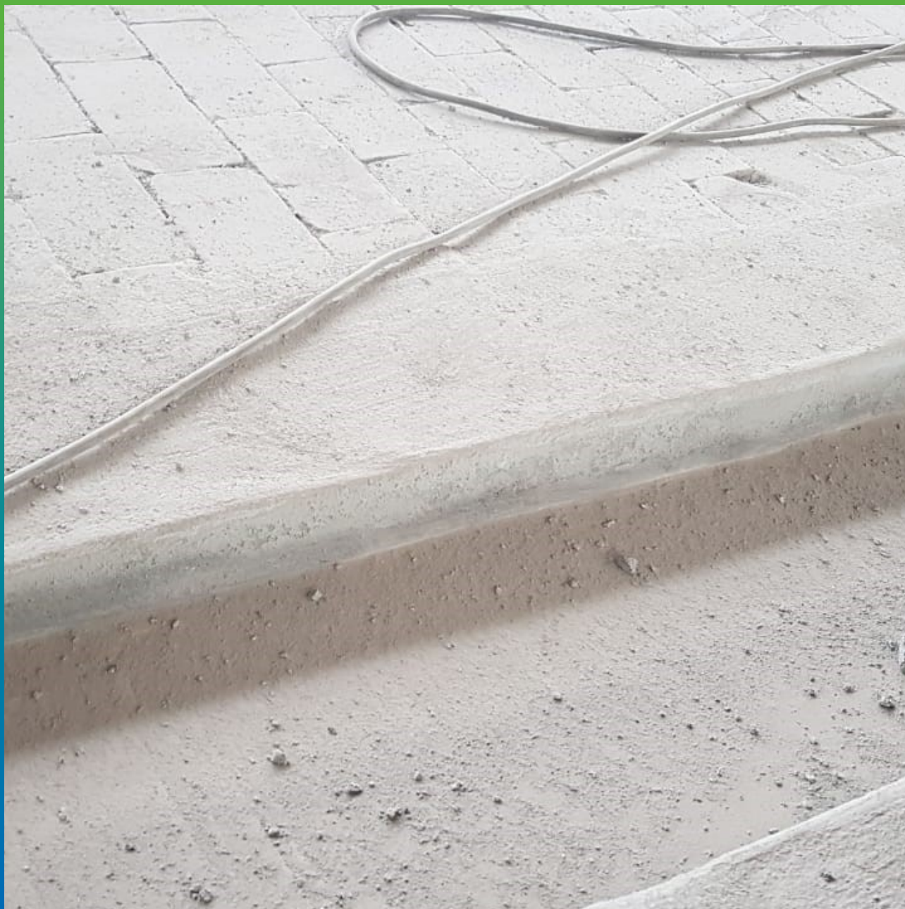
Лотки, отремонтированные высокопрочным безусадочным составом Стармекс РМЗ
