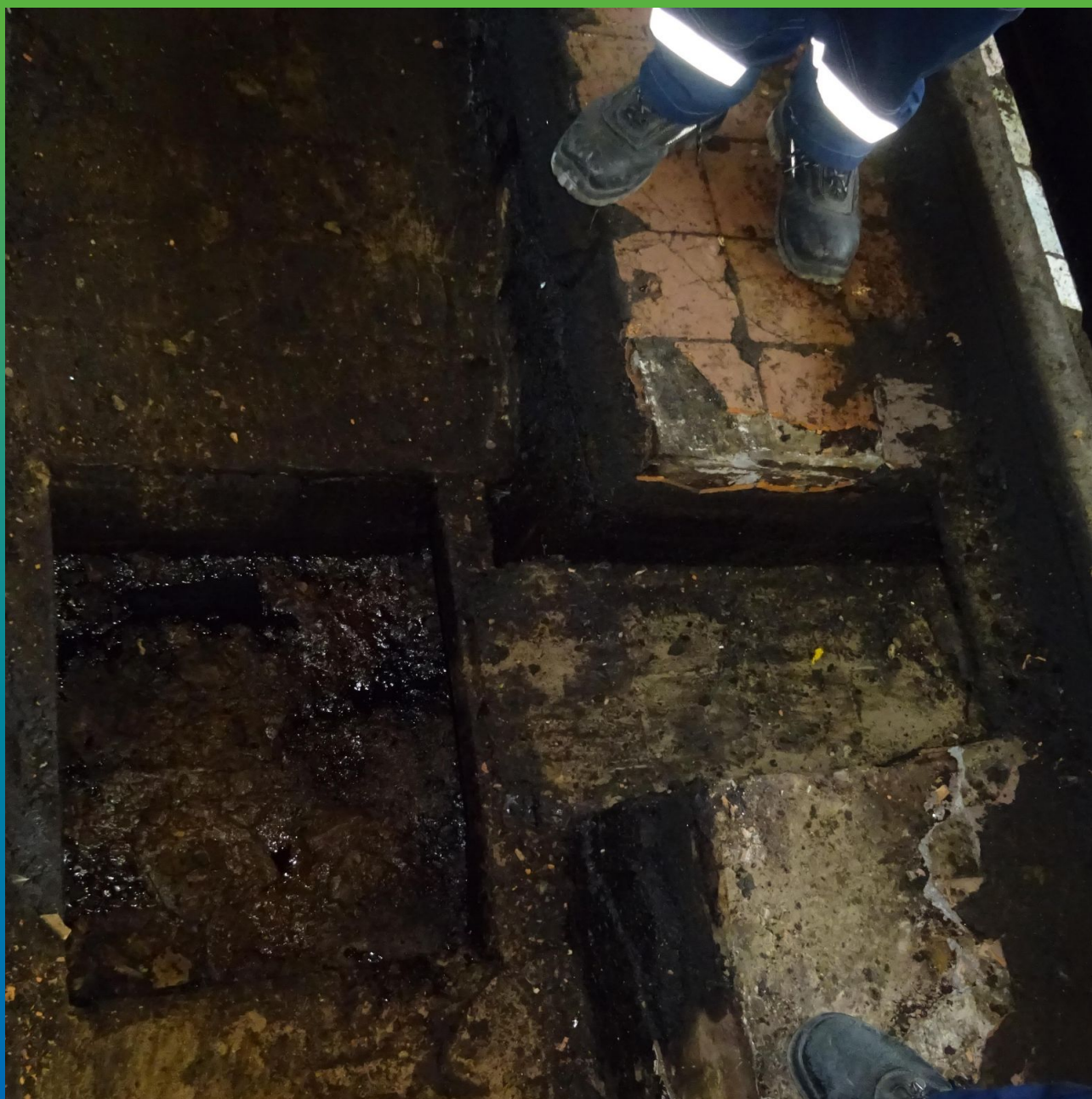
Состояние основания до начала работ
