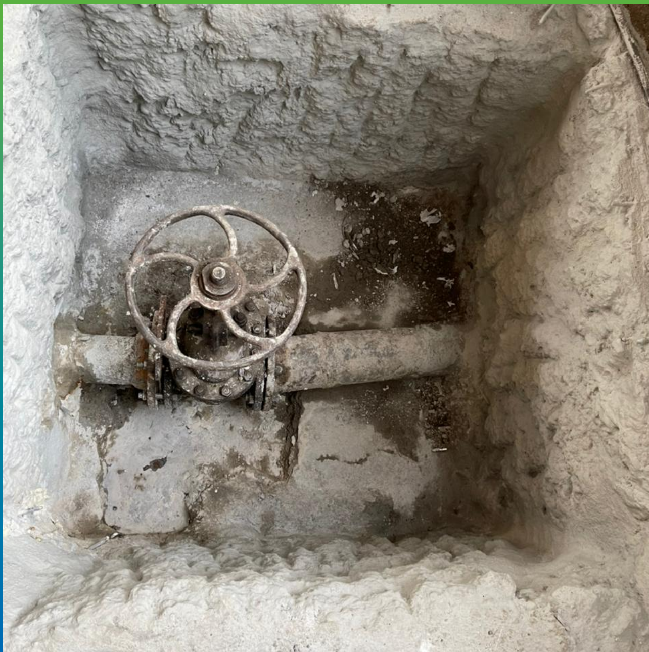
Гидроизолированные прямки, готовые к ремонтным работам
