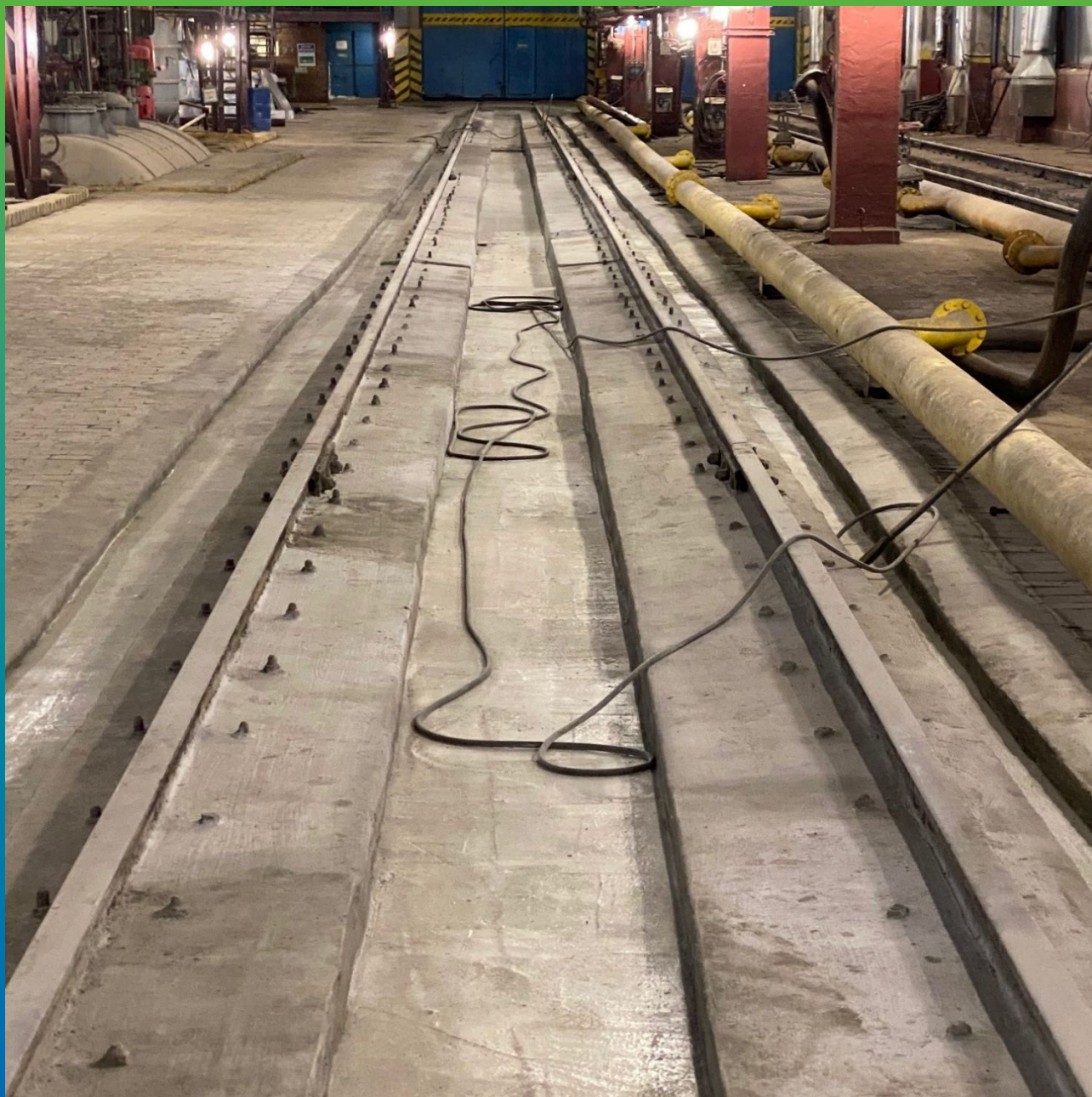
Лотки, отремонтированные высокопрочным безусадочным составом Стармекс РМЗ
