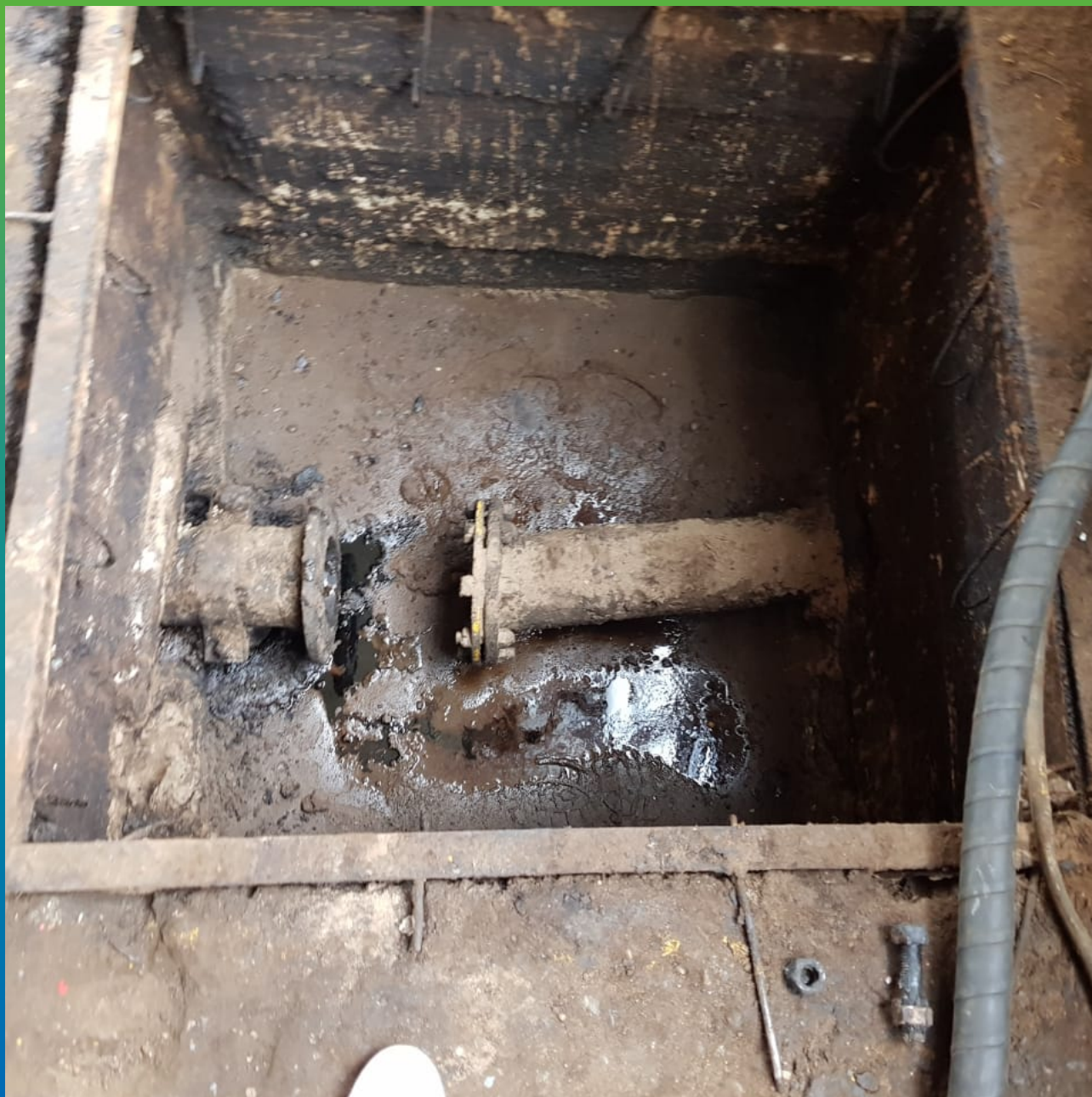
Состояние основания до начала работ
