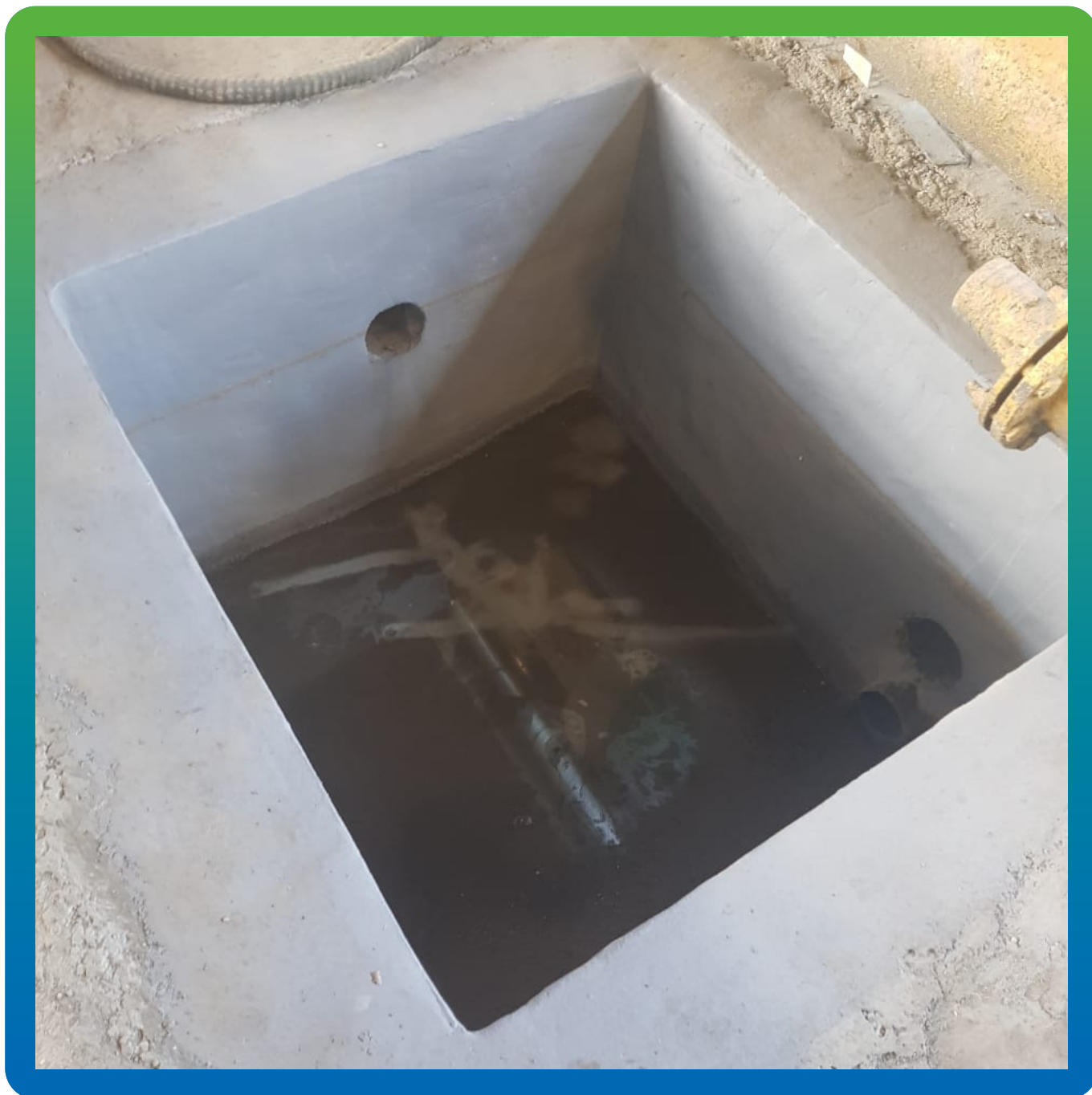
Внешний вид объекта после проведения работ
