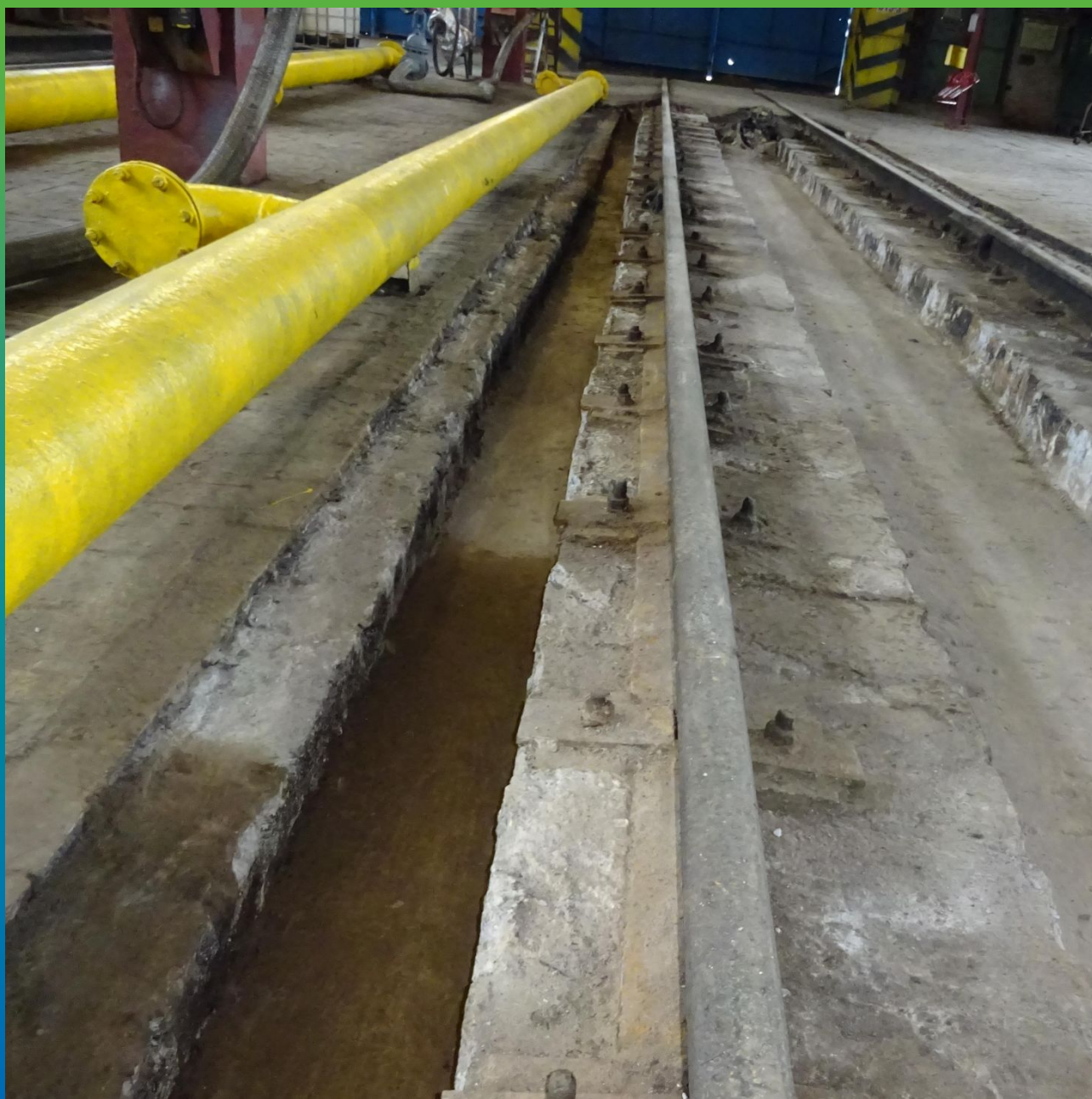
Основание, очищенное от существующего покрытия.
