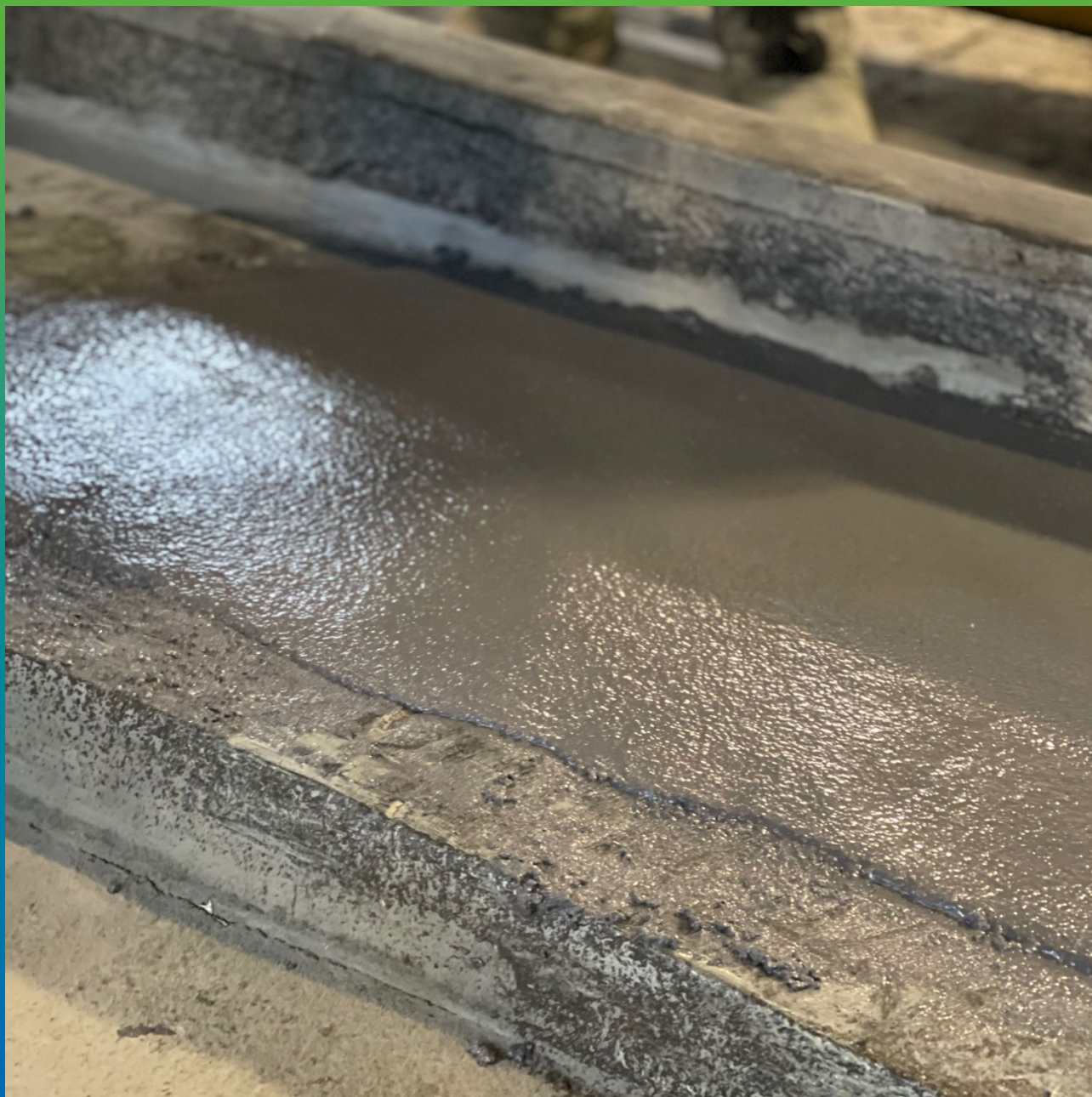
Нанесение защитного цементно-полиуретанового состава ДенсТоп ПМ 605 ФК на основание лотков
