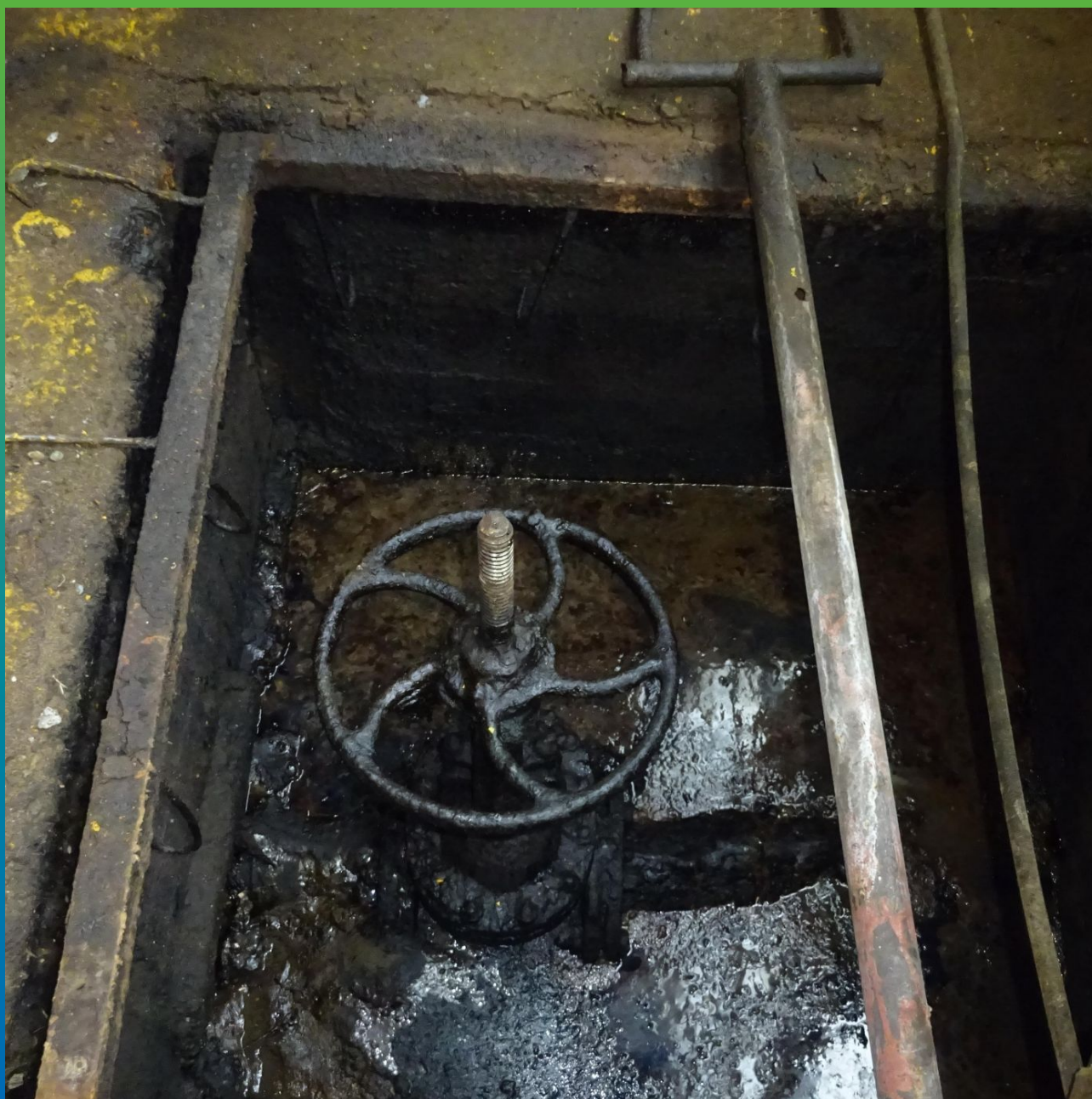
Состояние основания до начала работ
