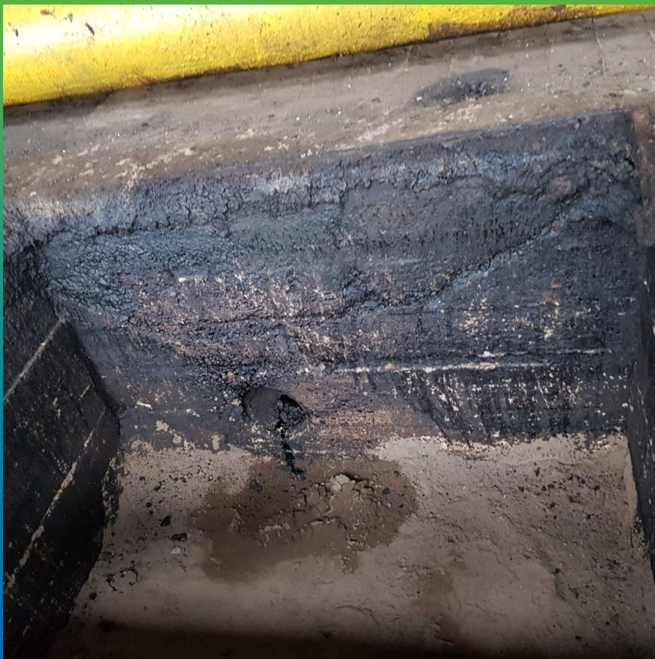
Состояние основания до начала работ
