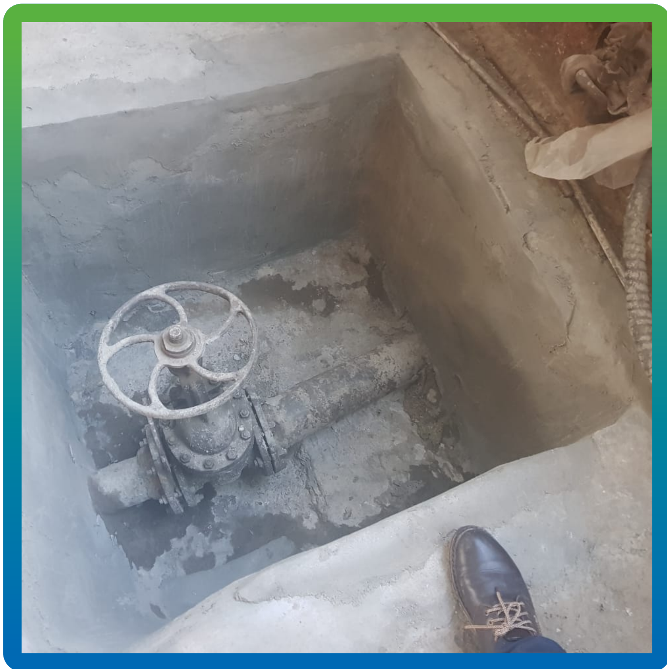
Приямки, подготовленные к ремонту наливным составом Стармекс ФМ7
