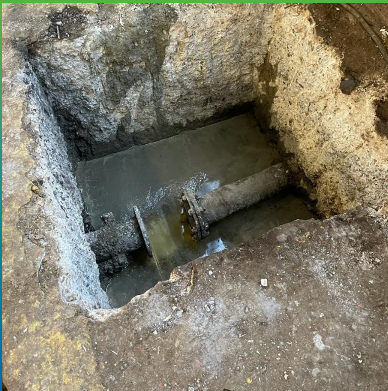
Подготовленные к гидроизоляции и ремонту приямки
