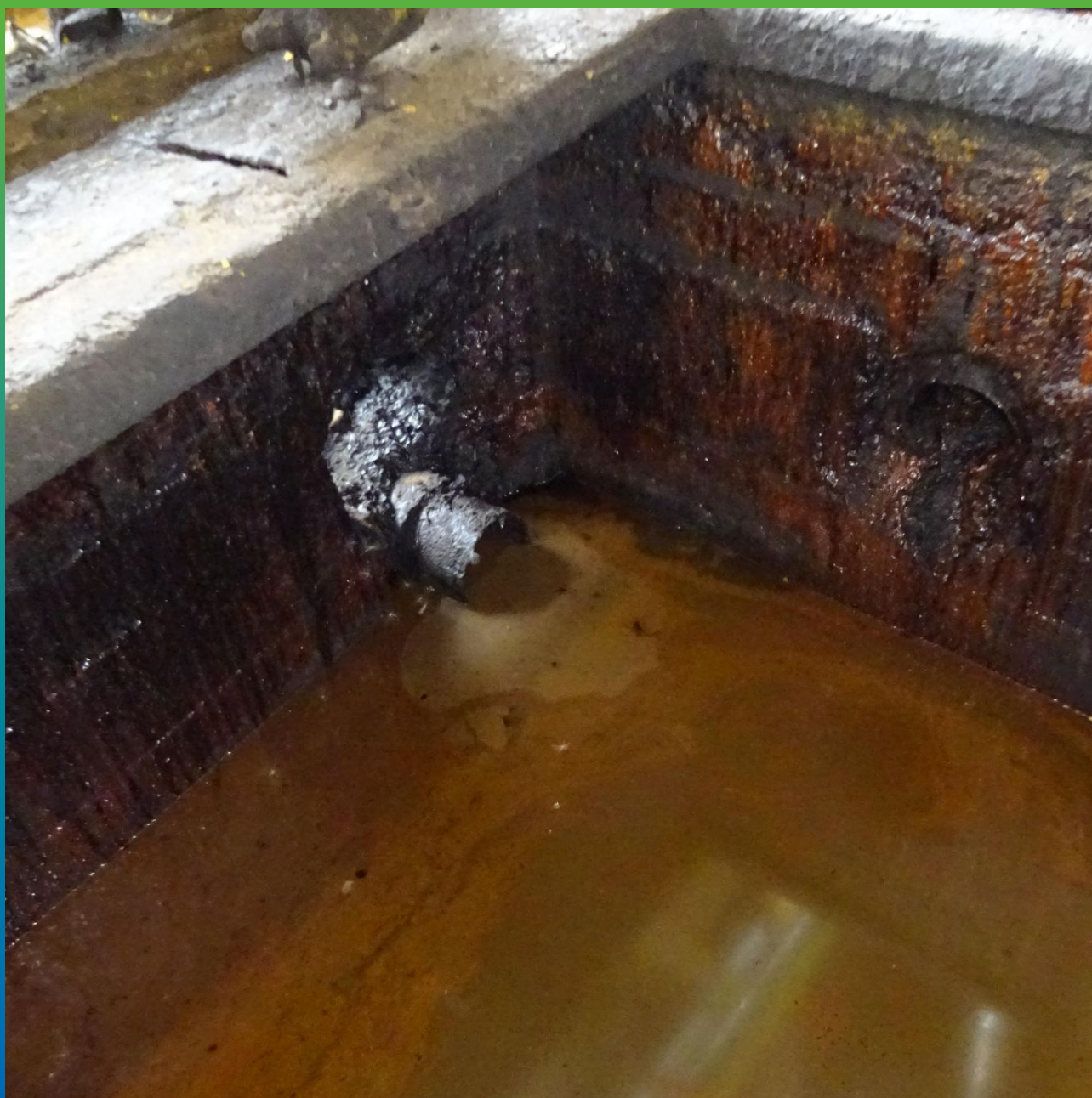
Состояние основания до начала работ
