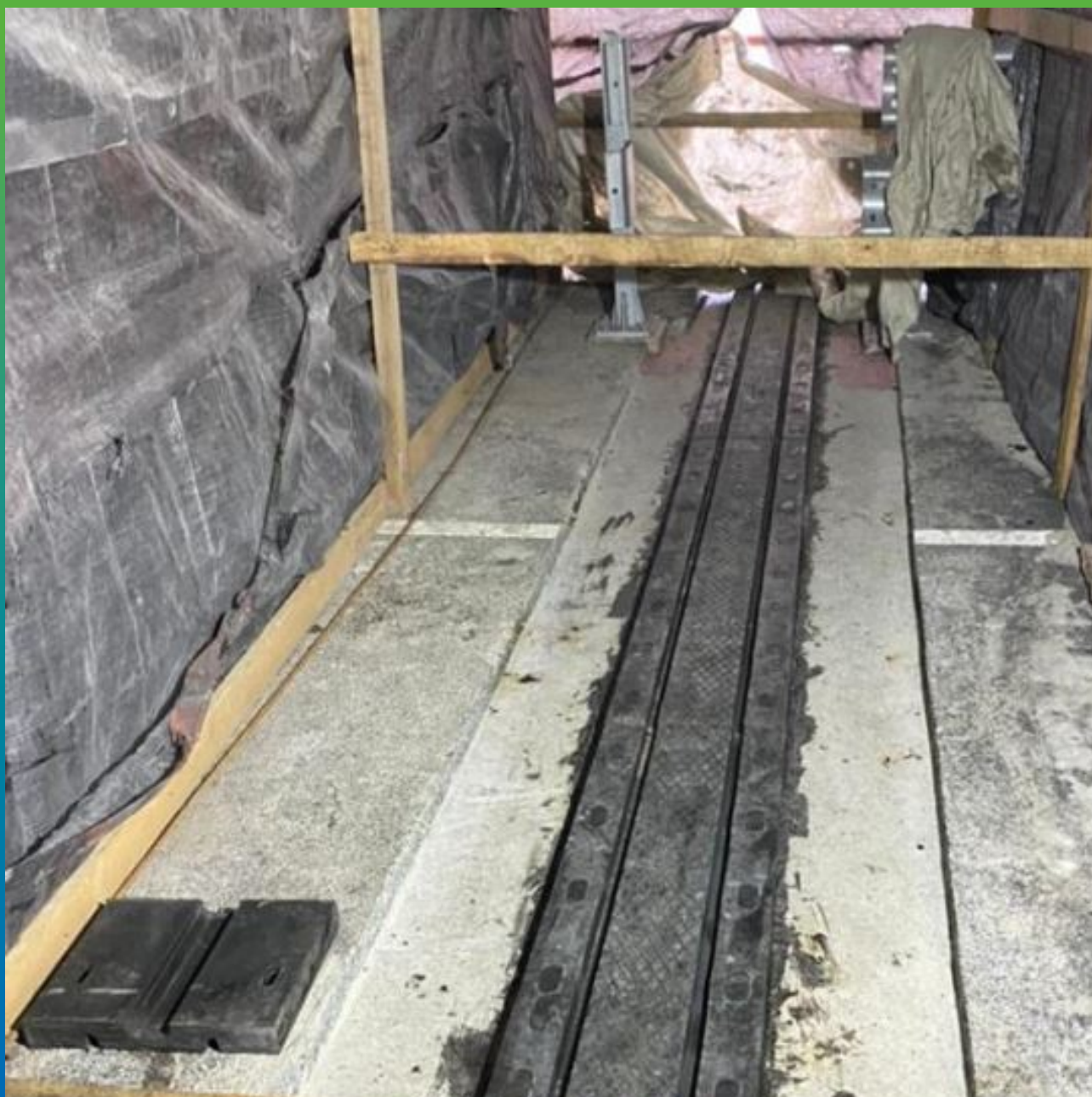
Штроба для укладки Манопур 336
