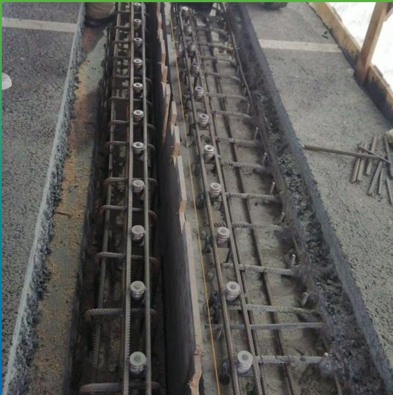
Установка креплений для монтажа деформационного шва
