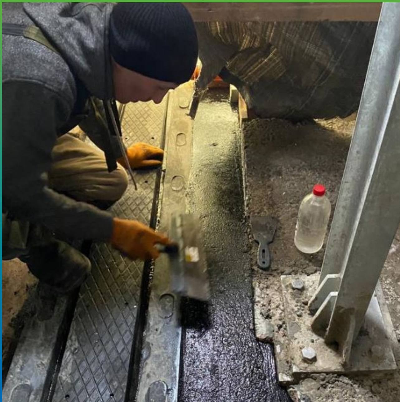
Укладка готового трехкомпонентного состава Манопур 336
