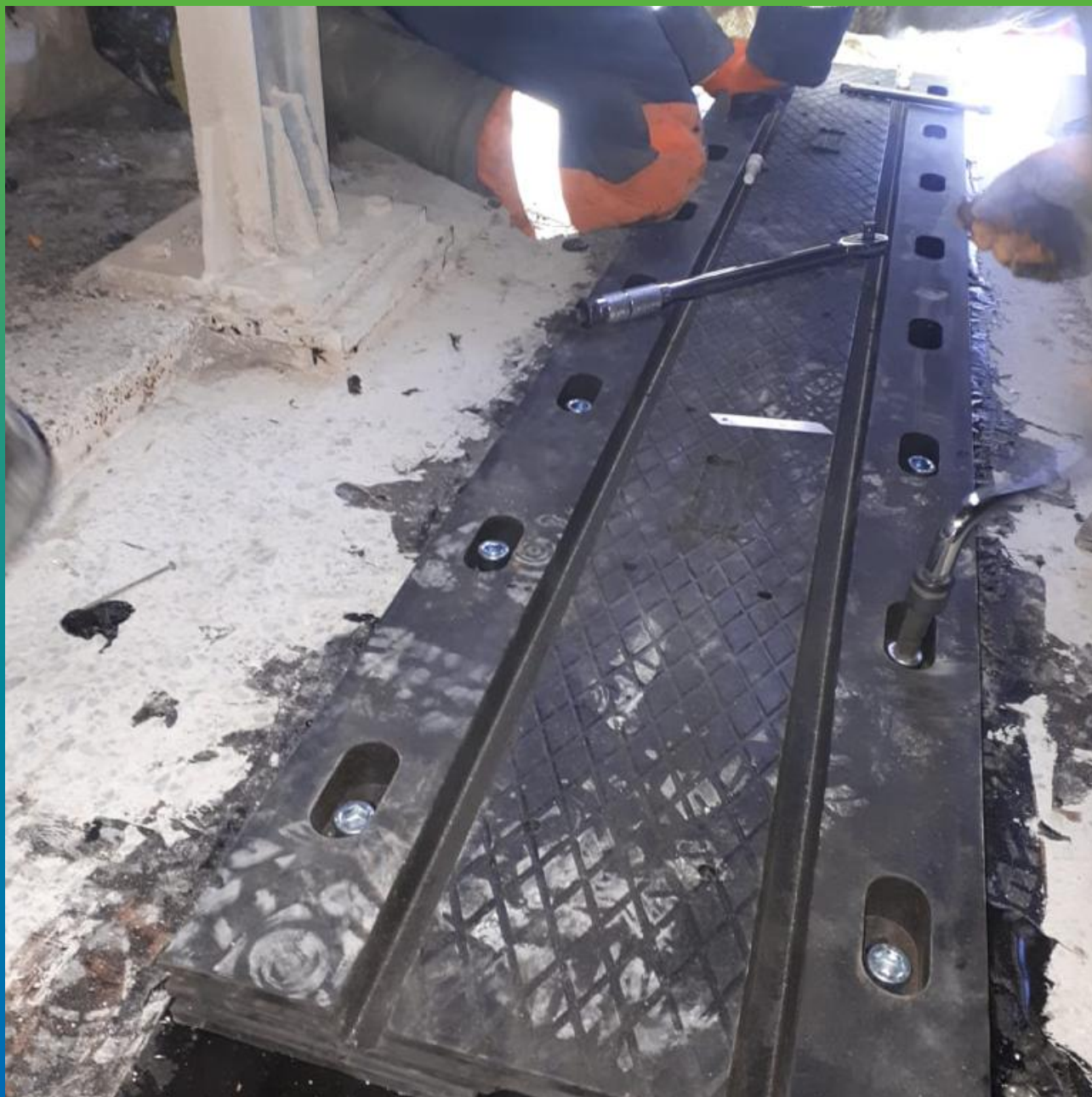
Монтаж резино-металлического деформационного шва
