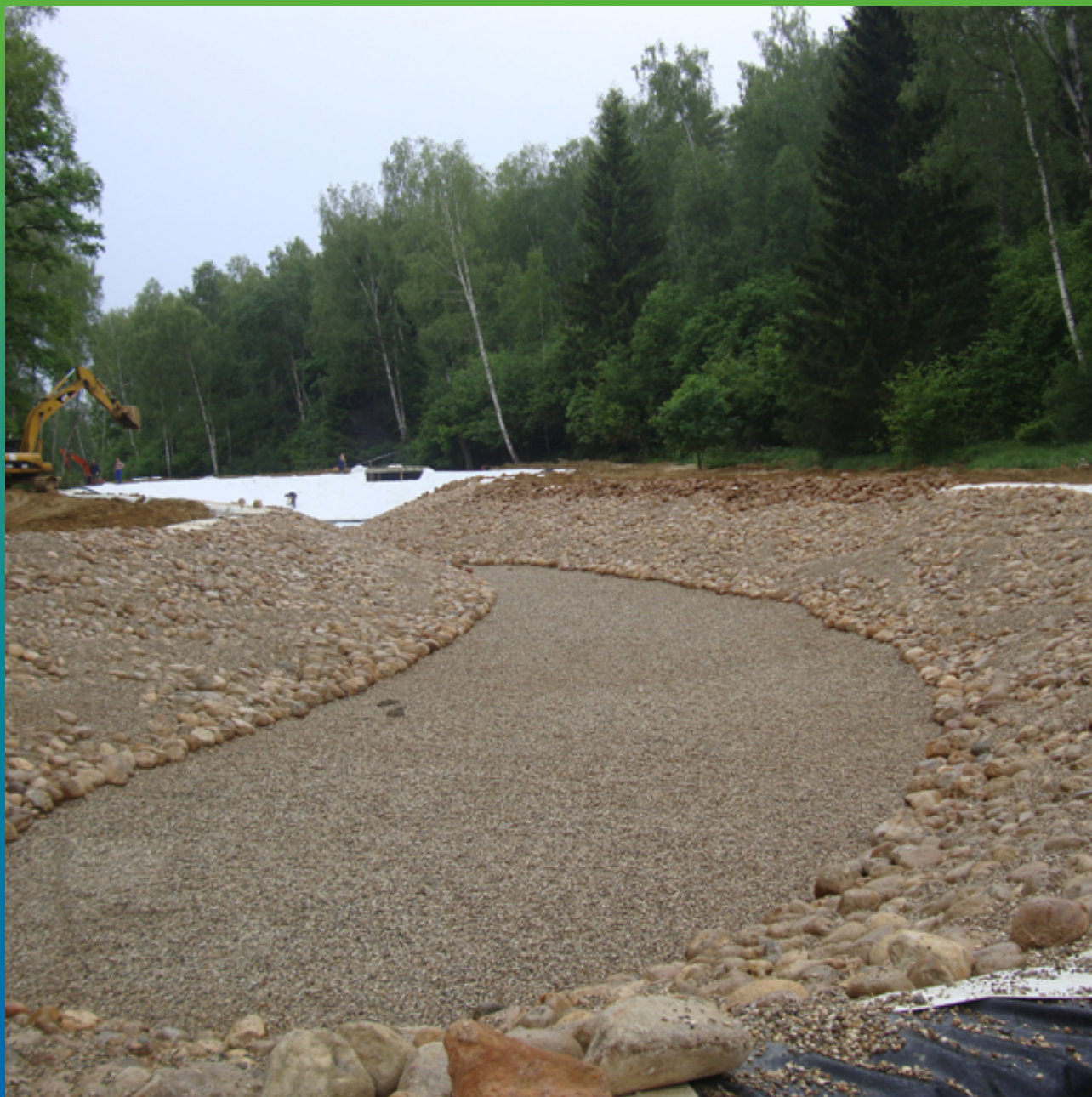
Устройство декоративного камня
