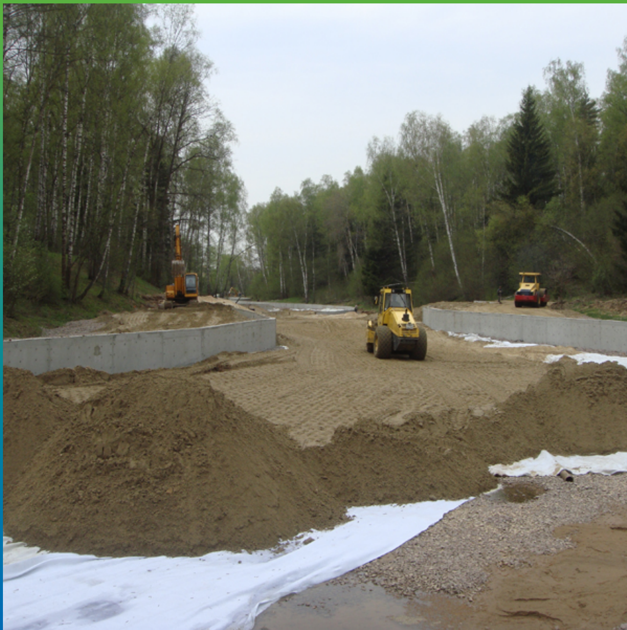
Устройство и выемка грунта котлована
