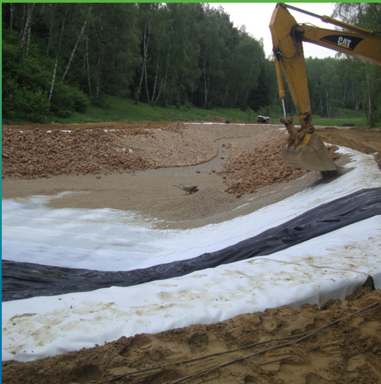
Устройство защитного слоя геотекстиля и укладка щебня
