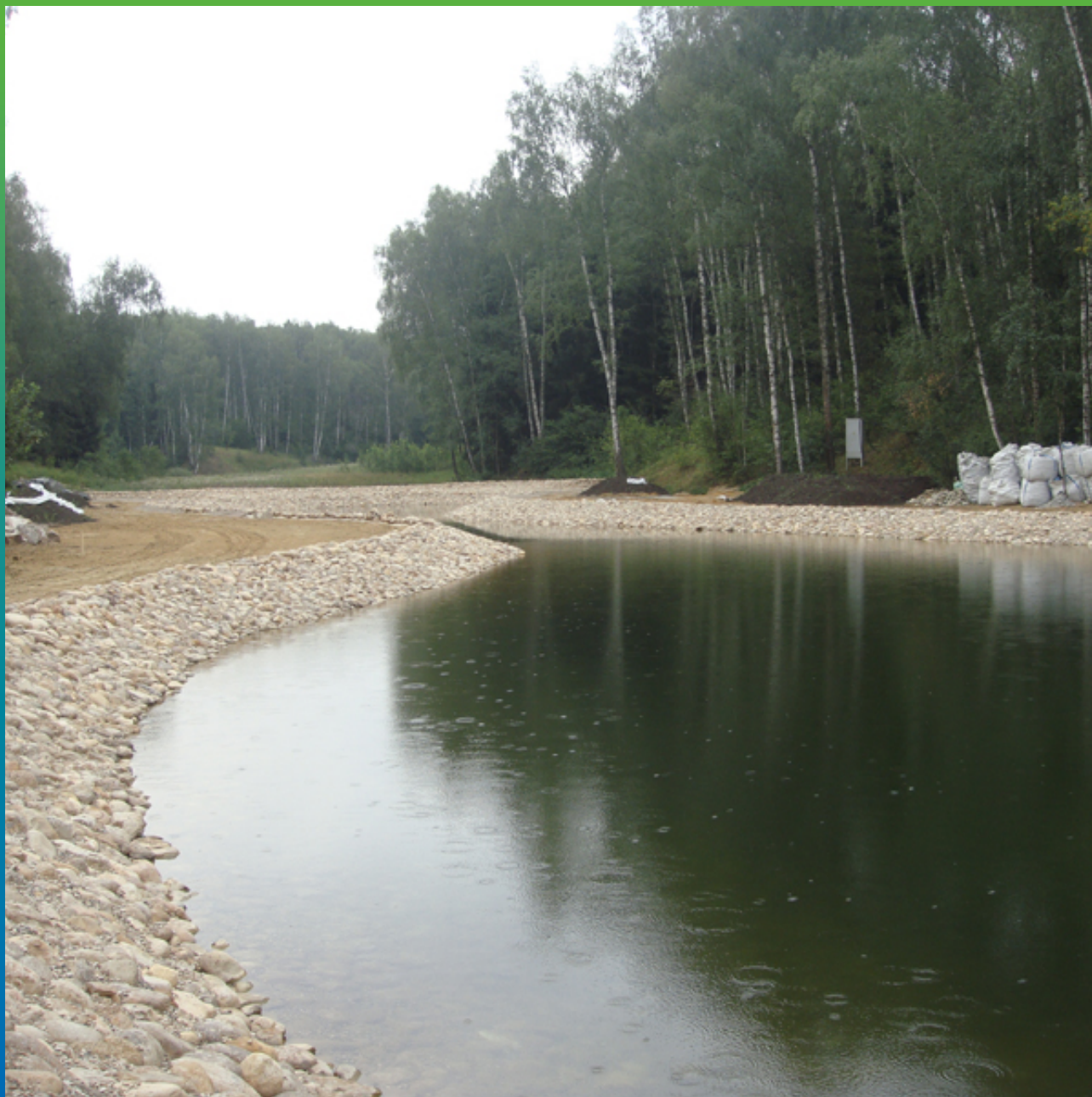
Заполнение чаши водоема водой
