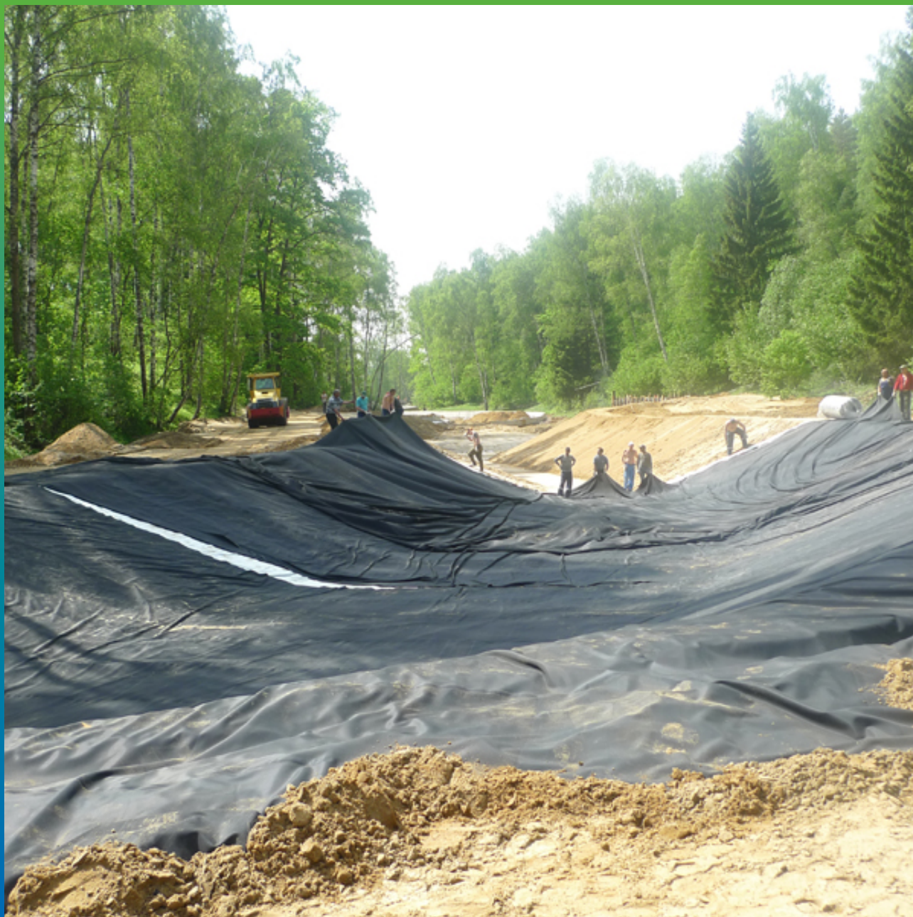
Укладка ЭПДМ мембраны Эластосил Т 1,2 мм
