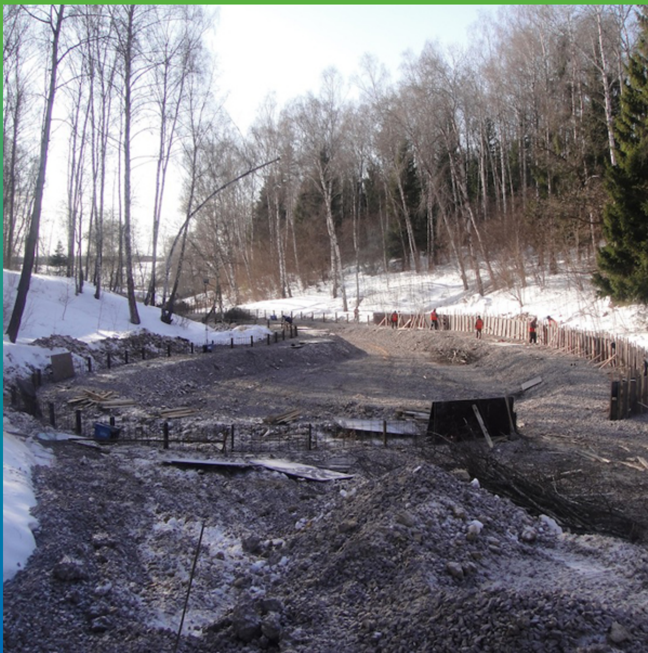
Устройство бетонных стен водоема
