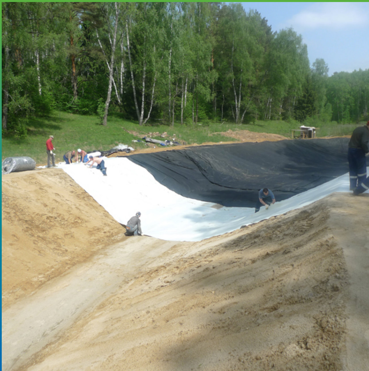
Укладка геотекстиля (подстилающий слой)
