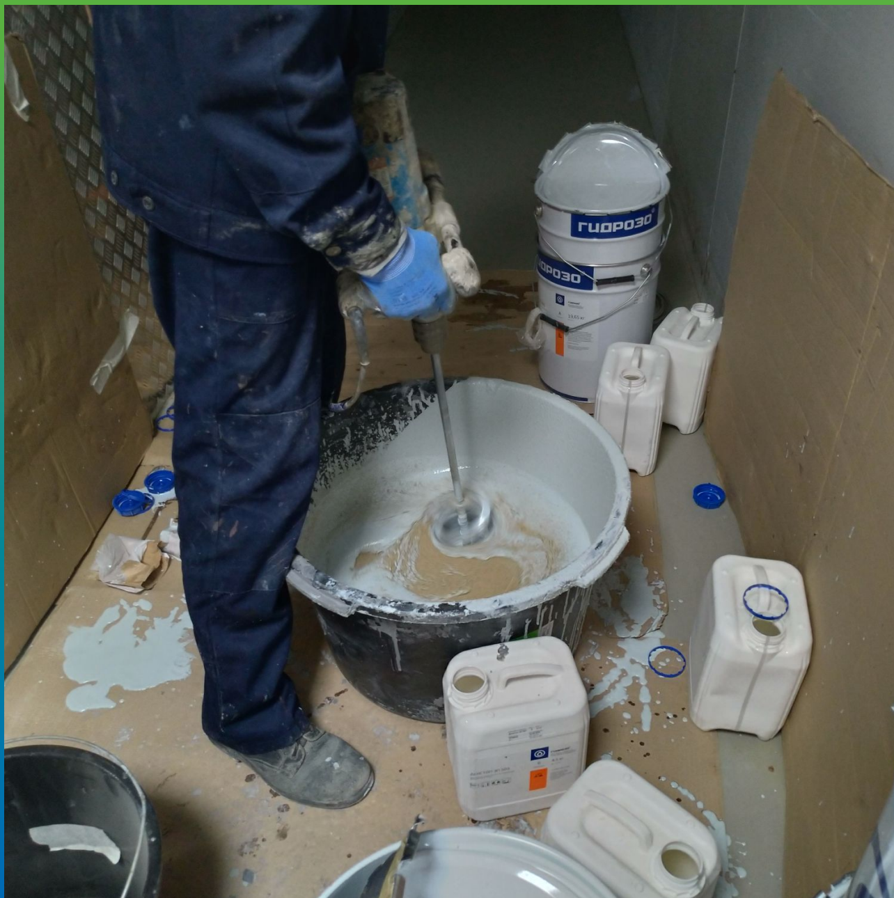
Устройство финишного покрытия колерованным, эпоксидным составом ДенсТоп ЭП 500
