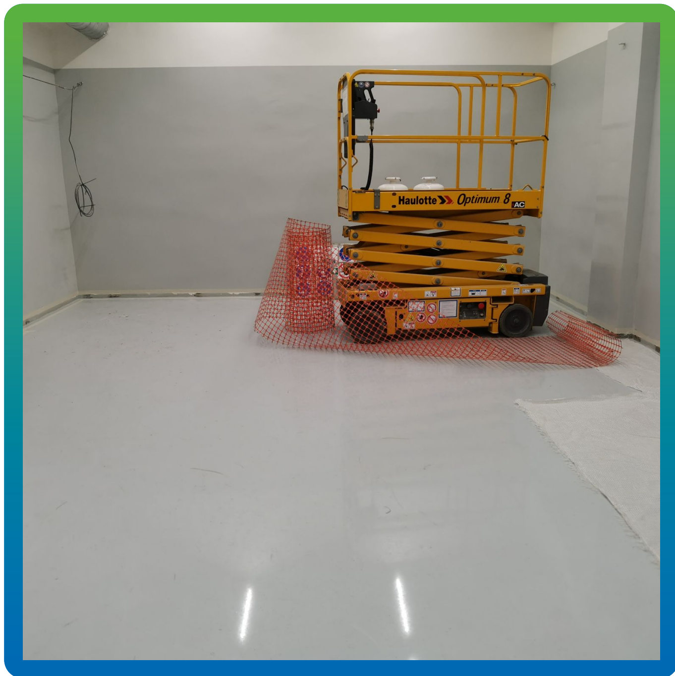
Вид покрытия после финишной заливки
