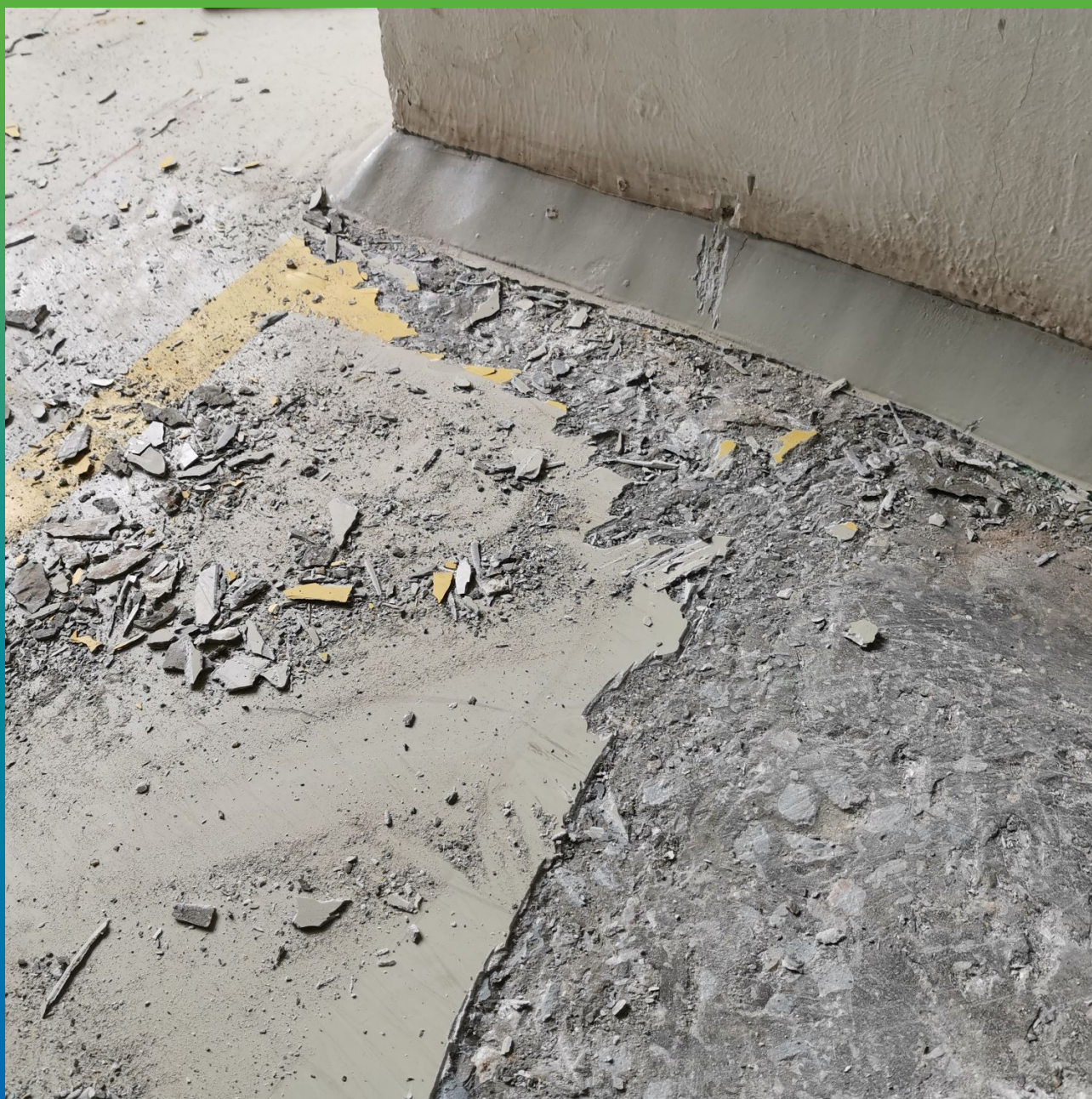
Демонтаж существующего покрытия
