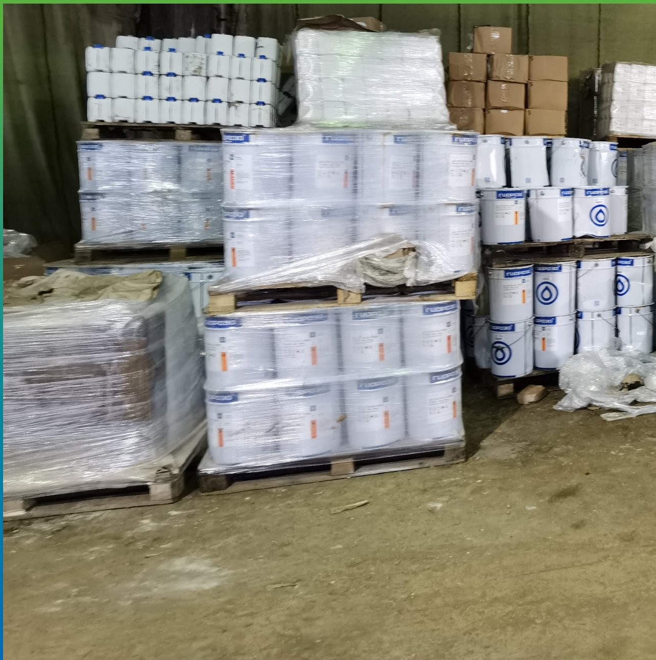
Материалы "Гидрозо" на объекте
