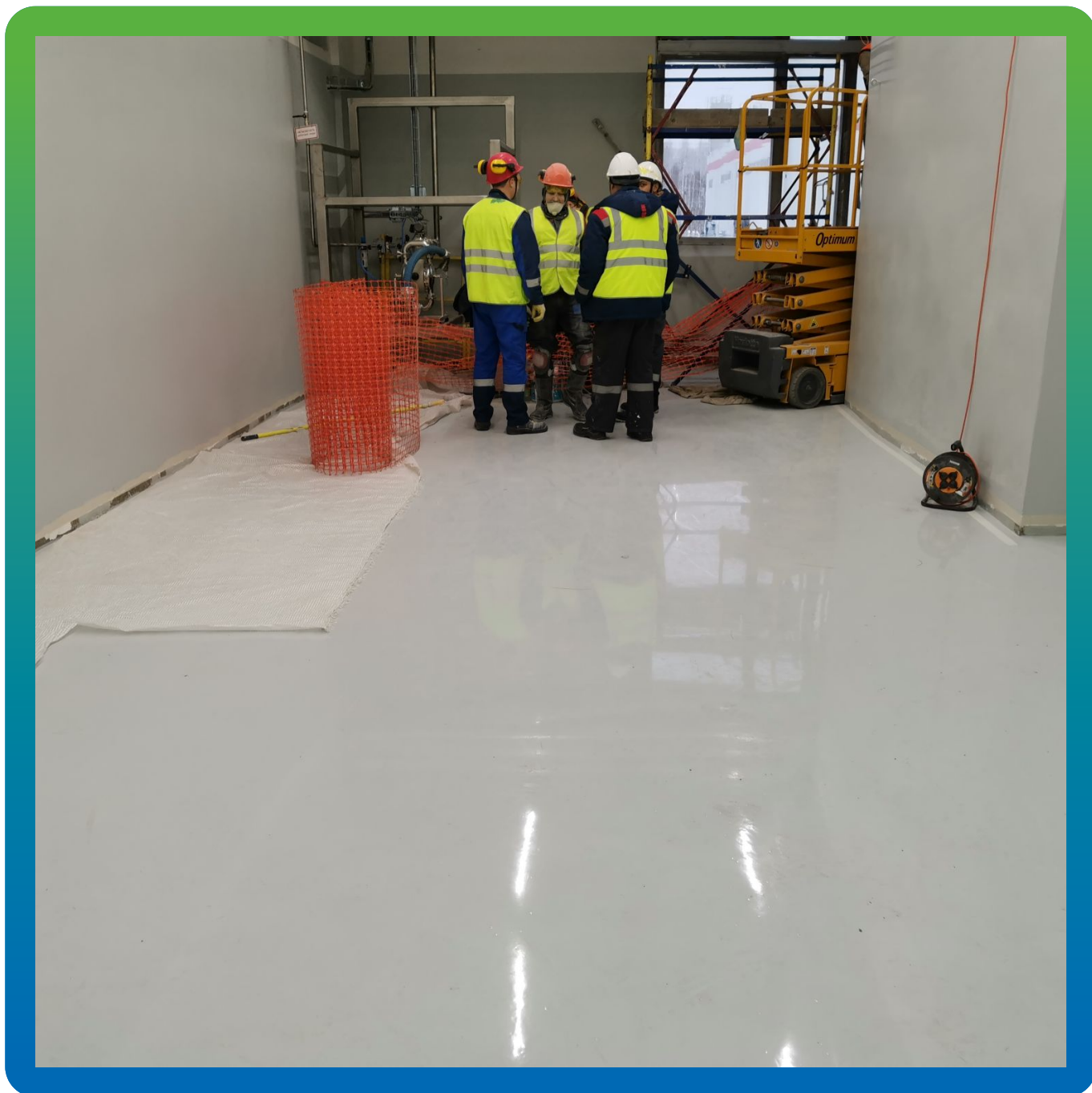
Вид покрытия перед установкой оборудования
