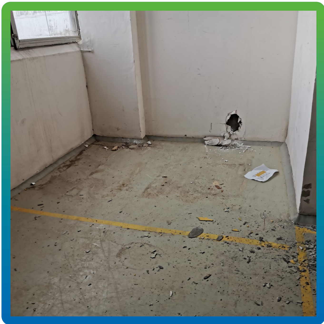
Вид объекта до проведения работ по устройству полов
