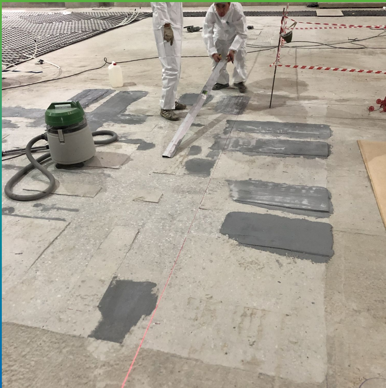
Выравнивание с помощью Манопокс 331 и проверка участков на перепады
