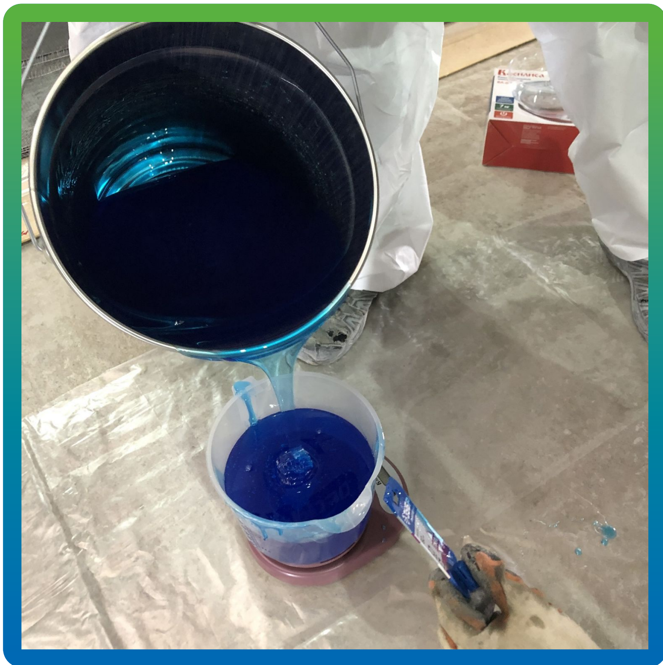
Замешивание компонентов А и Б эпоксидной композиции Манопокс 372
