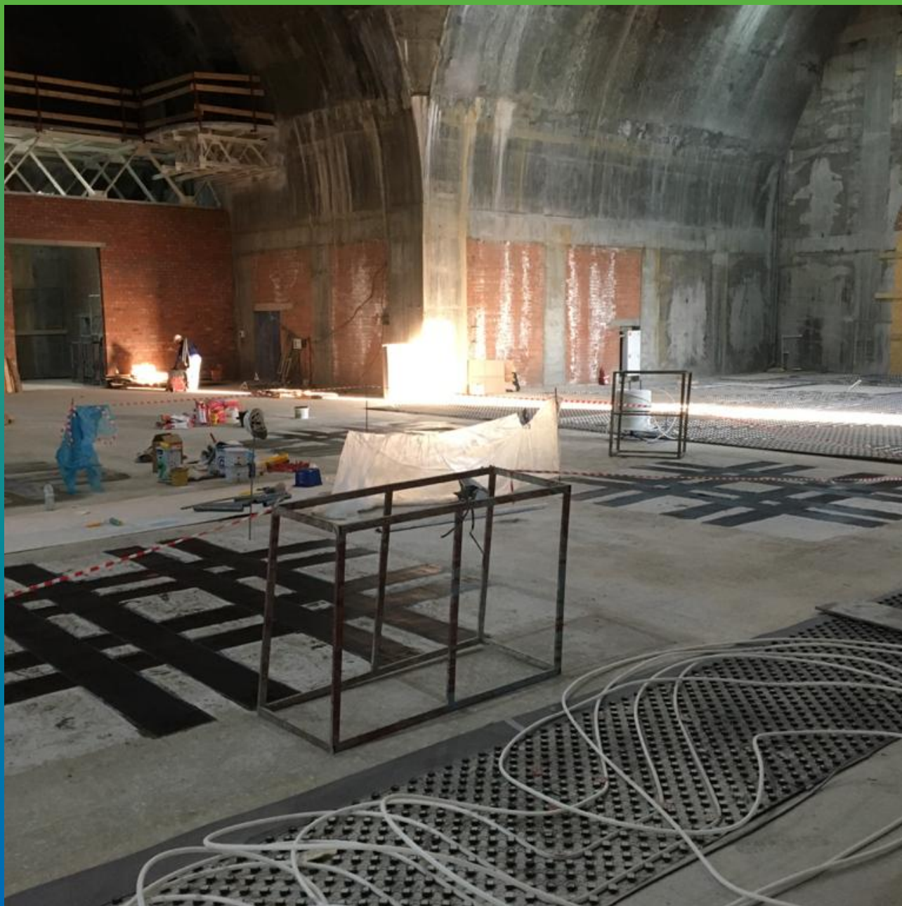
Общий вид смонтированного КСУ Армошел KB200
