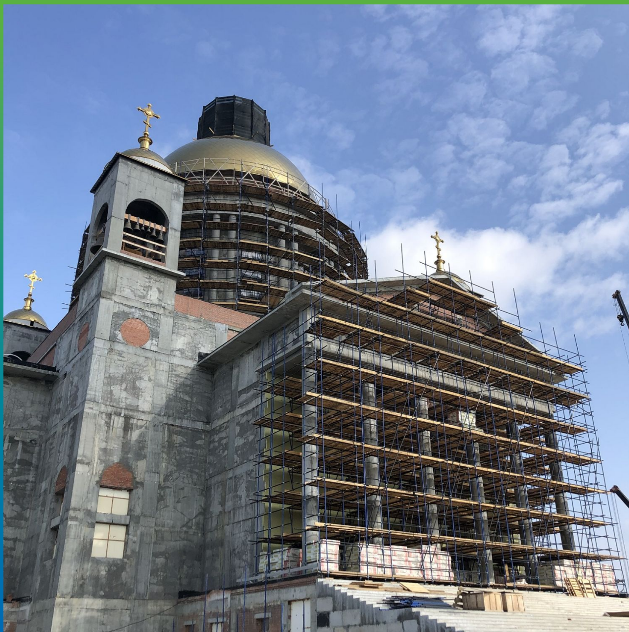
Общий вид объекта при строительстве
