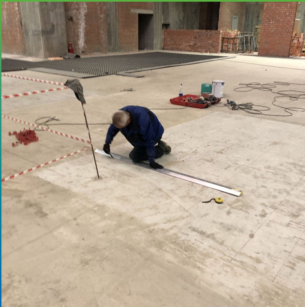
Разлиновка участков для выравнивания под монтажа КСУ Армошел
