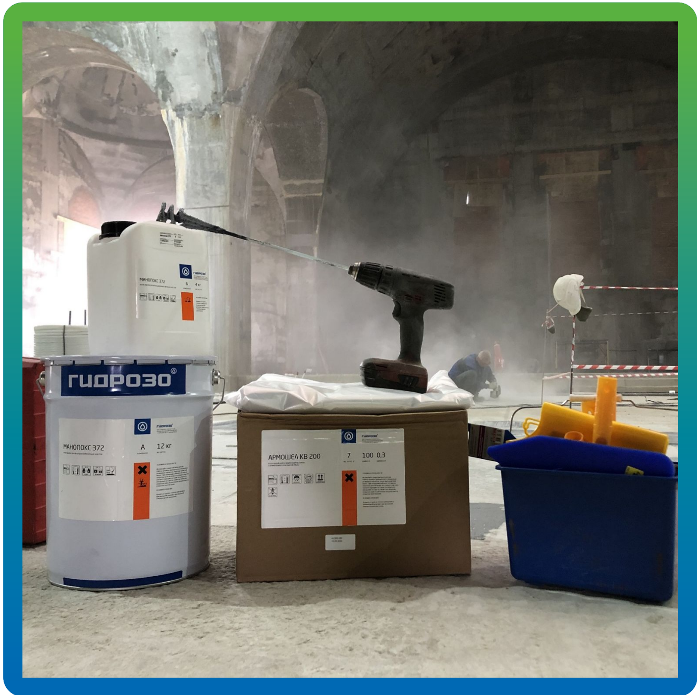
Материалы ГИДРОЗО и инструменты на объекте
