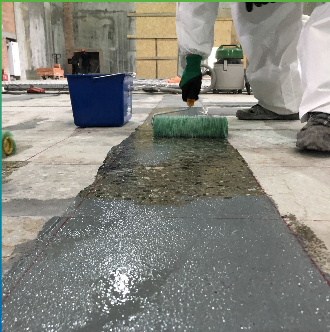
Грунтование основания составом Манопокс 372
