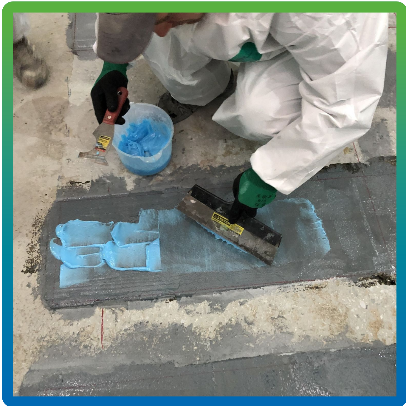
Укладка клеевого слоя Манопокс 372 загущенный составом Манопокс Тикс
