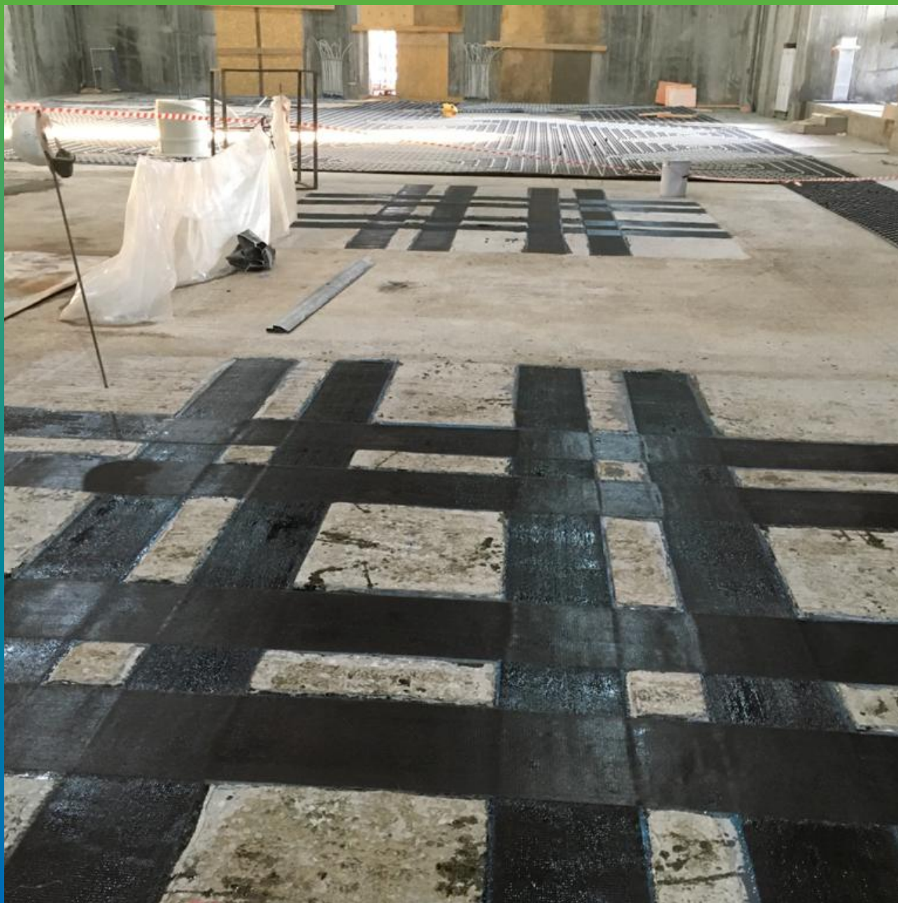
Вид на участок смонтированного КСУ Армошел KB200
