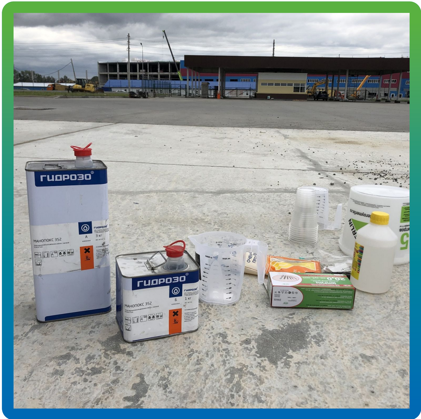
Материалы ГИДРОЗО на объекте
